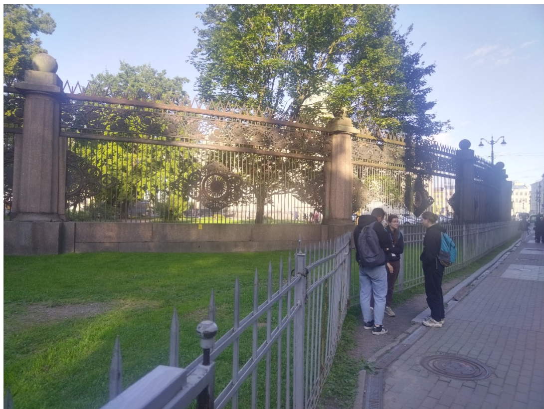
33. Вид на южную часть ограды с территории объекта культурного наследия федерального значения «Воспитательный дом Императорский» Дата съемки: 01.09.2025 г.
