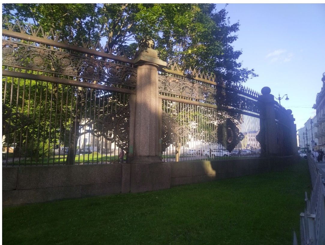
36. Вид на южную часть ограды с территории объекта культурного наследия федерального значения «Воспитательный дом Императорский» Дата съемки: 01.09.2025 г.
