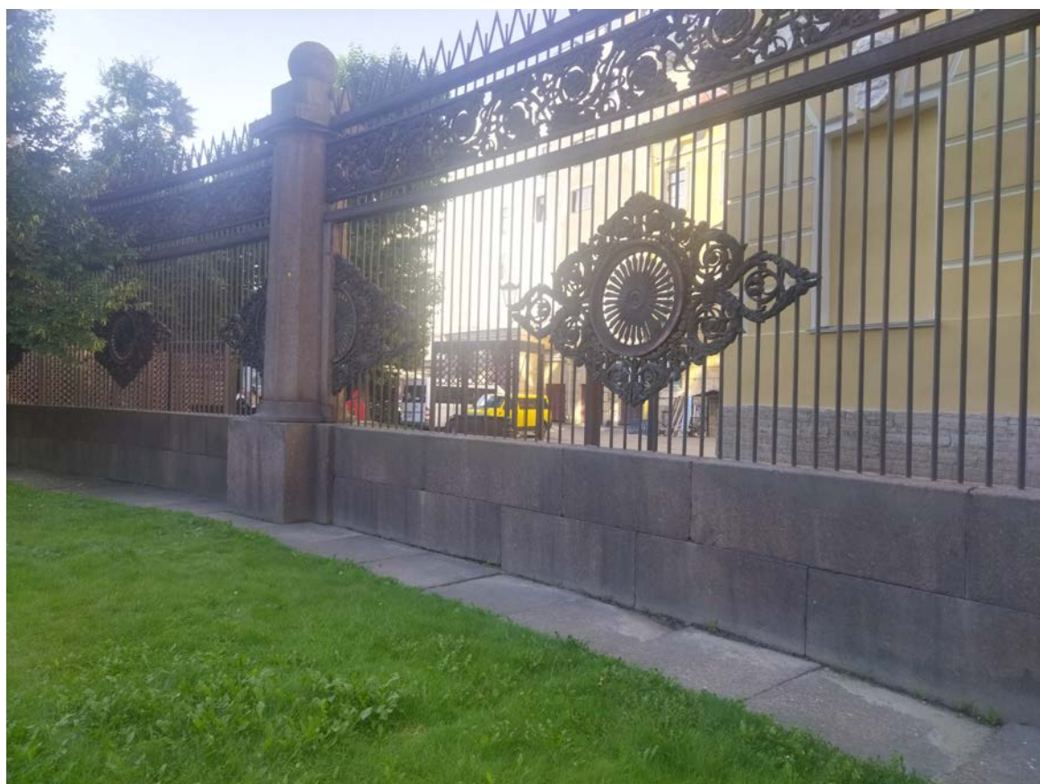
20. Северная часть ограды. Фрагмент. Гранитная отмостка. Дата съемки: 01.09.2025 г.
