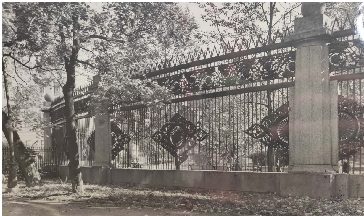
50. Ограда Казанского собора. Фрагмент 1981 г. Архив КГИОП. Фототека. Позитив № 125027/3
