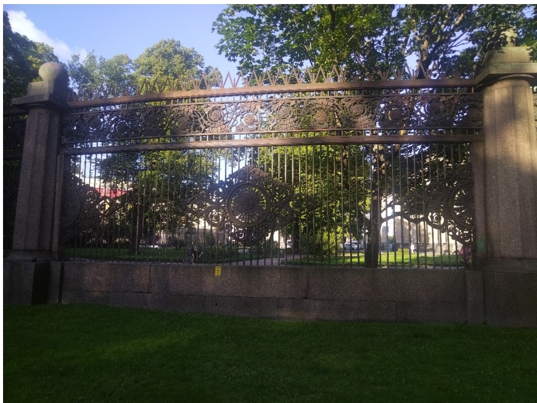
35. Вид на южную часть ограды с территории объекта культурного наследия федерального значения «Воспитательный дом Императорский» Дата съемки: 01.09.2025 г.
