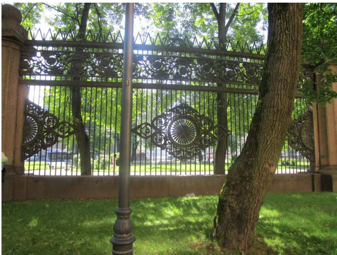
28. Вид на центральную часть ограды с территории объекта культурного наследия федерального значения «Сад "Старый"», Дата съемки: 02.07.2025 г.
