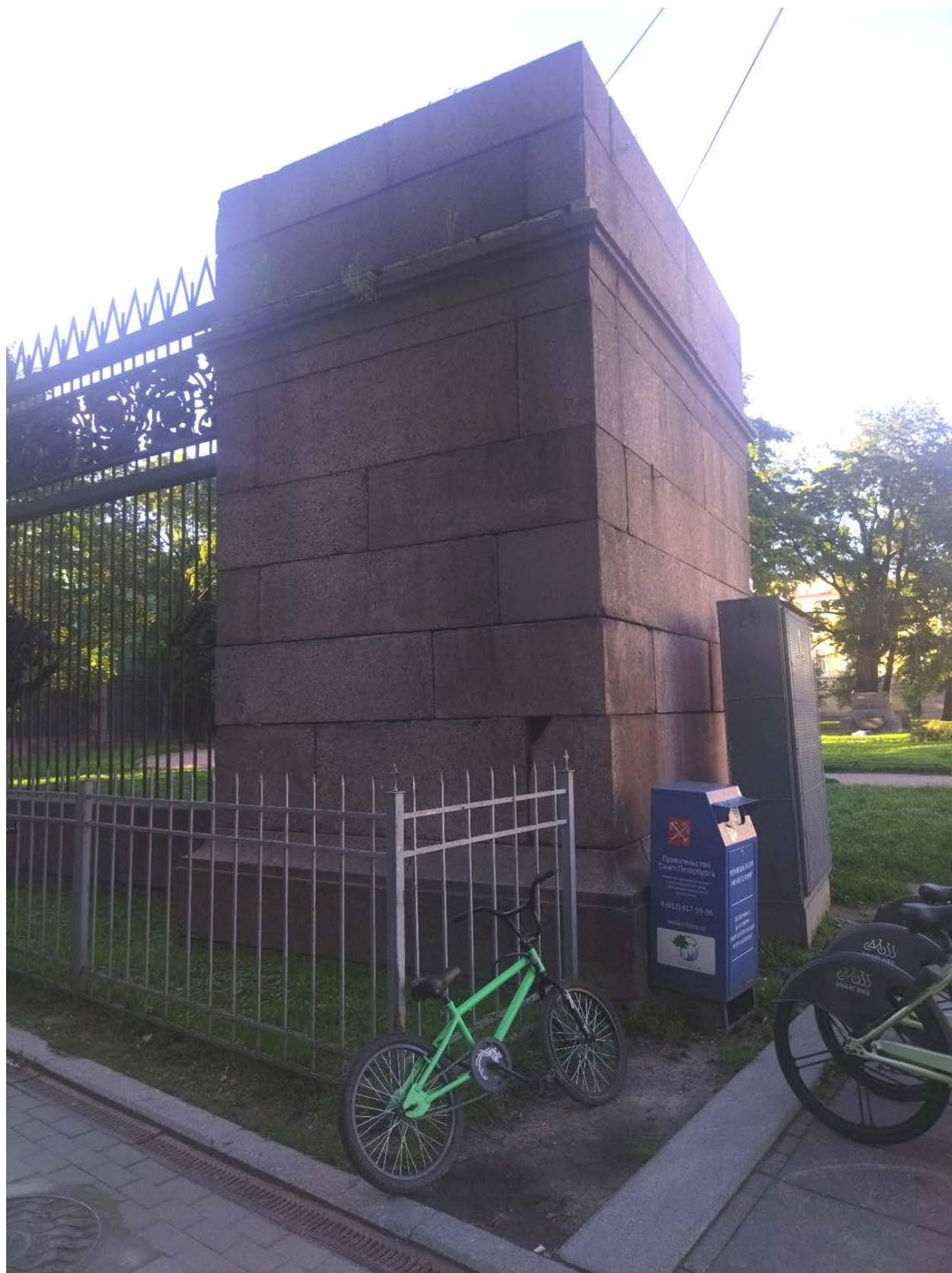
39. Вид на южную часть ограды с территории объекта культурного наследия федерального значения «Воспитательный дом Императорский» Фрагмент. Гранитный постамент. Дата съемки: 01.09.2025 г.
