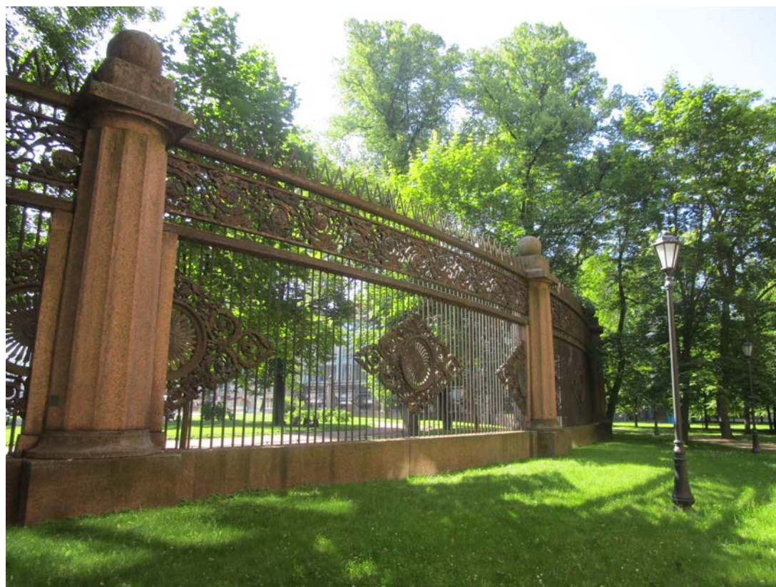
26. Вид на центральную часть ограды с территории объекта культурного наследия федерального значения «Сад "Старый"», Дата съемки: 02.07.2025 г.
