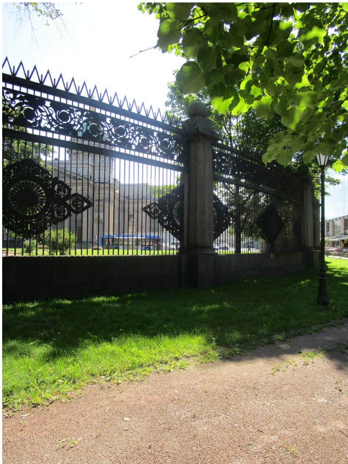
30. Вид на центральную часть ограды с территории объекта культурного наследия федерального значения «Сад "Старый"», Дата съемки: 02.07.2025 г.
