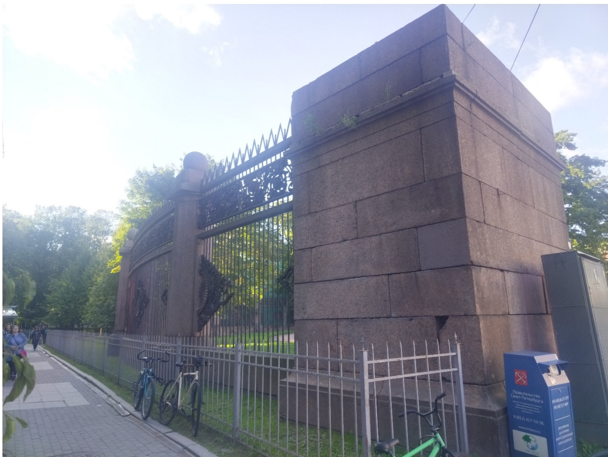
40. Вид на южную часть ограды с территории объекта культурного наследия федерального значения «Воспитательный дом Императорский» Дата съемки: 01.09.2025 г.
