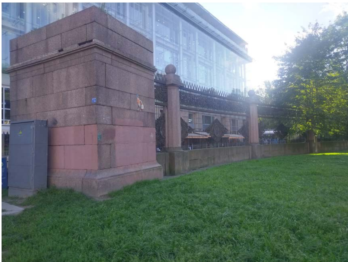
2. Вид на южный участок ограды с Казанской улицы. Дата съемки: 01.09.2025 г.
