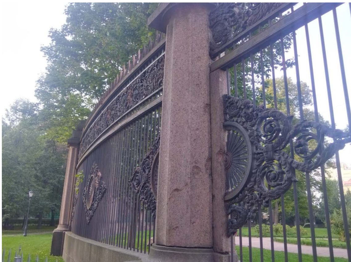
37. Вид на южную часть ограды с территории объекта культурного наследия федерального значения «Воспитательный дом Императорский». Фрагмент. Столб ограды. Дата съемки: 01.09.2025 г.
