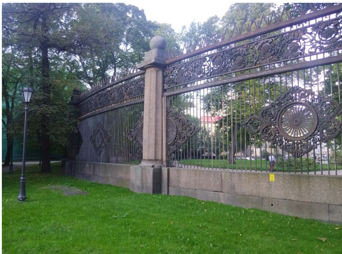
34. Вид на южную часть ограды с территории объекта культурного наследия федерального значения «Воспитательный дом Императорский» Дата съемки: 01.09.2025 г.
