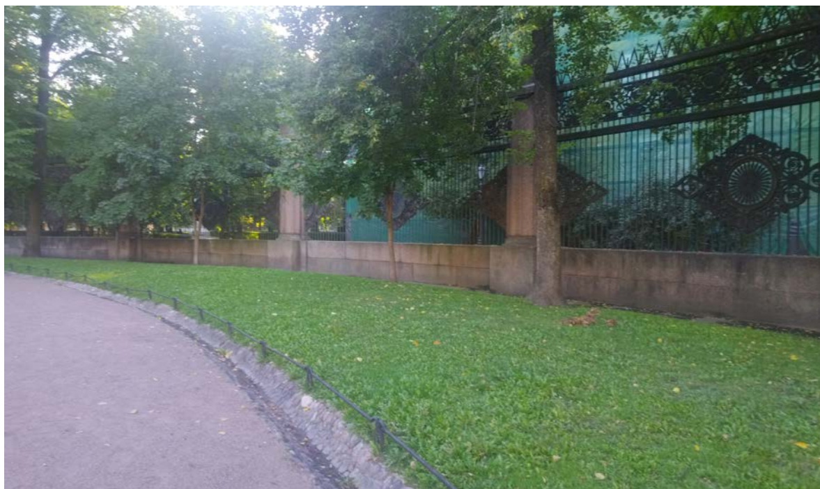
15. Центральная часть ограды. Фрагмент. Дата съемки: 01.09.2025 г.
