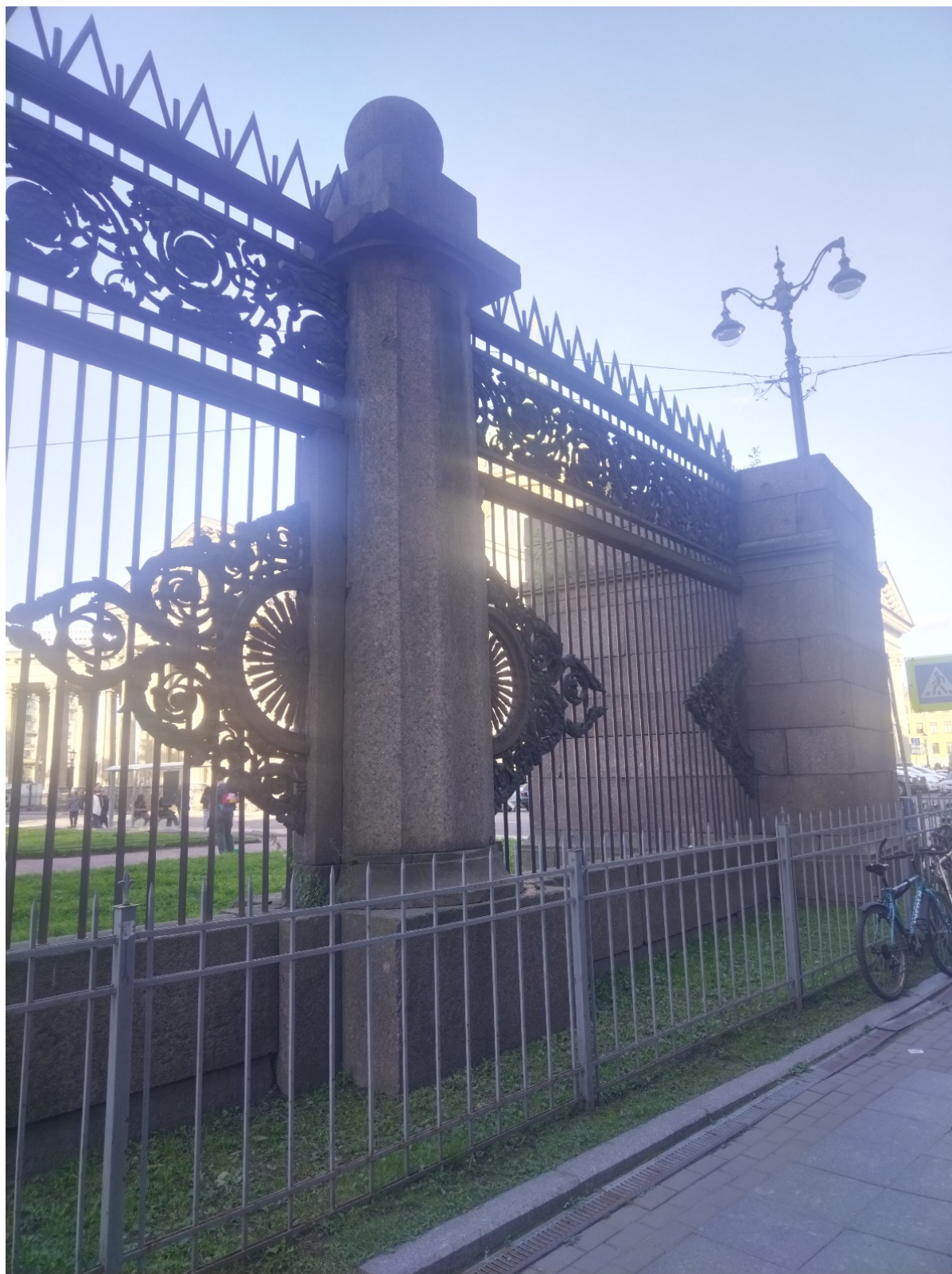
38. Вид на южную часть ограды с территории объекта культурного наследия федерального значения «Воспитательный дом Императорский» Дата съемки: 01.09.2025 г.
