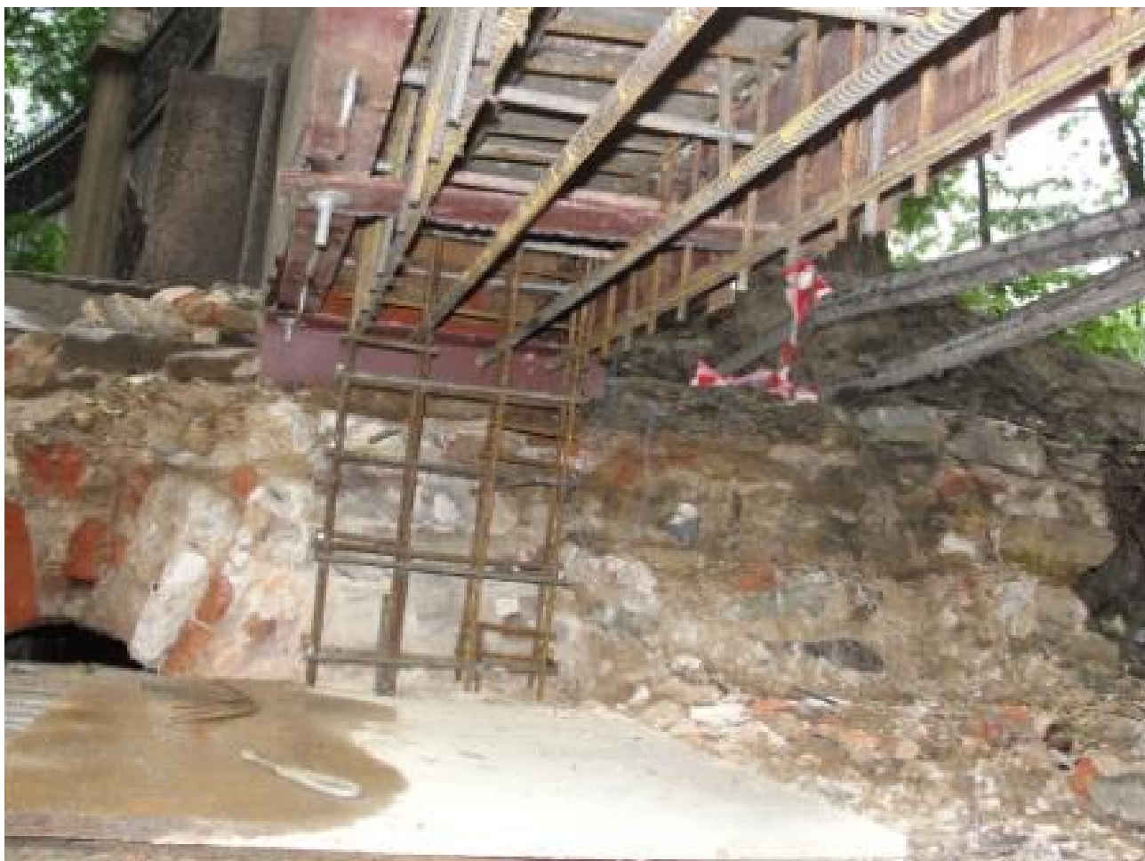
52. Выполнение армирования несущего перекрытия канала. 2011 г. http://rest-art-psp.ru/ (дата обращения: 07.09.2025)
