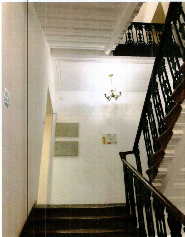
10. Парадная лестничная клетка объекта культурного наследия.
