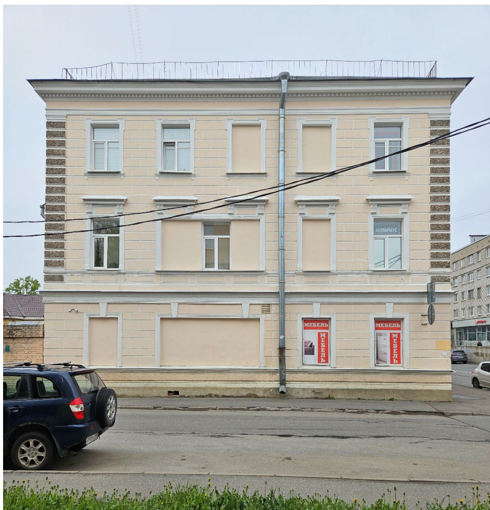
6. Южный фасад объекта культурного наследия регионального значения «Жилой дом», расположенного по адресу: Санкт- Петербург, г. Ломоносов, ул. Рубакина, д. 2/5, литера А. Фрагмент. 04.06.2025
