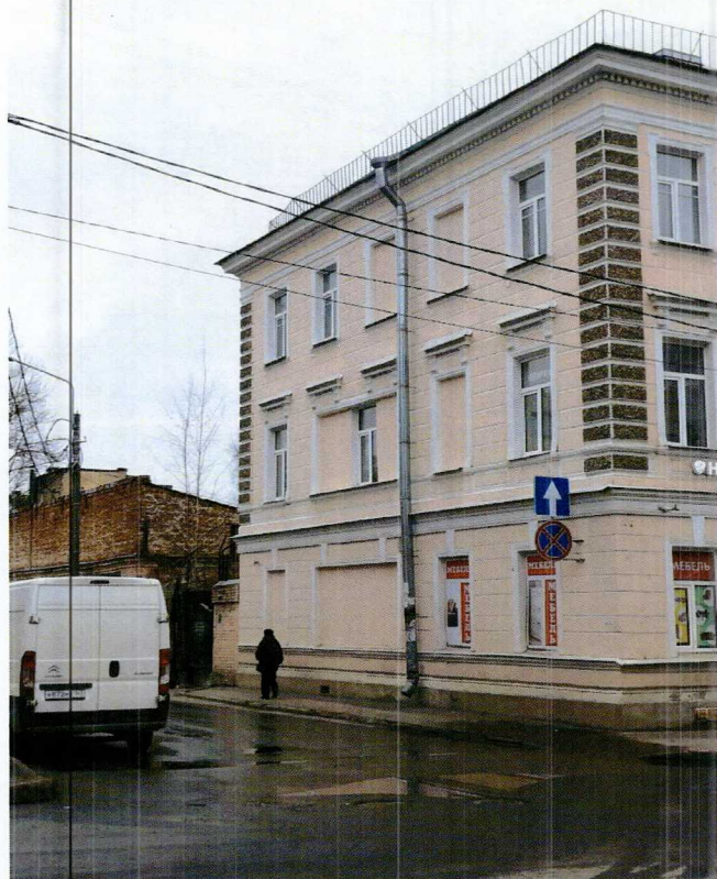
2. Южный фасад объекта культурного наследия.
