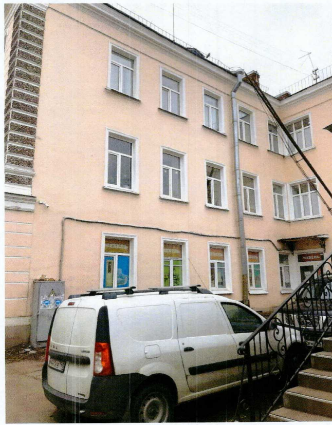
5. Фрагмент западного фасада объекта культурного наследия.
