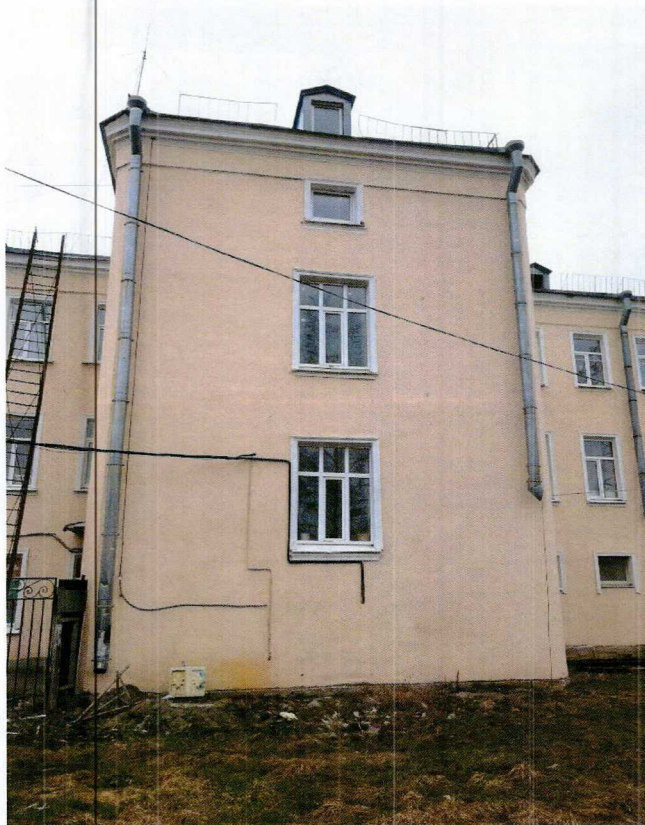
6. Фрагмент западного фасада объекта культурного наследия.
