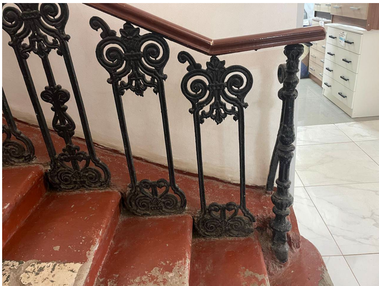
11. Лестница (пом. №26) объекта культурного наследия регионального значения «Жилой дом», расположенного по адресу: Санкт-Петербург, г. Ломоносов, ул. Рубакина, д. 2/5, литера А. 04.06.2025
