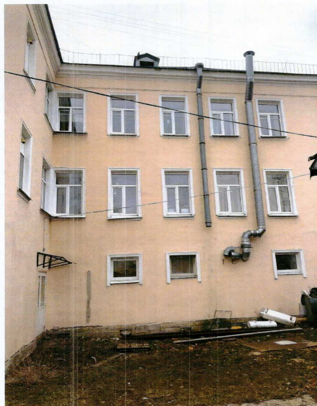
7. Фрагмент западного фасада объекта культурного наследия.
