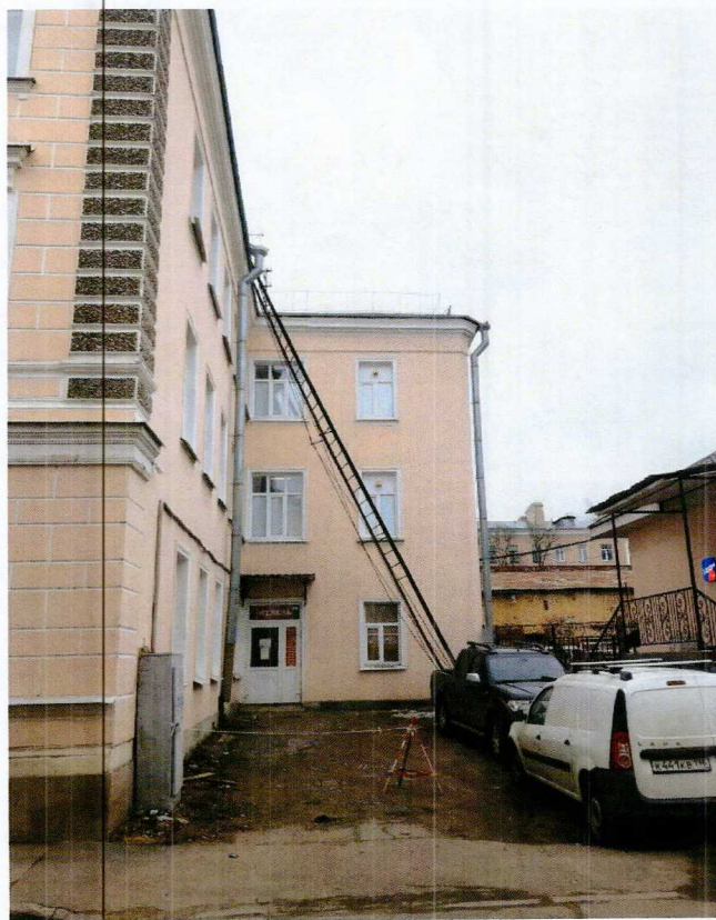
4. Северный фасад западного ризалита объекта культурного наследия.
