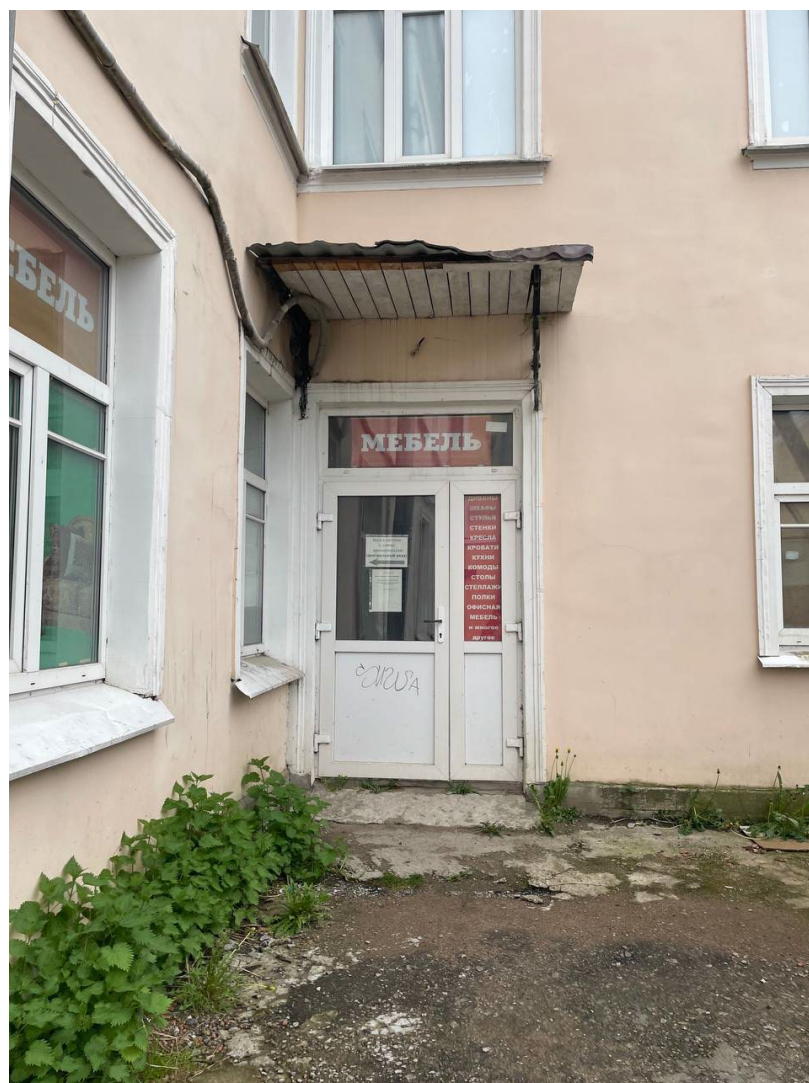
9. Дворовый западный фасад объекта культурного наследия регионального значения «Жилой дом», расположенного по адресу: Санкт-Петербург, г. Ломоносов, ул. Рубакина, д. 2/5, литера А. Фрагмент. 04.06.2025
