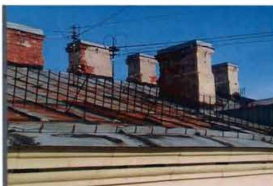
12. Фрагмент кровли. Коррозия металла.
