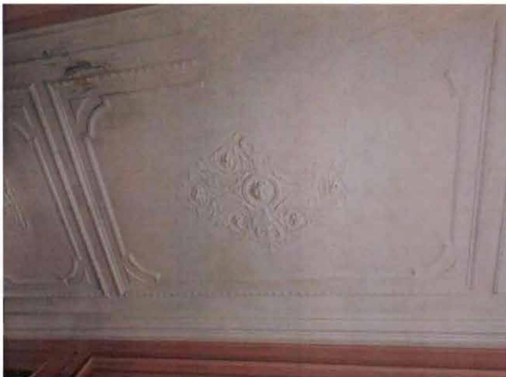
29. Оформление плафона верхней площадки 3-ЛК. Фрагментарная утрата деталей декора. Трещины и шелушения окрасочных слоев.
