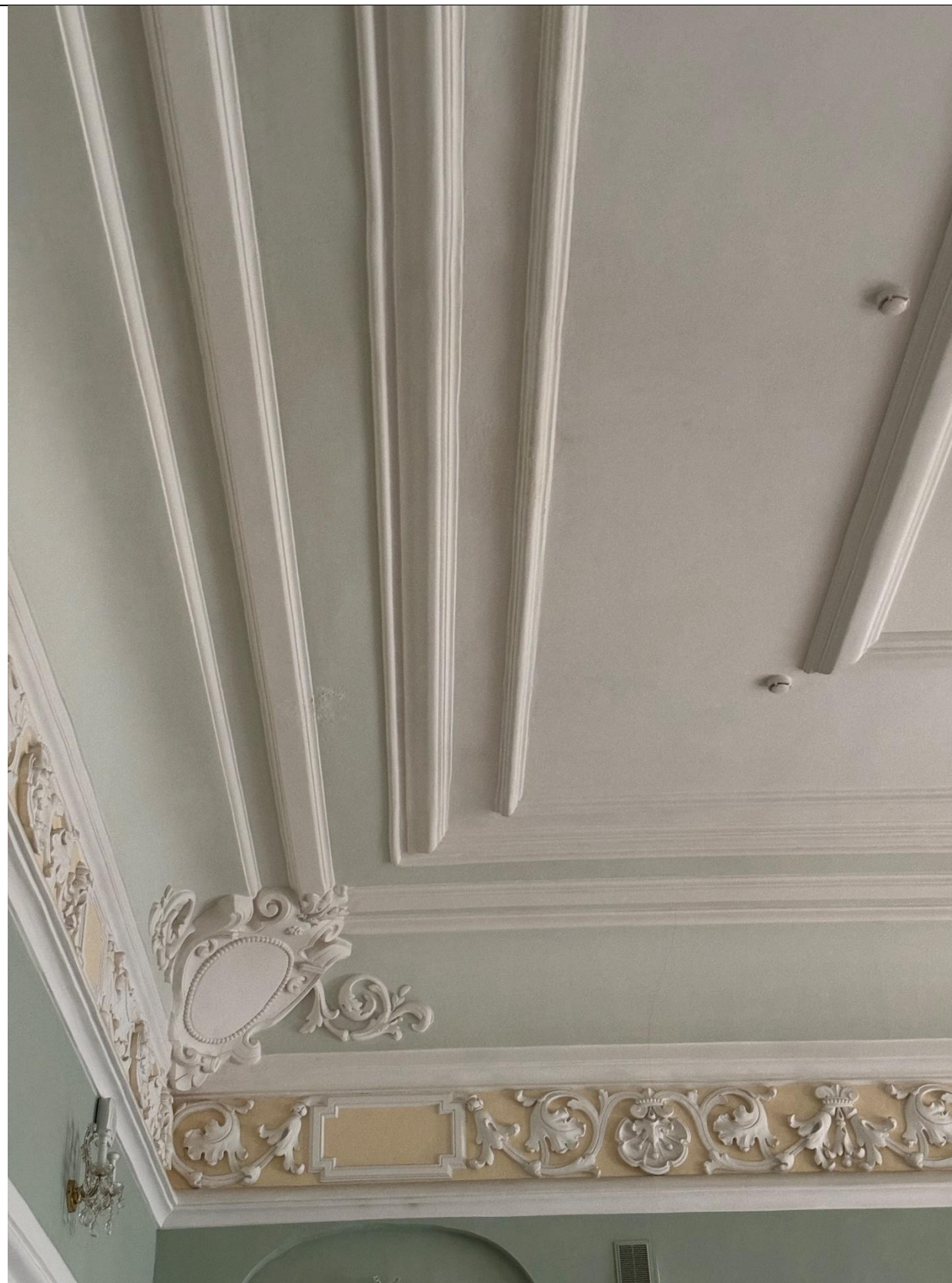
17. "Богадельня для престарелых членов Общества вспоможения приказчикам и сидельцам". Зал второго этажа (бывш. помещение церкви). Лепной декор потолка и стен.
