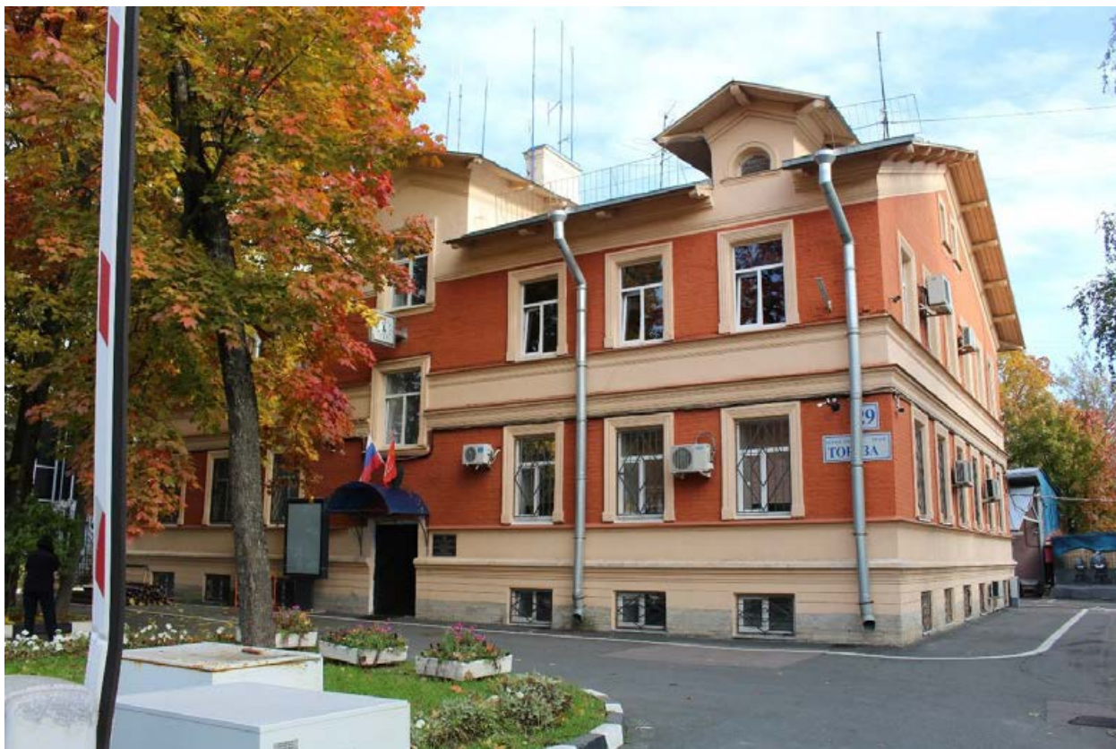
Фото 1. Общий вид объекта с юга.
