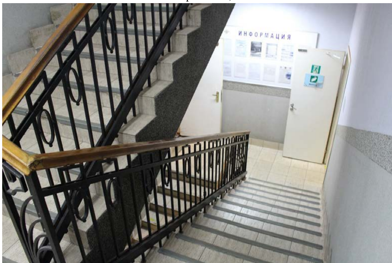
Фото 30. Лестница, пом. 53, вид на первый этаж.
