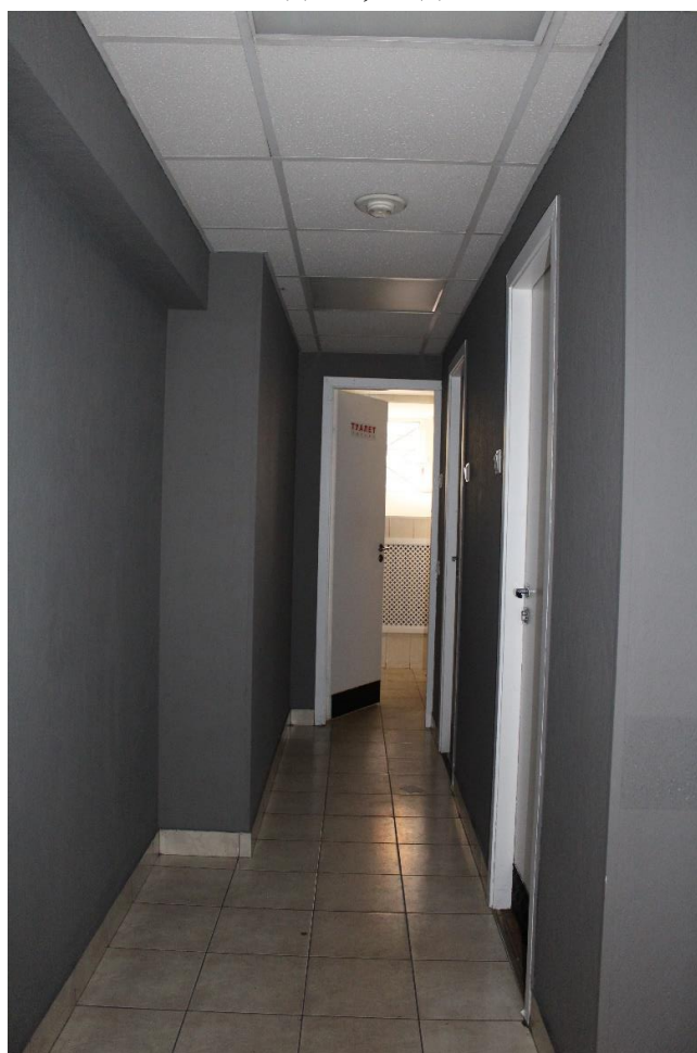
Фото 24. Подвал, вид южной части, пом. 18.
