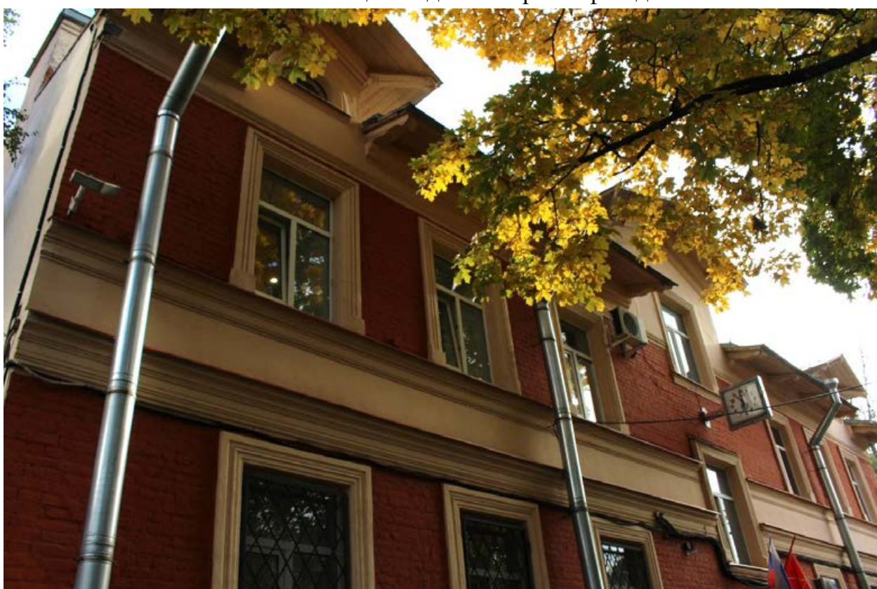
Фото 8. Вид на северную часть западного фасада.
