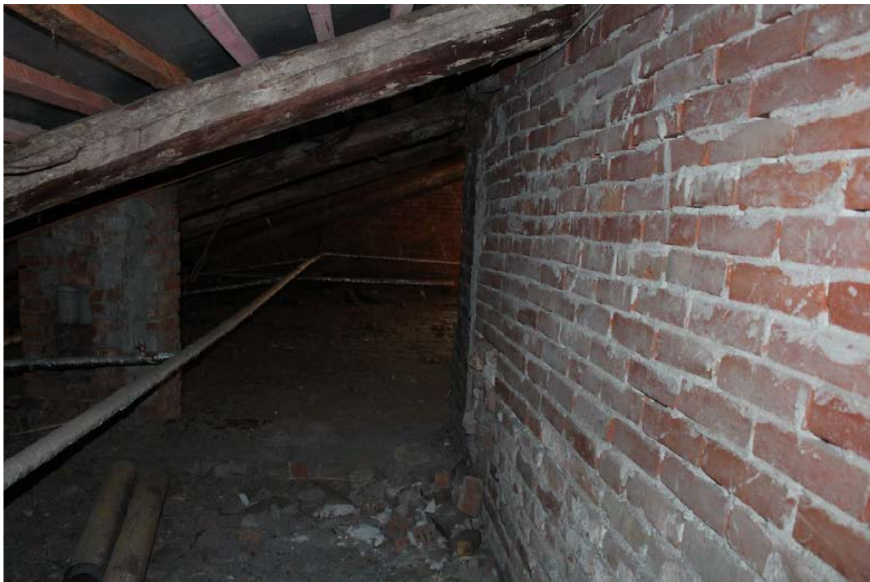
Фото 39. Чердак, стена лестничной клетки, проход.
