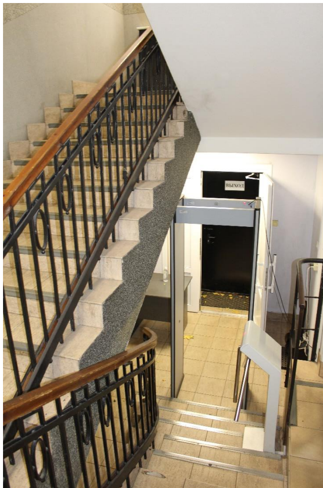
Фото 15. Лестницы в пом. 32.
