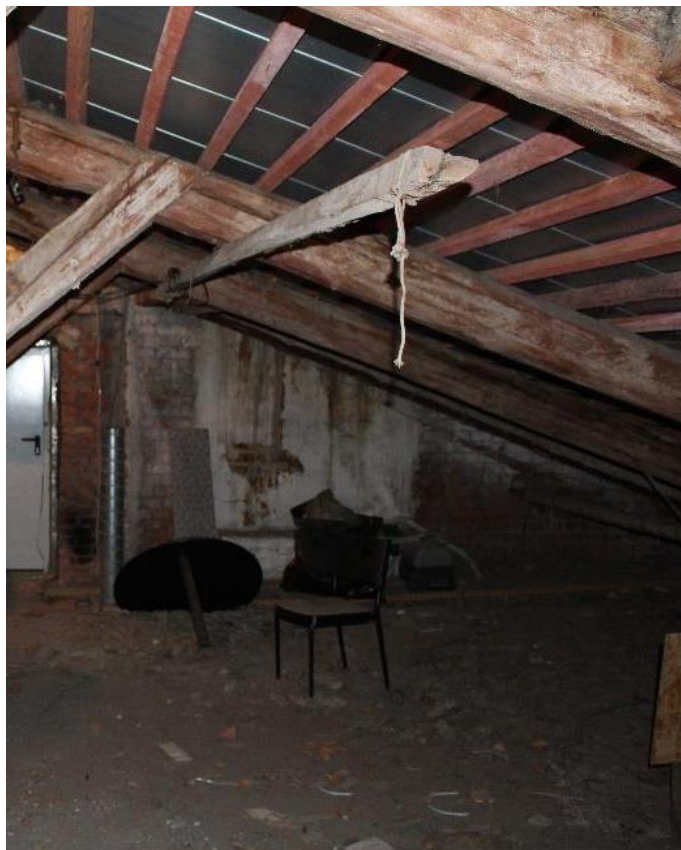
Фото 37. Чердак, северная часть.
