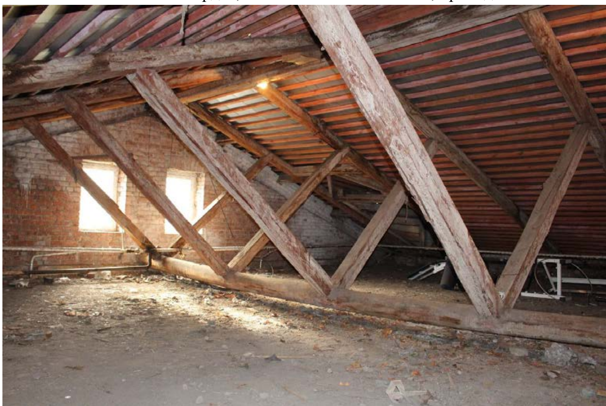
Фото 40. Чердак, вид на южную стену.
