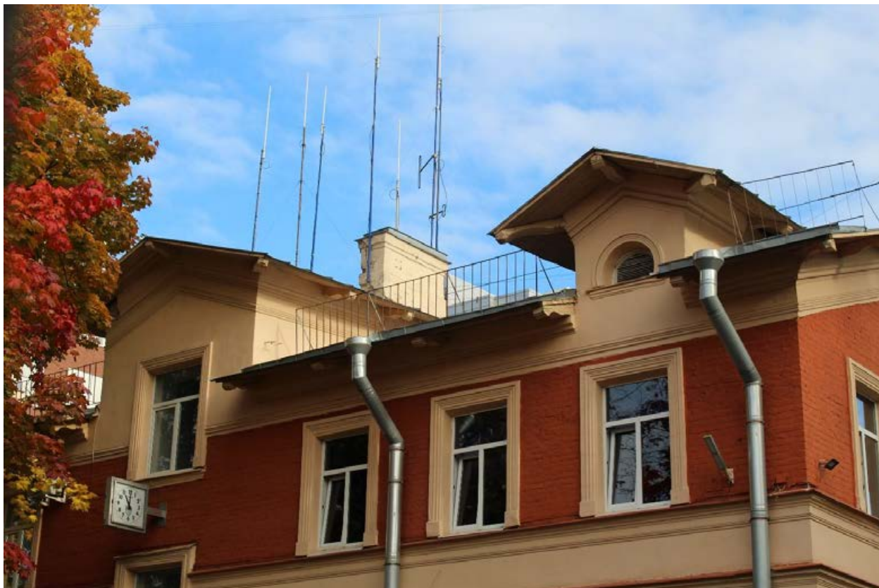
Фото 3. Фрагмент окон в чердаке с западного фасада.
