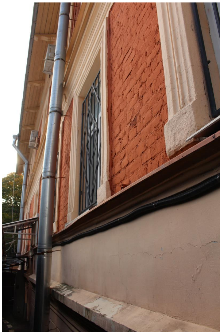
Фото 12. Фрагмент восточного фасада.
