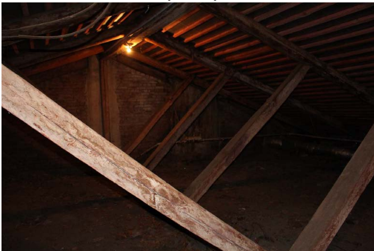
Фото 38. Фрагмент стропил крыши.
