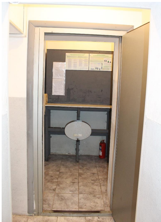
Фото 16. Вид на помещение 29.
