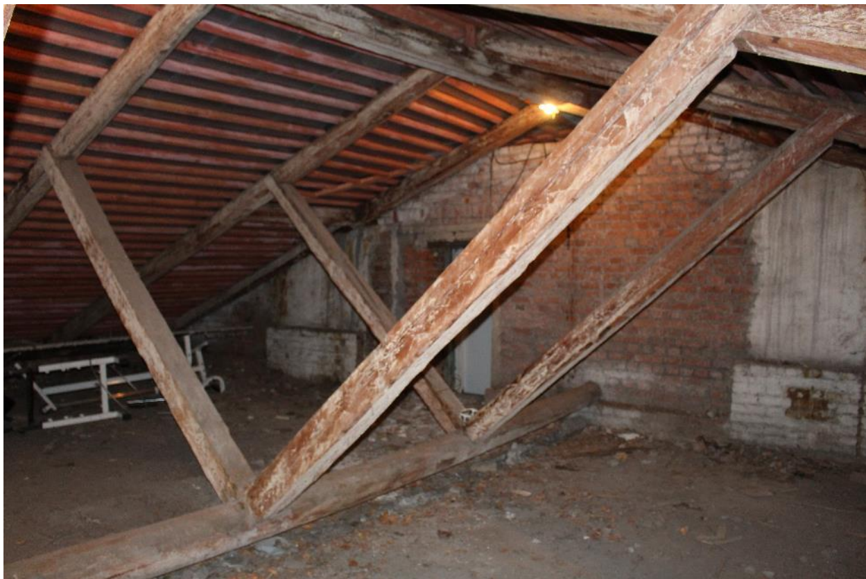
Фото 41. Чердак, южная часть.
