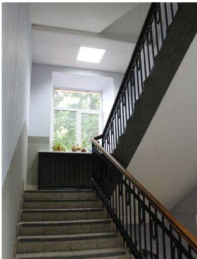
Фото 14. Лестницы в пом. 32.
