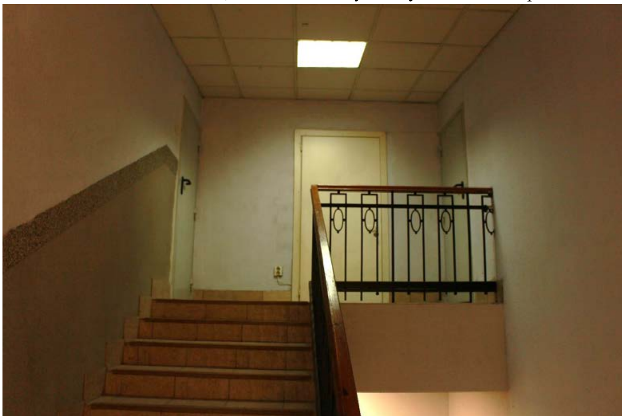
Фото 36. Помещение 53, вид на чердачную площадку.
