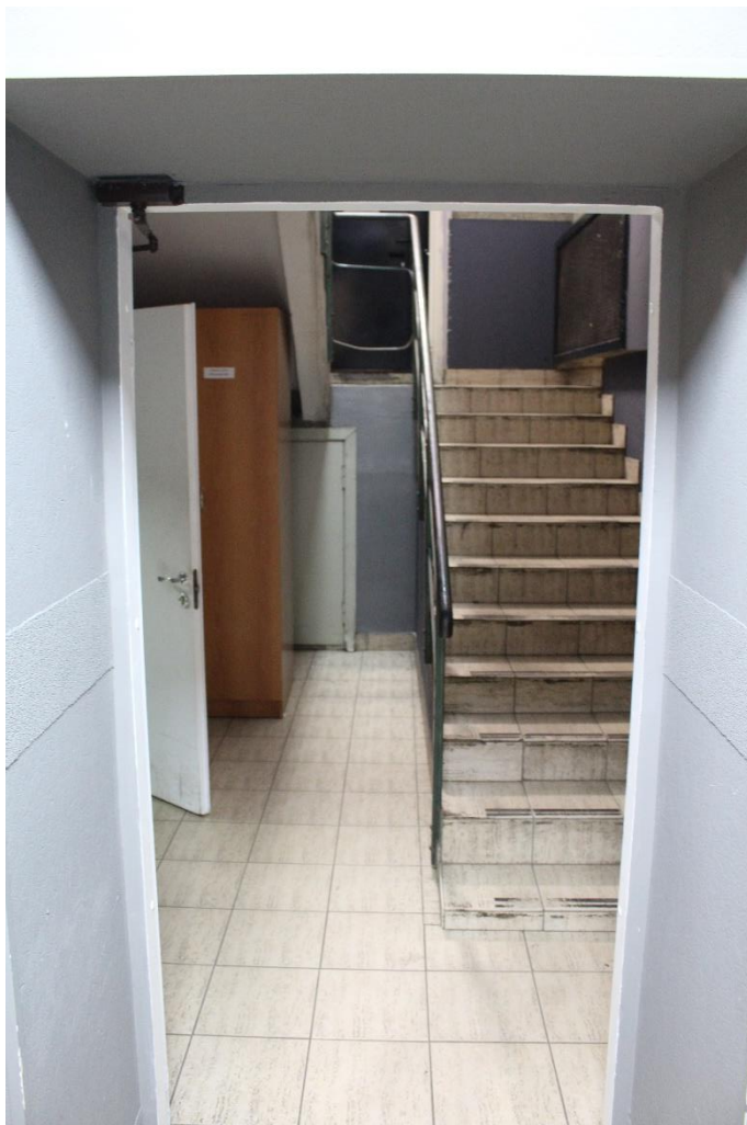
Фото 21. Восточная лестница, пом. 10.
