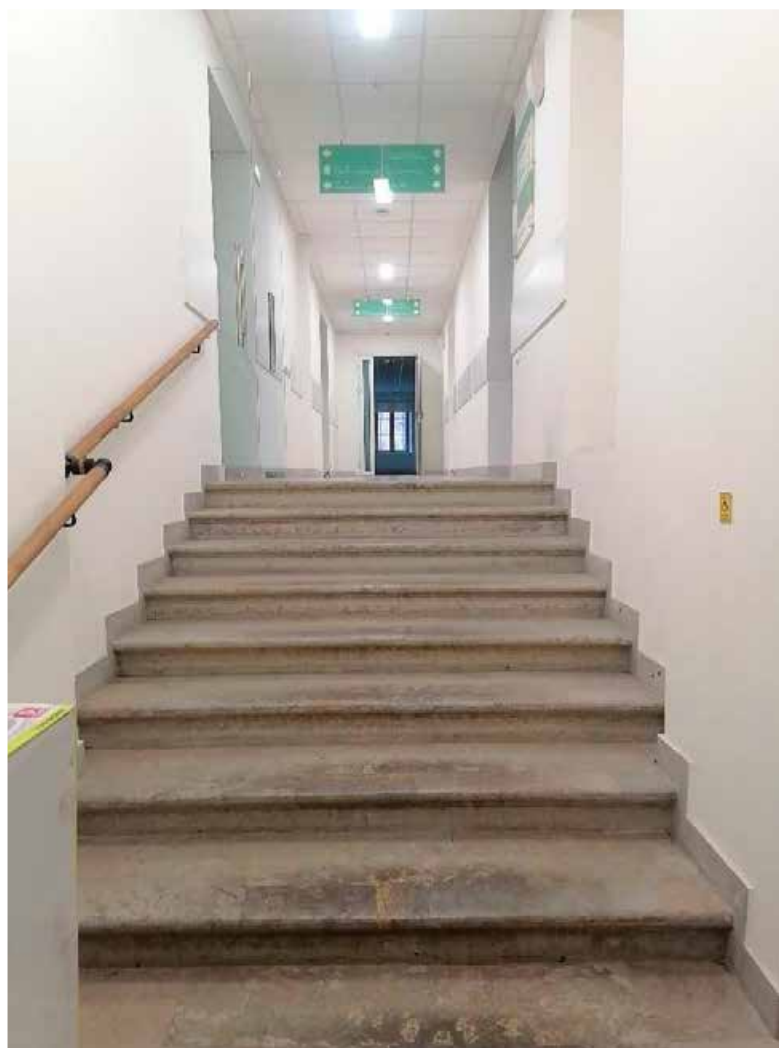
35. Помещение №15 (2-Н) в уровне 1 этажа объекта культурного наследия регионального значения «Орлово-Новосильцевская богадельня (Комплекс с садом и оградой, 3 флигеля)». Флигель», расположенного по адресу: г. Санкт-Петербург, пр. Энгельса д. 1, строение 2. 15.07.2025
