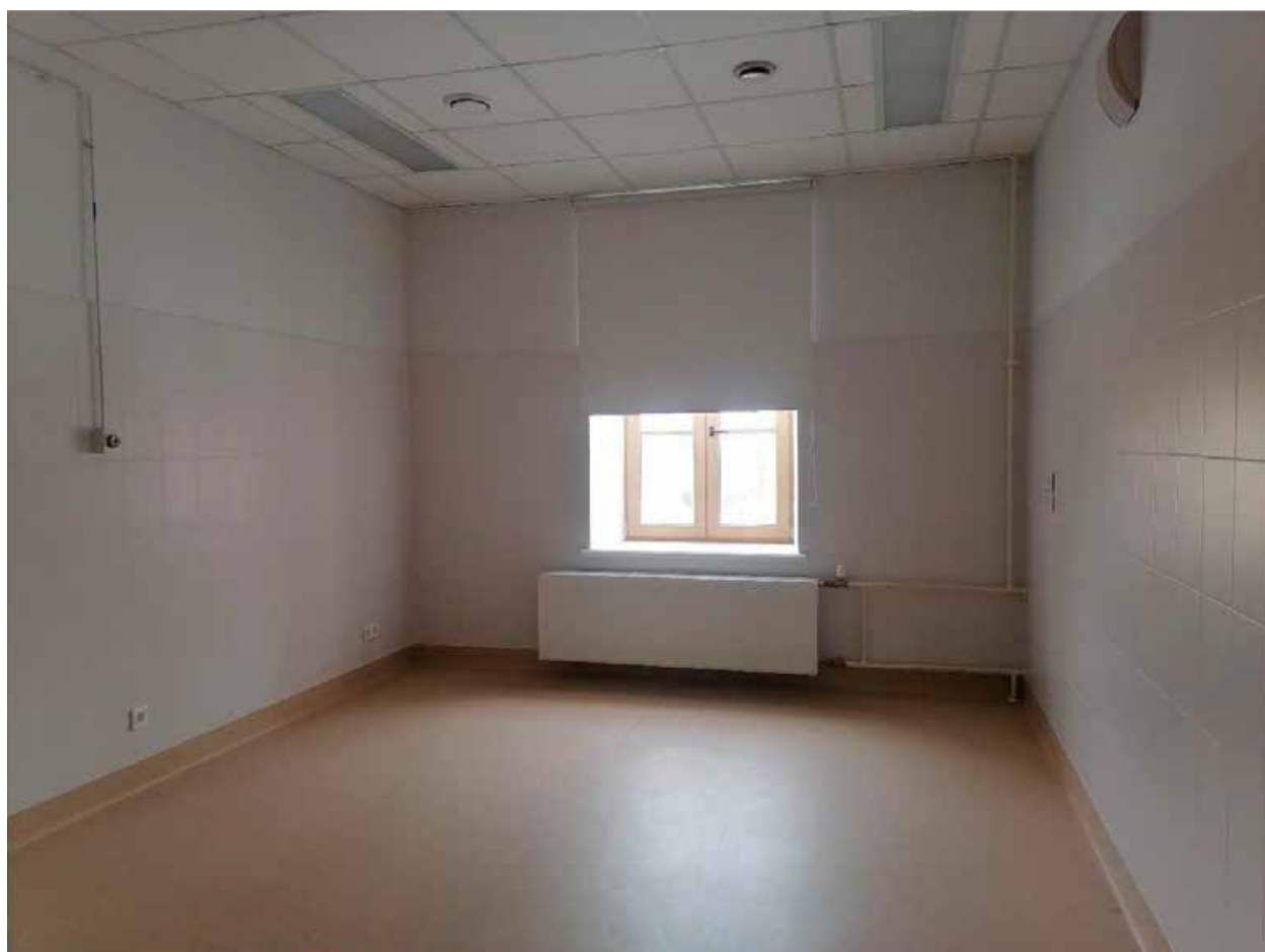
47. Помещение №43 (2Н) в уровне 2 этажа объекта культурного наследия регионального значения «Орлово-Новосильцевская богадельня (Комплекс с садом и оградой, 3 флигеля). Флигель», расположенного по адресу: г. Санкт-Петербург, пр. Энгельса д. 1, строение 2. 15.07.2025
