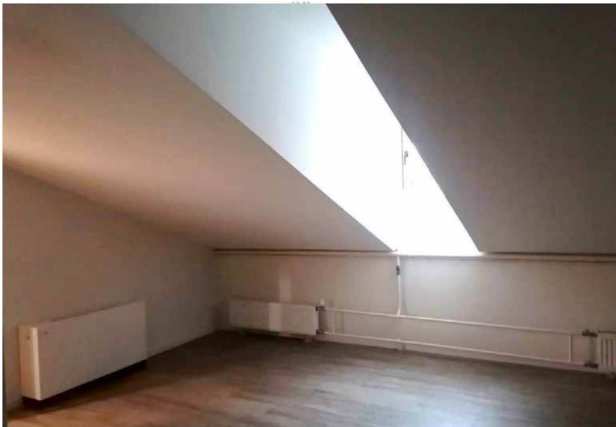
54. Помещение лестницы №71 (2Н) в уровне мансарды объекта культурного наследия регионального значения «Орлово-Новосильцевская богадельня (Комплекс с садом и оградой, 3 флигеля). Флигель», расположенного по адресу: г. Санкт-Петербург, пр. Энгельса д. 1, строение 2. 15.07.2025
