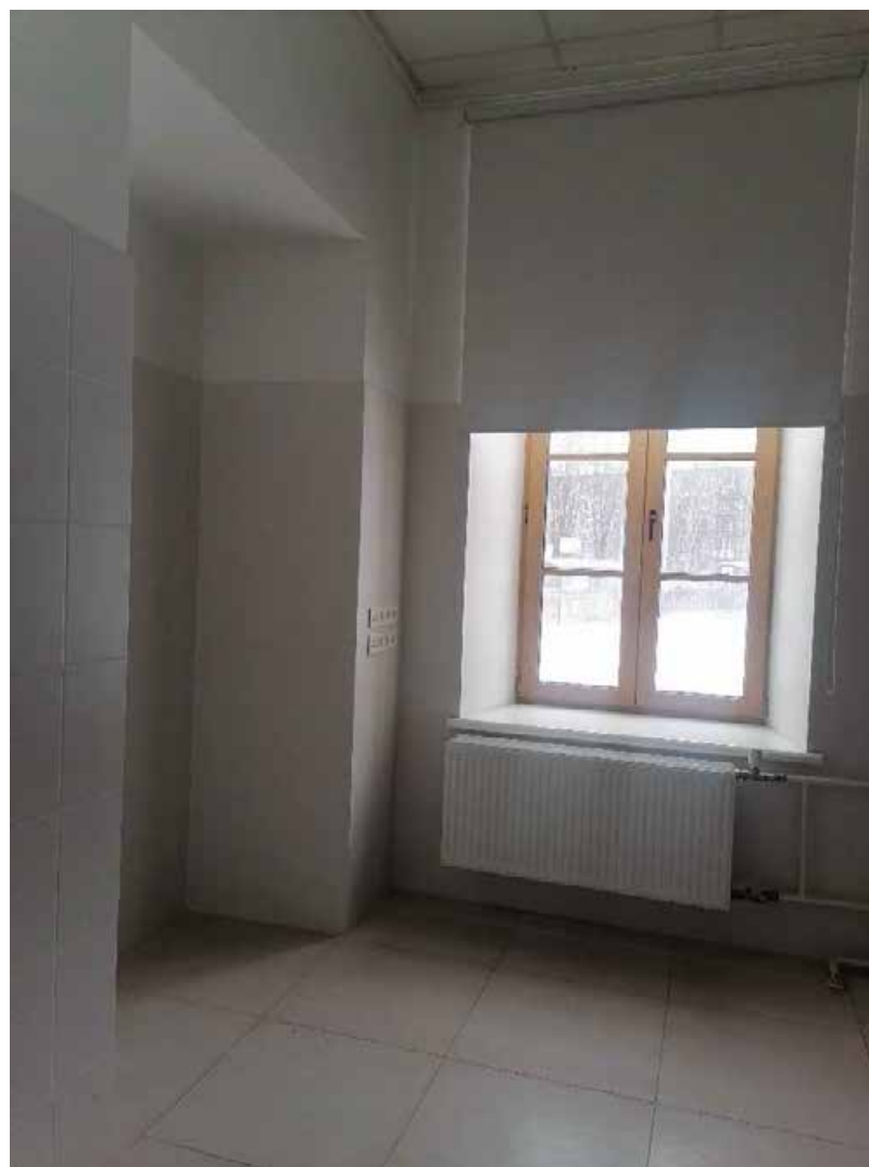
41. Помещение №30 (2-Н) в уровне 1 этажа объекта культурного наследия регионального значения «Орлово-Новосильцевская богадельня (Комплекс с садом и оградой, 3 флигеля). Флигель», расположенного по адресу: г. Санкт-Петербург, пр. Энгельса д. 1, строение 2. 15.07.2025
