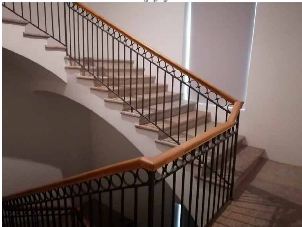
72. Помещение №10 (2Н) в уровне 2 этажа объекта культурного наследия регионального значения «Орлово-Новосильцевская богадельня (Комплекс с садом и оградой, 3 флигеля). Флигель», расположенного по адресу: г. Санкт-Петербург, пр. Энгельса д. 1, строение 3. 15.07.2025
