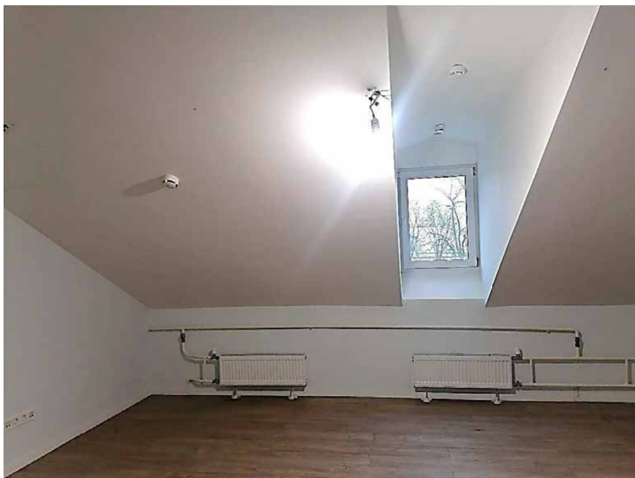
21. Помещение коридора №33 (2Н) в уровне мансарды объекта культурного наследия регионального значения «Орлово-Новосильцевская богадельня (Комплекс с садом и оградой, 3 флигеля). Флигель», расположенного по адресу: г. Санкт-Петербург, пр. Энгельса д. 1, строение 1. 15.07.2025
