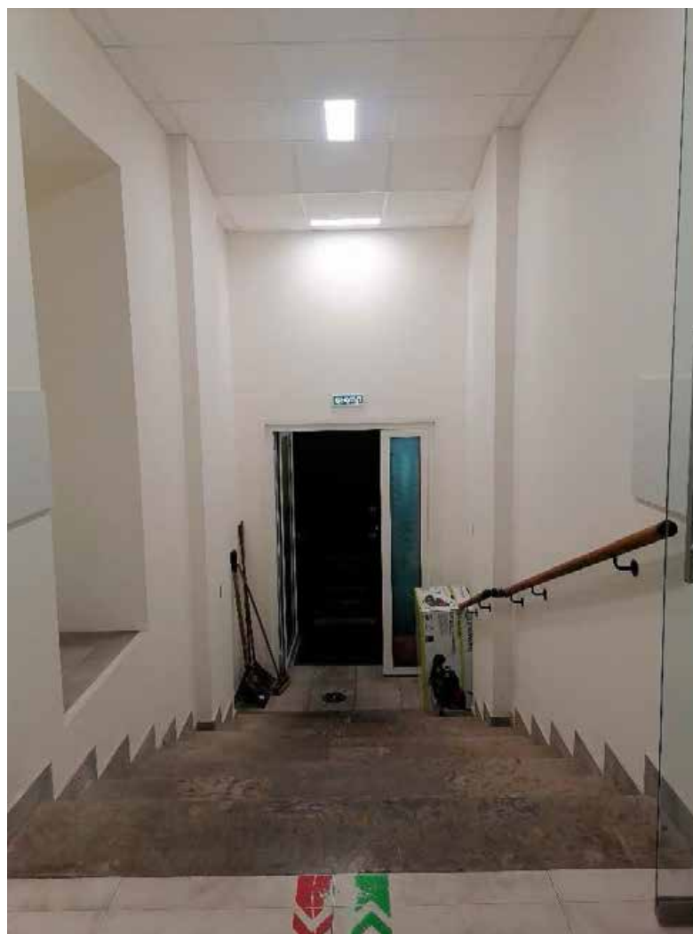
36. Помещение №15 (2-Н) в уровне 1 этажа объекта культурного наследия регионального значения «Орлово-Новосильцевская богадельня (Комплекс с садом и оградой, 3 флигеля)». Флигель», расположенного по адресу: г. Санкт-Петербург, пр. Энгельса д. 1, строение 2. 15.07.2025
