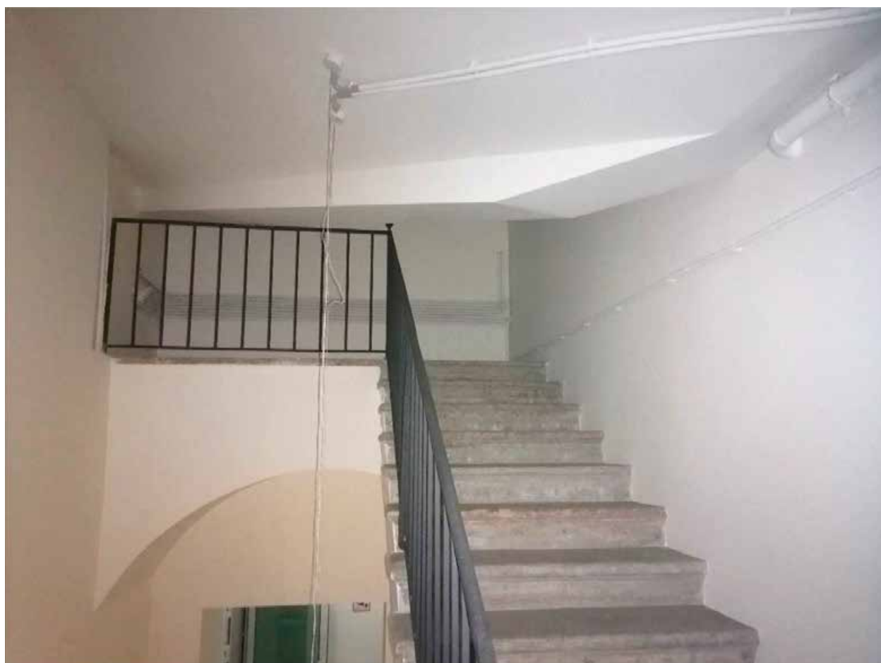
50. Помещение №34 (2Н) в уровне 2 этажа объекта культурного наследия регионального значения «Орлово-Новосильцевская богадельня (Комплекс с садом и оградой, 3 флигеля). Флигель», расположенного по адресу: г. Санкт-Петербург, пр. Энгельса д. 1, строение 2. 15.07.2025
