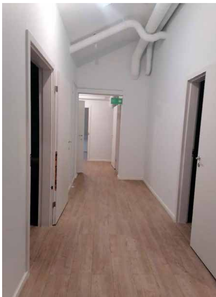
19. Помещение коридора №31 (2Н) в уровне мансарды объекта культурного наследия регионального значения «Орлово-Новосильцевская богадельня (Комплекс с садом и оградой, 3 флигеля). Флигель», расположенного по адресу: г. Санкт-Петербург, пр. Энгельса д. 1, строение 1. 15.07.2025
