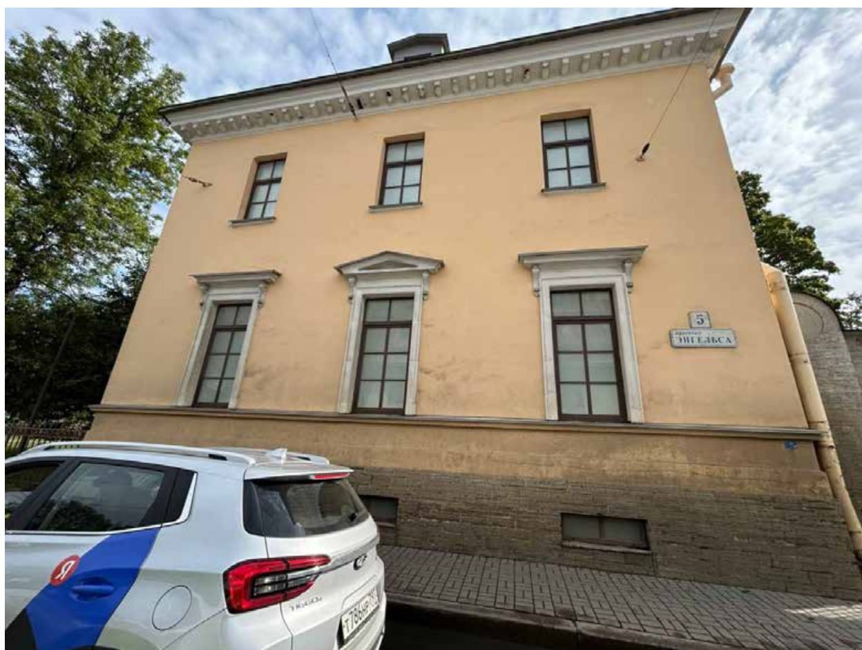
58. Юго-западный фасад объекта культурного наследия регионального значения «Орлово-Новосильцевская богадельня (Комплекс с садом и оградой, 3 флигеля). Флигель», расположенного по адресу: г. Санкт-Петербург, пр. Энгельса д. 1, строение 3. 15.07.2025
