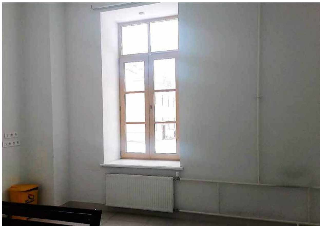
40. Помещение №18 (2-Н) в уровне 1 этажа объекта культурного наследия регионального значения «Орлово-Новосильцевская богадельня (Комплекс с садом и оградой, 3 флигеля). Флигель», расположенного по адресу: г. Санкт-Петербург, пр. Энгельса д. 1, строение 2. 15.07.2025
