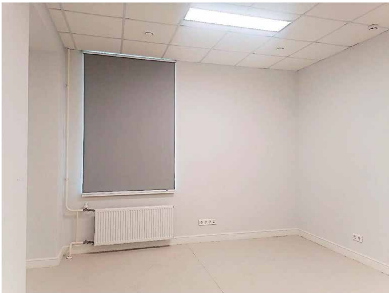
16. Помещение №19 (2Н) в уровне 2 этажа объекта культурного наследия регионального значения «Орлово-Новосильцевская богадельня (Комплекс с садом и оградой, 3 флигеля). Флигель», расположенного по адресу: г. Санкт-Петербург, пр. Энгельса д. 1, строение 1. 15.07.2025
