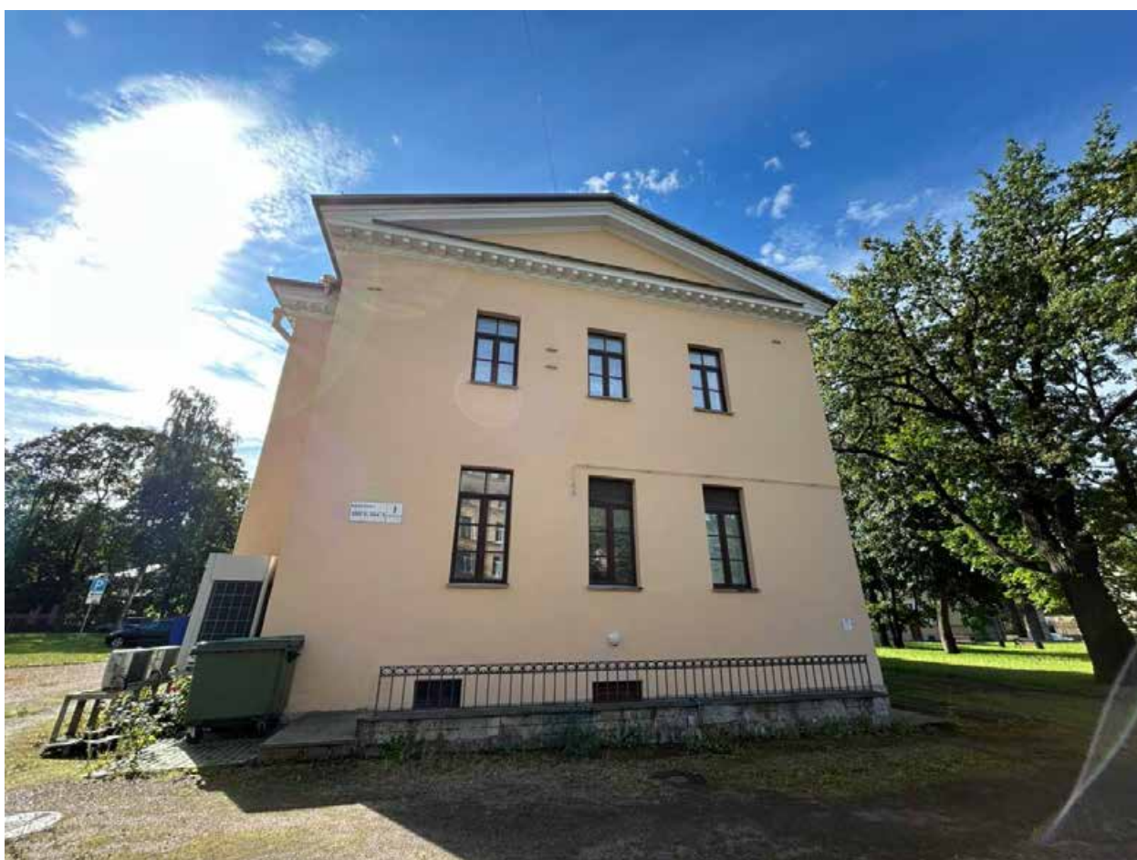
25. Северо-западный фасад объекта культурного наследия регионального значения «Орлово-Новосильцевская богадельня (Комплекс с садом и оградой, 3 флигеля). Флигель», расположенного по адресу: г. Санкт-Петербург, пр. Энгельса д. 1, строение 2. 15.07.2025
