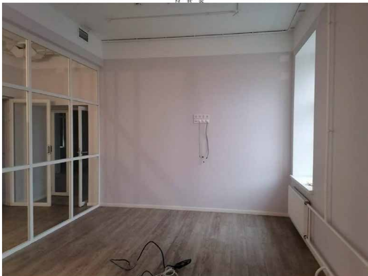
75. Помещение №22 (2Н) в уровне 2 этажа объекта культурного наследия регионального значения «Орлово-Новосильцевская богадельня (Комплекс с садом и оградой, 3 флигеля)». Флигель», расположенного по адресу: г. Санкт-Петербург, пр. Энгельса д. 1, строение 3. 15.07.2025
