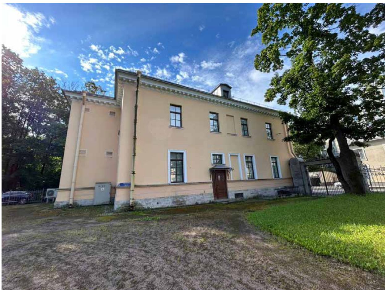
3. Северо-западный фасад объекта культурного наследия регионального значения «Орлово-Новосильцевская богадельня (Комплекс с садом и оградой, 3 флигеля). Флигель», расположенного по адресу: г. Санкт-Петербург, пр. Энгельса д. 1, строение 1. 15.07.2025
