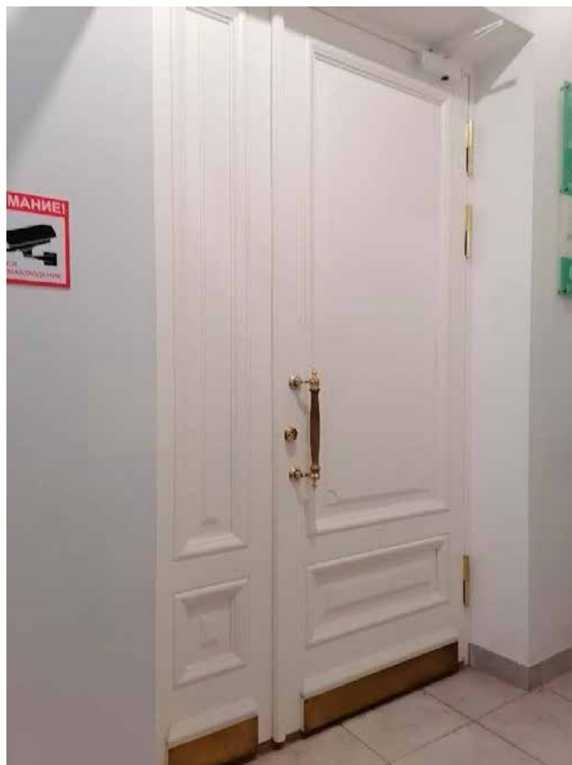
10. Помещение входного вестибюля №1 (2Н) в уровне 1 этажа объекта культурного наследия регионального значения «Орлово-Новосильцевская богадельня (Комплекс с садом и оградой, 3 флигеля). Флигель», расположенного по адресу: г. Санкт-Петербург, пр. Энгельса д. 1, строение 1. 15.07.2025
