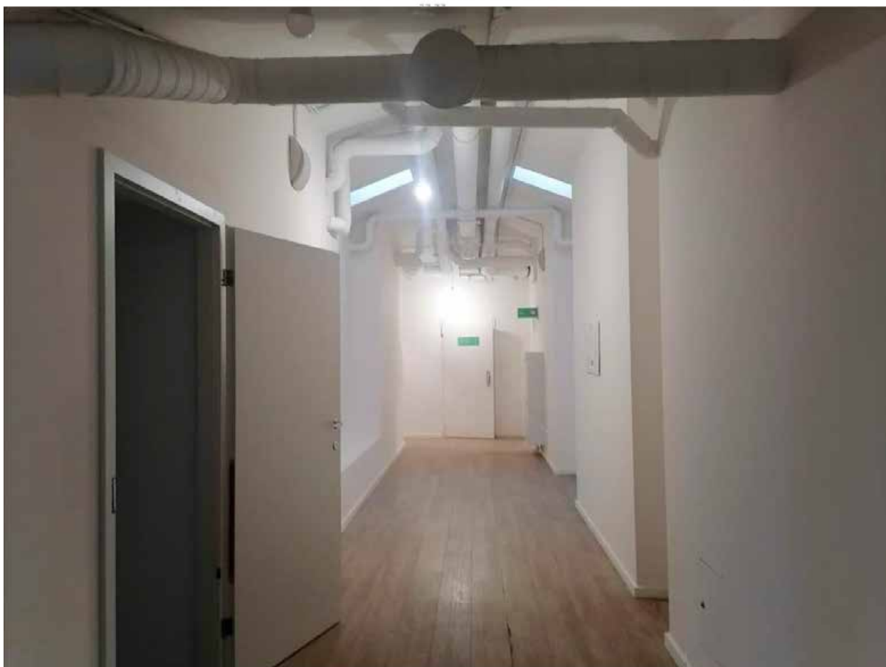
52. Помещение №73 (2Н) в уровне мансарды объекта культурного наследия регионального значения «Орлово-Новосильцевская богадельня (Комплекс с садом и оградой, 3 флигеля). Флигель», расположенного по адресу: г. Санкт-Петербург, пр. Энгельса д. 1, строение 2. 15.07.2025
