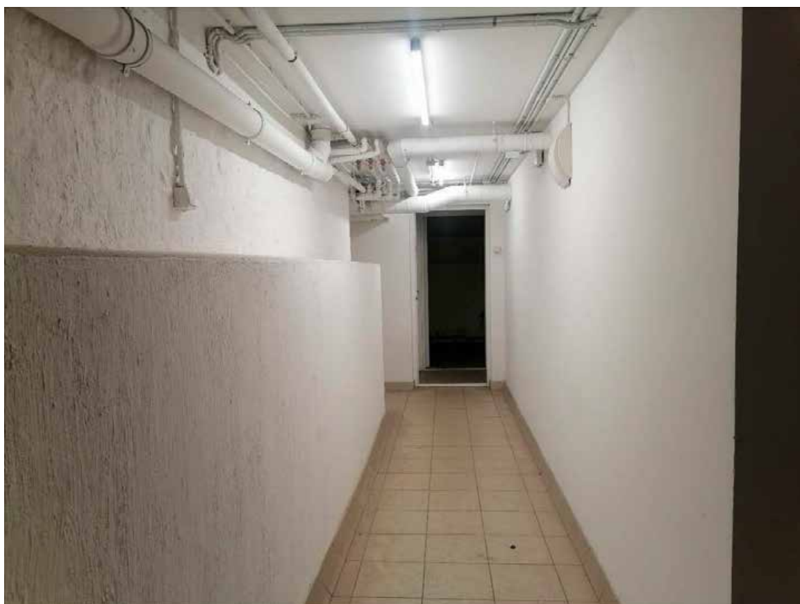
5. Коридор (№1 (1Н)) в уровне подвала объекта культурного наследия регионального значения «Орлово-Новосильцевская богадельня (Комплекс с садом и оградой, 3 флигеля). Флигель», расположенного по адресу: г. Санкт-Петербург, пр. Энгельса д. 1, строение 1. 15.07.2025
