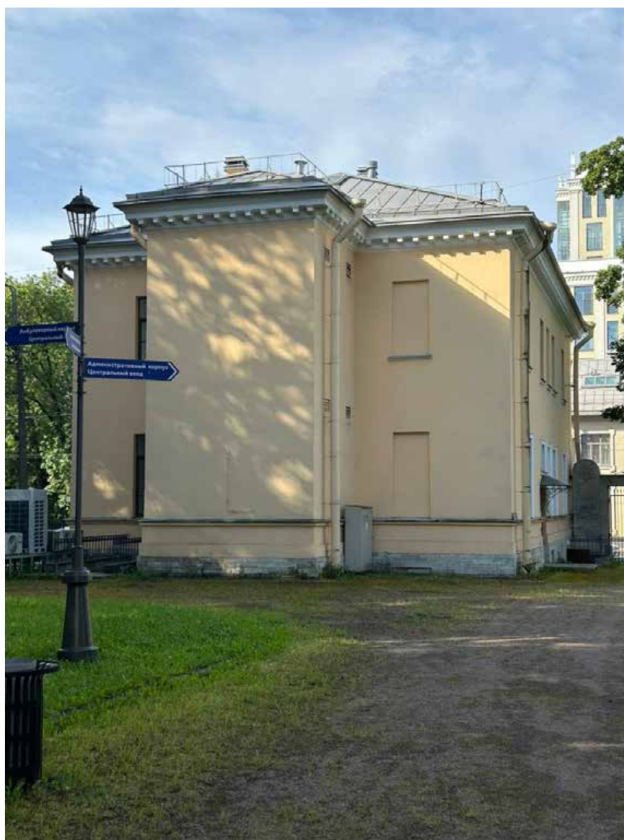
60. Северо-восточный фасад объекта культурного наследия регионального значения «Орлово-Новосильцевская богадельня (Комплекс с садом и оградой, 3 флигеля). Флигель», расположенного по адресу: г. Санкт-Петербург, пр. Энгельса д. 1, строение 3. 15.07.2025
