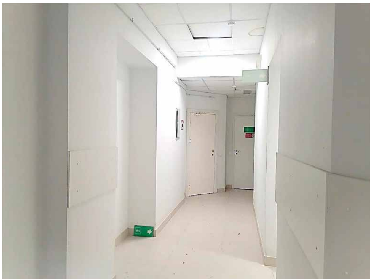
12. Помещение входного вестибюля №4( 2Н) в уровне 1 этажа объекта культурного наследия регионального значения «Орлово-Новосильцевская богадельня (Комплекс с садом и оградой, 3 флигеля). Флигель», расположенного по адресу: г. Санкт-Петербург, пр. Энгельса д. 1, строение 1. 15.07.2025
