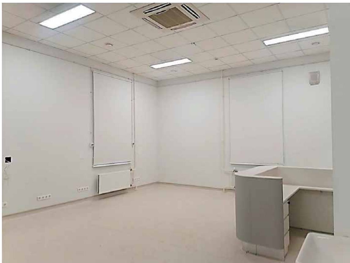
13. Помещение входного вестибюля №11 (2Н) в уровне 1 этажа объекта культурного наследия регионального значения «Орлово-Новосильцевская богадельня (Комплекс с садом и оградой, 3 флигеля). Флигель», расположенного по адресу: г. Санкт-Петербург, пр. Энгельса д. 1, строение 1. 15.07.2025
