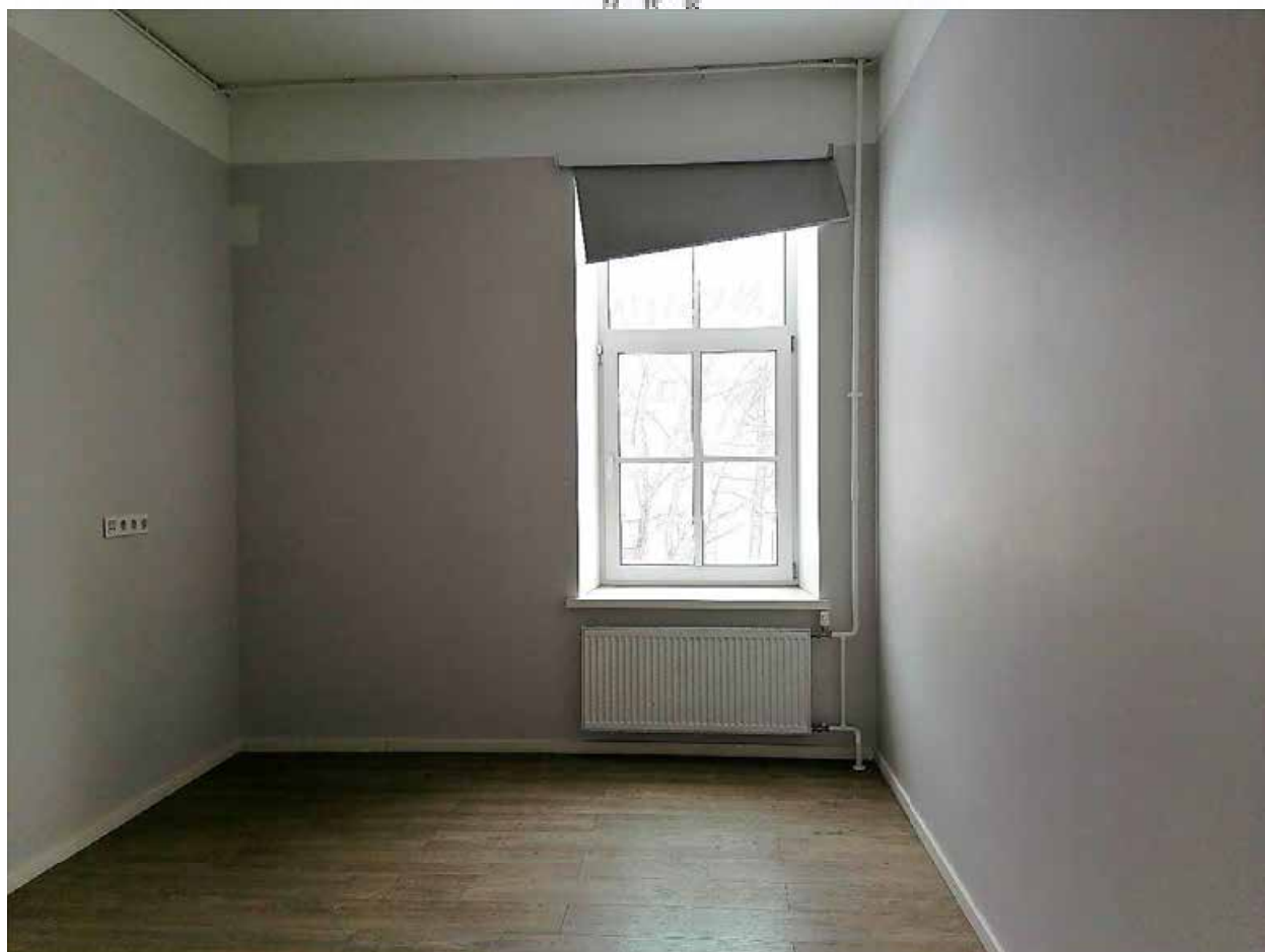
73. Помещение №13 (2Н) в уровне 2 этажа объекта культурного наследия регионального значения «Орлово-Новосильцевская богадельня (Комплекс с садом и оградой, 3 флигеля). Флигель», расположенного по адресу: г. Санкт-Петербург, пр. Энгельса д. 1, строение 3. 15.07.2025
