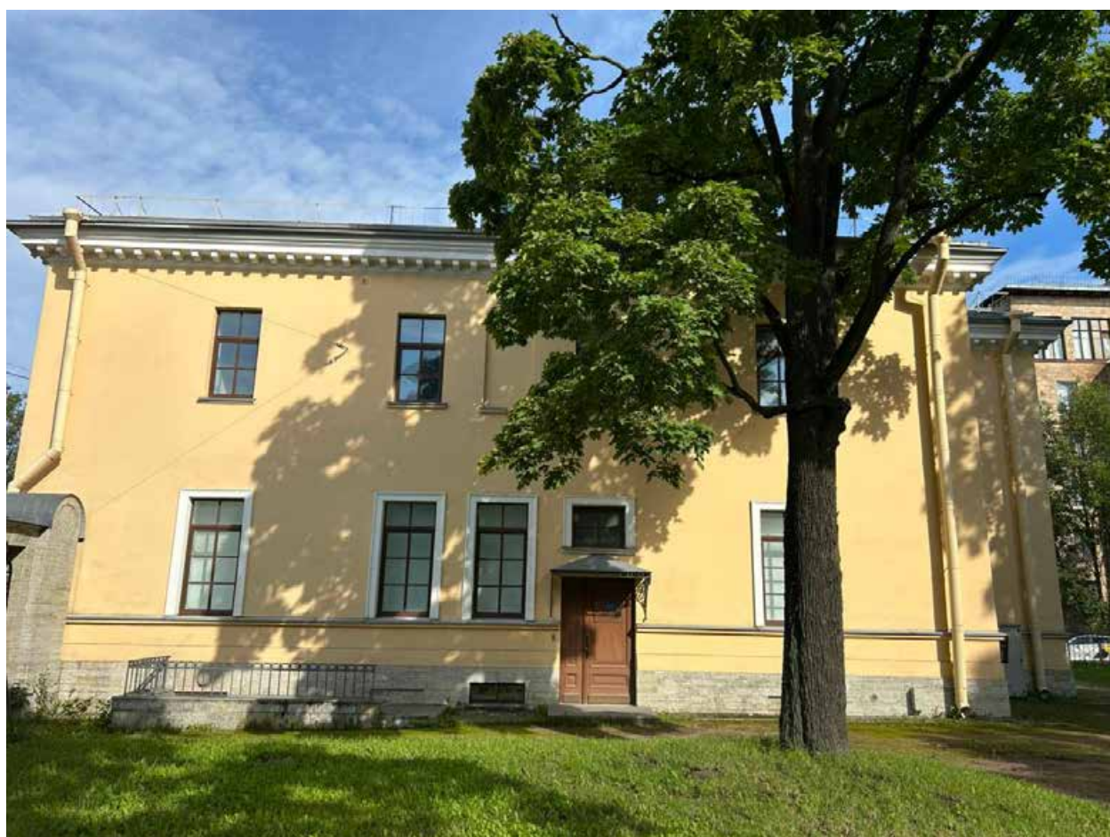
57. Юго-восточный фасад объекта культурного наследия регионального значения «Орлово-Новосильцевская богадельня (Комплекс с садом и оградой, 3 флигеля). Флигель», расположенного по адресу: г. Санкт-Петербург, пр. Энгельса д. 1, строение 3. 15.07.2025
