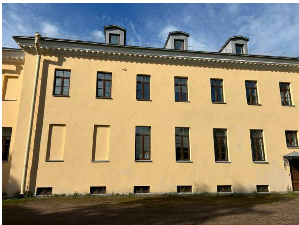
26. Северо-восточный фасад объекта культурного наследия регионального значения «Орлово-Новосильцевская богадельня (Комплекс с садом и оградой, 3 флигеля). Флигель», расположенного по адресу: г. Санкт-Петербург, пр. Энгельса д. 1, строение 2. 15.07.2025
