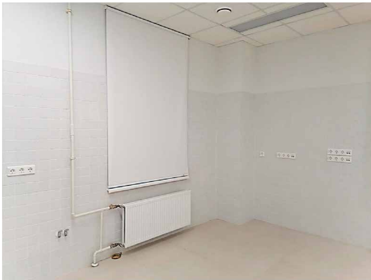
17. Помещение №21 (2Н) в уровне 2 этажа объекта культурного наследия регионального значения «Орлово-Новосильцевская богадельня (Комплекс с садом и оградой, 3 флигеля). Флигель», расположенного по адресу: г. Санкт-Петербург, пр. Энгельса д. 1, строение 1. 15.07.2025
