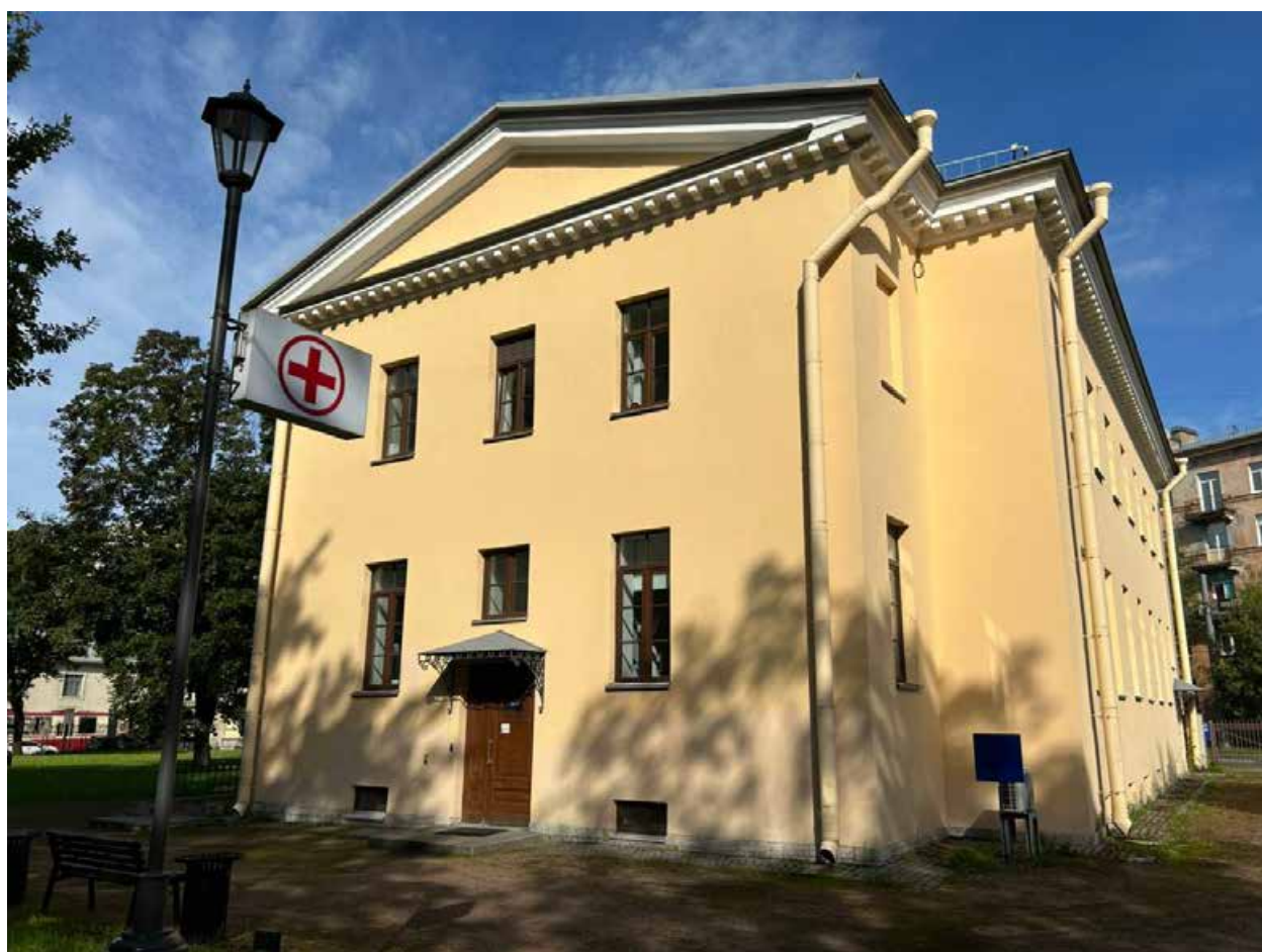
23. Юго-восточный фасад объекта культурного наследия регионального значения «Орлово-Новосильцевская богадельня (Комплекс с садом и оградой, 3 флигеля). Флигель», расположенного по адресу: г. Санкт-Петербург, пр. Энгельса д. 1, строение 2. 15.07.2025
