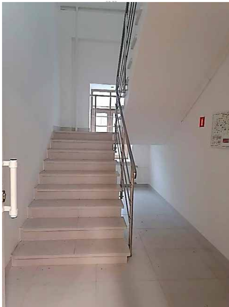
51. Помещение №57 (2Н) в уровне мансарды объекта культурного наследия регионального значения «Орлово-Новосильцевская богадельня (Комплекс с садом и оградой, 3 флигеля). Флигель», расположенного по адресу: г. Санкт-Петербург, пр. Энгельса д. 1, строение 2. 15.07.2025
