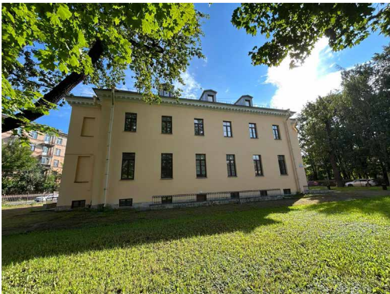
24. Юго-западный фасад объекта культурного наследия регионального значения «Орлово-Новосильцевская богадельня (Комплекс с садом и оградой, 3 флигеля). Флигель», расположенного по адресу: г. Санкт-Петербург, пр. Энгельса д. 1, строение 2. 15.07.2025
