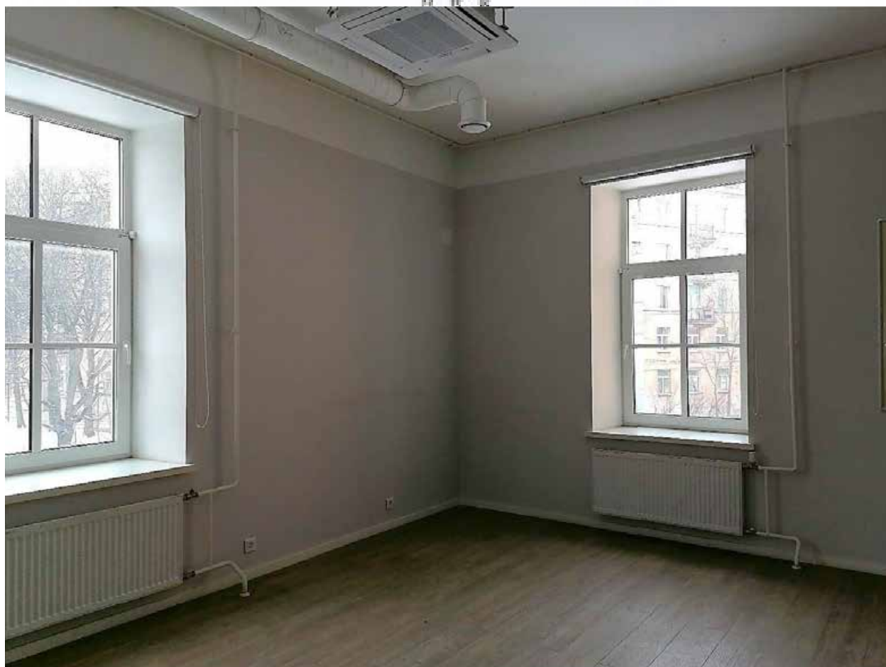
74. Помещение №25 (2Н) в уровне 2 этажа объекта культурного наследия регионального значения «Орлово-Новосильцевская богадельня (Комплекс с садом и оградой, 3 флигеля)». Флигель», расположенного по адресу: г. Санкт-Петербург, пр. Энгельса д. 1, строение 3. 15.07.2025
