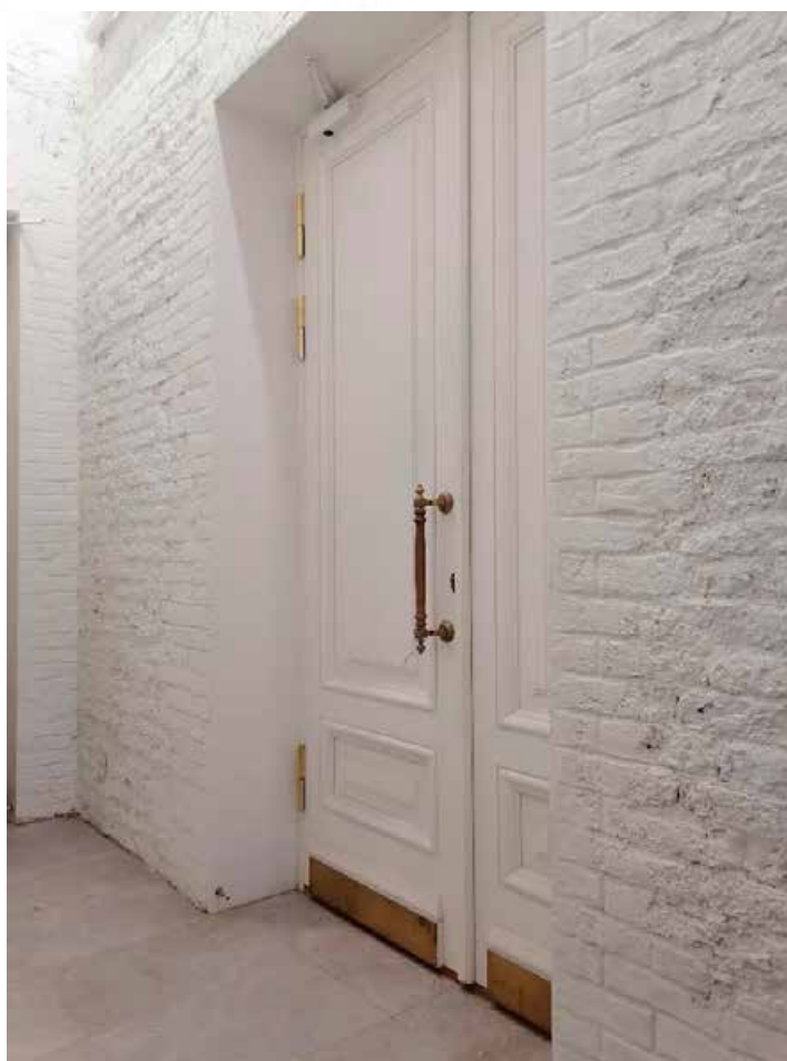
67. Вход в помещение лестницы №9 (2Н) в уровне 1 этажа объекта культурного наследия регионального значения «Орлово-Новосильцевская богадельня (Комплекс с садом и оградой, 3 флигеля). Флигель», расположенного по адресу: г. Санкт-Петербург, пр. Энгельса д. 1, строение 3. 15.07.2025
