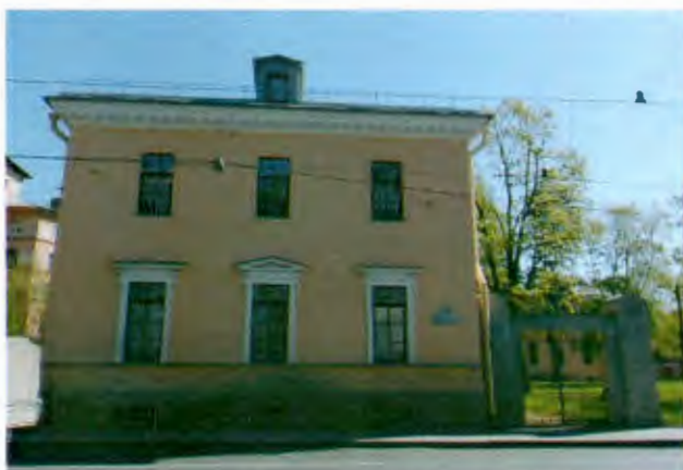
18. Лицевой (западный) фасад здания.
