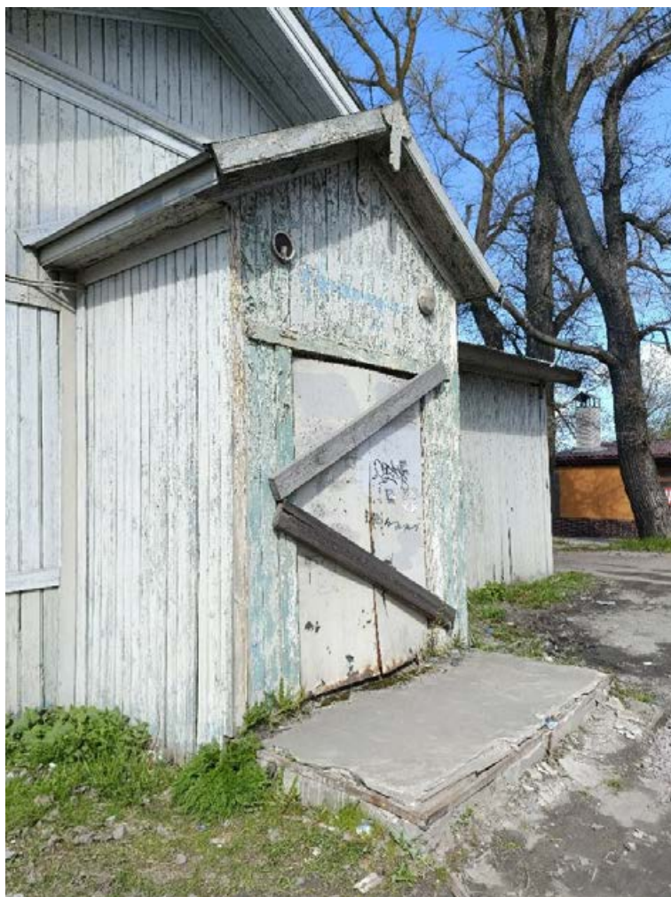
Фото 3. Крыльцо и тамбур с востока.
