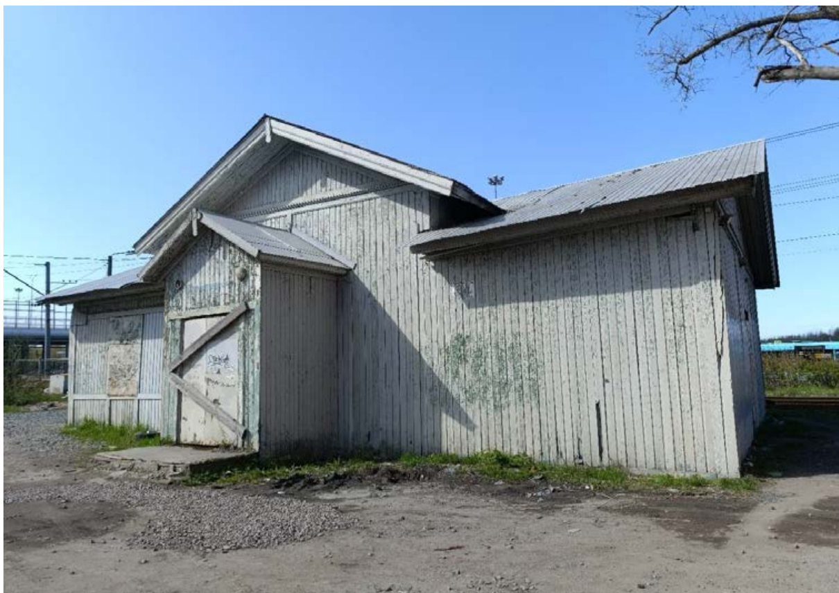
Фото 5. Общий вид объекта с северо-востока.
