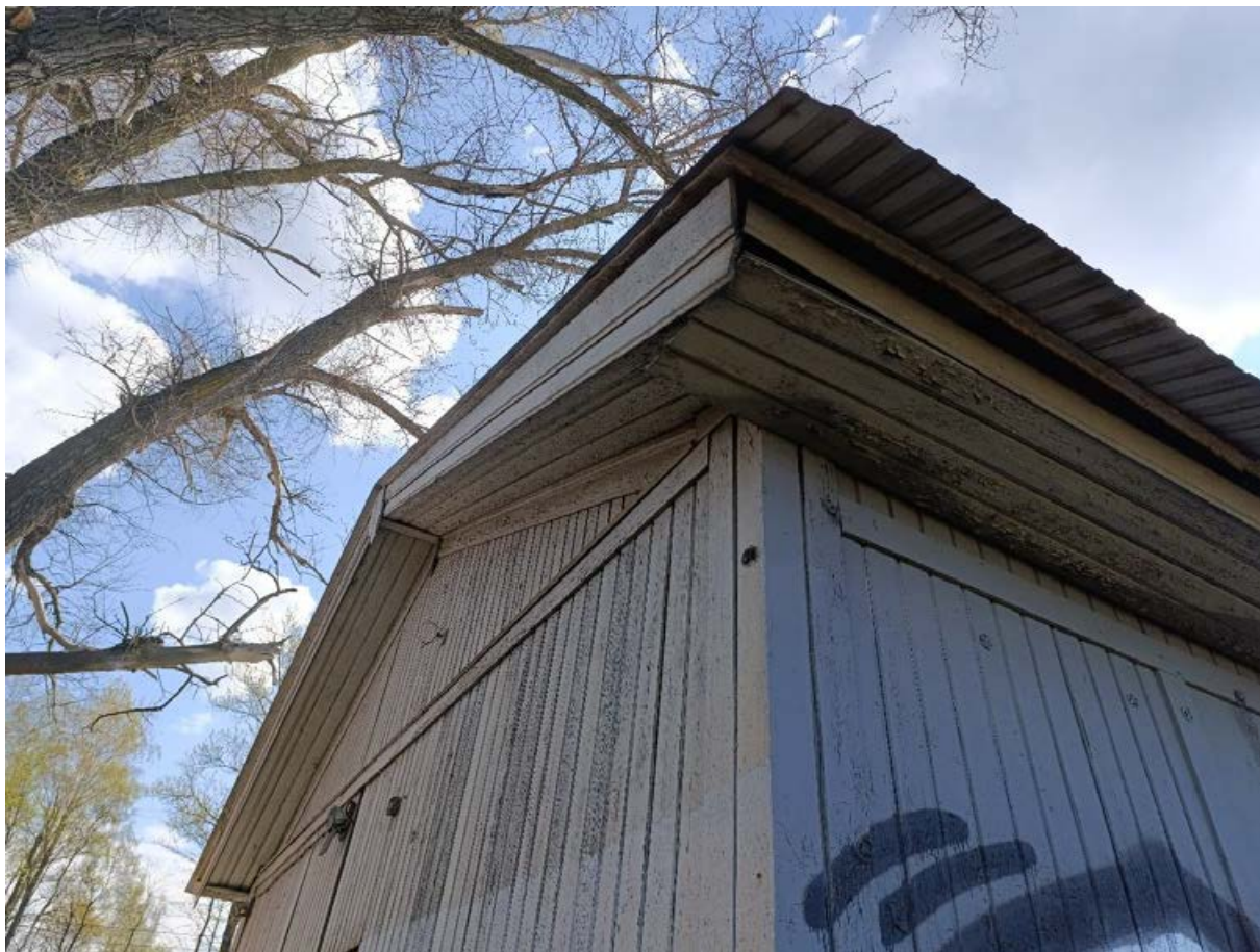
Фото 7. Фрагмент карниза северного и западного фасадов.
