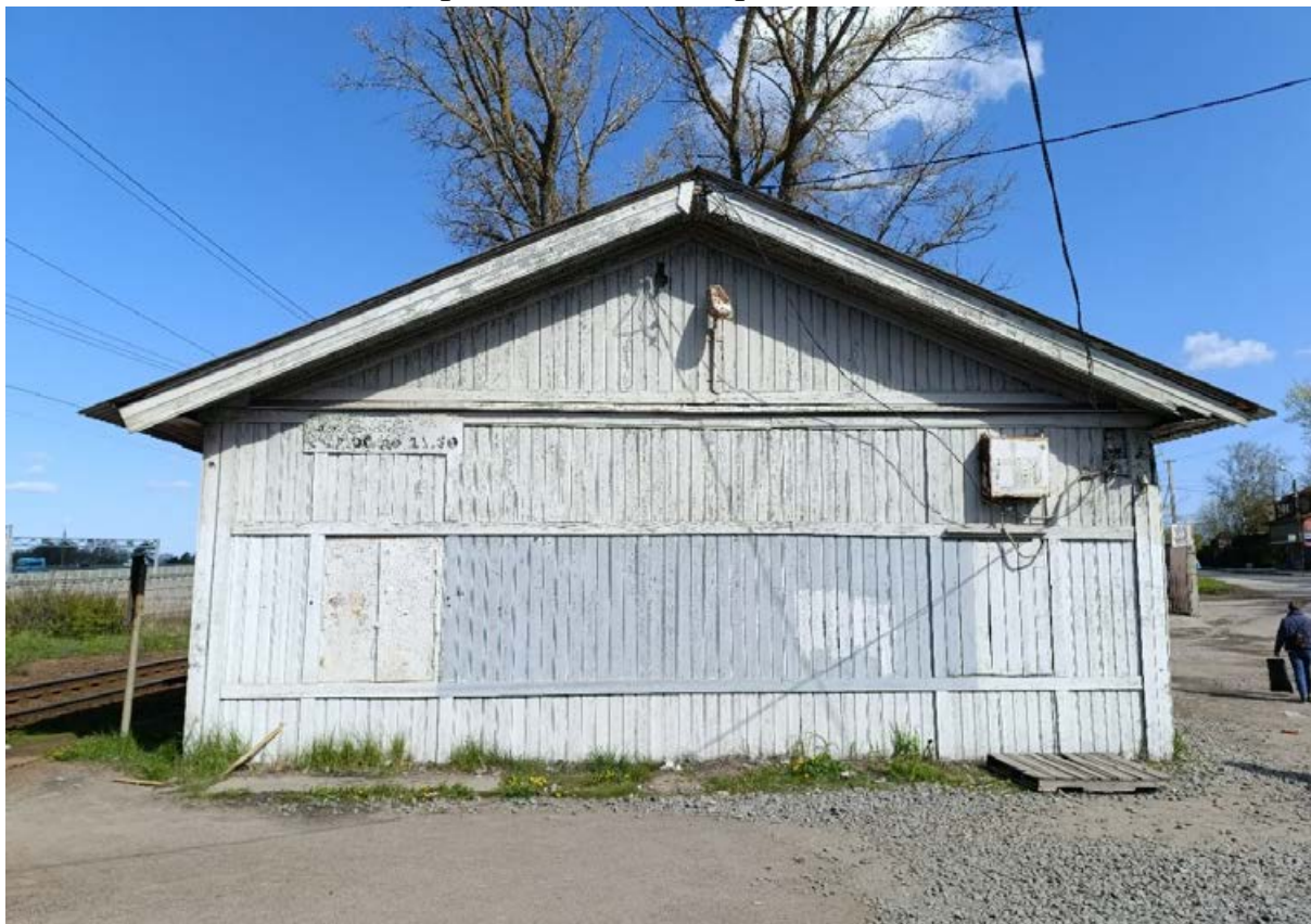
Фото 1. Южный фасад объекта «Железнодорожный вокзал платформы Горская».
