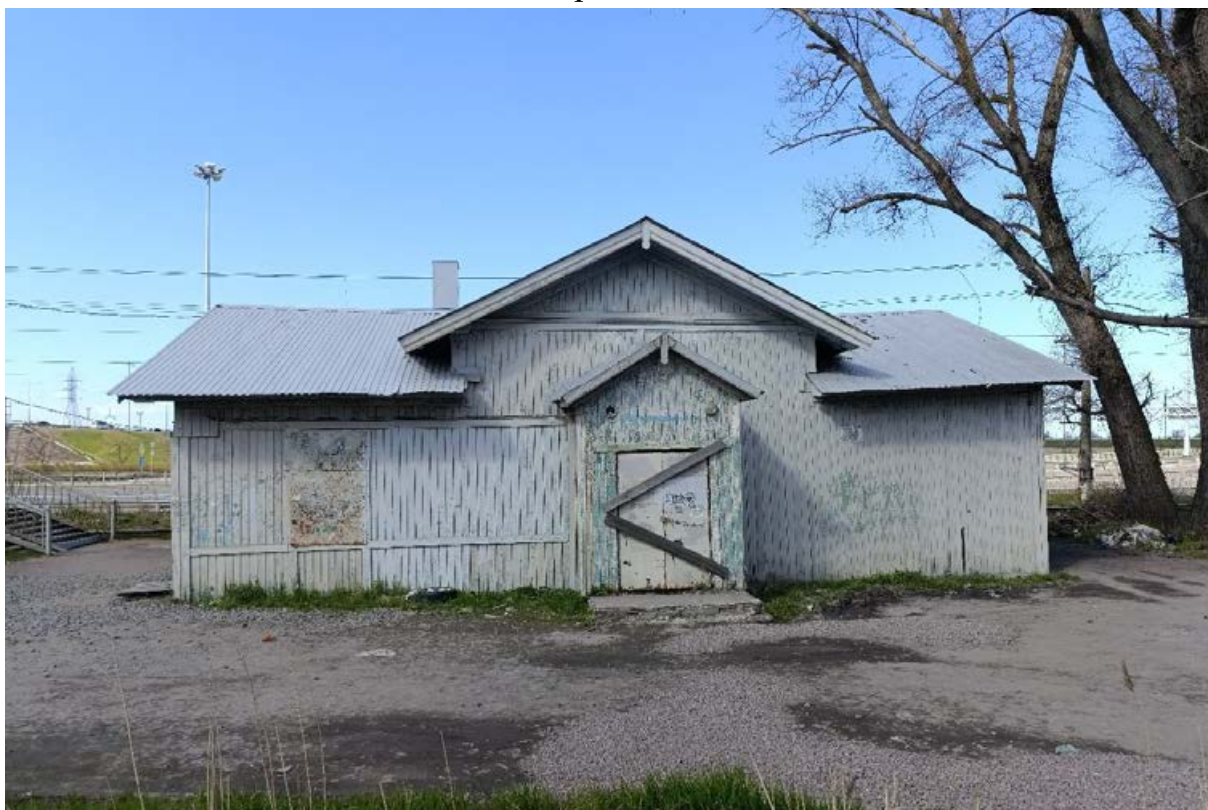
Фото 2. Восточный фасад, общий вид.
