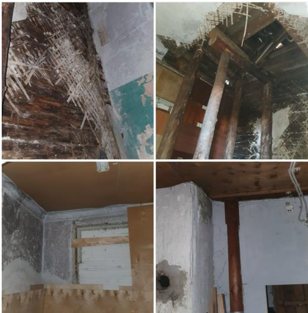
35. Фрагменты помещений. Фотографии начала 2025. [Электронный портал] URL: https://vk.com/ravomaki?w=wall-218237359_160 .
