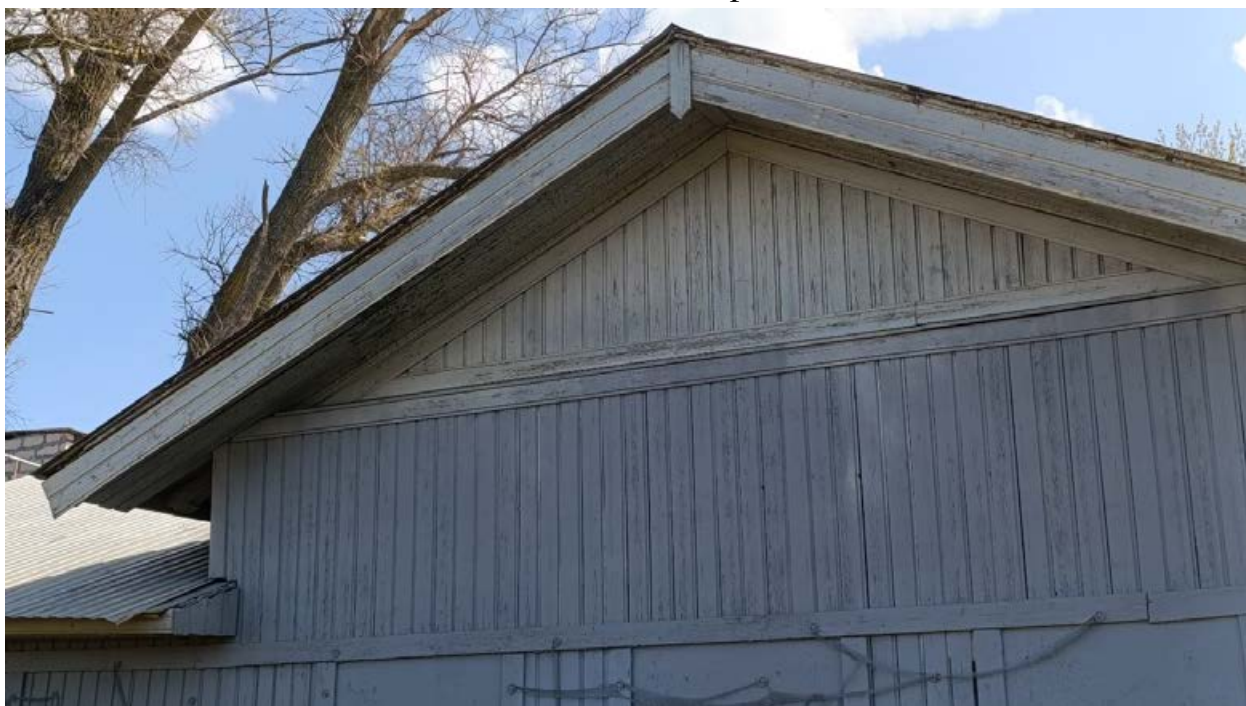
Фото 10. Фрагмент западного фасада, карниз.
