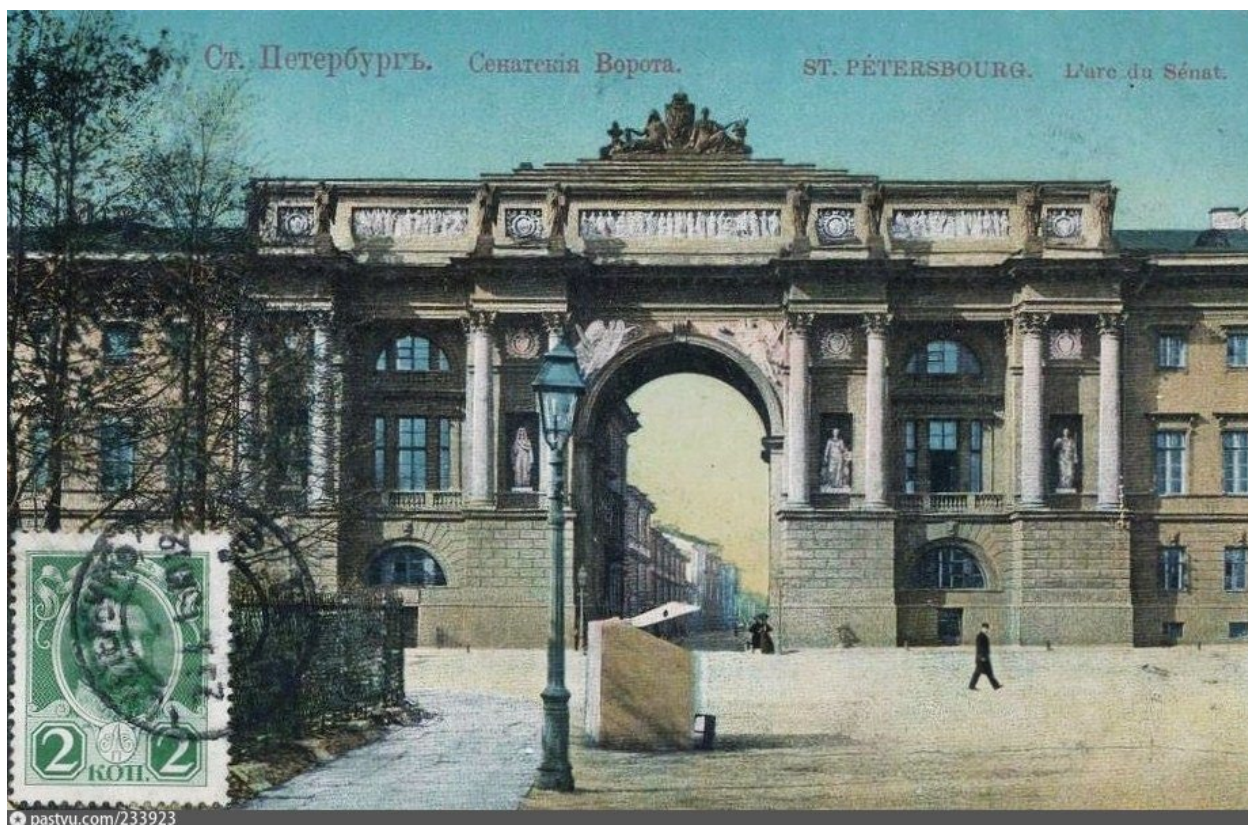
Илл. 19. Вид на Галерную улицу через Сенатские Ворота. https://img-fotki.yandex.ru/
