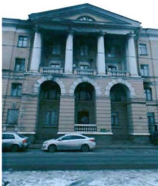
10. Портик западного фасада.
