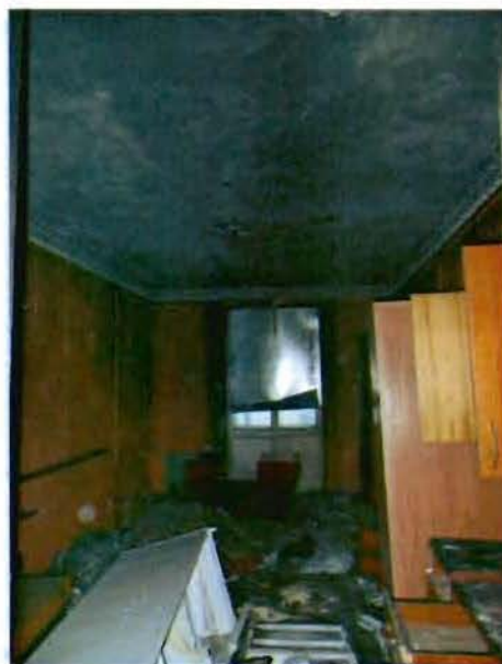
20. Помещение третьего этажа.
