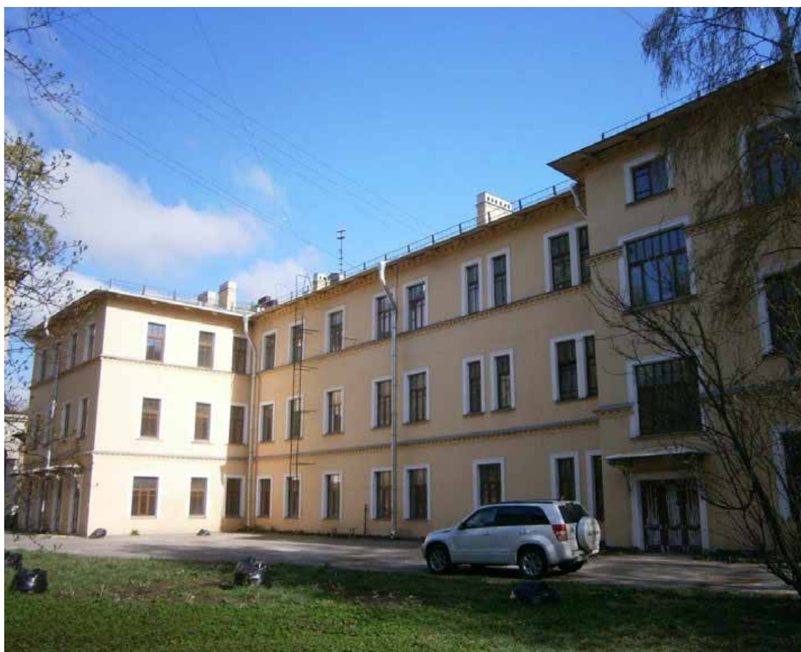
Илл. 14. Пр. Стачек, д. 34 к. 1. Южный фасад. 2014 г. Citywalls – Архитектурный сайт Санкт-Петербурга [Электронный ресурс] URL: https://www.citywalls.ru/photo301289.html .
