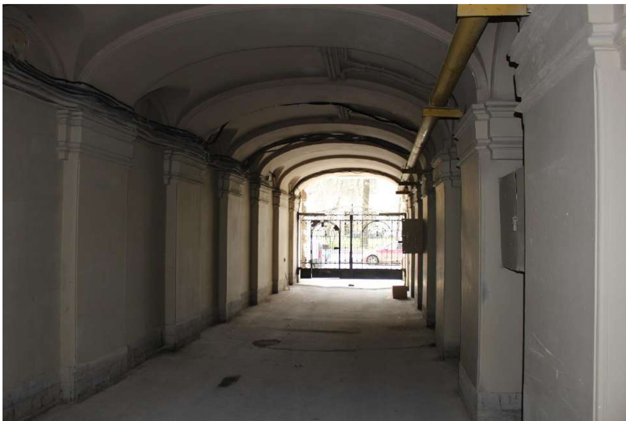
Фото 3. Арка воротного проезда объекта культурного наследия регионального значения «Дом Г.Г. Елисеева».
