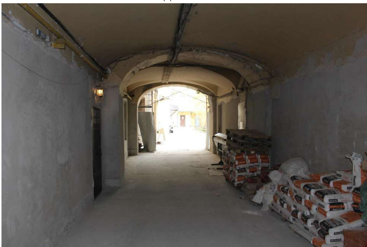
Фото 4. Арка воротного проезда объекта культурного наследия регионального значения «Дом Г.Г. Елисеева».
