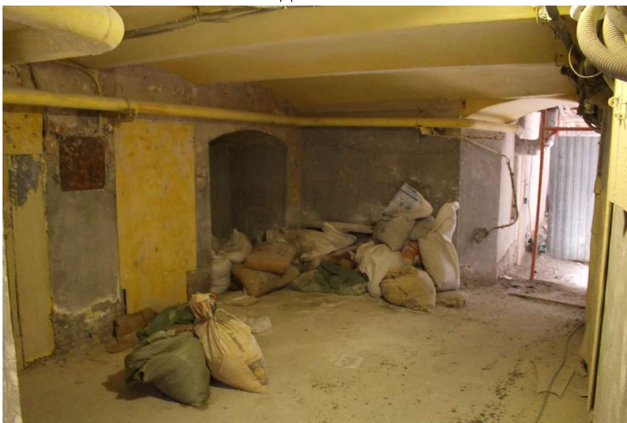
Фото 11. Арка воротного проезда дворового корпуса объекта культурного наследия регионального значения «Дом Г.Г. Елисеева».
