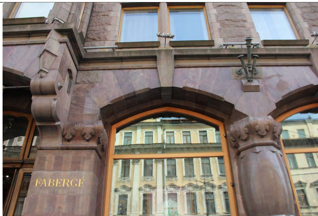
Лицевой фасад. Перемычки витринных окон.
