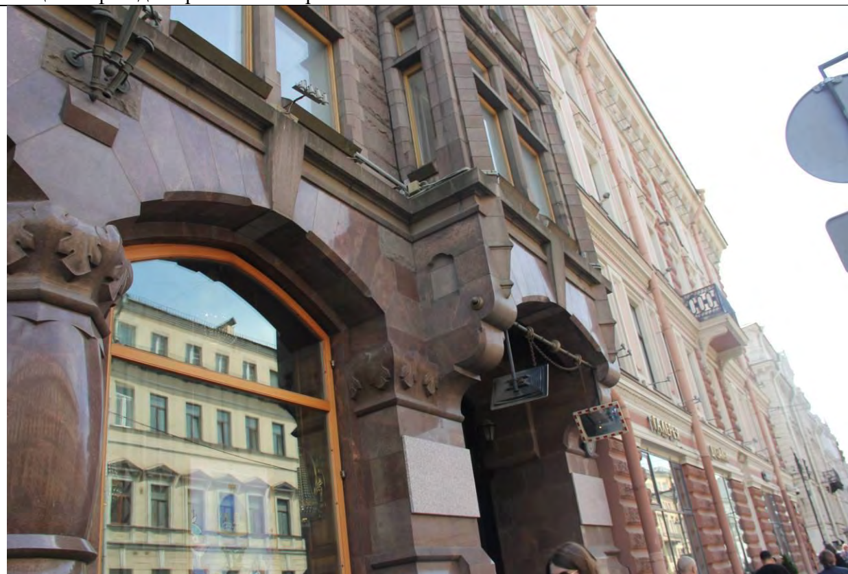
Лицевой фасад. Первый этаж. Правая часть.
