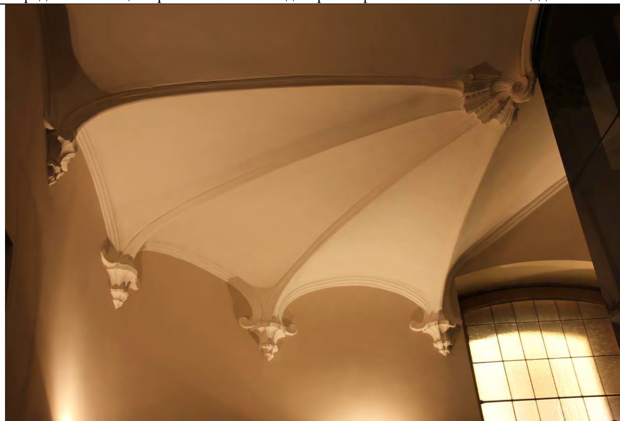
Парадная лестница. Лепной декор угла лестничной площадки.
