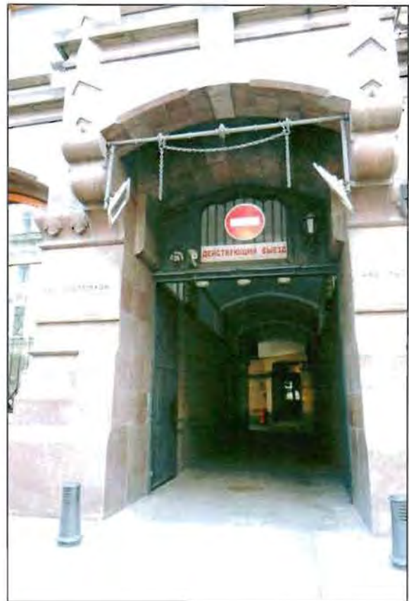
3. Лицевой фасад. Фрагмент. Арочный проезд
