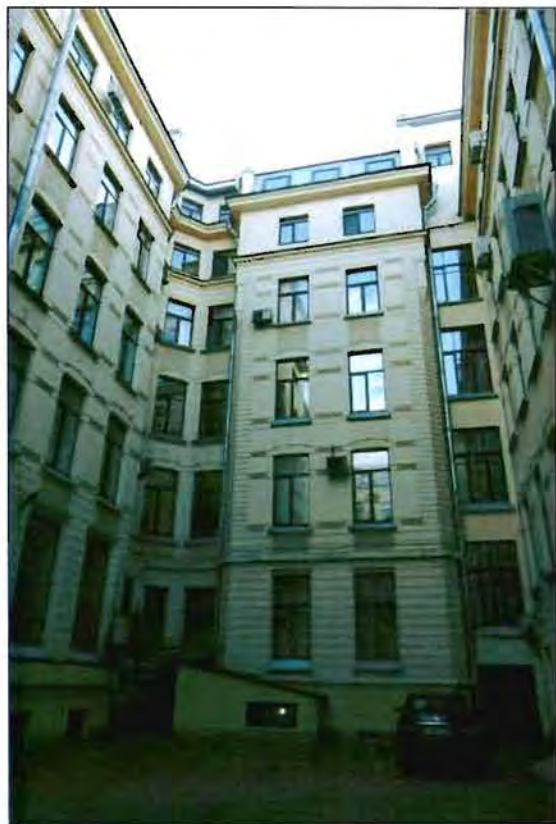
5. Дворовый фасад. Общий вид.
