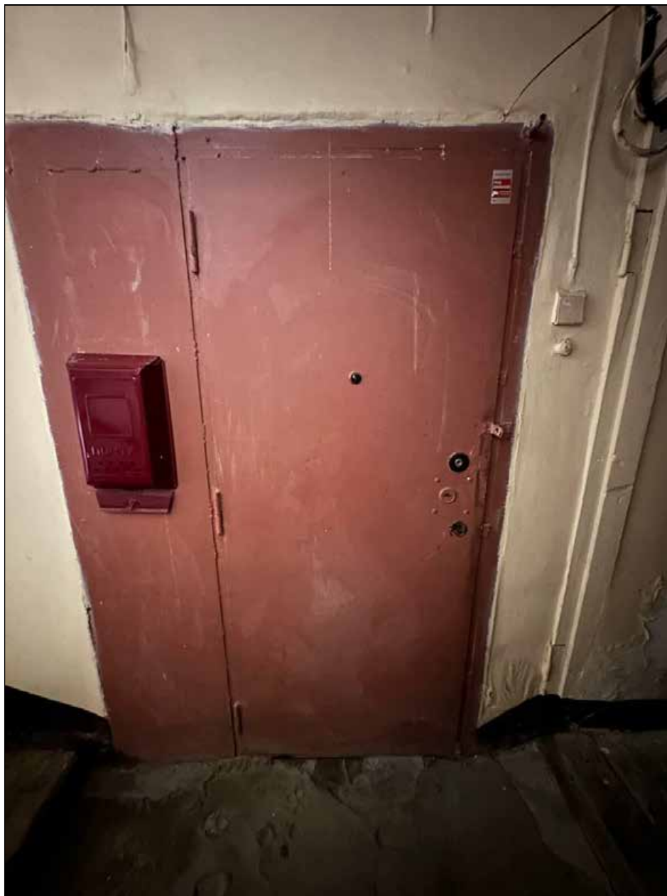
16. Лестница флигеля, первый этаж. Существующее дверное заполнение заложенного входного дверного проёма пом. 1-Н (в муляжном состоянии)*.
