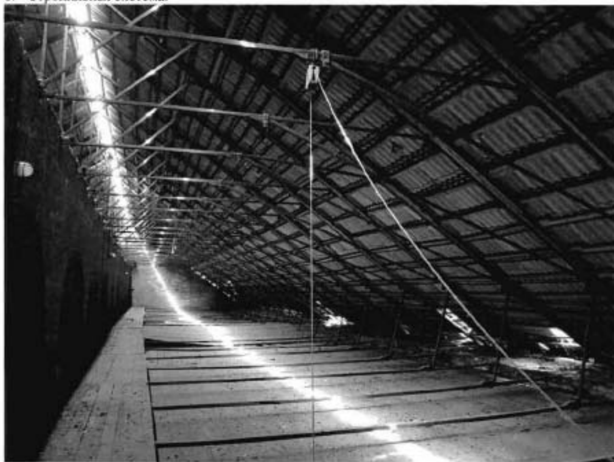
8. Стропильная система.
