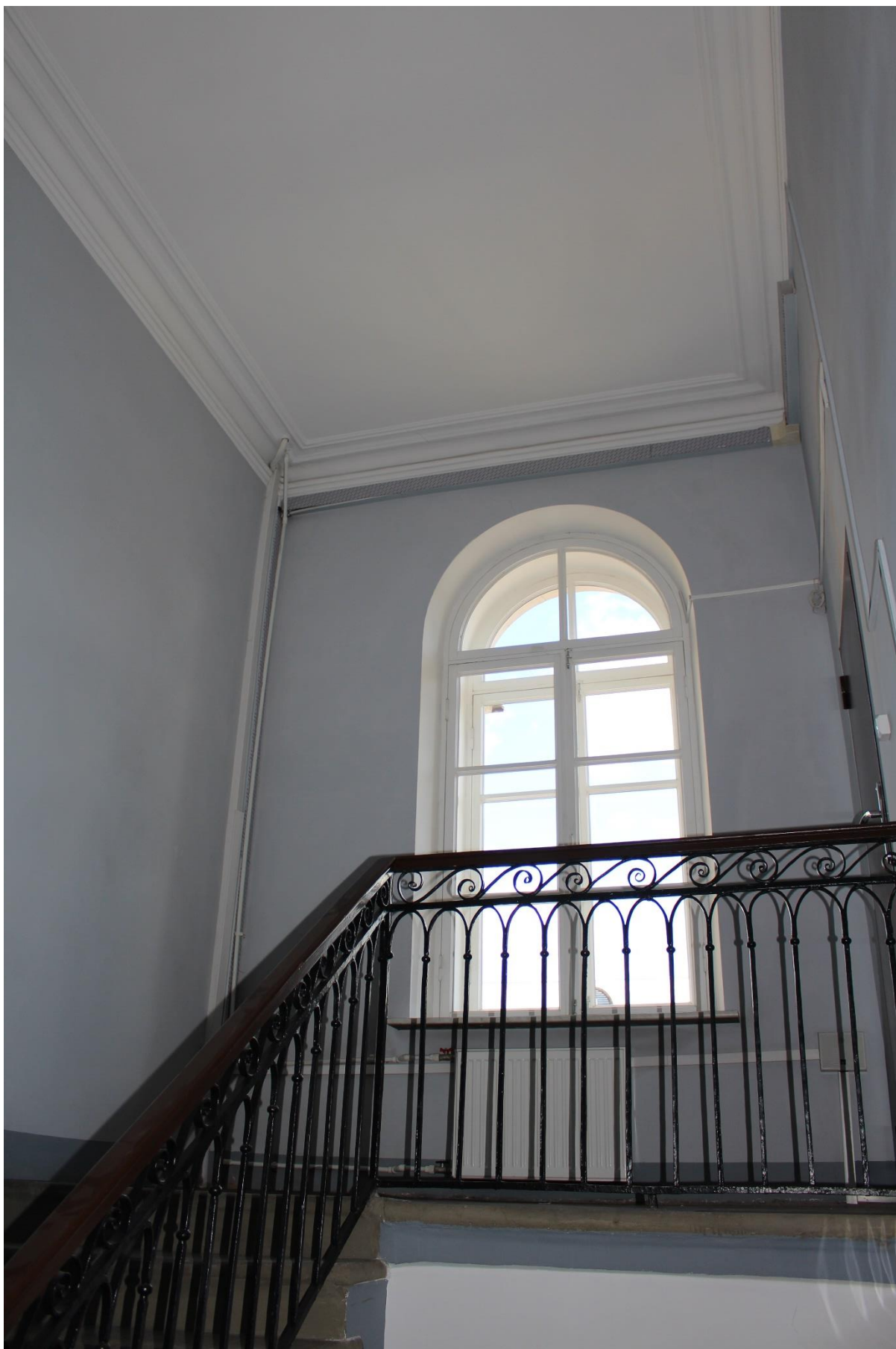
Фото 103. Объект культурного наследия федерального значения «Дом плац-майорский». Лестница в северной части здания.
