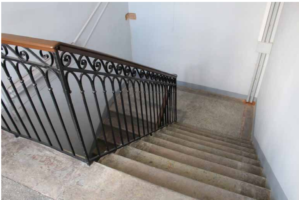
Фото 104. Объект культурного наследия федерального значения «Дом плац-майорский». Лестница в северной части здания.
