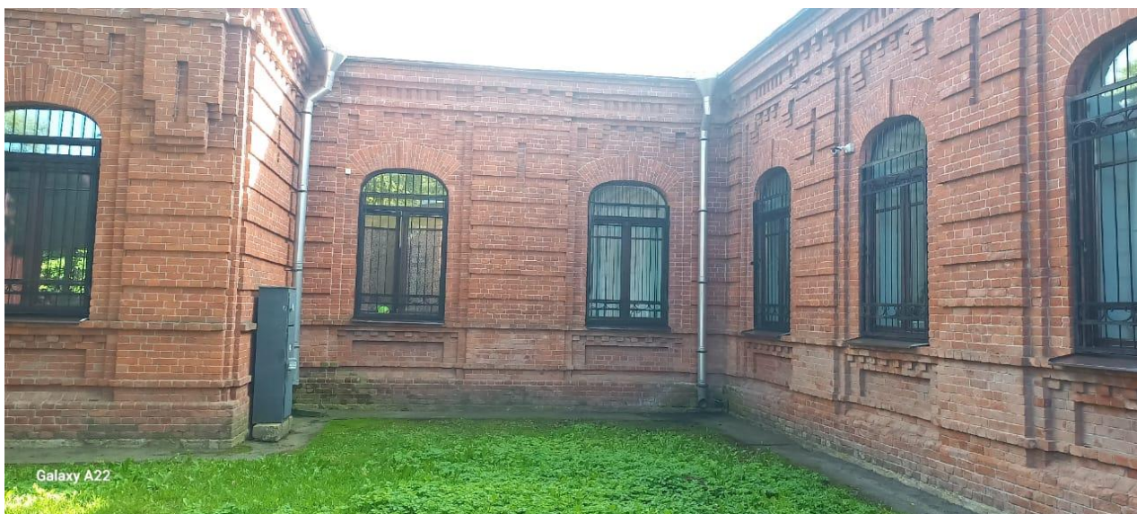
28. «Школа Адмиралтейских Ижорских заводов». Торцевой фасад. «Заводы Ижорские Адмиралтейские» (территория). Штиглиц М.С. 16.08.2025.
