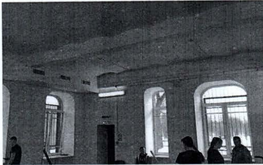
22. Вид на помещение 1-Н (37)
