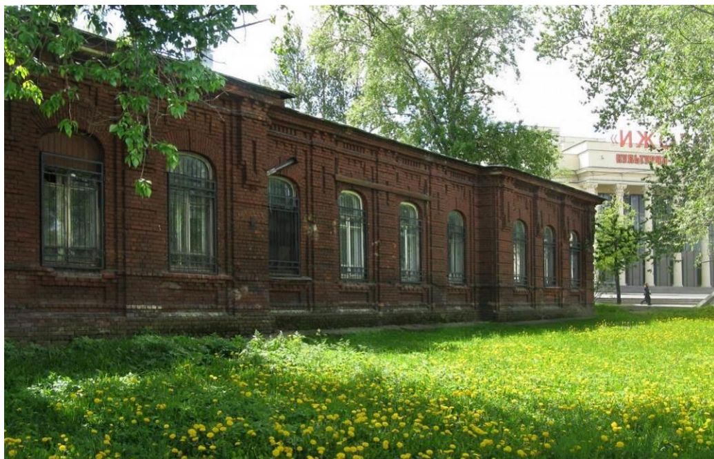
15. «Школа Адмиралтейских Ижорских заводов». Торцевой фасад. «Заводы Ижорские Адмиралтейские» (территория). Штиглиц М.С. 16.08.2025.
