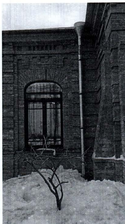
13. Фрагмент западного лицевого фасада объекта культурного наследия
