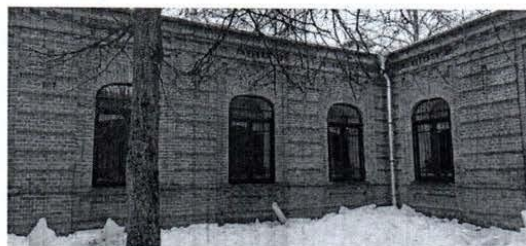
9. Фрагмент восточного лицевого фасада западного крыла объекта культурного наследия
