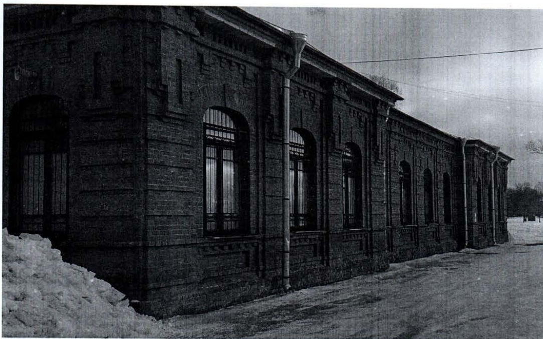
2. Вид на южный лицевой фасад объекта культурного наследия
