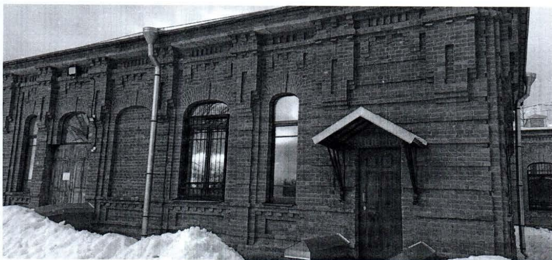
3. Вид на восточный фасад южного крыла объекта культурного наследия
