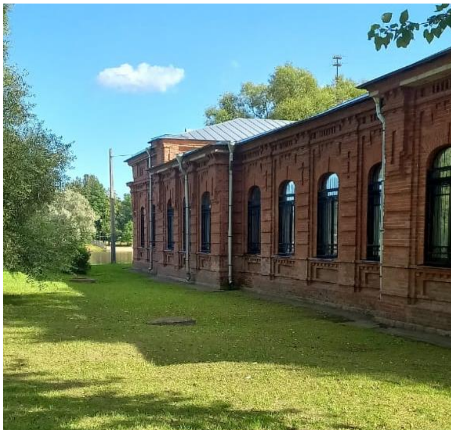
14. «Школа Адмиралтейских Ижорских заводов». Торцевой фасад. «Заводы Ижорские Адмиралтейские» (территория). Штиглиц М.С. 16.08.2025.
