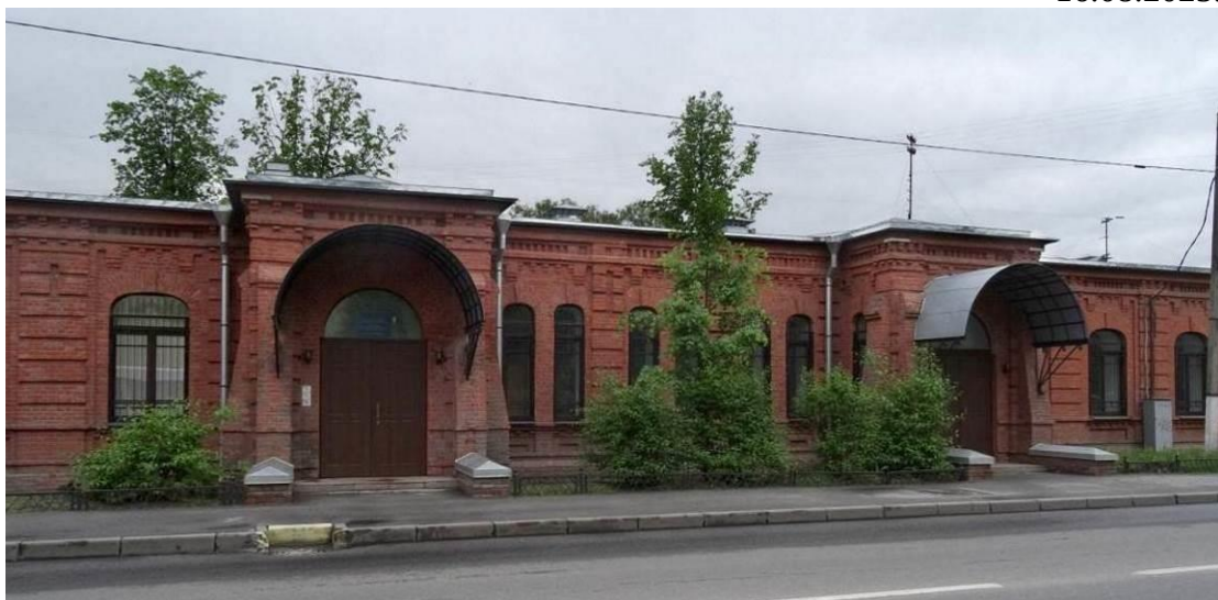
2. «Школа Адмиралтейских Ижорских заводов». Лицевой фасад. Фрагмент. Штиглиц М.С. 16.08.2025.
