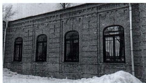
7. Фрагмент восточного дворового фасада объекта культурного наследия
