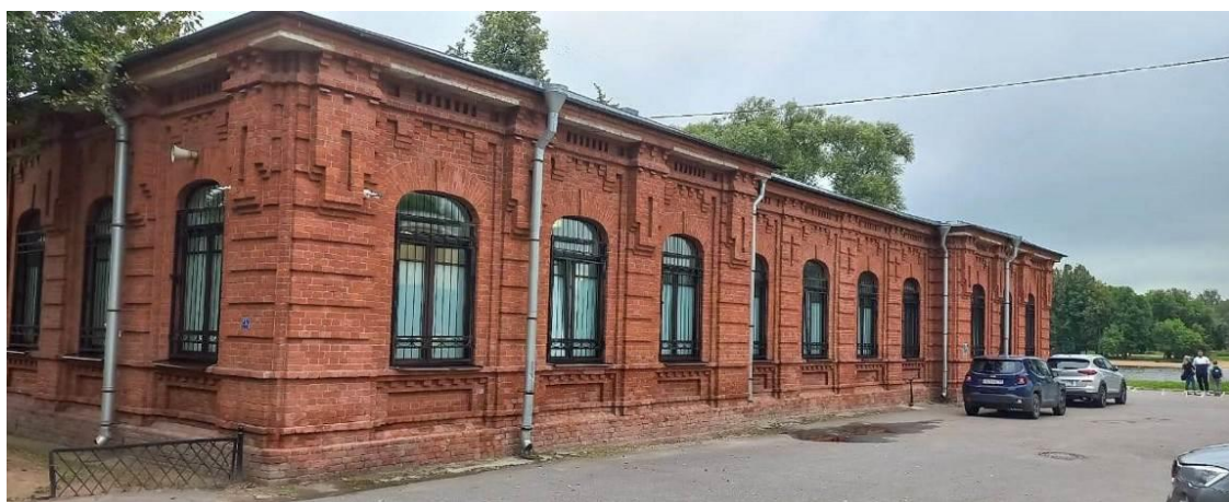
10. «Школа Адмиралтейских Ижорских заводов». Торцевой фасад. «Заводы Ижорские Адмиралтейские» (территория). Штиглиц М.С. 16.08.2025.
