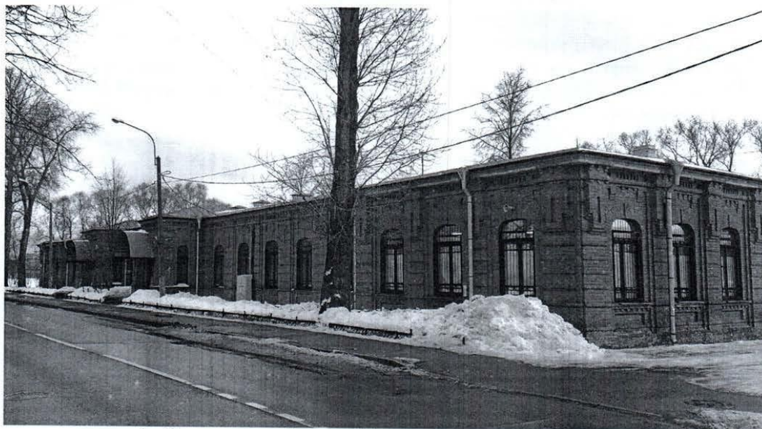
1. Вид на западный лицевой фасад объекта культурного наследия
