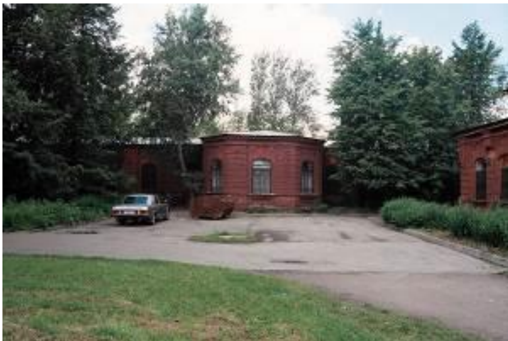
6. «Школа Адмиралтейских Ижорских заводов». Дворовый фасад. Штиглиц М.С. 16.08.2025.
