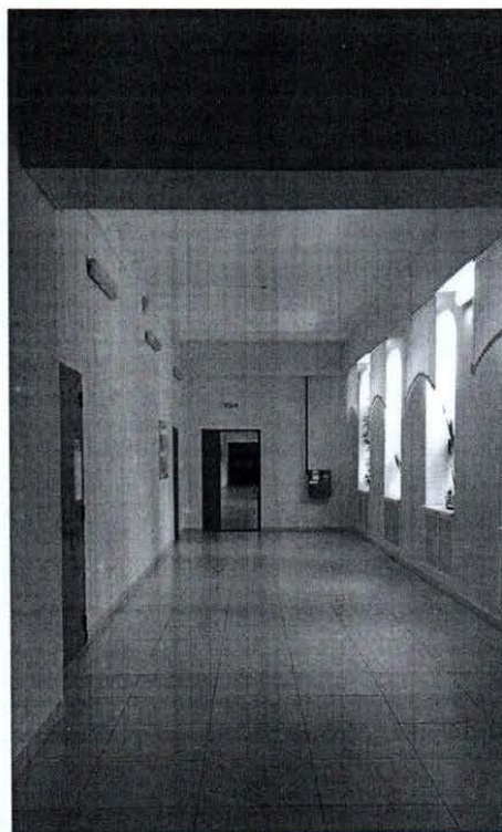
17. Вид на помещение 1-Н (3)
