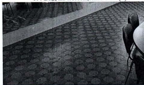
21. Вид на помещение 1-Н (32)
