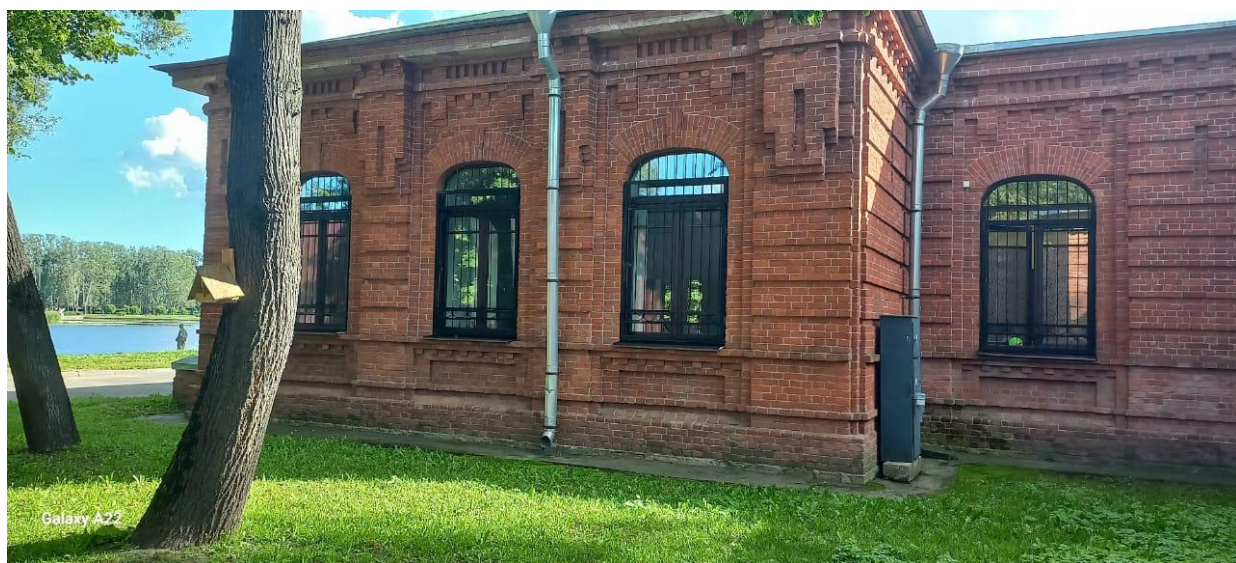
27. «Школа Адмиралтейских Ижорских заводов». Торцевой фасад. «Заводы Ижорские Адмиралтейские» (территория). Штиглиц М.С. 16.08.2025.
