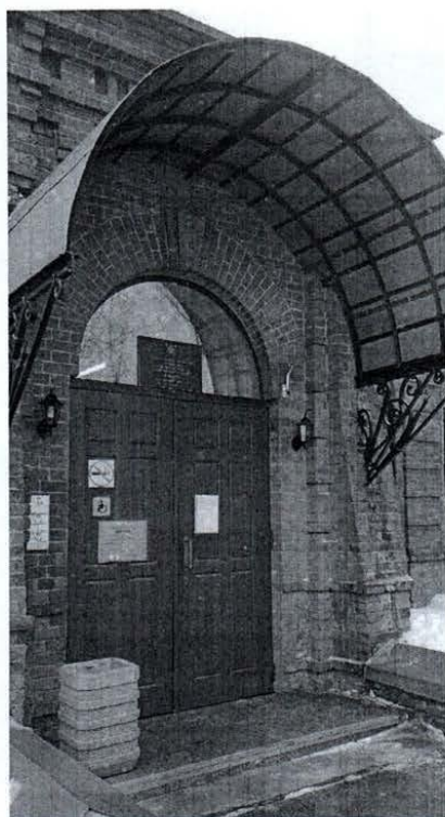
12. Фрагмент западного лицевого фасада объекта культурного наследия
