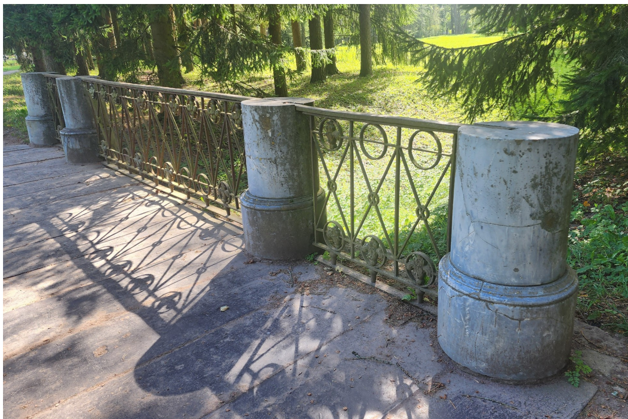
Фото 2. Западное ограждение моста.
