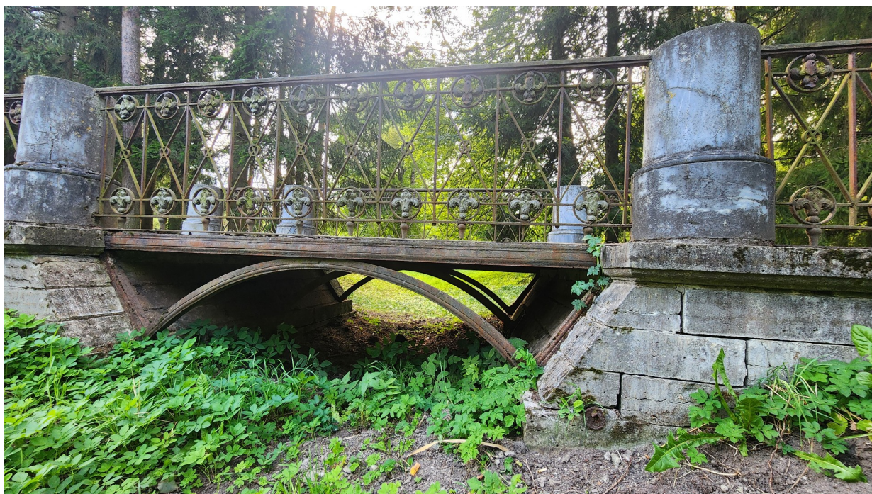
Фото 7. Металлические арки и горизонтальные балки.
