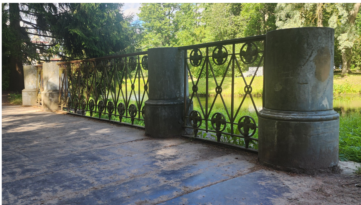
Фото 4. Металлическое кованое перильное ограждение (восточное) с геометрическим рисунком с литыми вставками в виде лилий.
