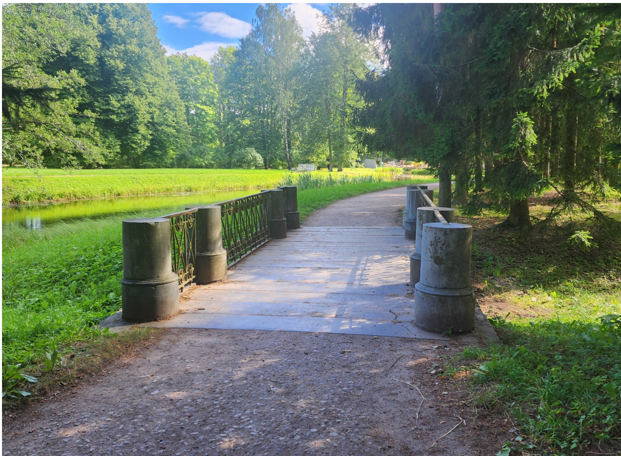
Фото 1. Общий вид моста.
