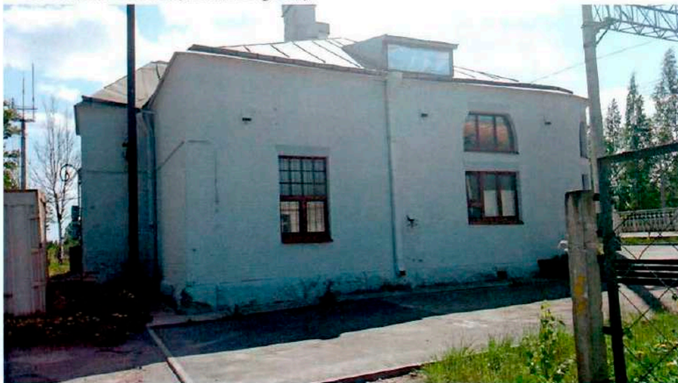
3. Здание вокзала (западный фасад).
