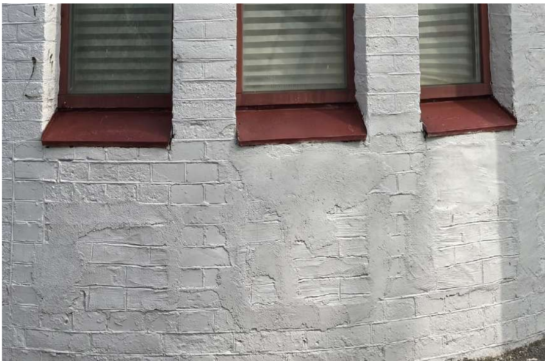
Фото 23. Объект культурного наследия регионального значения «Железнодорожная станция Левашово: вокзал» по адресу: г. Санкт-Петербург, п. Левашово, Железнодорожная ул., д. 7, лит. А (Левашово, железнодорожная станция. Вокзальное шоссе, 43). Вид на замененную кирпичную кладку (западный фасад). Дата: 25.07.2025 г.
