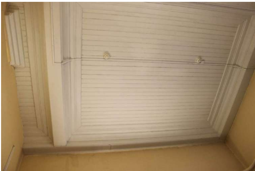
Фото 13. Объект культурного наследия регионального значения «Железнодорожная станция Левашово: вокзал» по адресу: г. Санкт-Петербург, п. Левашово, Железнодорожная ул., д. 7, лит. А (Левашово, железнодорожная станция. Вокзальное шоссе, 43). Вид на плафоны подшивные кессонированные в помещениях №10, являющиеся предметом охраны. Дата: 25.07.2025 г.
