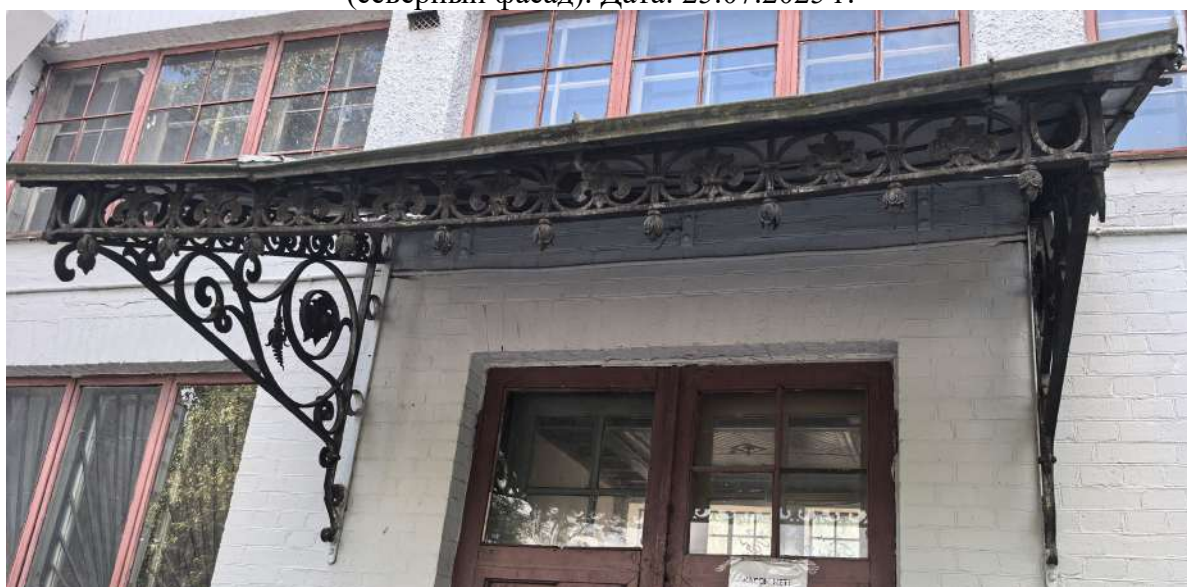
Фото 16. Объект культурного наследия регионального значения «Железнодорожная станция Левашово: вокзал» по адресу: г. Санкт-Петербург, п. Левашово, Железнодорожная ул., д. 7, лит. А (Левашово, железнодорожная станция. Вокзальное шоссе, 43). Вид на металлический козырек с фигурными кронштейнами, являющийся предметом охраны (северный фасад). Дата: 25.07.2025 г.
