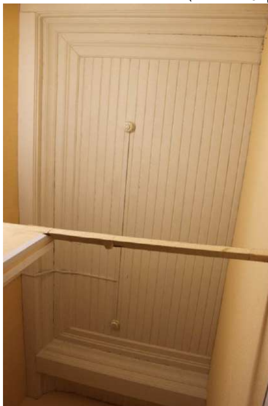
Фото 8. Объект культурного наследия регионального значения «Железнодорожная станция Левашово: вокзал» по адресу: г. Санкт-Петербург, п. Левашово, Железнодорожная ул., д. 7, лит. А (Левашово, железнодорожная станция. Вокзальное шоссе, 43). Вид на плафоны подшивные кессонированные в помещениях №11-12, являющимися предметом охраны Дата: 25.07.2025 г.
