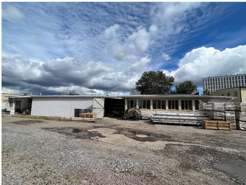
Фото №13. «Производственный корпус» (Митрофаньевское шоссе, дом 8а, литера Р), кирпичное сооружение, кадастровый № 78:32:0750102:3327 (№3 на схеме). «Навесы», некапитальное сооружение, не стоят на кадастровом учете (№8 на схеме).
