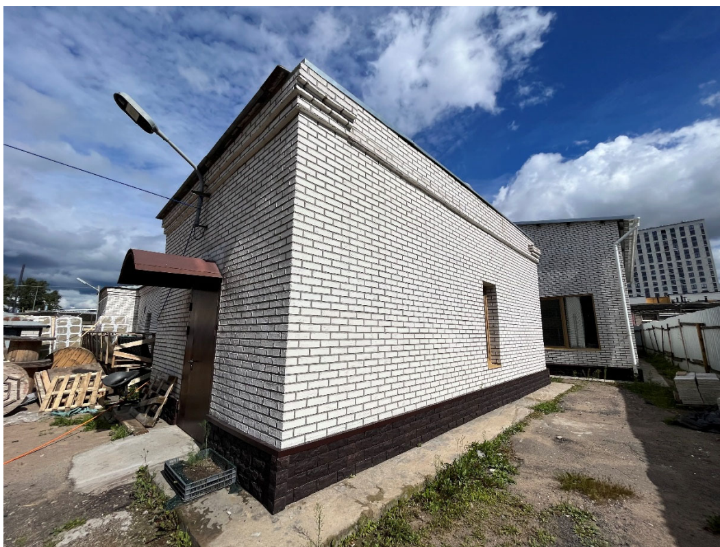
Фото №6. «Здание бывшей котельной» (Митрофаньевское ш., д. 8а, лит. Д, кадастровый номер: 78:32:0750102:3008), капитальное сооружение, фрагмент южного фасада (№4 на схеме).
