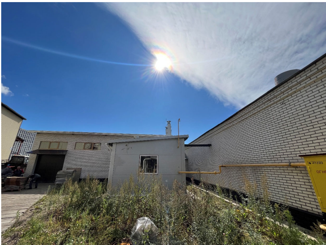
Фото №9. «Временный навес для станка», некапитальное сооружение, не стоит на кадастровом учете, северный фасад (№7 на схеме). «Котельная», некапитальное сооружение, не стоит на кадастровом учете, северный фасад (№5 на схеме).
