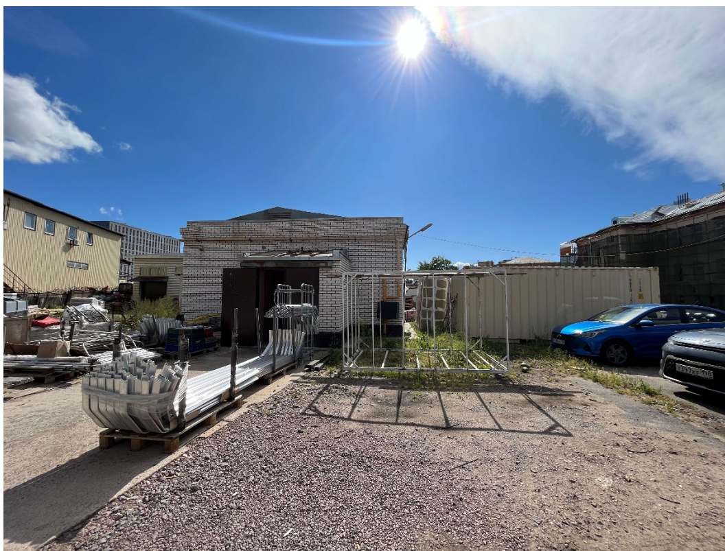
Фото №8. «Здание бывшей котельной» (Митрофаньевское ш., д. 8а, лит. Д, кадастровый номер: 78:32:0750102:3008), капитальное сооружение, западный фасад (№4 на схеме).
