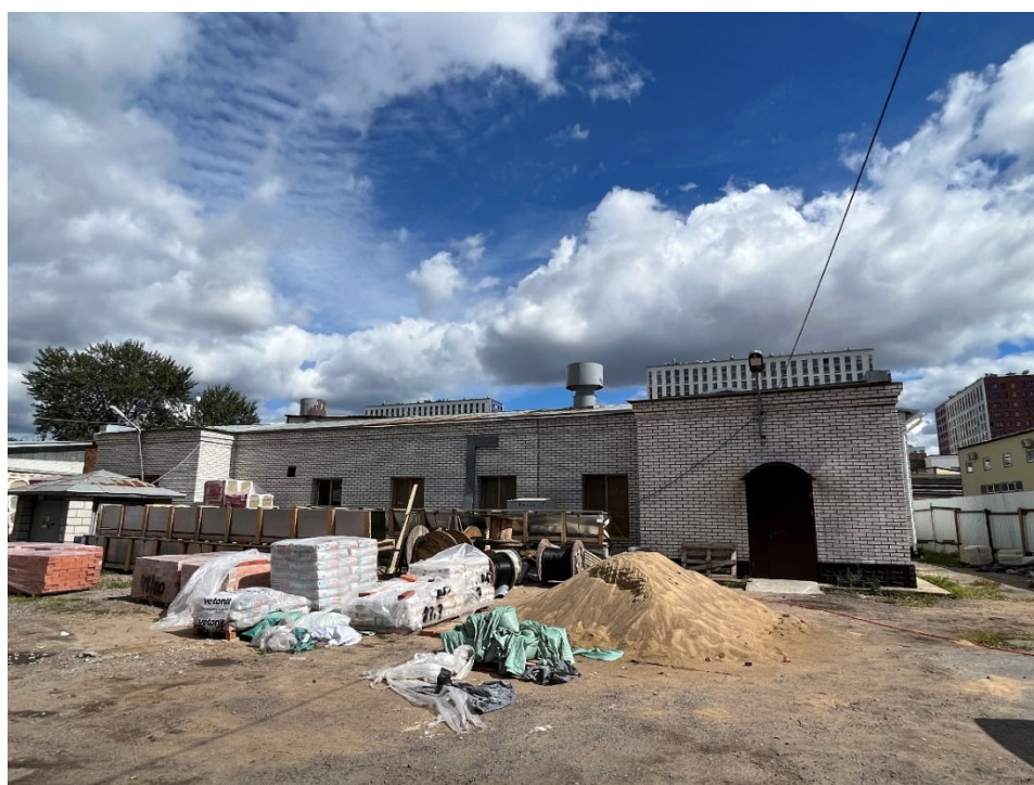
Фото №5. «Здание бывшей котельной» (Митрофаньевское ш., д. 8а, лит. Д, кадастровый номер: 78:32:0750102:3008), капитальное сооружение, западный фасад (№4 на схеме).
