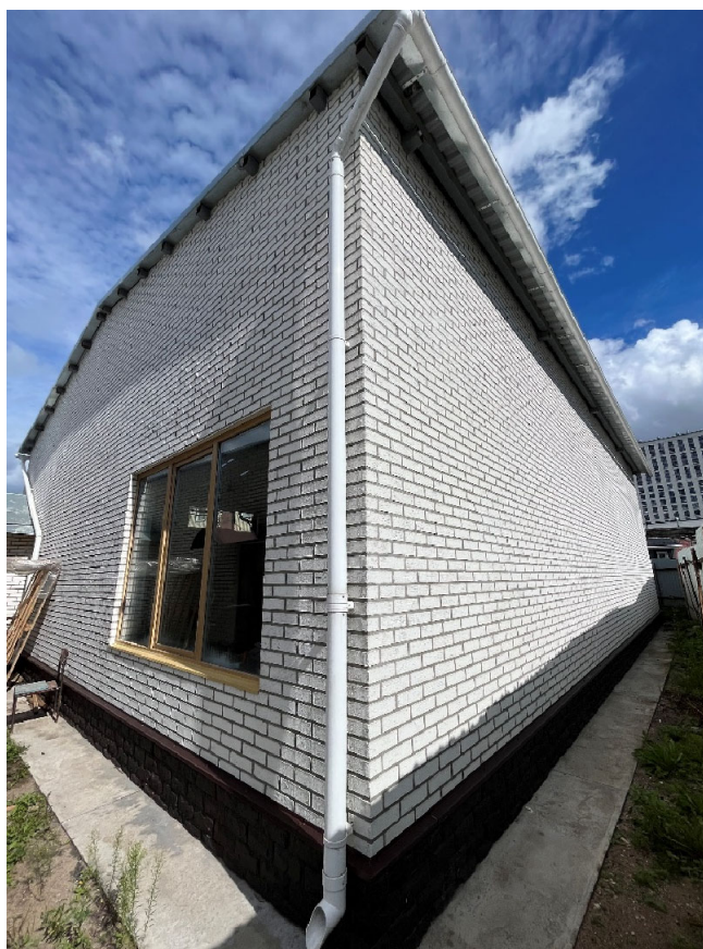
Фото №7. «Временный навес для станка», некапитальное сооружение, не стоит на кадастровом учете, фрагмент западного и южного фасада (№7 на схеме).
