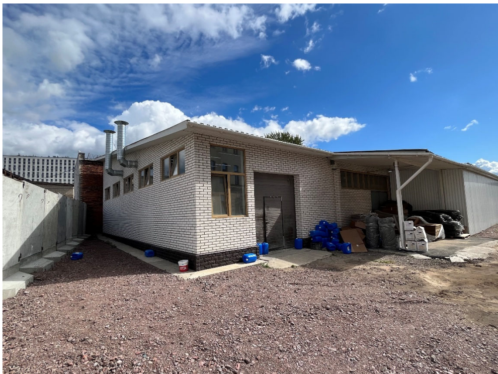
Фото №15. «Производственный корпус» (Митрофаньевское шоссе, дом 8а, литера Р), кирпичное сооружение, кадастровый № 78:32:0750102:3327 (№3 на схеме). «Навесы», некапитальное сооружение, не стоят на кадастровом учете (№8 на схеме).
