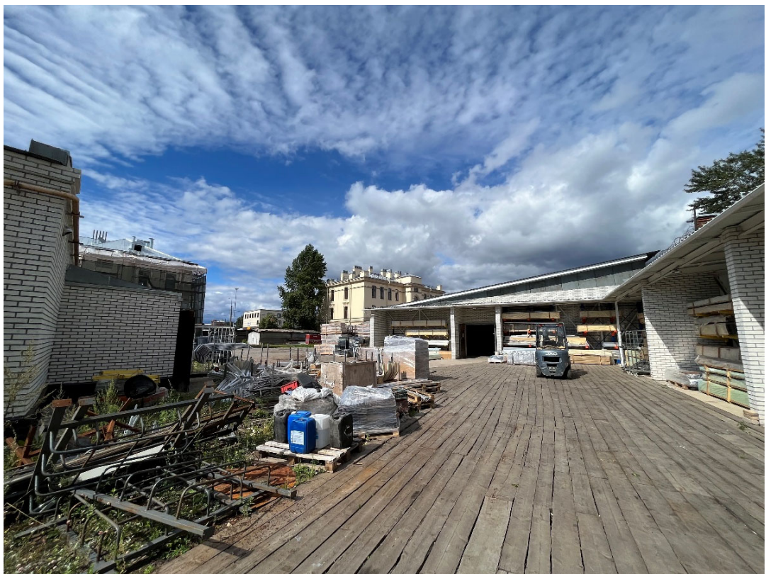
Фото №10. «Навесы», некапитальное сооружение, не стоят на кадастровом учете (№8 на схеме).
