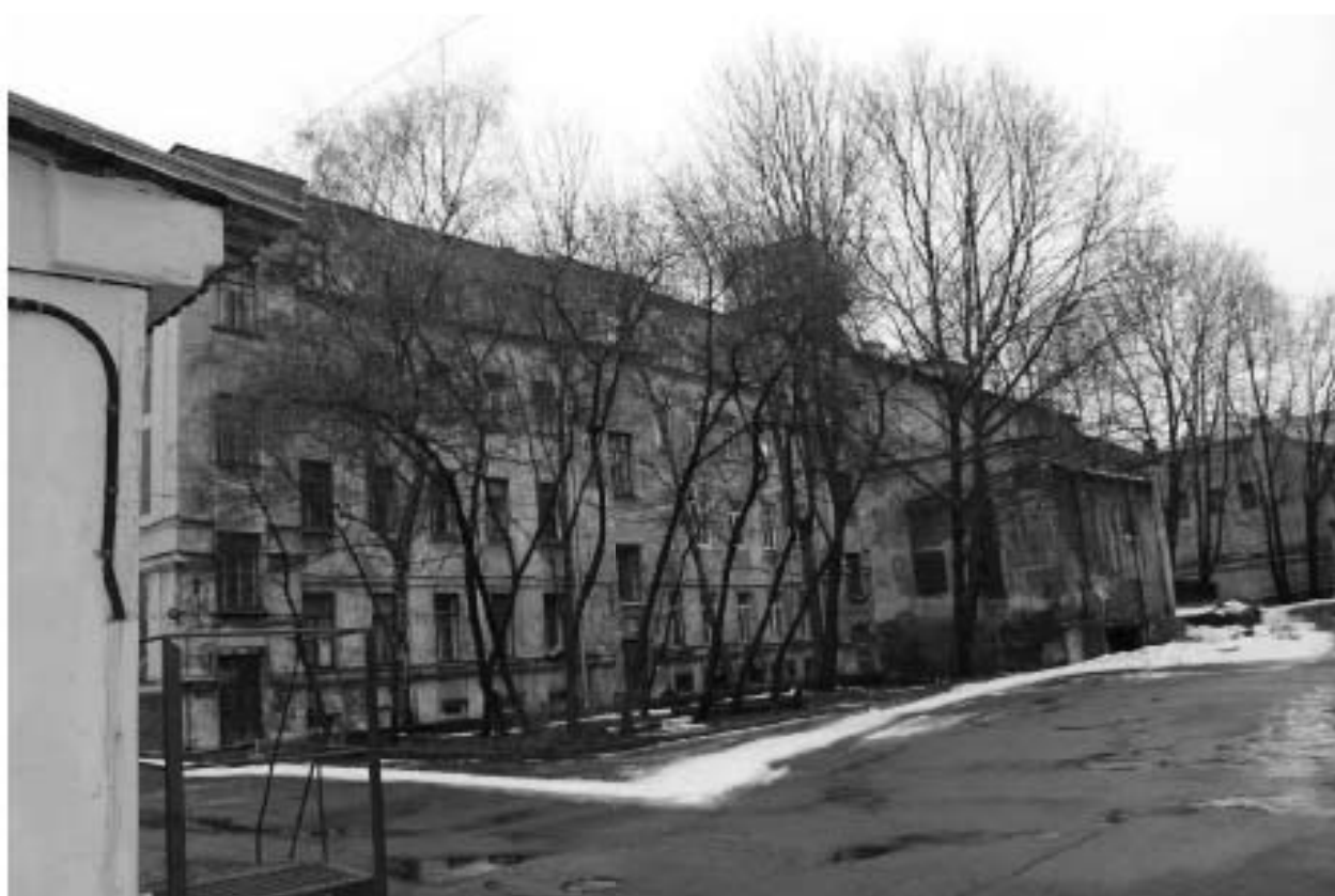
Фото 84. Вид на юго-восточный фасад выявленного объекта культурного наследия «Жилой дом».
