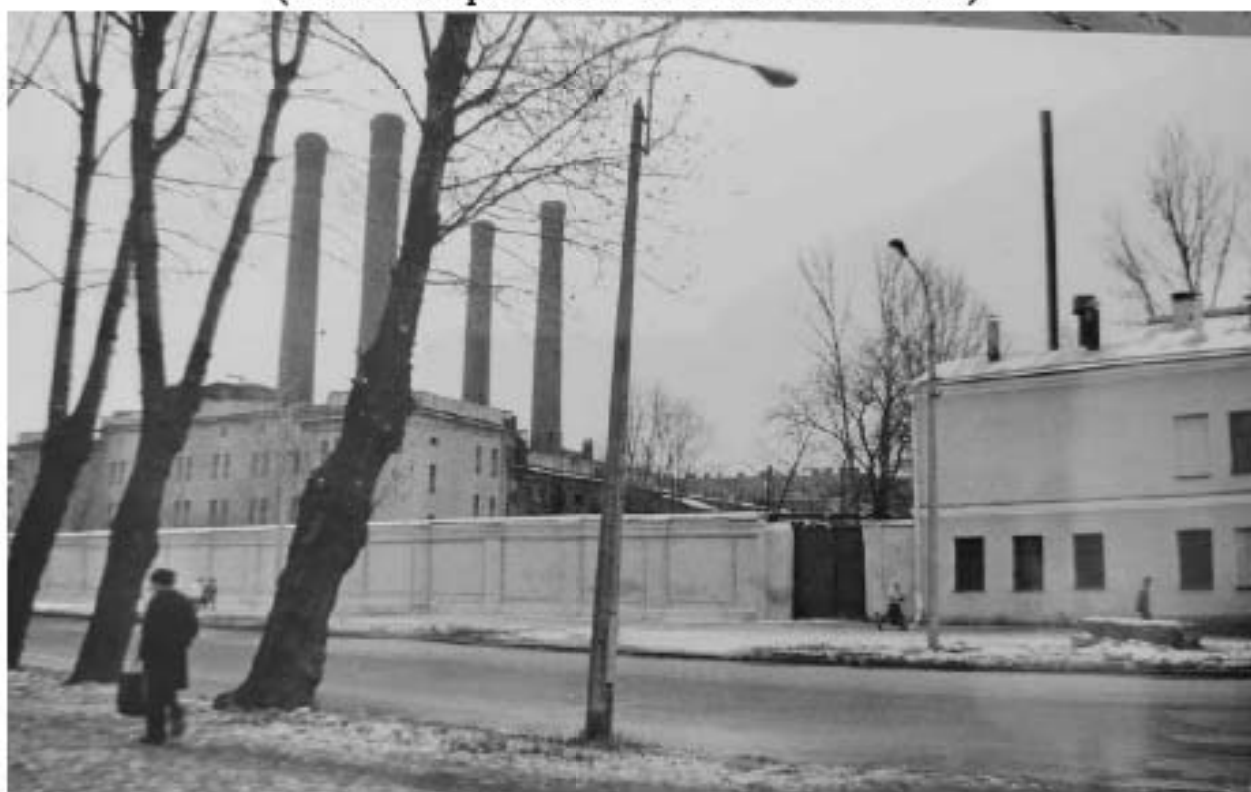
Илл. 139. Архив КГИОП. Фототека. Электростанция № 3 ТЭЦ № 2 Ленэнерго. б/д [1990-е гг.] (источник: архив КГИОП. Фототека. П. 1705).
