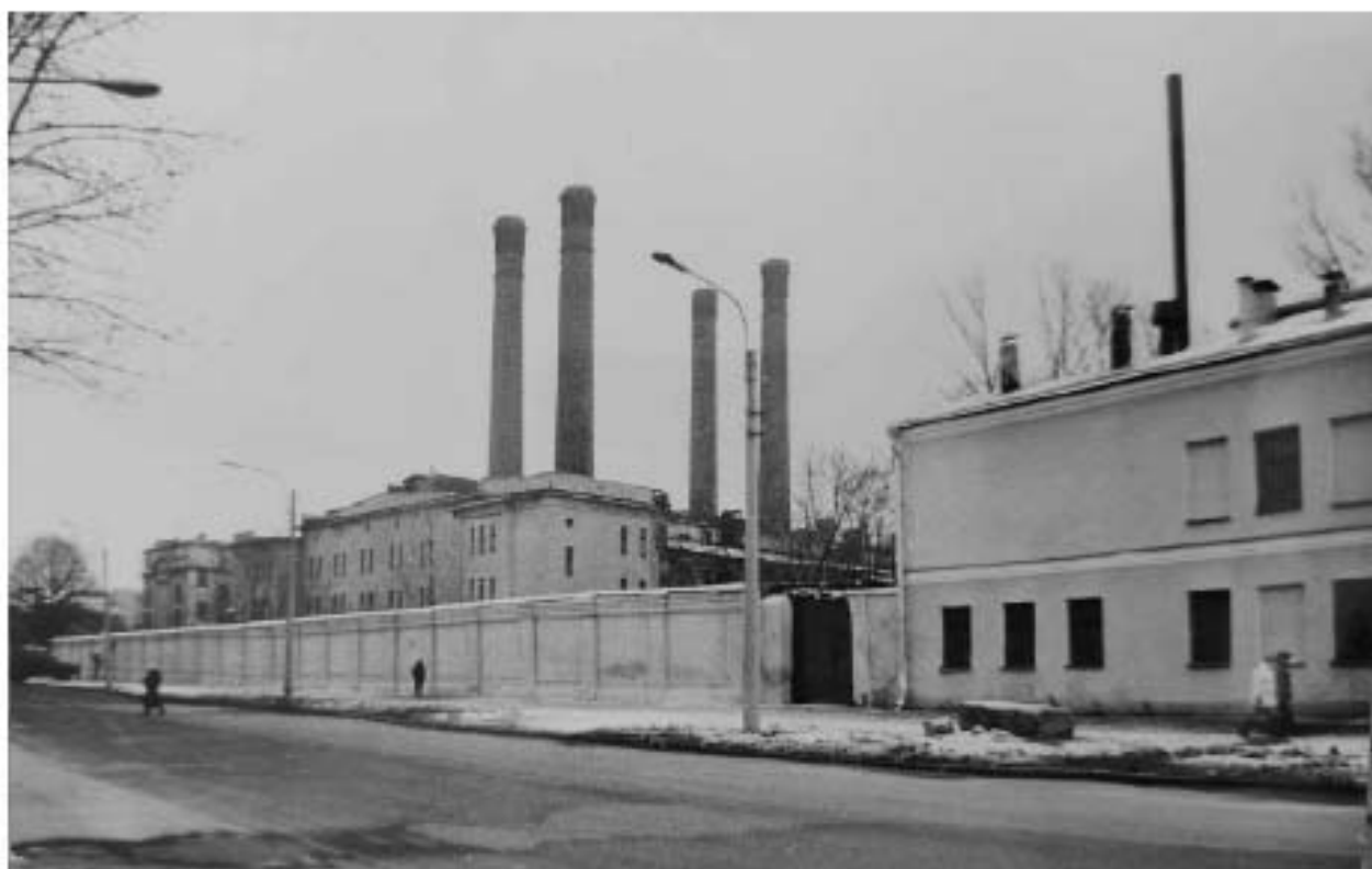
Илл. 140. Архив КГИОП. Фототека. Электростанция № 3 ТЭЦ № 2 Ленэнерго. б/д [1990-е гг.] (источник: архив КГИОП. Фототека. П. 1705).
