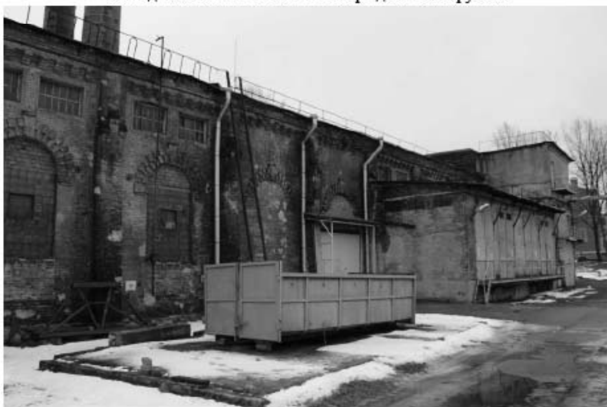
Фото 9. Вид на юго-восточный фасад выявленного объекта культурного наследия «Машинный зал и четыре дымовые трубы».
