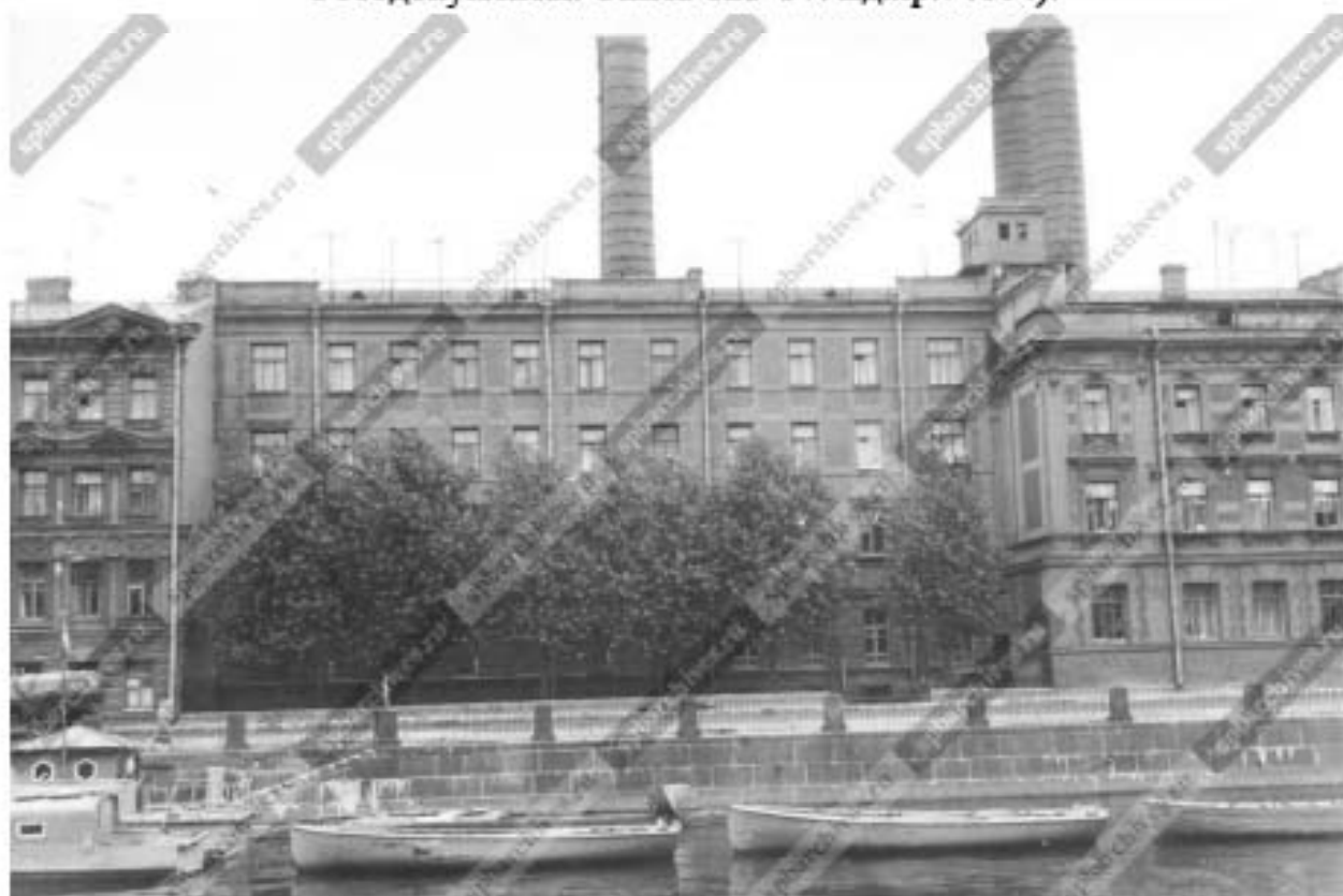
Илл. 119. Общий вид фасада здания электрической станции со стороны реки Фонтанки. 1964 г. (источник: ЦГАКФФД СПб. Фотодокументы. Опись 1БР-57. Ед.хр.74003).
