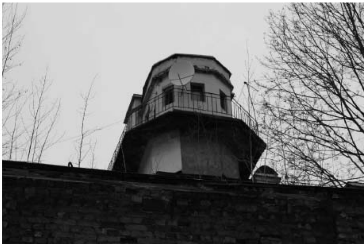
Фото 88. Вид на юго-восточный фасад выявленного объекта культурного наследия «Жилой дом».
