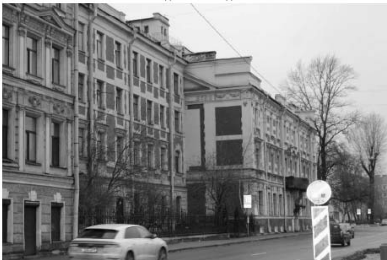
Фото 80. Вид на северо-восточный фасад выявленного объекта культурного наследия «Жилой дом».
