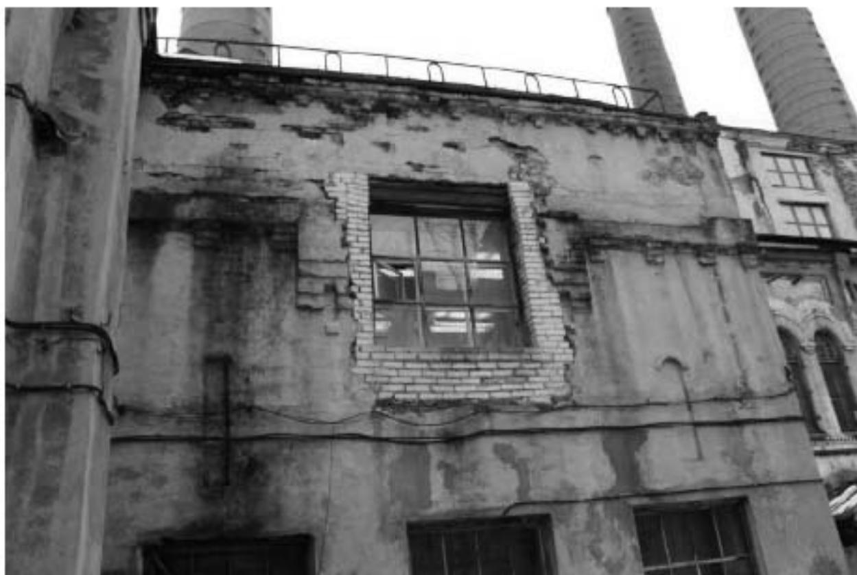
Фото 21. Вид на северо-западный фасад пристройки к выявленному объекту культурного наследия «Машинный зал и четыре дымовые трубы».
