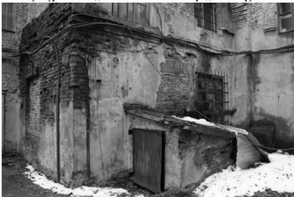
Фото 17. Вид на поздние пристроенные части к выявленному объекту культурного наследия «Машинный зал и четыре дымовые трубы».
