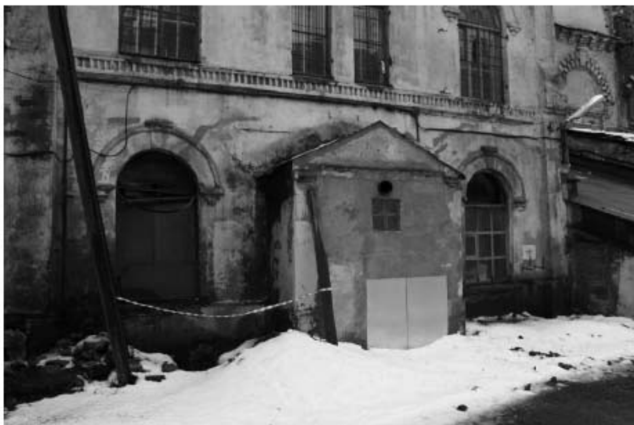
Фото 23. Вид на северо-западный фасад пристройки к выявленному объекту культурного наследия «Машинный зал и четыре дымовые трубы».
