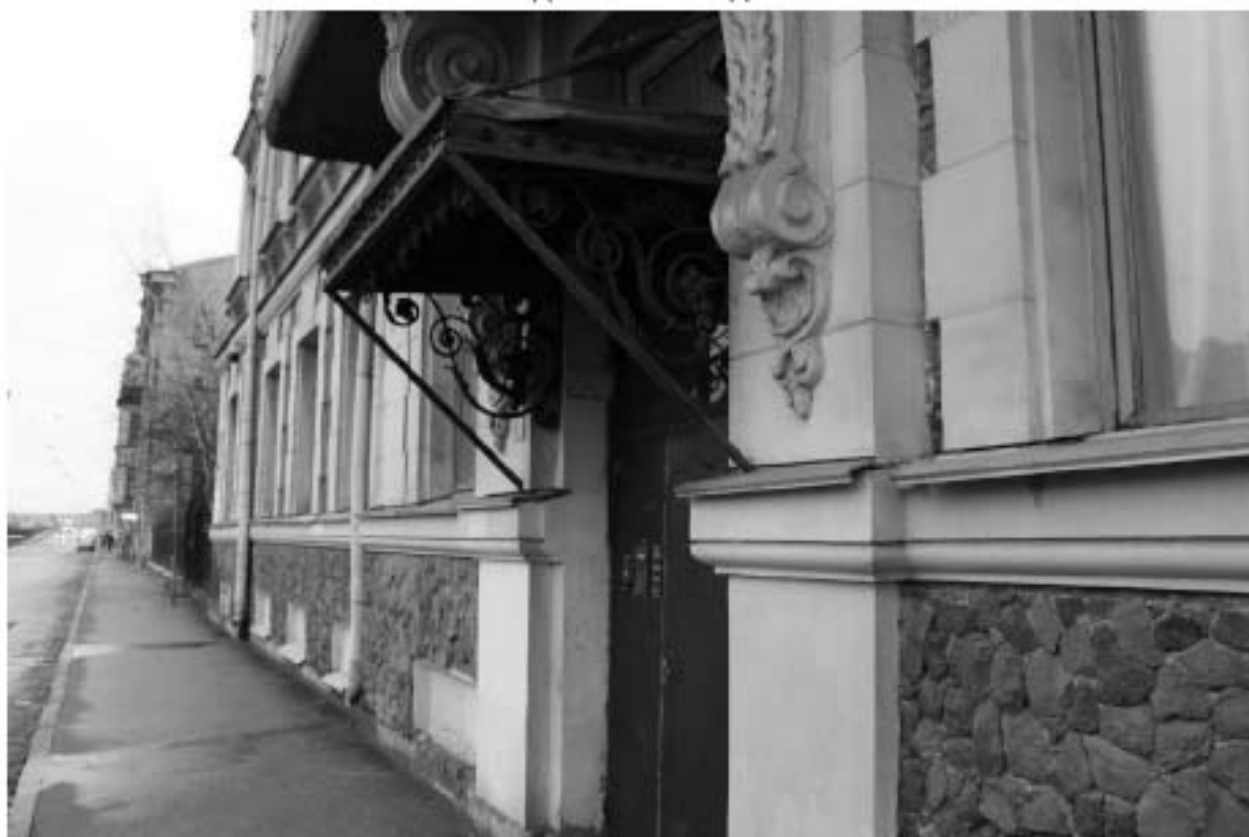
Фото 78. Вид на козырек входа в парадную лестницу выявленного объекта культурного наследия «Жилой дом».
