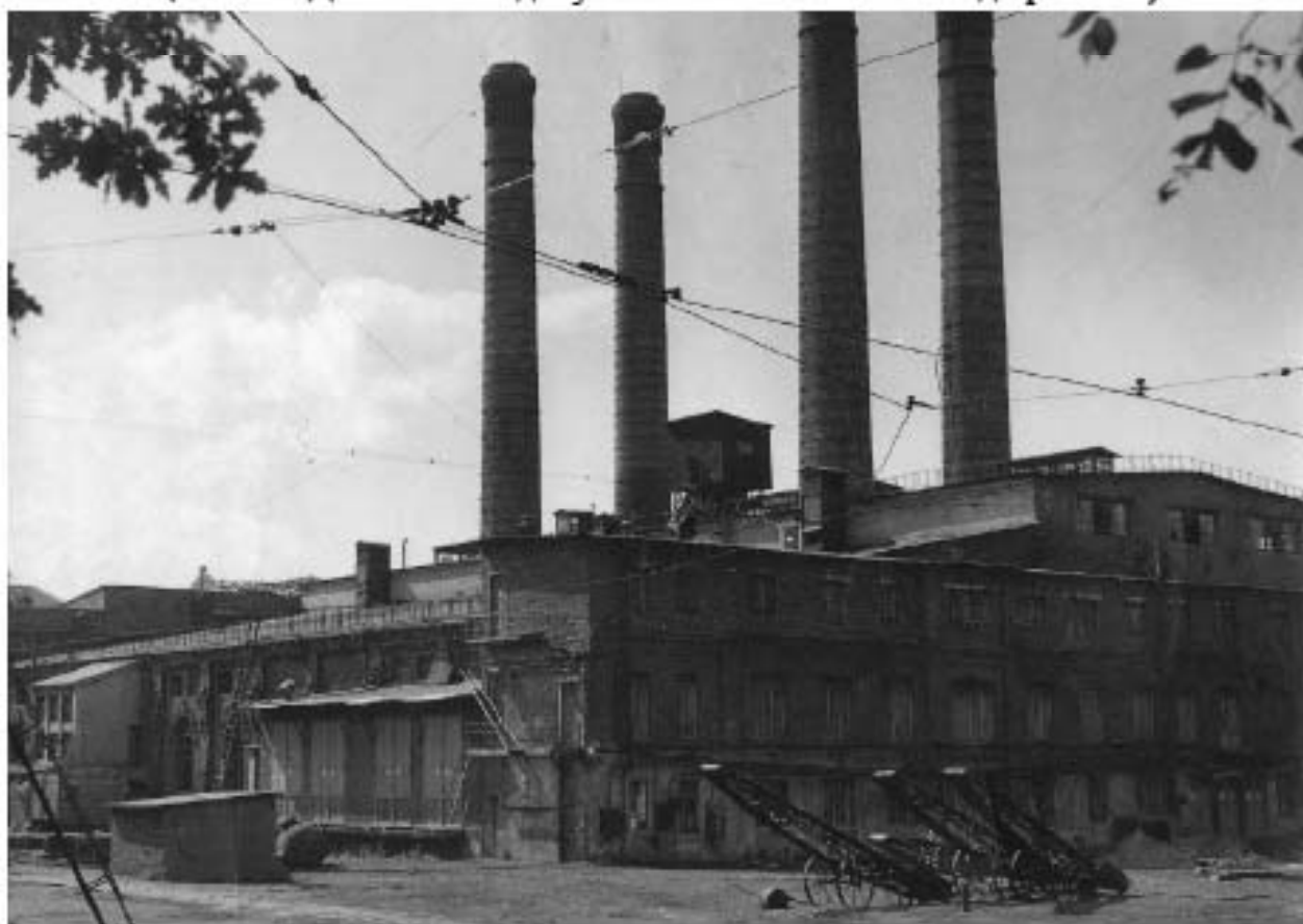
Илл. 115. Вид на ЛГЭС № 3 им. Л.Л. Гинтера со стороны двора. Конец 1950-х гг. (источник: https://www.tgcl.ru/central120/istoricheskie-foto/ ).
