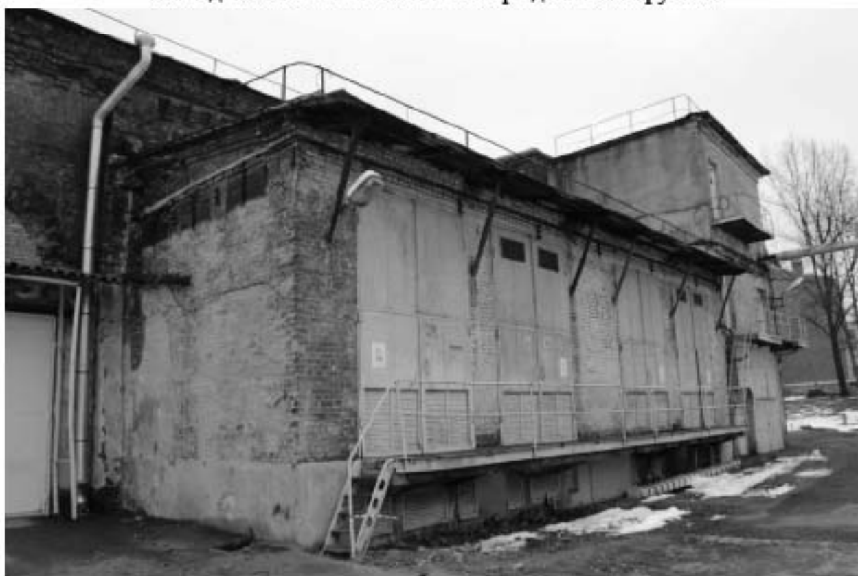
Фото 11. Вид на позднюю пристройку к выявленному объекту культурного наследия «Машинный зал и четыре дымовые трубы».
