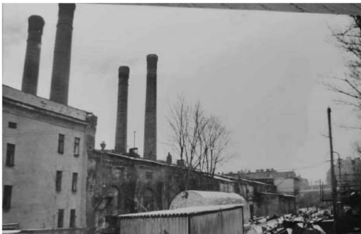
Илл. 142. Архив КГИОП. Фототека. Электростанция № 3 ТЭЦ № 2 Ленэнерго. Вид от забора со стороны Введенского канала. 6/д [1990-е гг.] (источник: архив КГИОП. Фототека. П. 1705).
