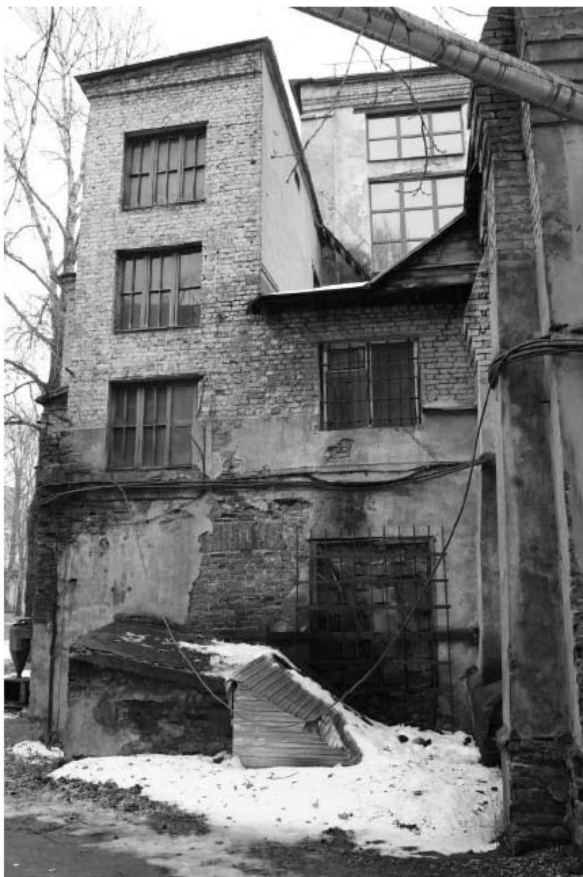
Фото 18. Вид на поздние пристроенные части к выявленному объекту культурного наследия «Машинный зал и четыре дымовые трубы».
