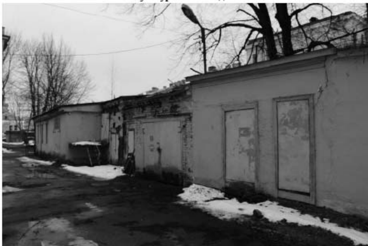
Фото 30. Вид на поздние постройки в западной части территории объекта культурного наследия.
