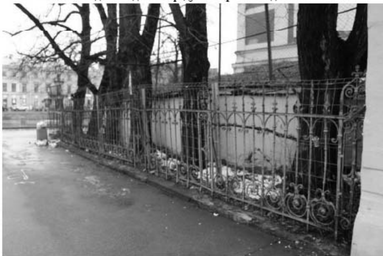
Фото 74. Вид на историческую ограду со стороны Введенского канала.
