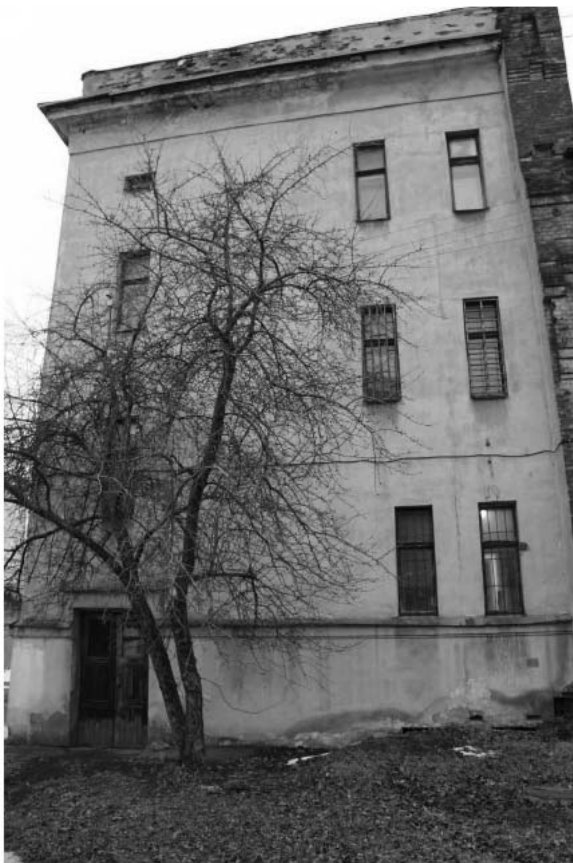
Фото 5. Вид на юго-восточный фасад поздней части выявленного объекта культурного наследия «Машинный зал и четыре дымовые трубы».
