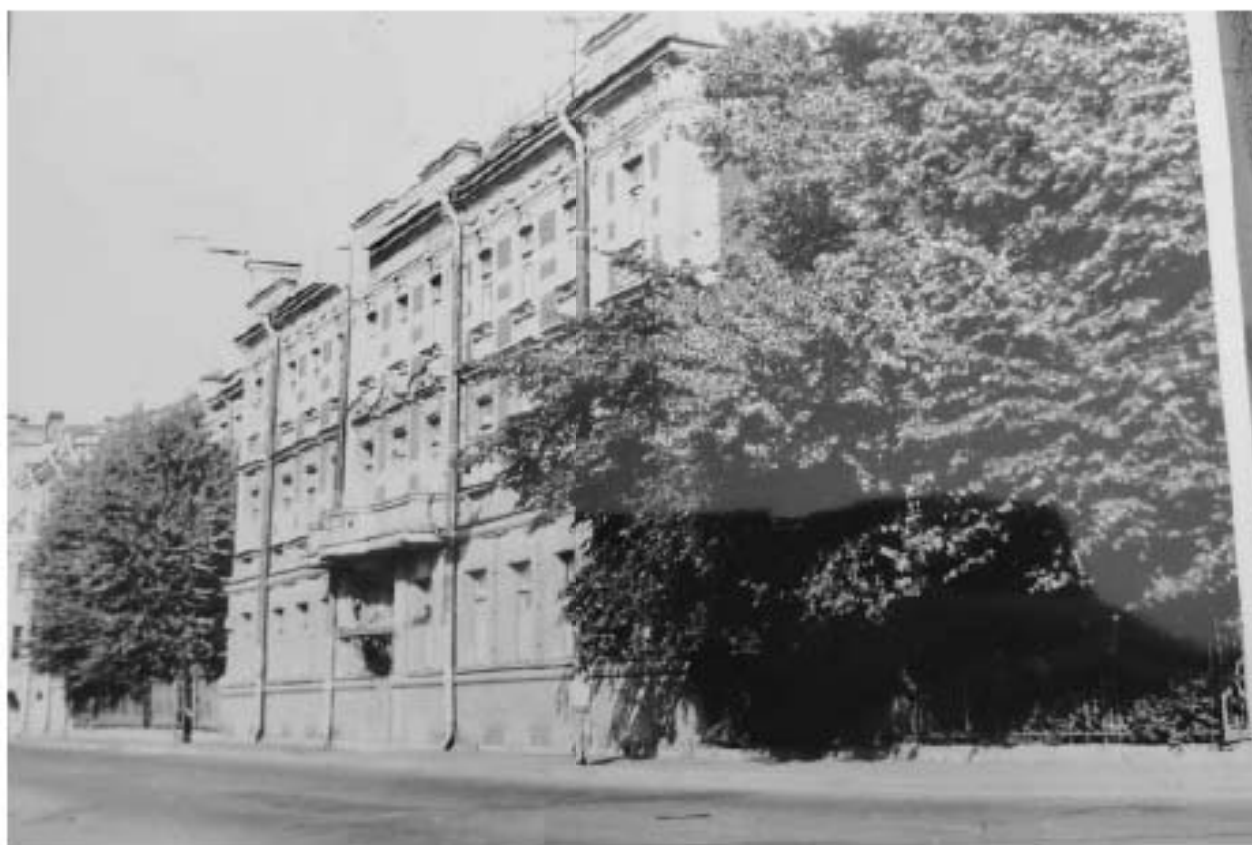
Илл. 132. Вид центральной части фасада дома № 104 по набережной Фонтанки. 16.07.1992 г. (источник: архив КГИОП. Фототека. П. 1705; аналогичная фотография – ЦГАКФФД СПб. Фотодокументы. Опись 1АР-157. Ед.хр.225944).
