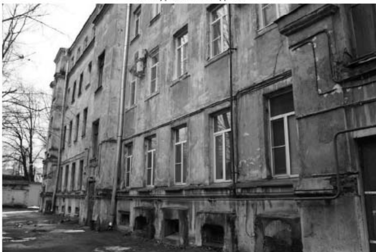
Фото 87. Вид на юго-восточный фасад выявленного объекта культурного наследия «Жилой дом».
