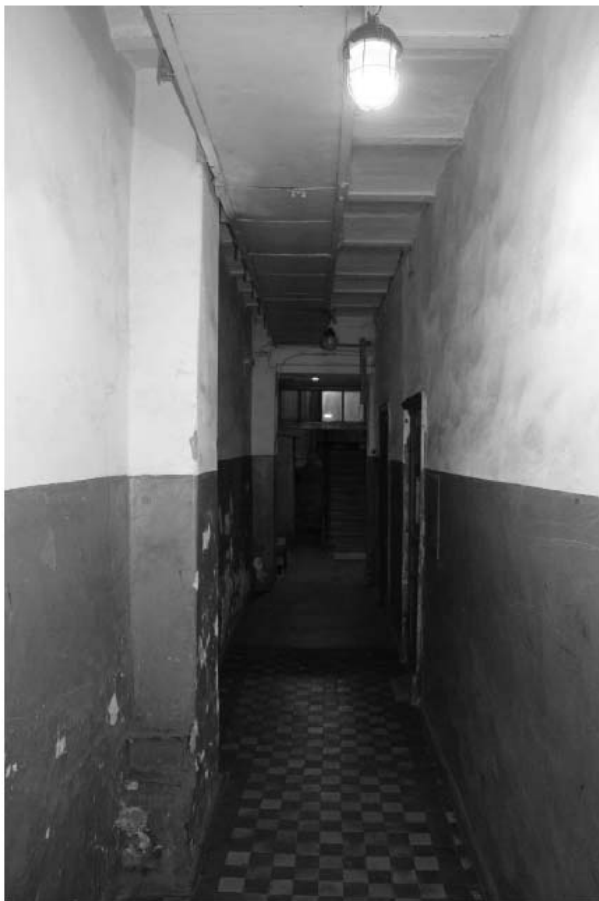
Фото 64. Внутренние помещения 1-го этажа поздней трехэтажной части.
