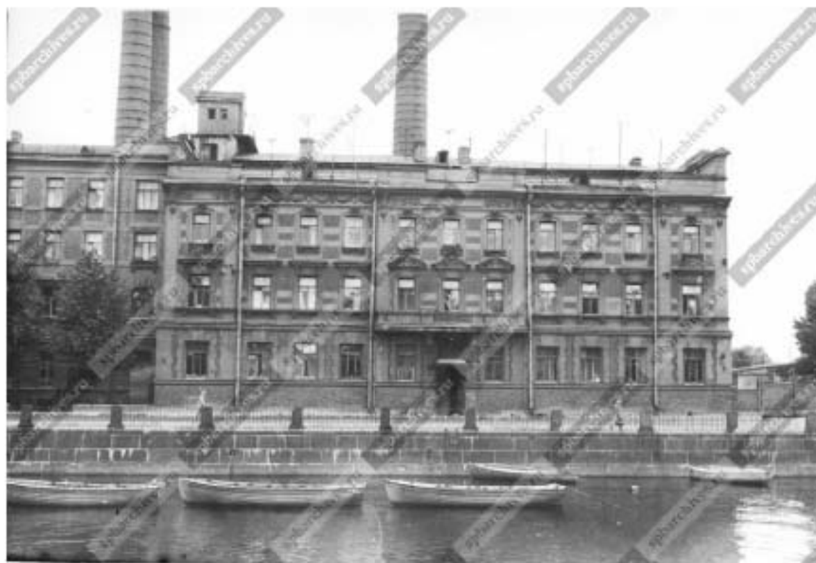
Илл. 118. Общий вид фасада здания электрической станции со стороны набережной реки Фонтанки, 104. 1964 г. (источник: ЦГАКФФД СПб. Фотодокументы. Опись 1БР-57. Ед.хр.74004).
