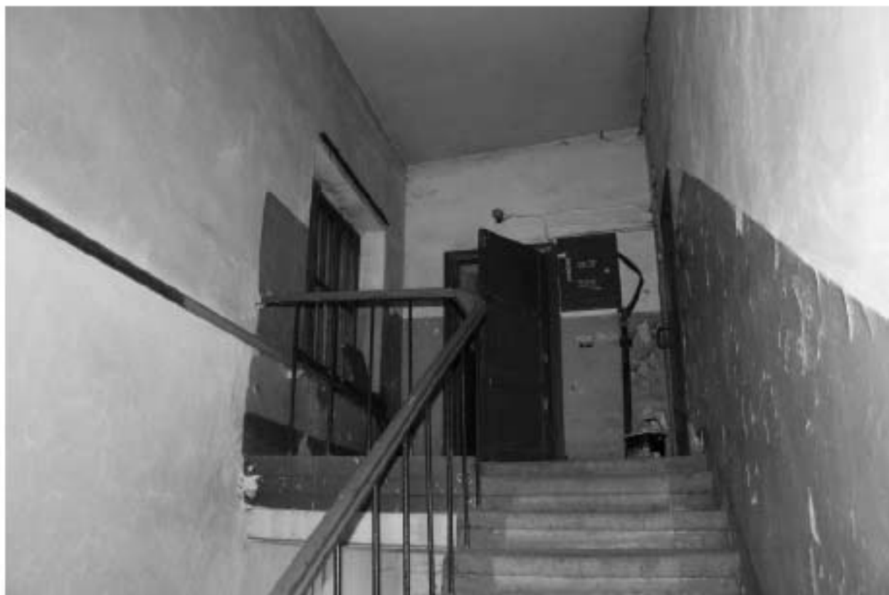
Фото 67. Лестничная клетка поздней трехэтажной части в уровне 3-го этажа.
