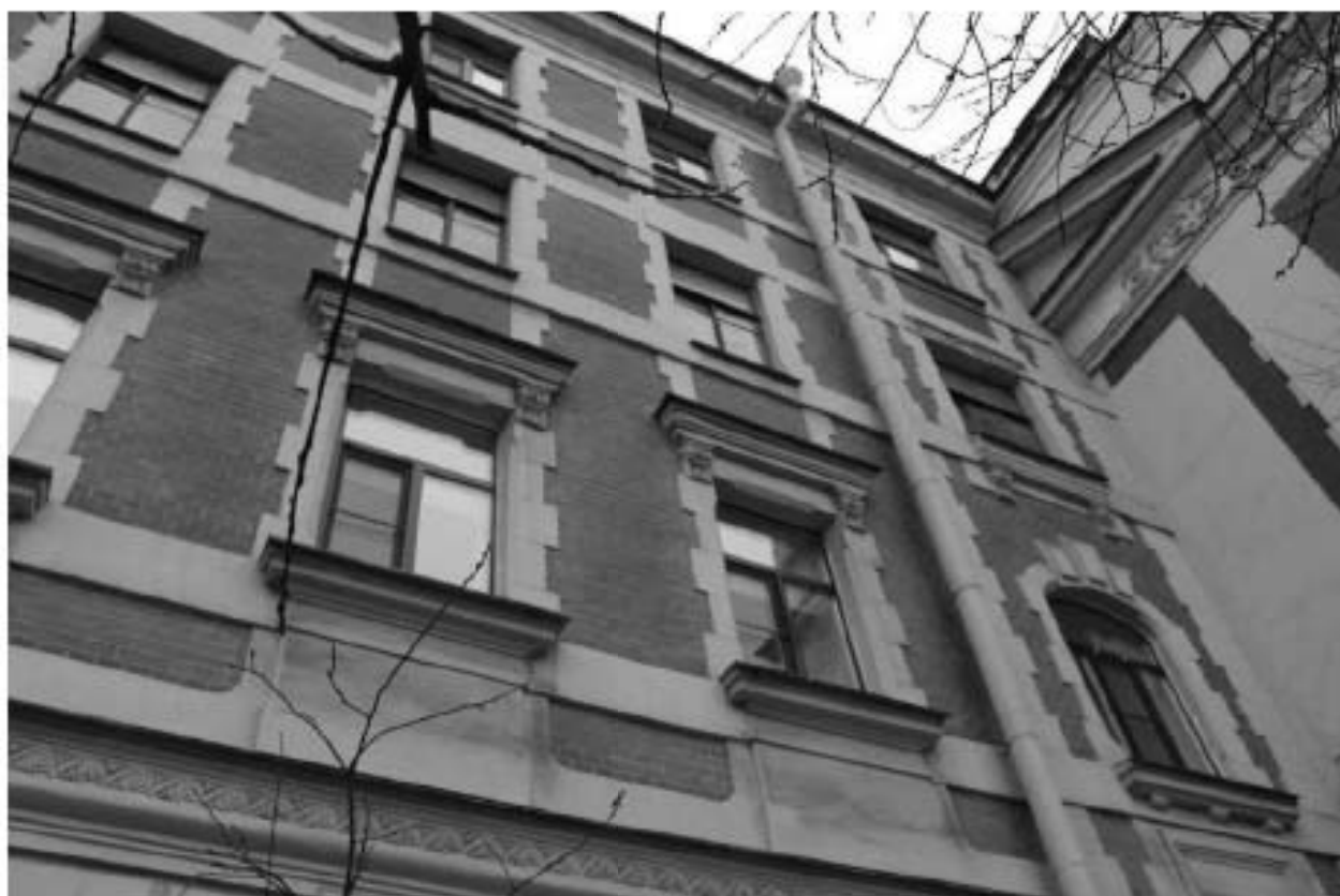
Фото 120. Вид на северо-западный фасад выявленного объекта культурного наследия «Административное здание».
