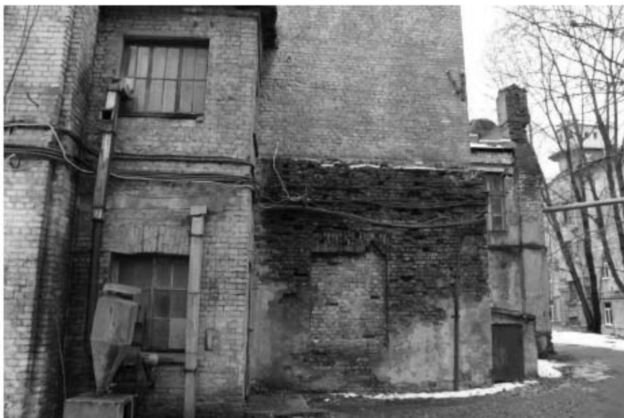
Фото 16. Вид на поздние пристроенные части к выявленному объекту культурного наследия «Машинный зал и четыре дымовые трубы».
