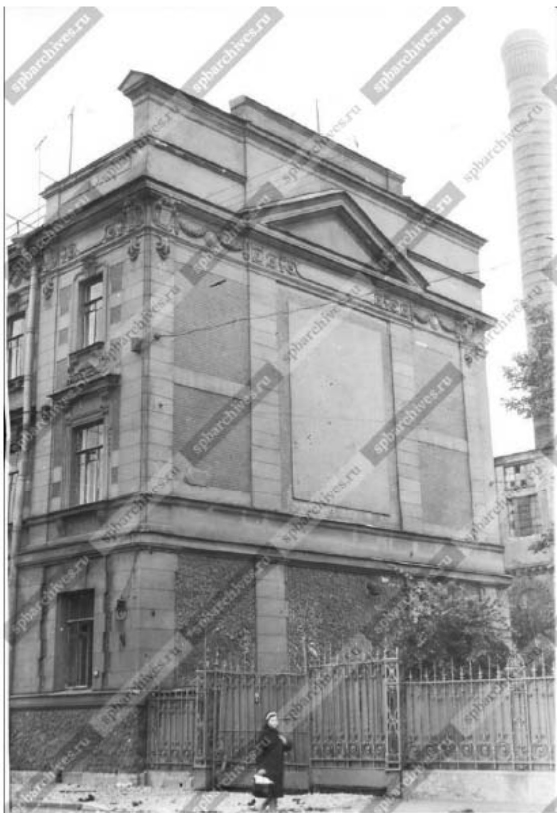
Илл. 120. Общий вид торцевого фасада корпуса 2В электрической станции со стороны набережной реки Фонтанки. 1964 г. (источник: ЦГАКФФД СПб. Фотодокументы. Опись 1БР-57. Ед.хр.74005).
