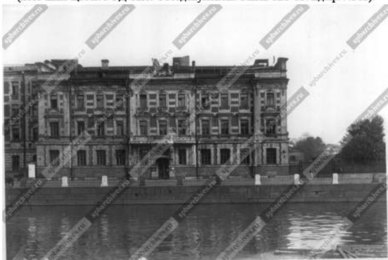
Илл. 113. Часть фасада дома № 104 на набережной реки Фонтанки. 1939 г. (источник: ЦГАКФФД СПб. Фотодокументы. Опись 1ВР-33. Ед.хр.44309).
