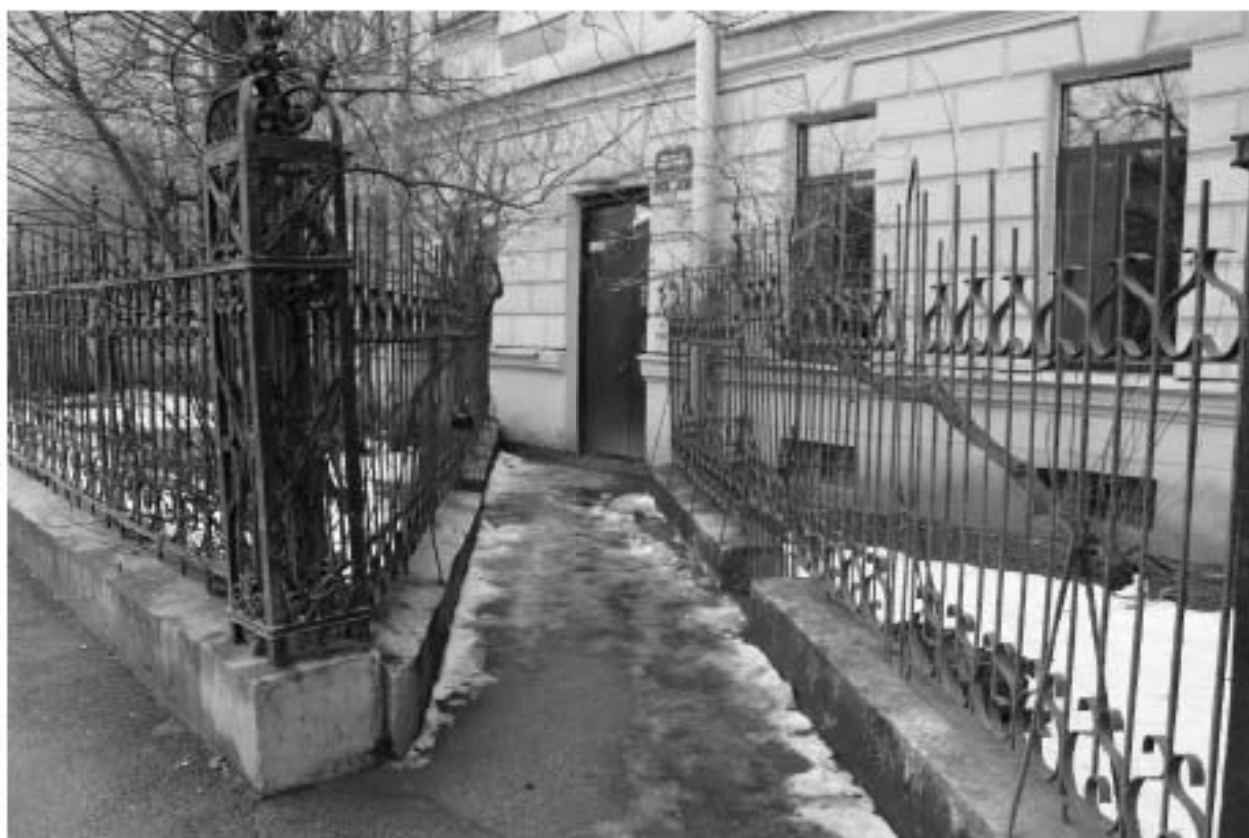
Фото 122. Вид на историческую и позднюю ограду у выявленного объекта культурного наследия «Административное здание».
