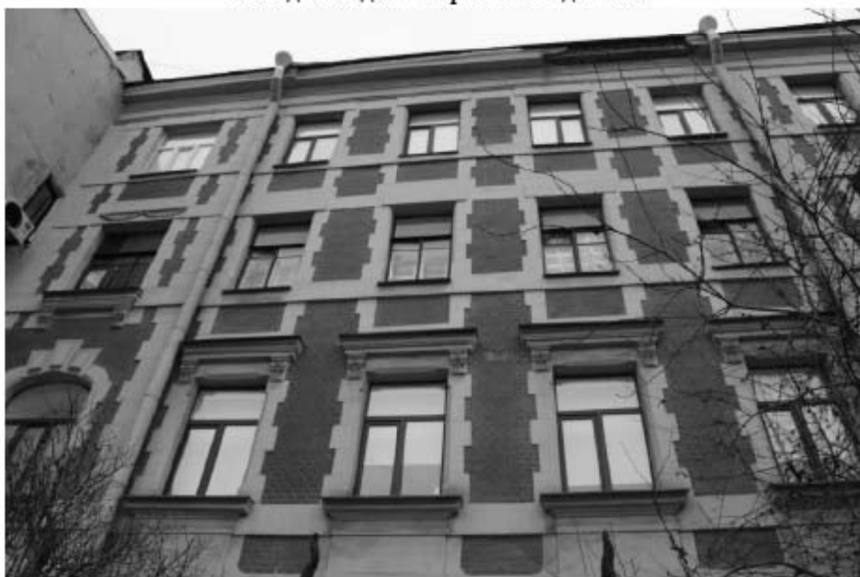
Фото 119. Вид на северо-западный фасад выявленного объекта культурного наследия «Административное здание».
