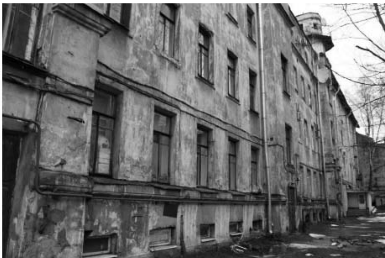
Фото 86. Вид на юго-восточный фасад выявленного объекта культурного наследия «Жилой дом».
