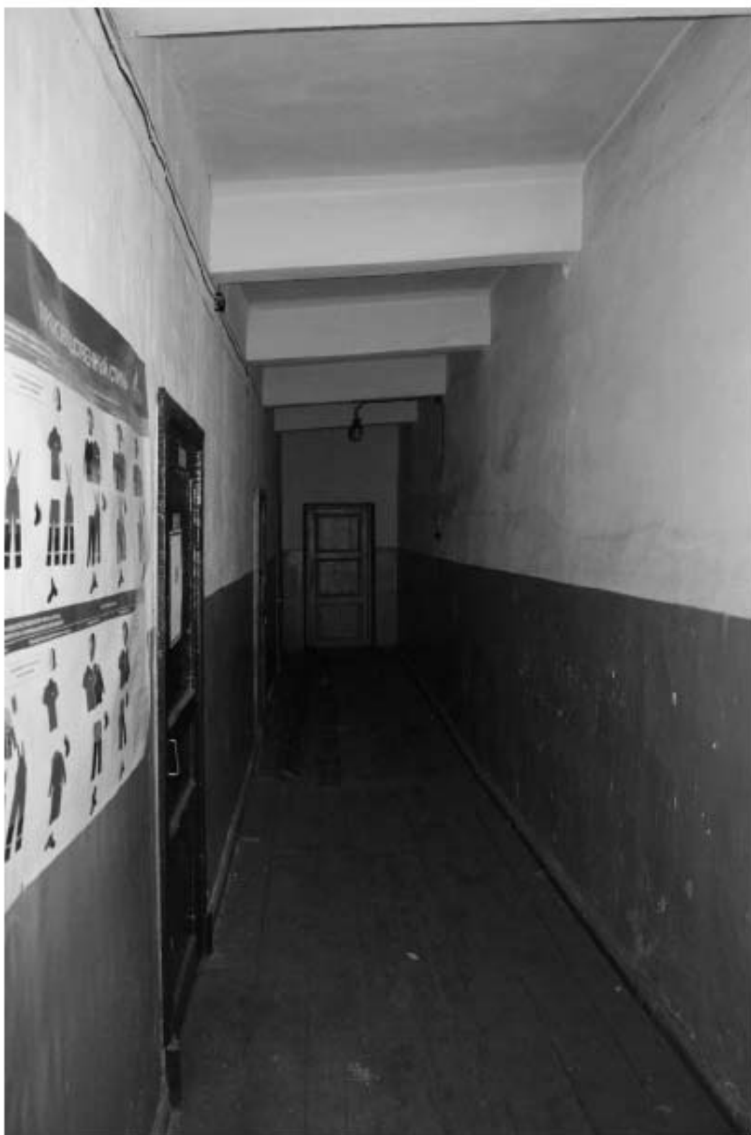
Фото 68. Внутренние помещения 3-го этажа поздней трехэтажной части.
