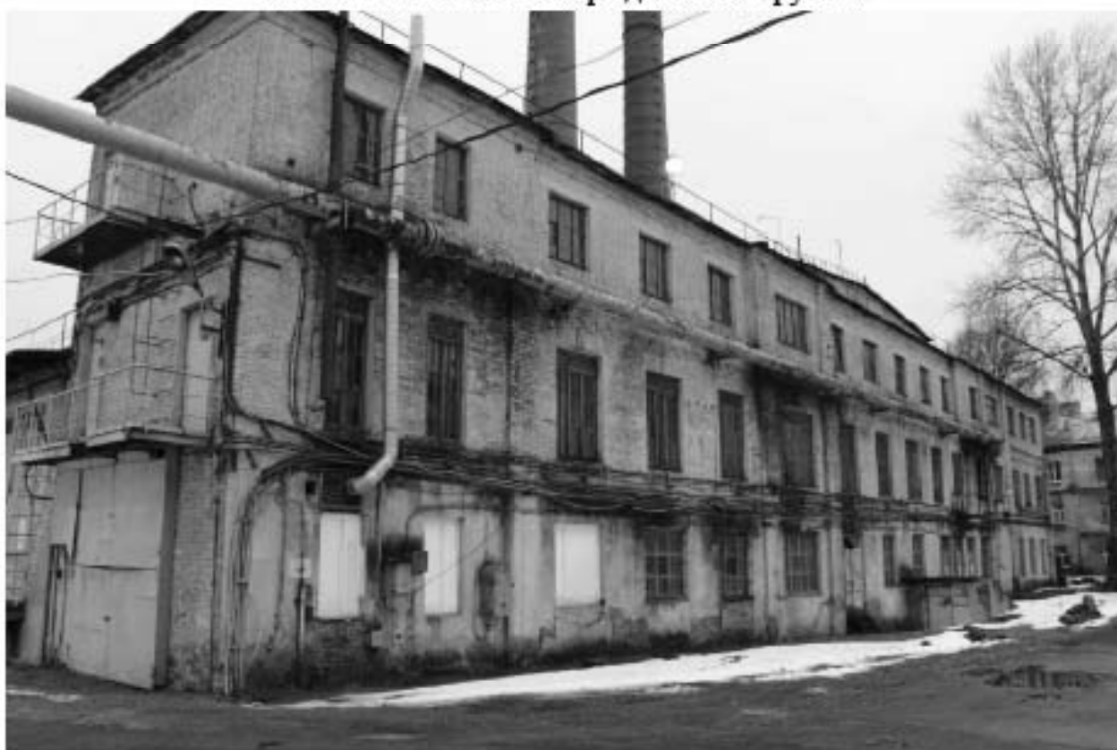
Фото 13. Вид на северо-восточный фасад выявленного объекта культурного наследия «Машинный зал и четыре дымовые трубы».
