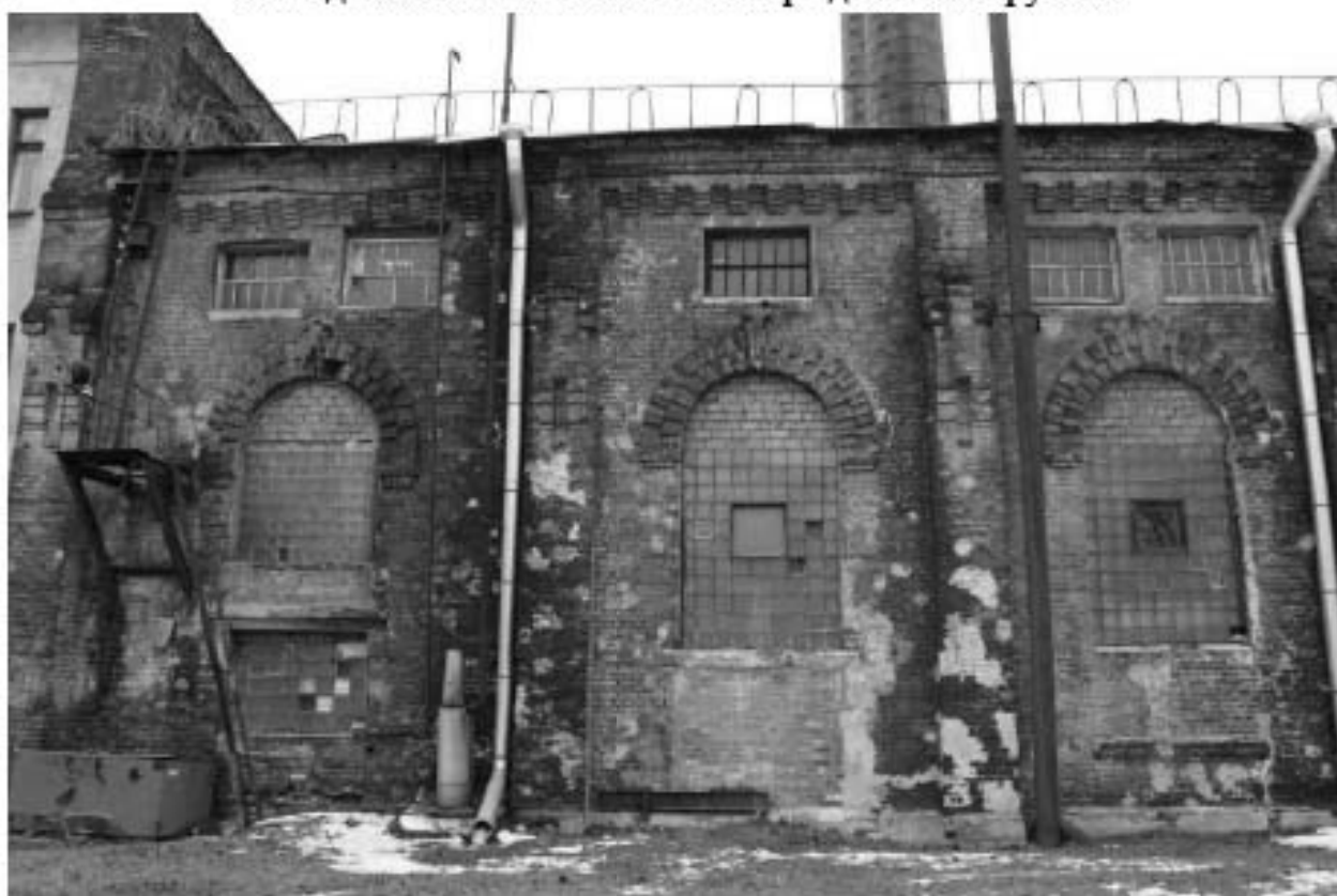
Фото 7. Вид на юго-восточный фасад выявленного объекта культурного наследия «Машинный зал и четыре дымовые трубы».
