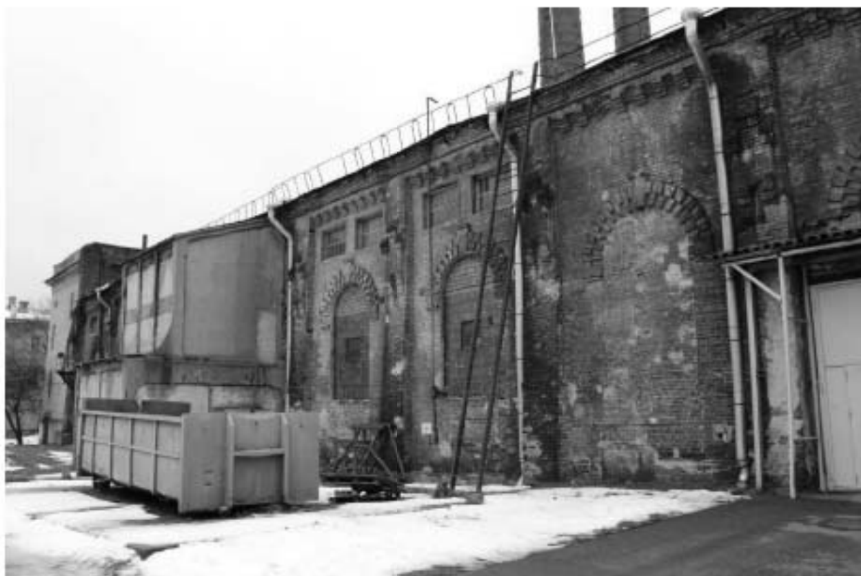
Фото 10. Вид на юго-восточный фасад выявленного объекта культурного наследия «Машинный зал и четыре дымовые трубы».
