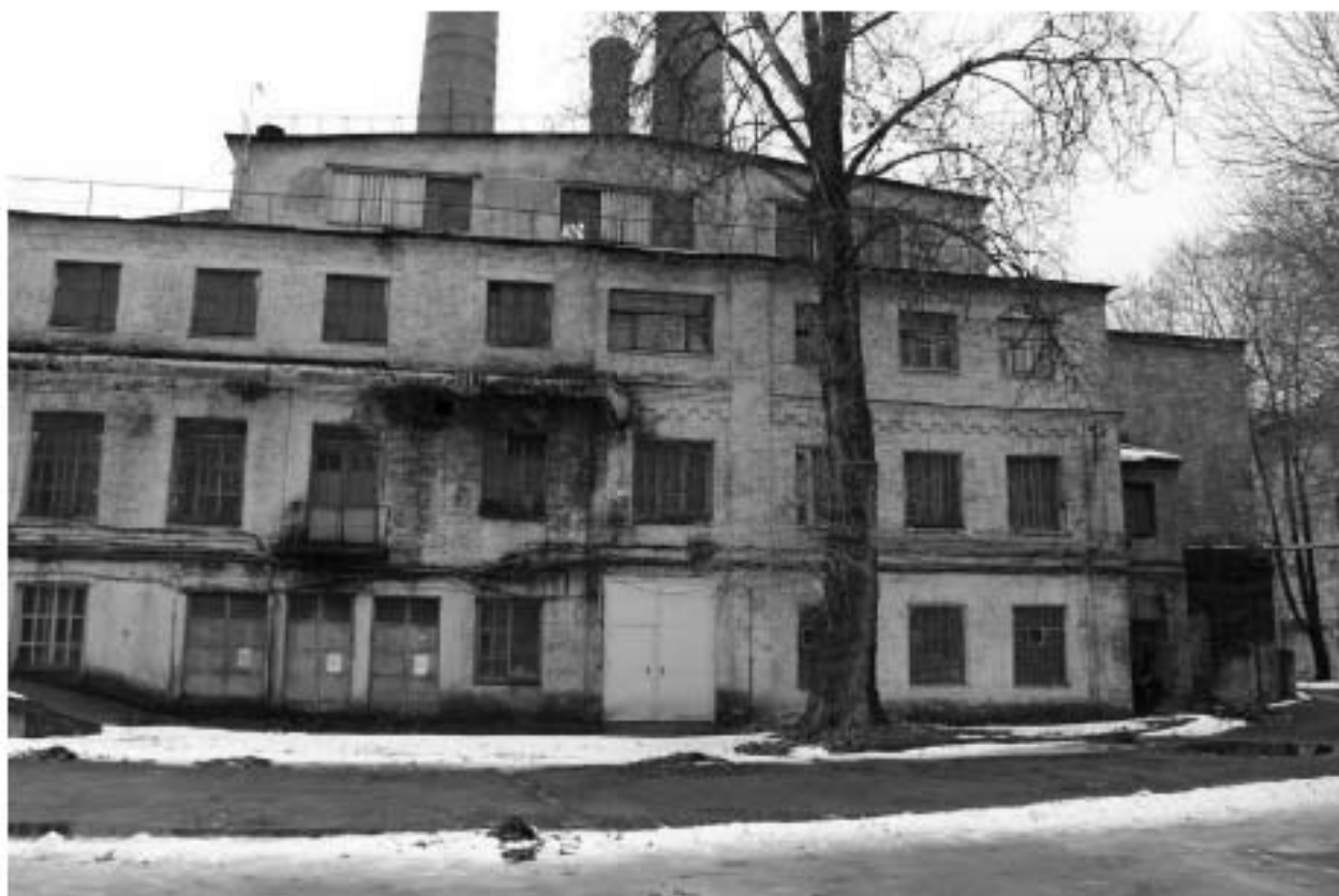
Фото 14. Вид на северо-восточный фасад выявленного объекта культурного наследия «Машинный зал и четыре дымовые трубы».
