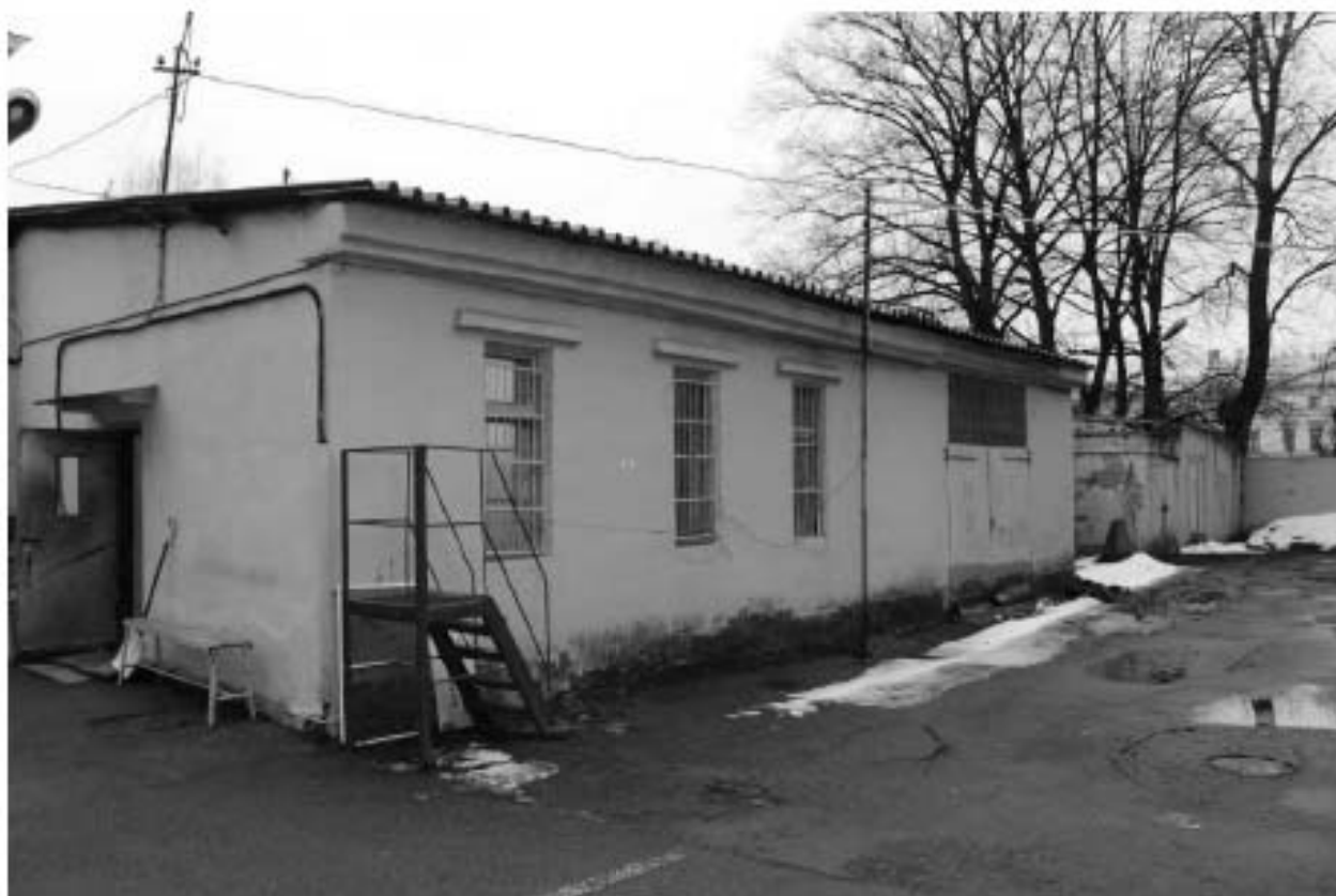
Фото 29. Вид на поздние постройки в западной части территории объекта культурного наследия.
