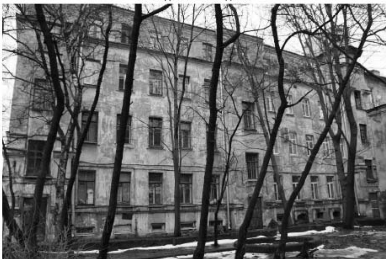
Фото 85. Вид на юго-восточный фасад выявленного объекта культурного наследия «Жилой дом».
