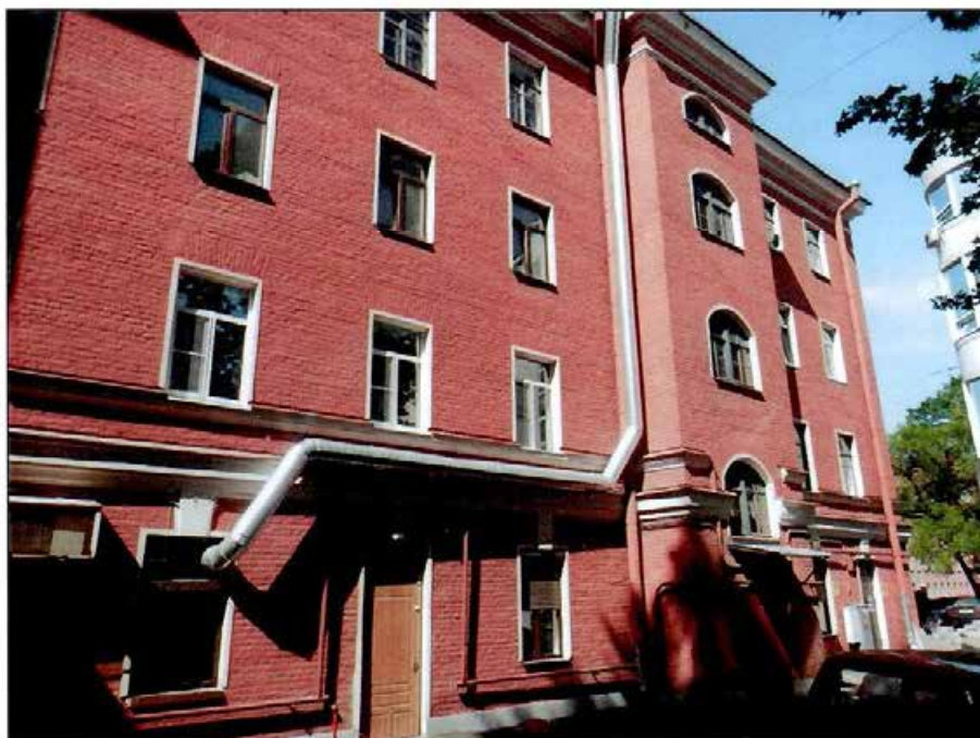
4. Общий вид. Восточный фасад.
