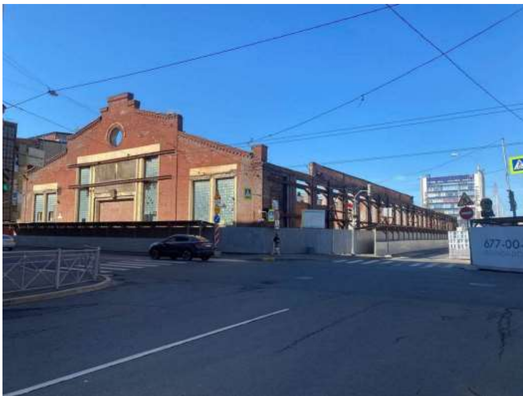
1. Чугунолитейный цех (Большой Сампсониевский пр., д. 30, корп. 2, лит. Б). Общий вид. Штиглиц М.С. 15.08.2025.
