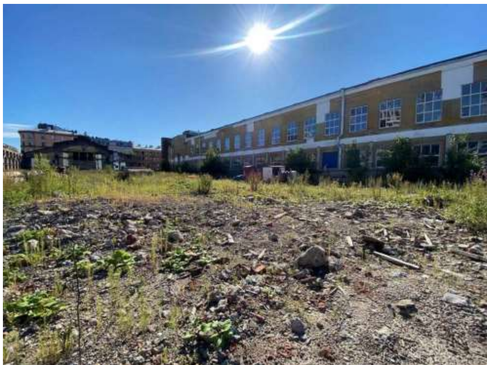
11. Чугунолитейный цех (Большой Сампсониевский пр., д. 30, корп. 2, лит. Б). Вид на внутреннюю часть корпуса. Штиглиц М.С. 15.08.2025.
