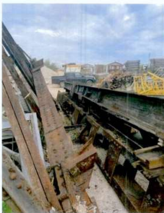
7. Фрагмент клепанной фермы, расположенной по адресу: Санкт-Петербург, Петергофское шоссе, дом 75, корпус 46 (фото от 26.09.2024)
