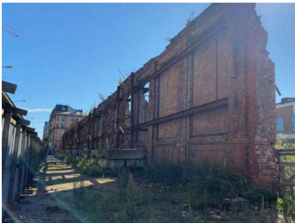
8. Чугунолитейный цех (Большой Сампсониевский пр., д. 30, корп. 2, лит. Б). Фасад по ул. Фокина. Штиглиц М.С. 15.08.2025.
