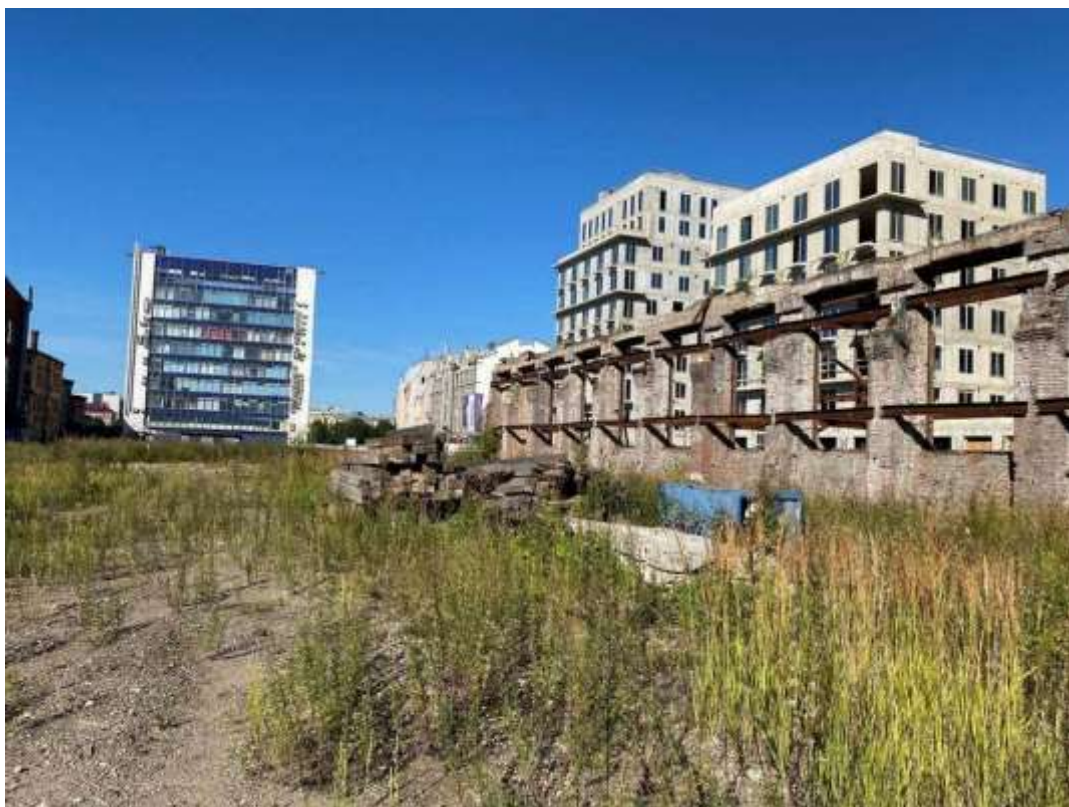
13. Чугунолитейный цех (Большой Сампсониевский пр., д. 30, корп. 2, лит. Б). Вид на внутреннюю часть корпуса. Штиглиц М.С. 15.08.2025.
