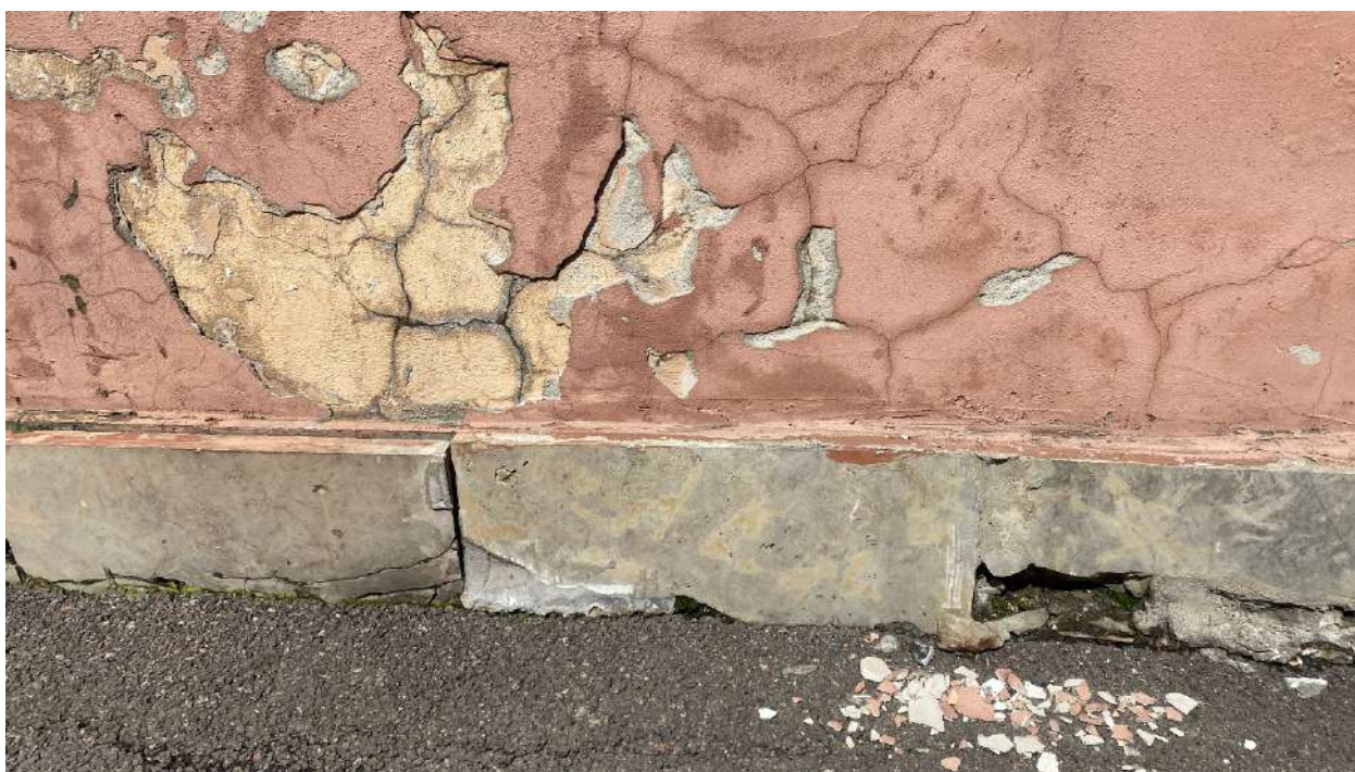
Фото 16. Общее состояние цоколя. Дата фотофиксации: 26.09.2025г.
