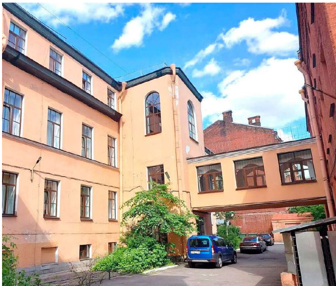
Фото 8. Общие виды на помещения объекта. Дата фотофиксации: 26.09.2025г.
