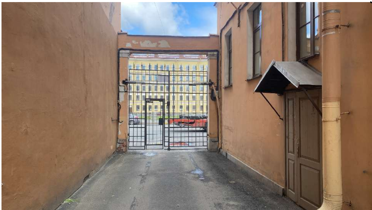
Фото 13. Общие виды на объект. Дата фотофиксации: 26.09.2025г.
