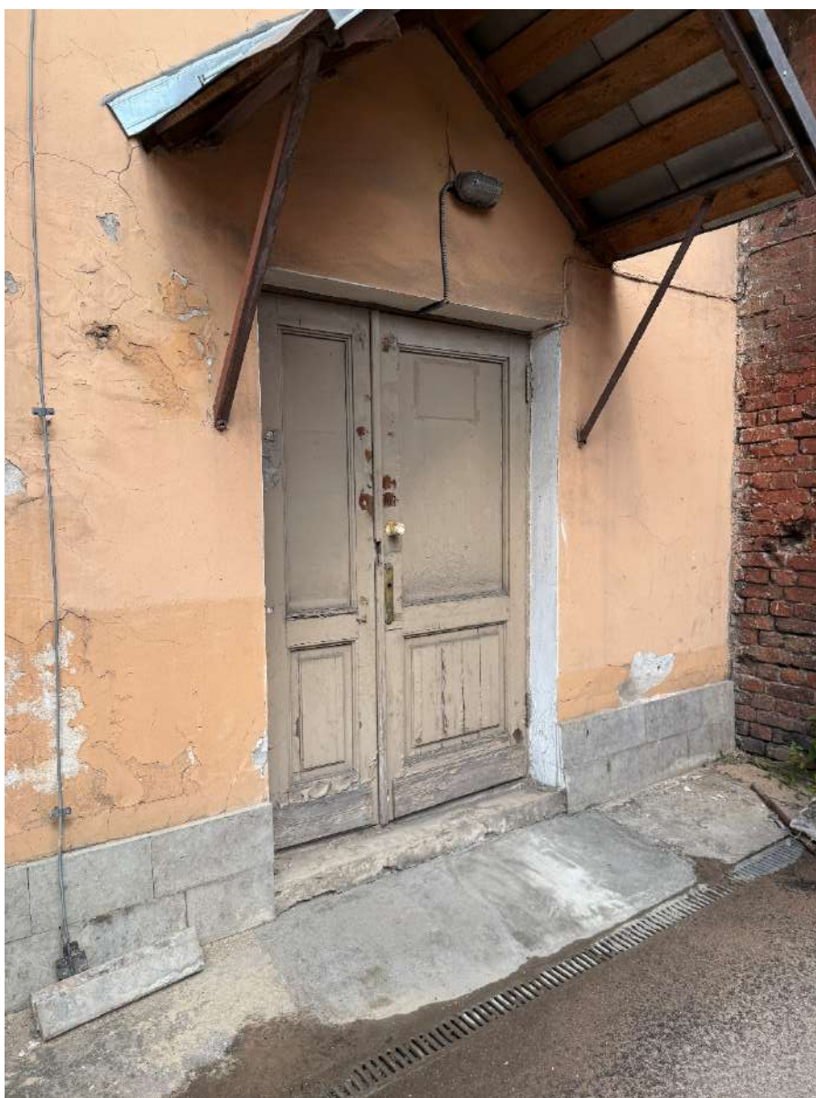
Фото 19. Дверное заполнение на фасаде. Дата фотофиксации: 26.09.2025г.
