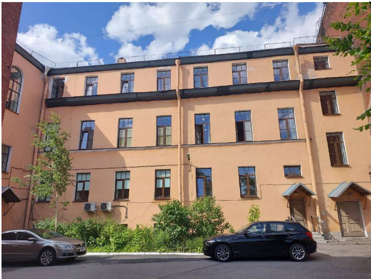
Фото 3. Общие виды на помещения объекта. Дата фотофиксации: 26.09.2025г.
