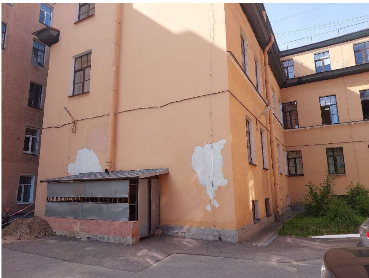
Фото 6. Общие виды на помещения объекта. Дата фотофиксации: 26.09.2025г.
