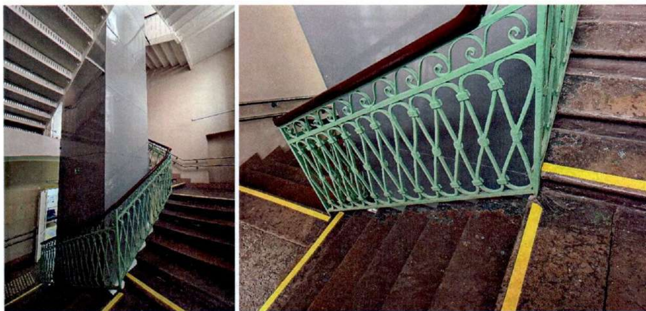
Фото 32, 33. Лестница Л-5 объекта культурного наследия.
