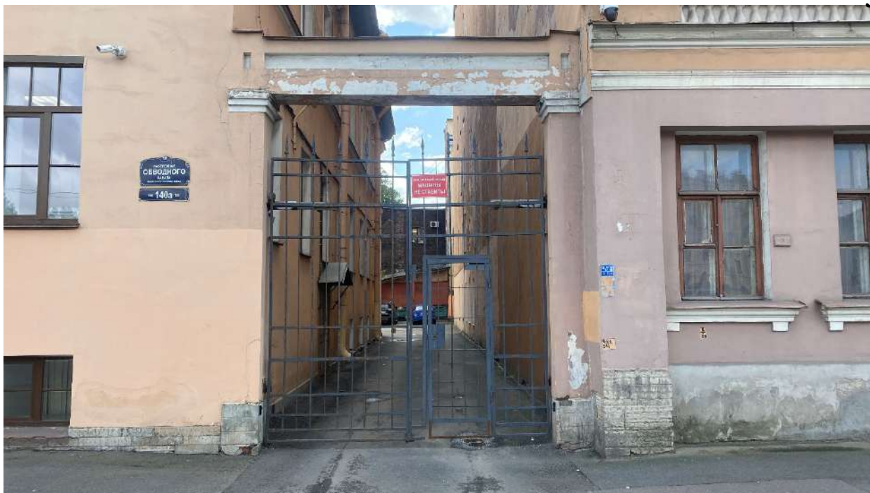
Фото 9. Общее состояние арки. Дата фотофиксации: 26.09.2025г.
