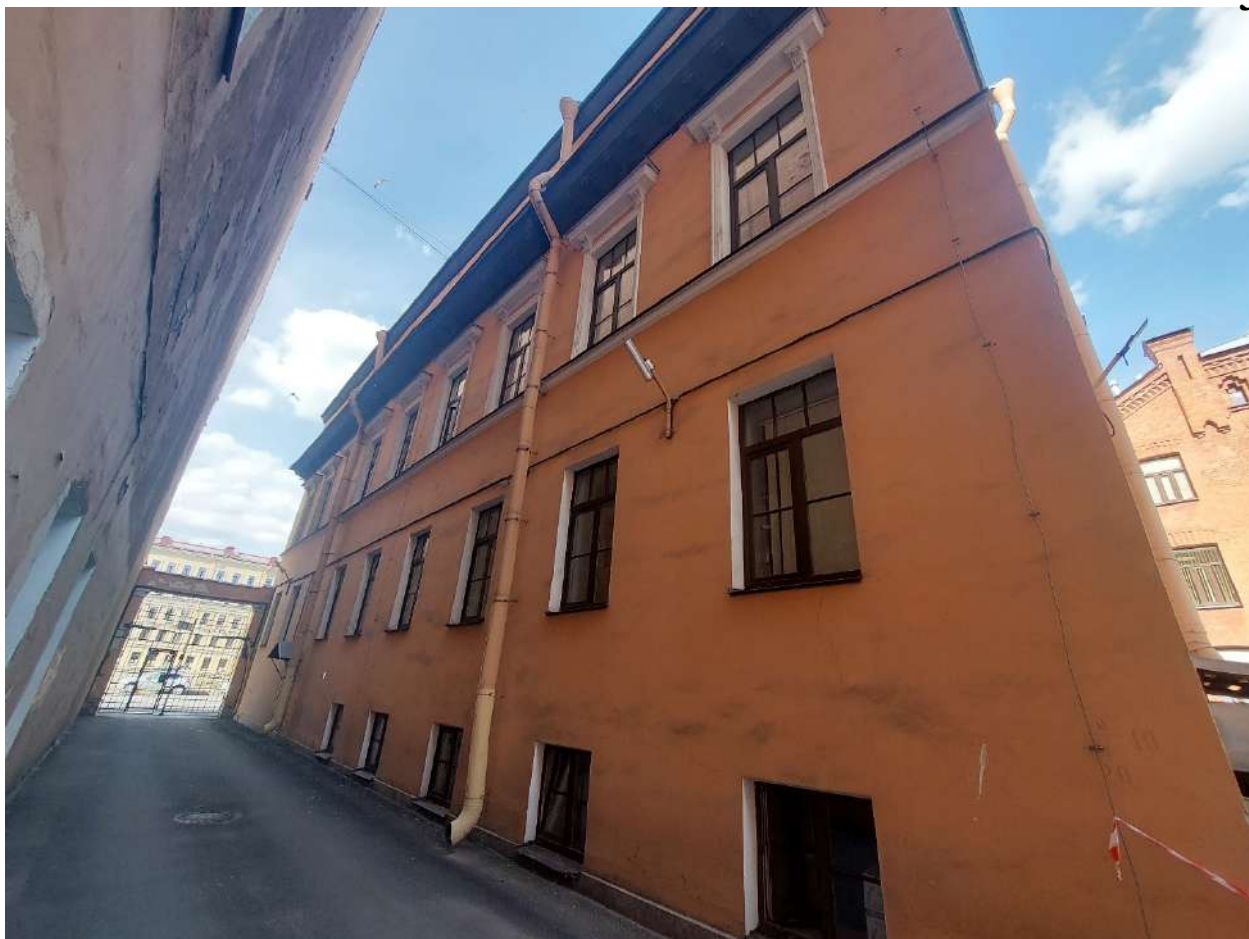
Фото 7. Общие виды на помещения объекта. Дата фотофиксации: 26.09.2025г.
