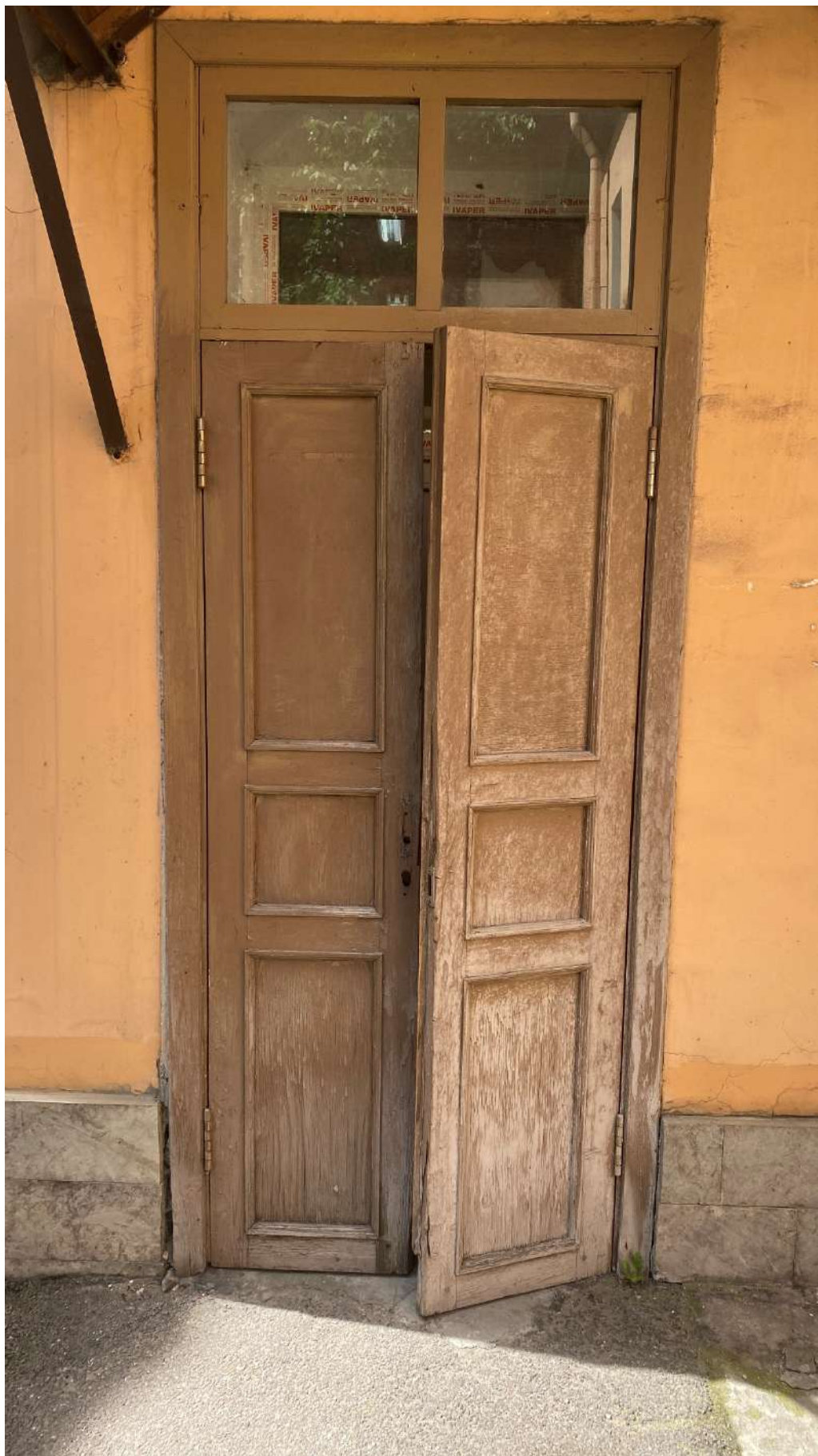
Фото 22. Дверное заполнение на фасаде. Дата фотофиксации: 26.09.2025г.
