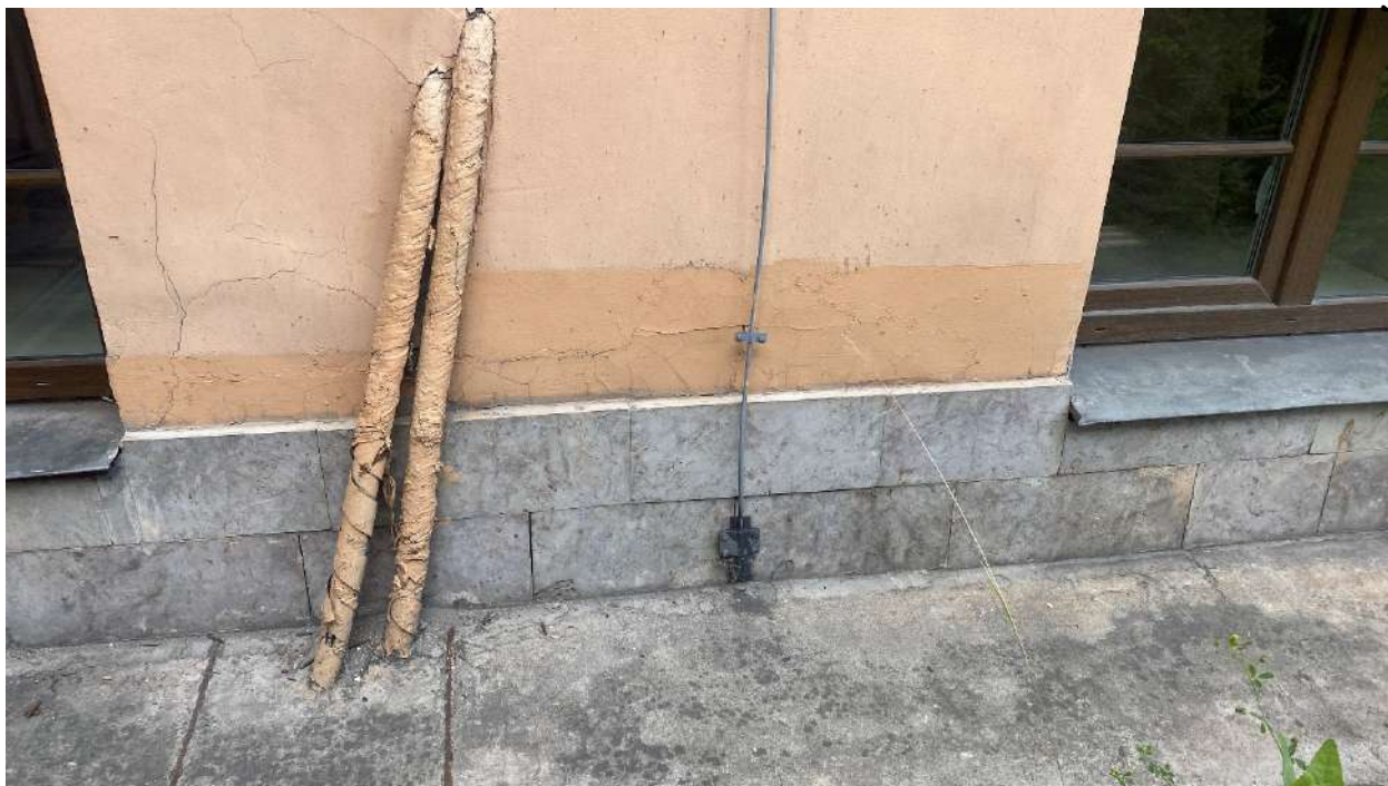
Фото 15. Общее состояние цоколя. Дата фотофиксации: 26.09.2025г.
