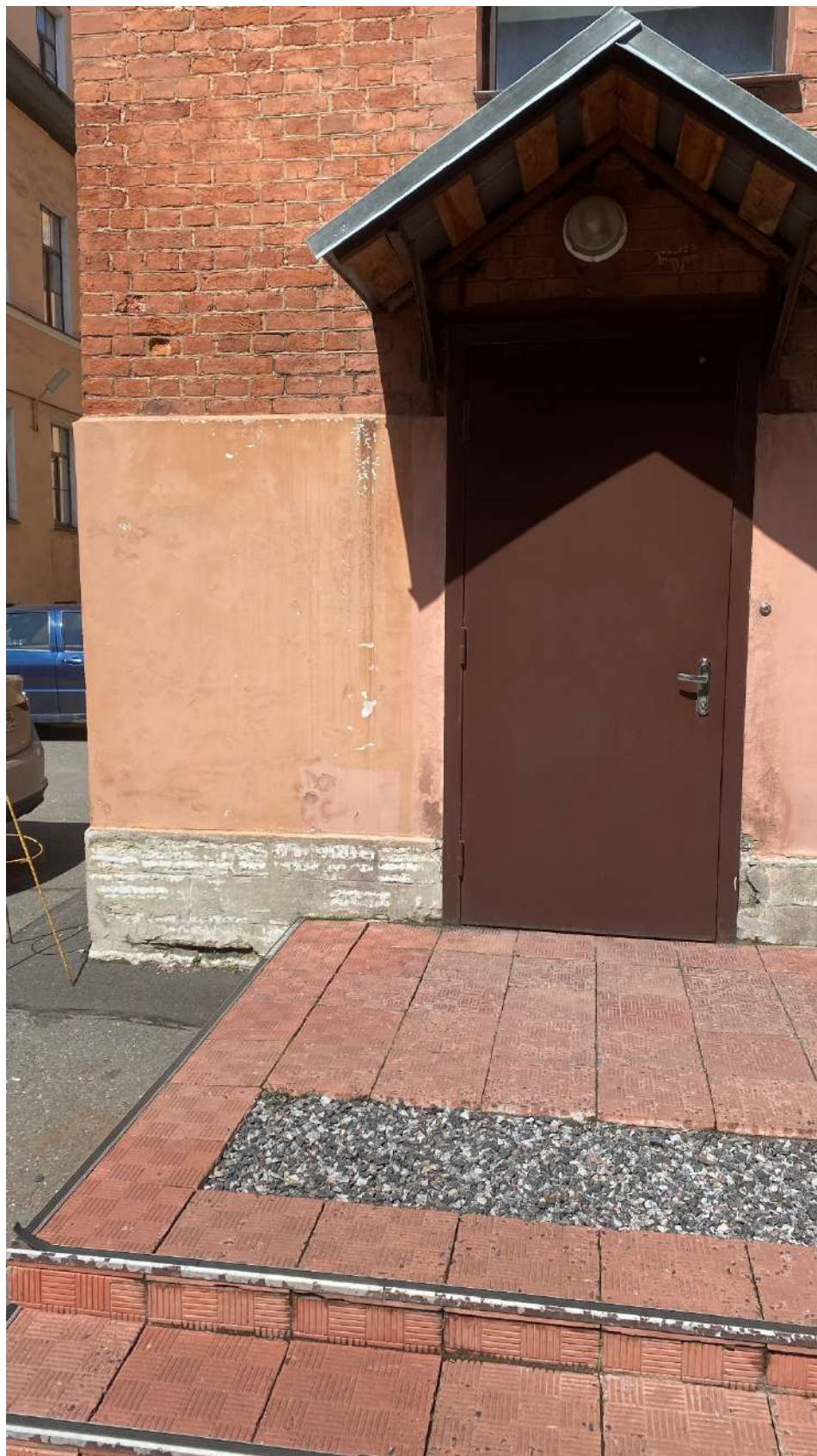
Фото 21. Дверное заполнение на фасаде. Дата фотофиксации: 26.09.2025г.
