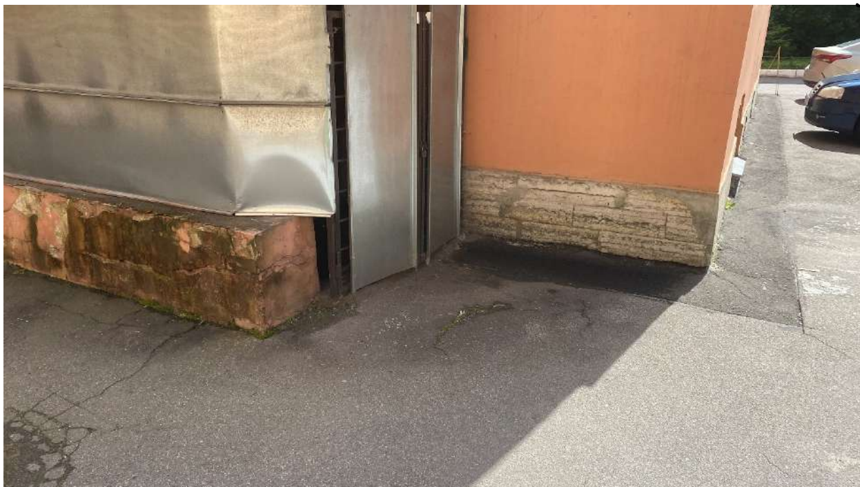
Фото 18. Общее состояние цоколя. Дата фотофиксации: 26.09.2025г.
