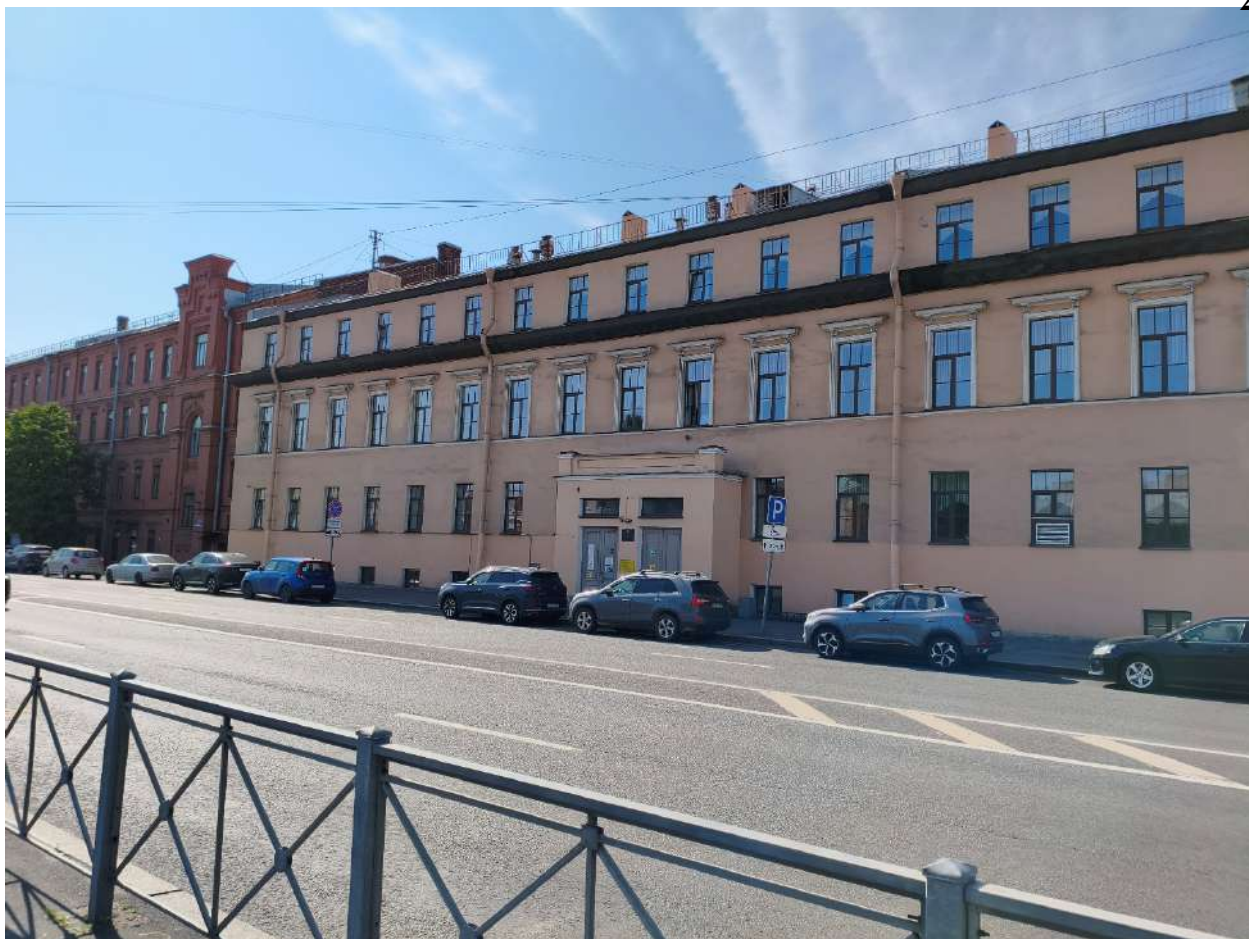
Фото 1. Общий вид на объект. Дата фотофиксации: 26.09.2025г.
