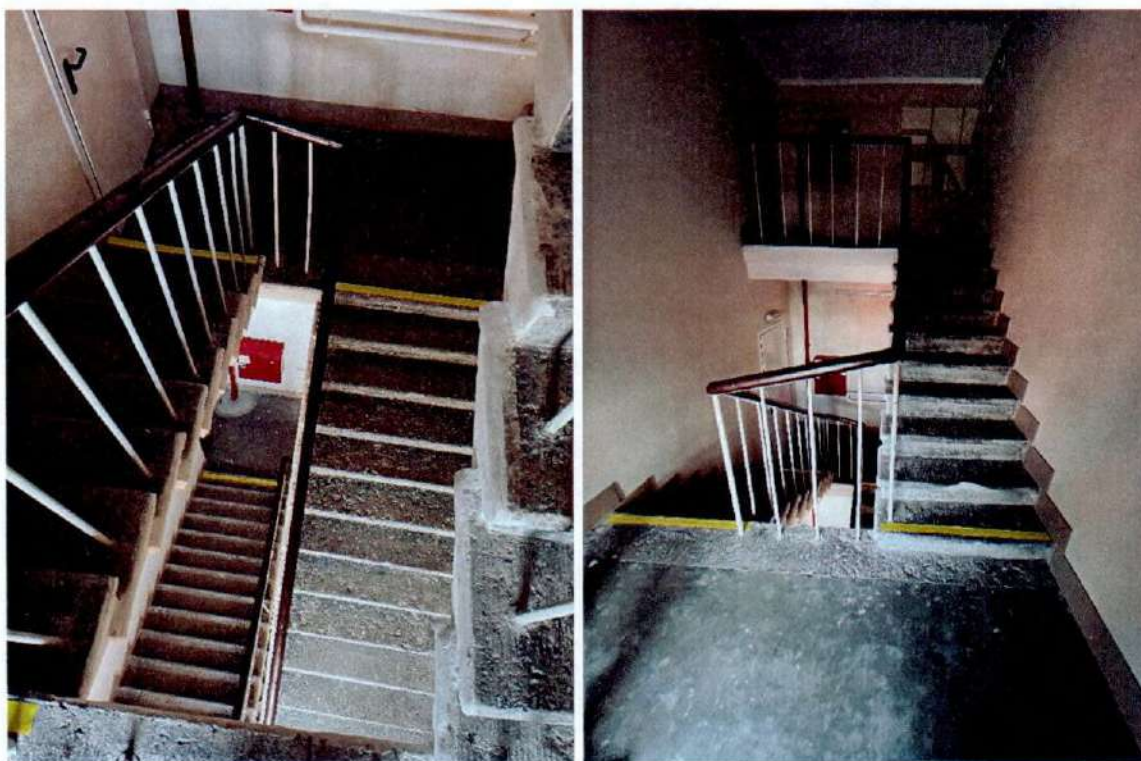
Фото 34, 35. Лестница Л-4 объекта культурного наследия.
