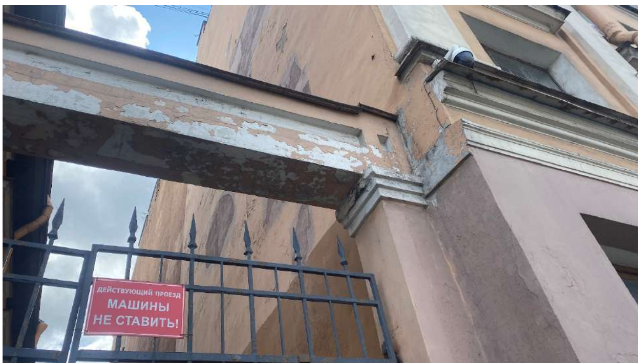
Фото 10. Общее состояние арки. Дата фотофиксации: 26.09.2025г.
