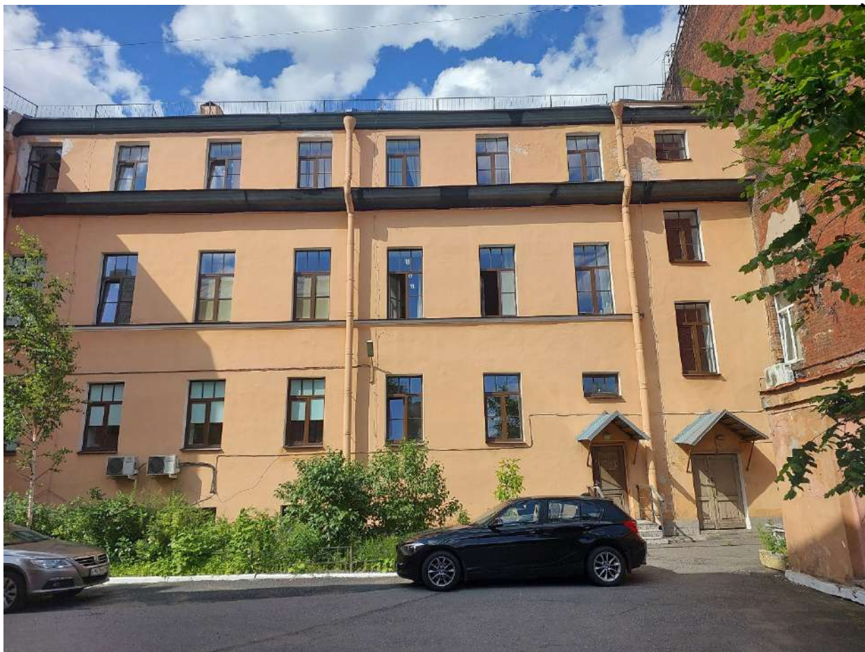
Фото 5. Общие виды на помещения объекта. Дата фотофиксации: 26.09.2025г.
