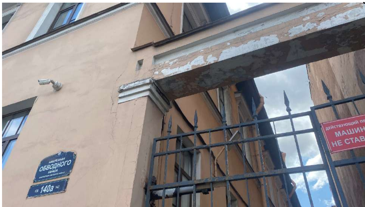
Фото 11. Общее состояние арки. Дата фотофиксации: 26.09.2025г.
