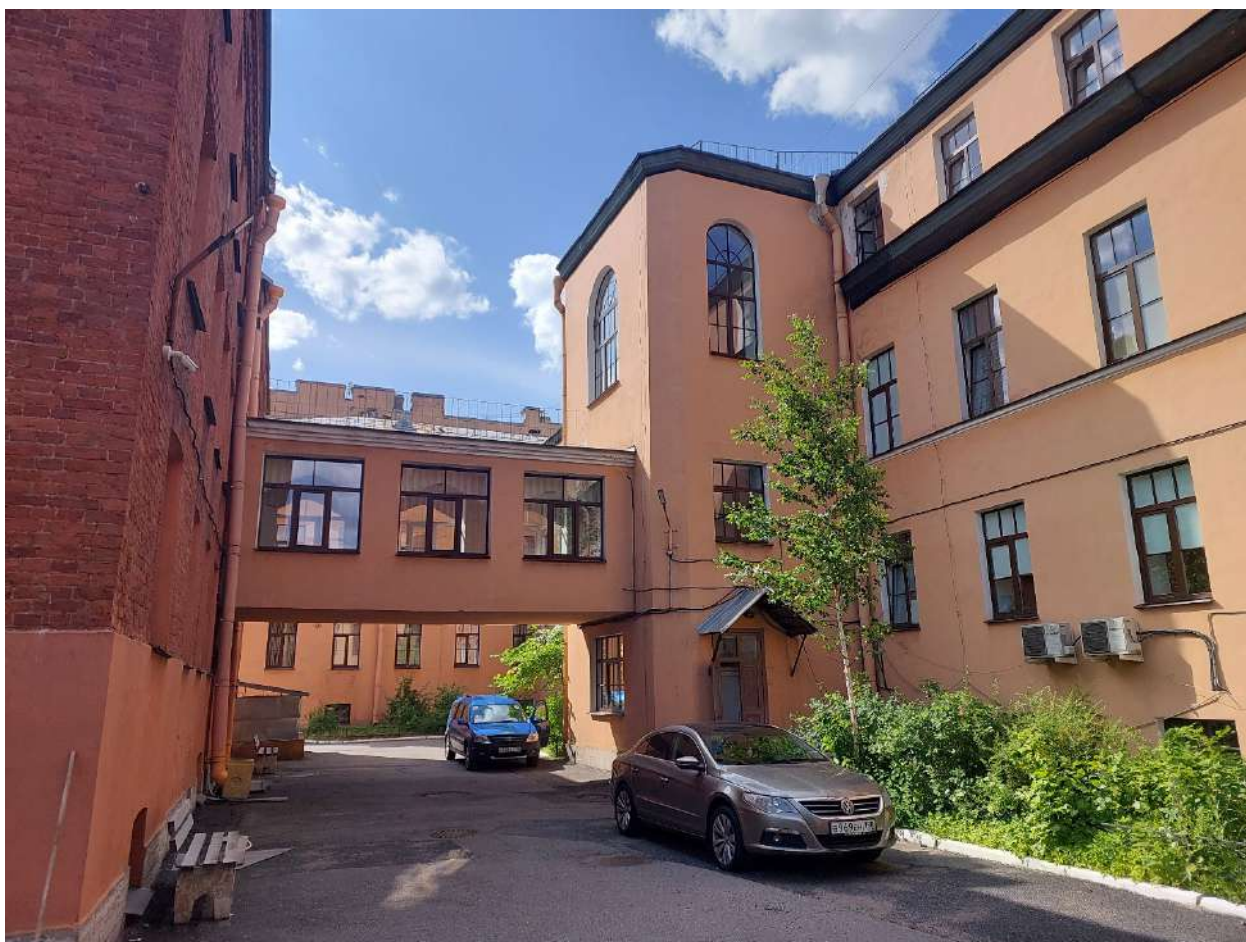
Фото 4. Общие виды на помещения объекта. Дата фотофиксации: 26.09.2025г.
