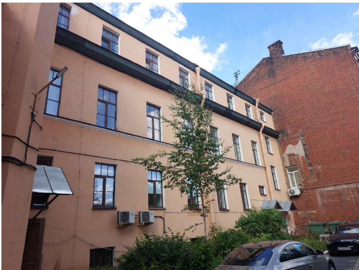
Фото 2. Общие виды на помещения объекта. Дата фотофиксации: 26.09.2025г.
