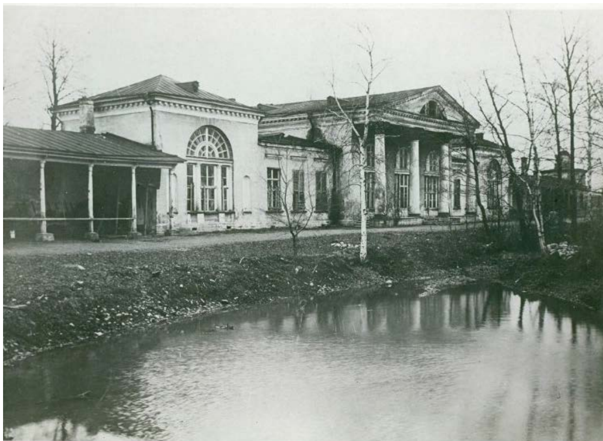
30. Изменение в 1870-е гг. южного фасада за счет выноса стен оранжерей (на фото слева). Архив КГИОП. П. 32. Н-157. Архитектурный паспорт здания общежития Охтинского лесозавода (бывшая дача Безобразовых). Альбом фотографий. Сост.: Вальберг В.П., Липман А.И. 1939 г.
