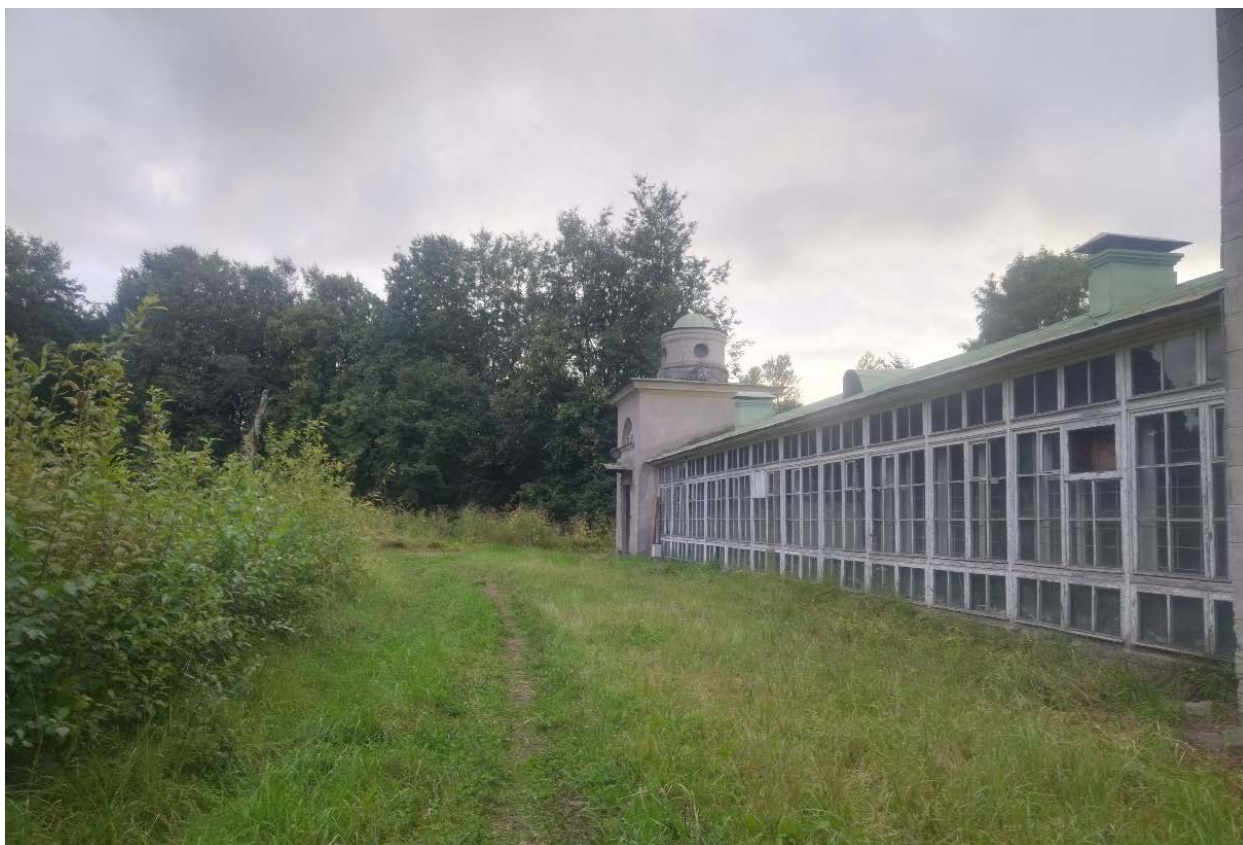
53. Вид на южную часть усадьбы. Южный фасад объекта культурного наследия федерального значения «Дача». Западное крыло. Тропинка вдоль фасада
