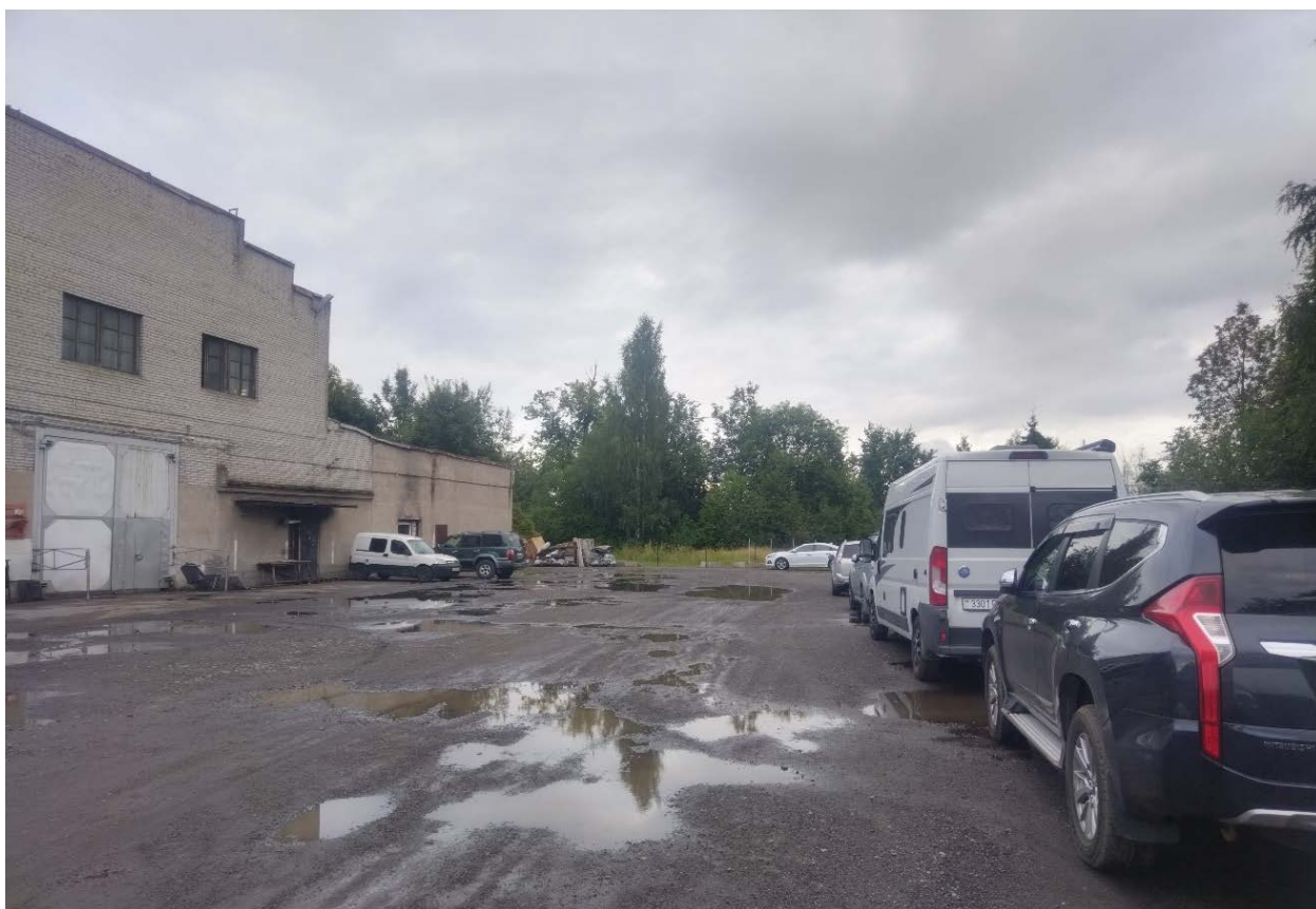
38. Южная часть территории объекта культурного наследия. Площадка для стоянки транспорта
