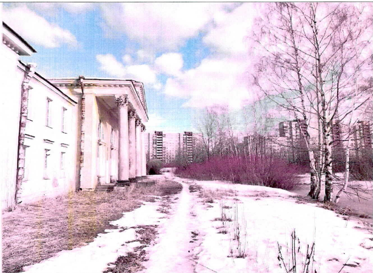
Территория со стороны южного фасада Дачи
