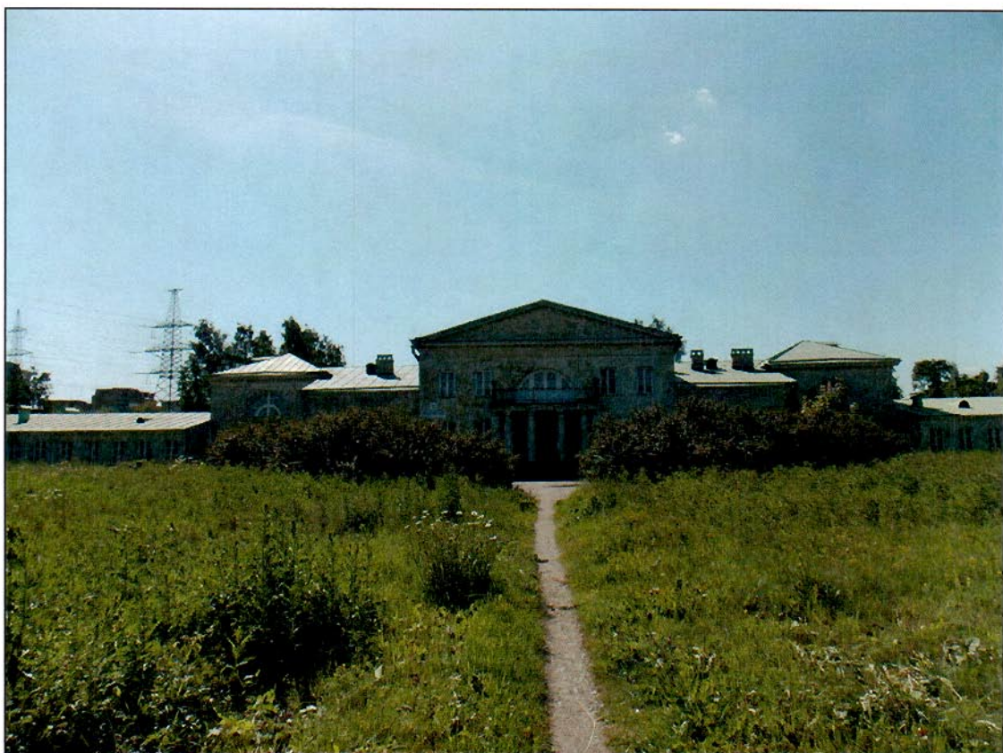
21. Вид на северный фасад здания дачи.
