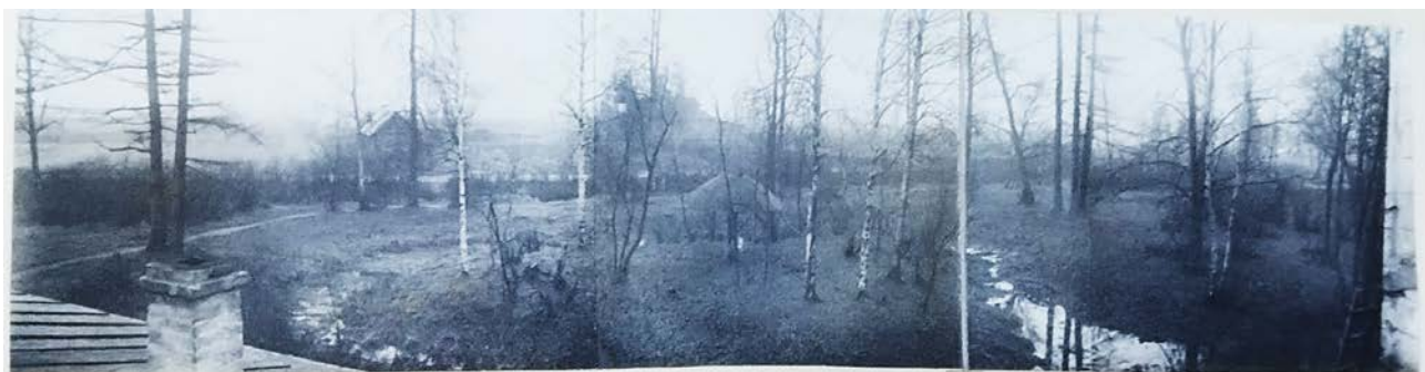
41. Дача Безобразовых. Парк. Панорама восточной части. Вид с севера. Архив КГИОП. П-32. Н-157. Архитектурный паспорт здания общежития Охтинского лесозавода (бывшая дача Безобразовых). Альбом фотографий. Сост.: Вальберг В.П., Липман А.И. 1939г.
