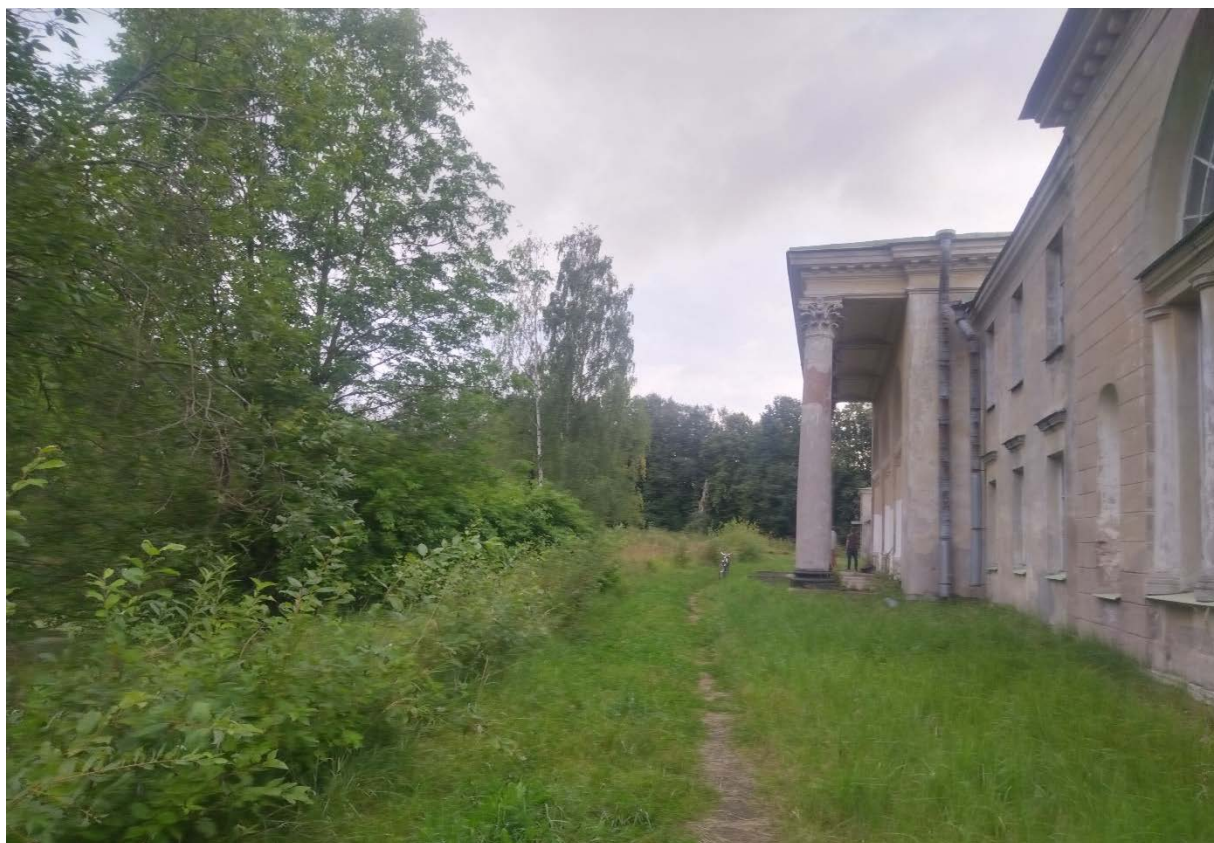
65. Вид на южную часть усадьбы. Южный фасад объекта культурного наследия федерального значения «Дача». Центральная часть. Тропинка вдоль фасада
