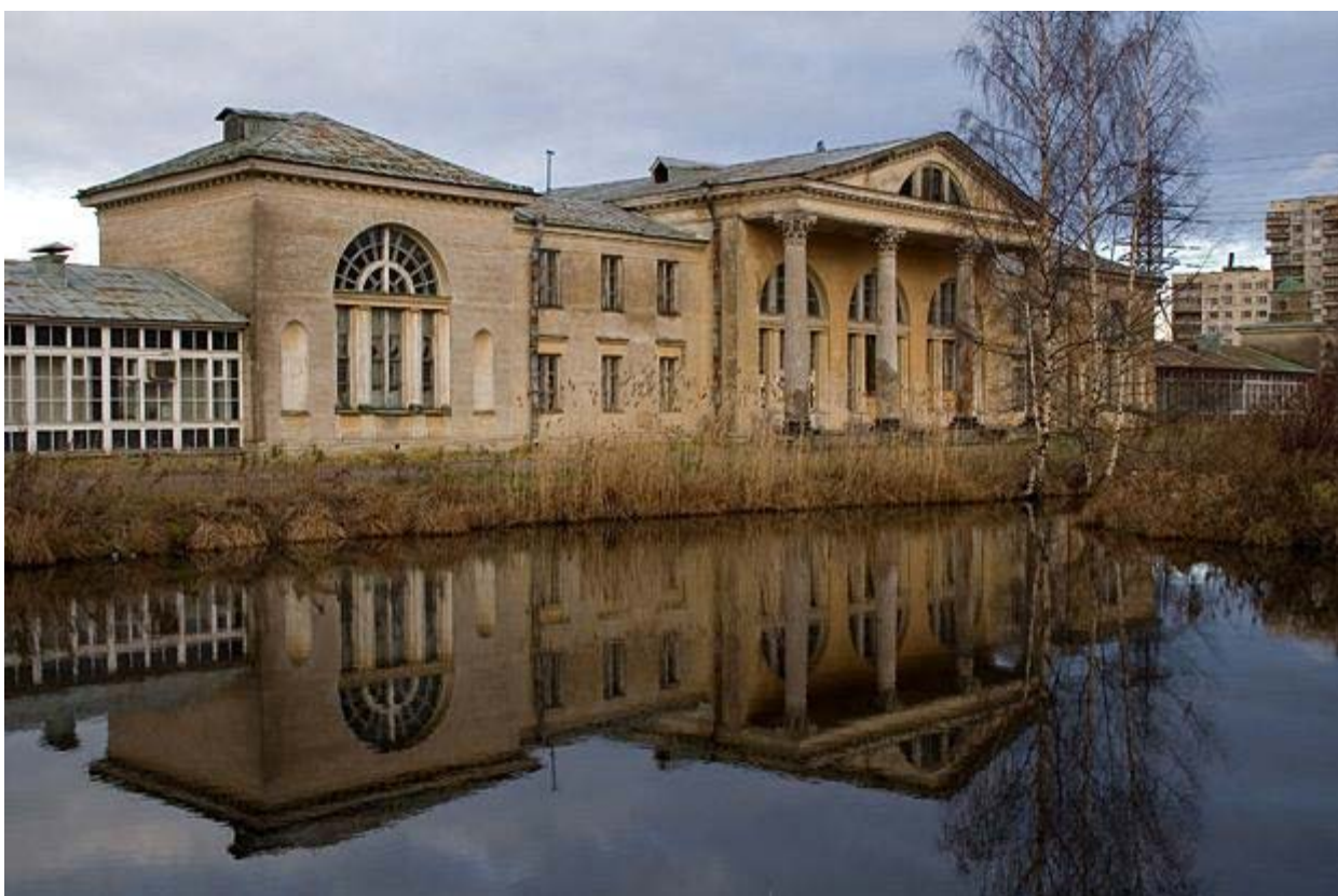
68. Дача Безобразовых ("Жерновка"). Южный фасад. 2008 г. https://www.citywalls.ru/
