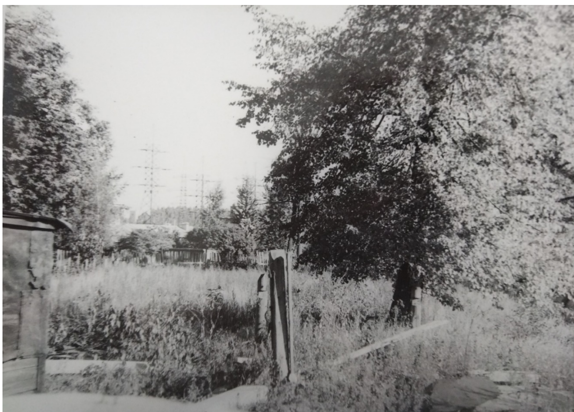
62. Центральная часть участка перед южным фасадом. 1980 г. Архив КГИОП. Фототека. № 87528/2
