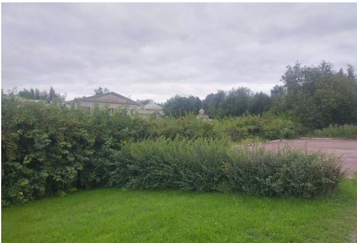
3. Вид входной зоны у Ириновского проспекта. Объект культурного наследия федерального значения «Дача». Фрагмент северного фасада.
