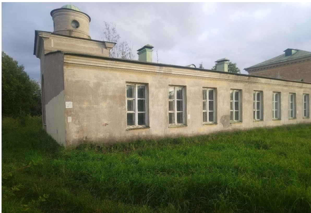
71. Северо-восточная часть усадьбы. Восточное крыло объекта культурного наследия федерального значения «Дача».
