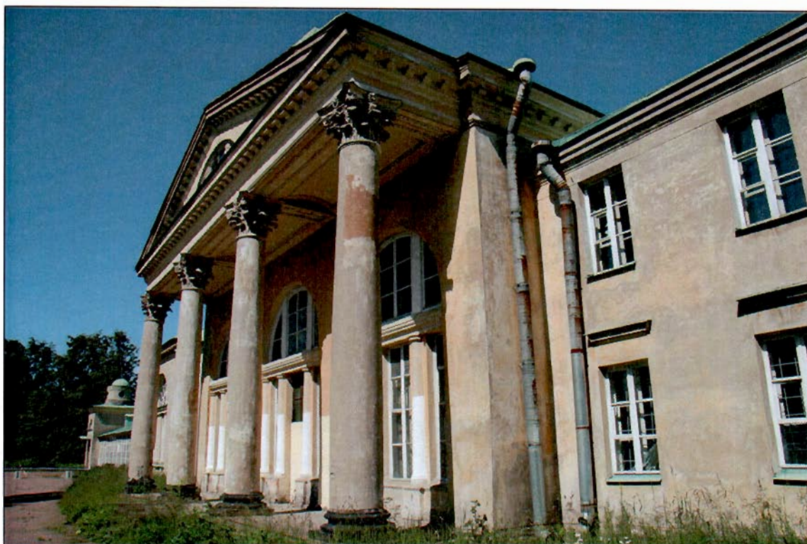
6. Фрагмент. Северный фасад.
