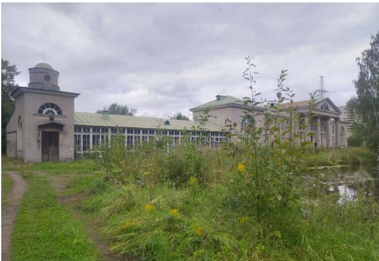
21. Вид на южную часть усадьбы. Южный фасад объекта культурного наследия федерального значения «Дача», «Пруд»
