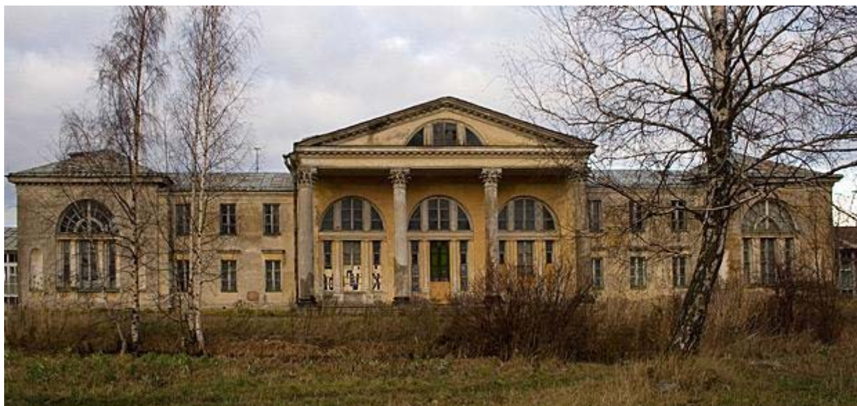
69. Дача Безобразовых ("Жерновка"). Южный фасад. 2008 г. https://www.citywalls.ru/
