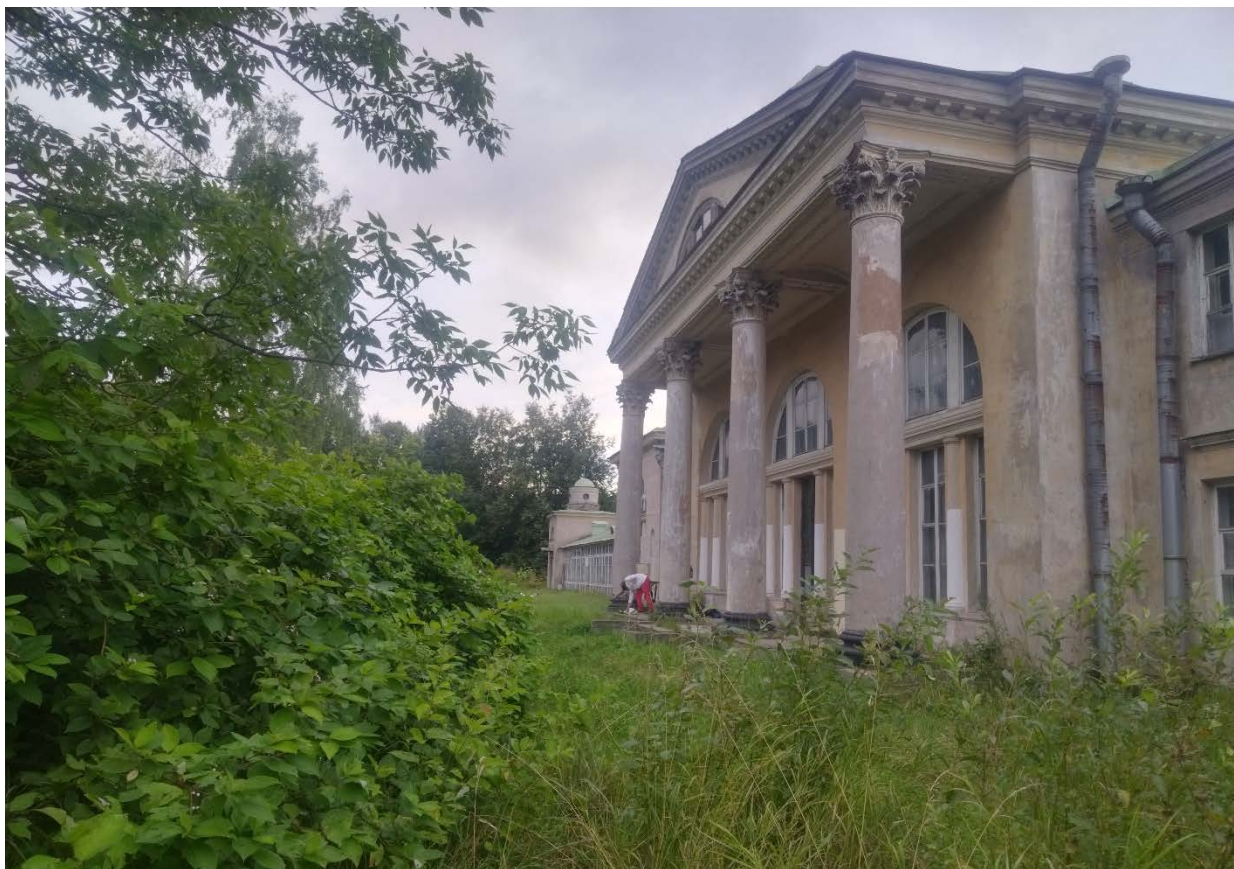
64. Вид на южную часть усадьбы. Южный фасад объекта культурного наследия федерального значения «Дача». Центральная часть. Тропинка вдоль фасада
