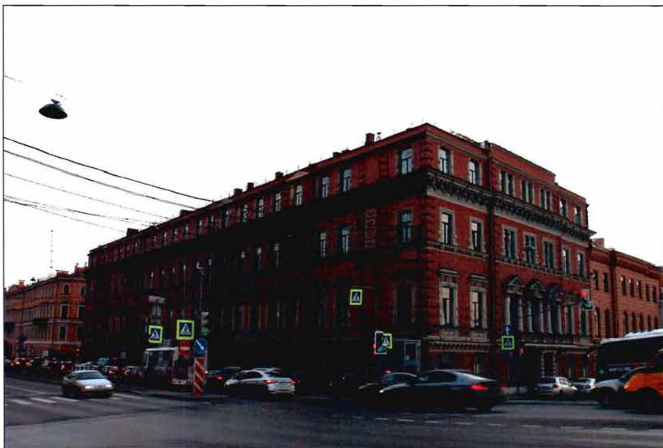
1. Общий вид с северо-востока.
