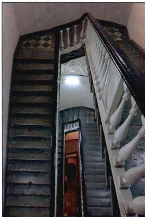
13. Интерьер. Фрагмент. Двухмаршевая лестница с известняковыми ступенями.
