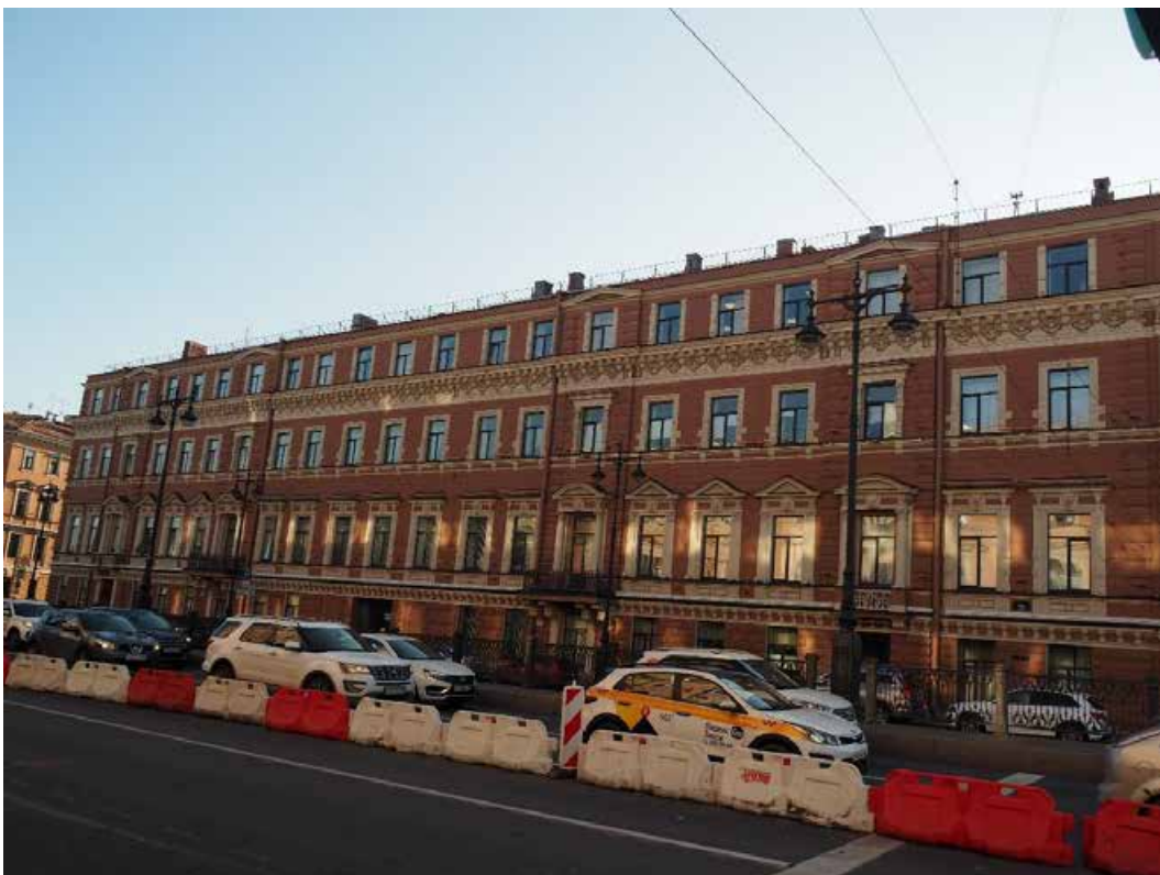
2. «Дом А. Ф. Кларка (здание общества «Мазут»)), Английская набережная, д. 38, литера А. Восточный фасад. Общий вид. Фото 15.09.2025г.
