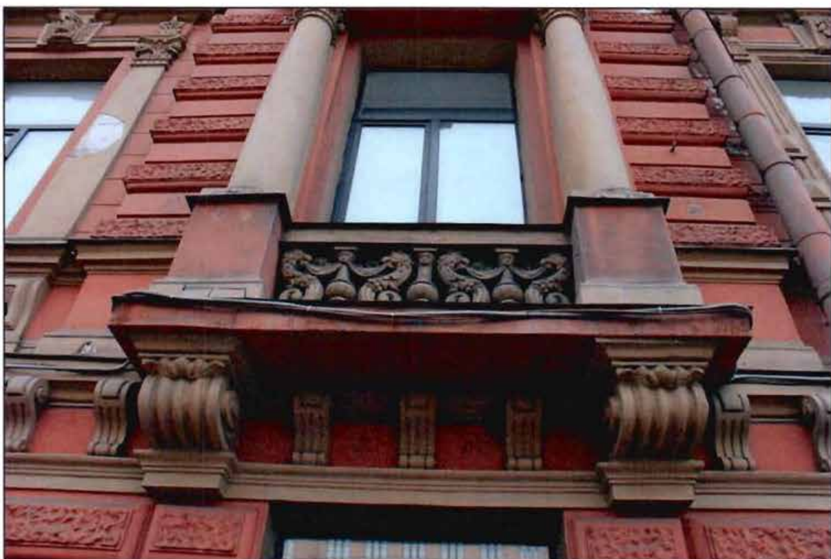
4. Восточный фасад. Фрагмент. Штукатурное ограждение окна в виде парапетных тумб с балясинами.
