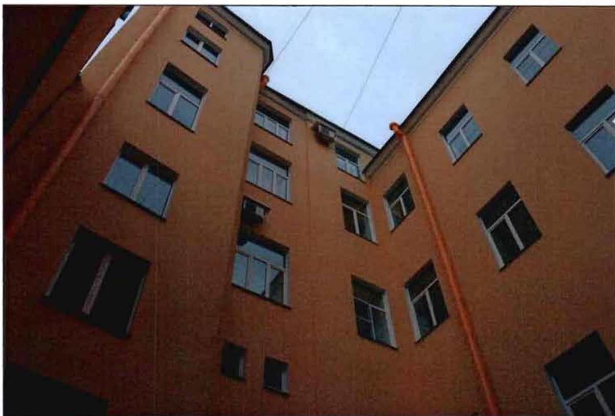
2. Вид на дворовые фасады.
