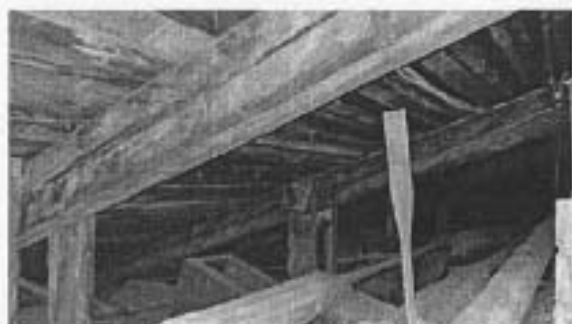
Вид деревянных конструкций кровли чердака
