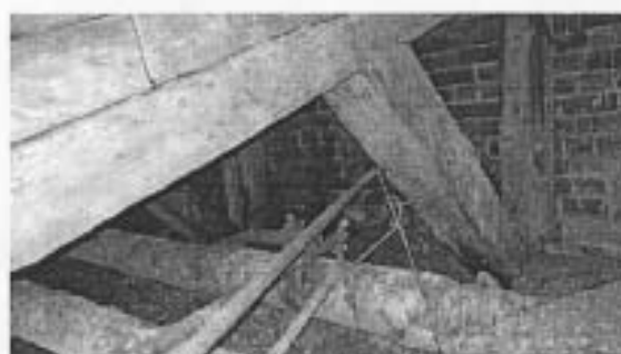
Вид деревянных конструкций кровли чердака
