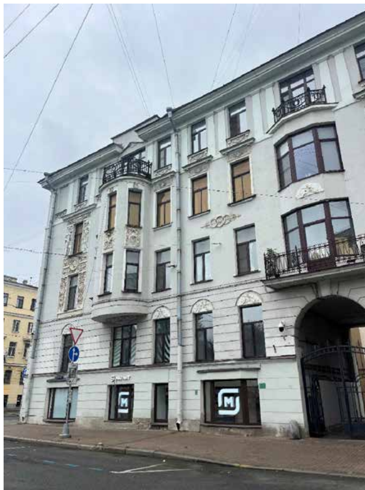
Фото №2. Лицевой северо-восточный фасад.
