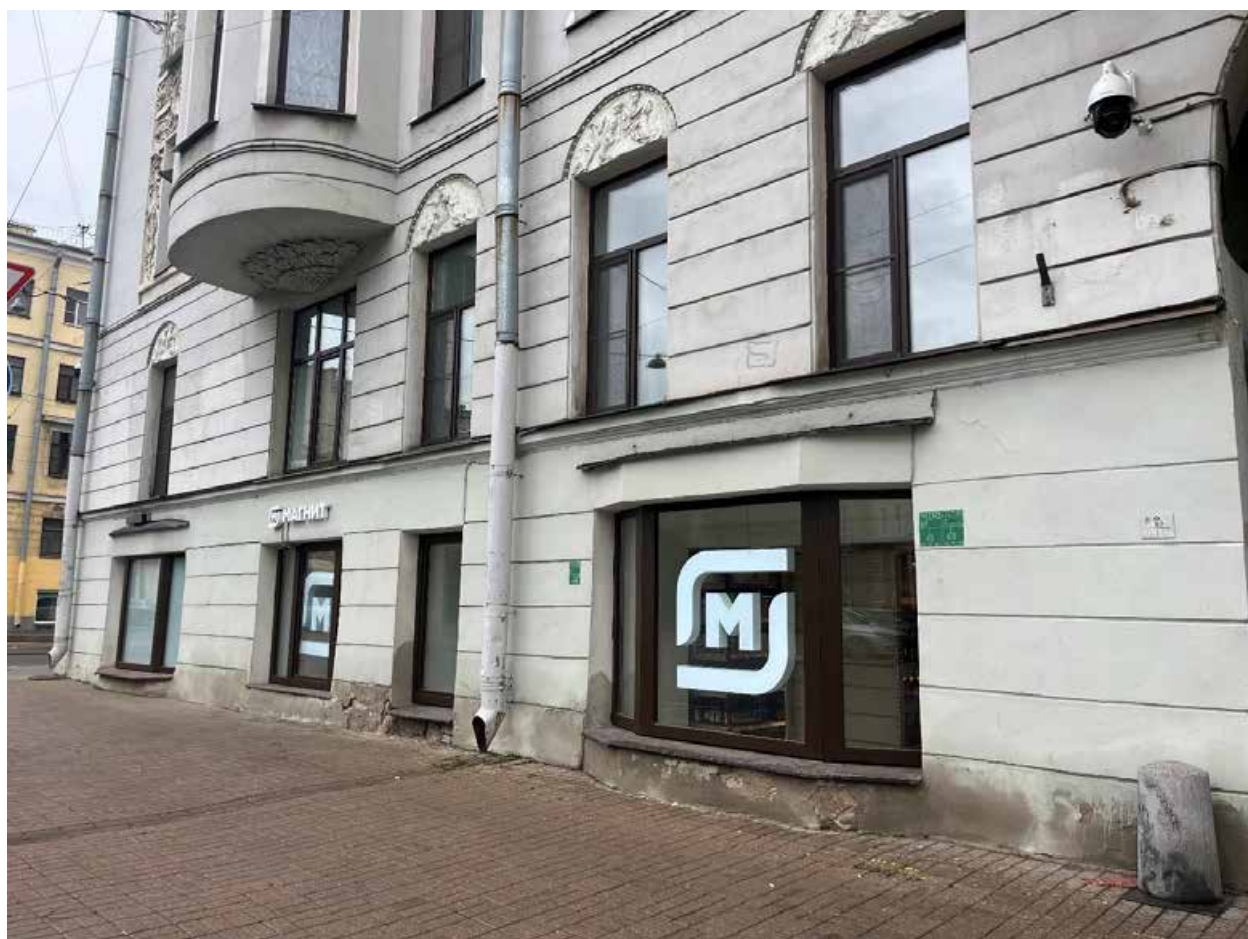
Фото №3. Лицевой северо-восточный фасад.
