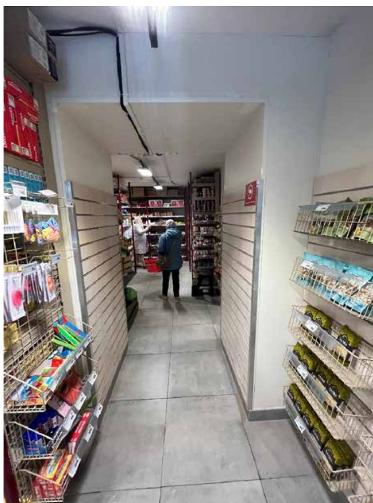
Фото №10. Помещение З-Н, торговый зал, проем в капитальной стене.
