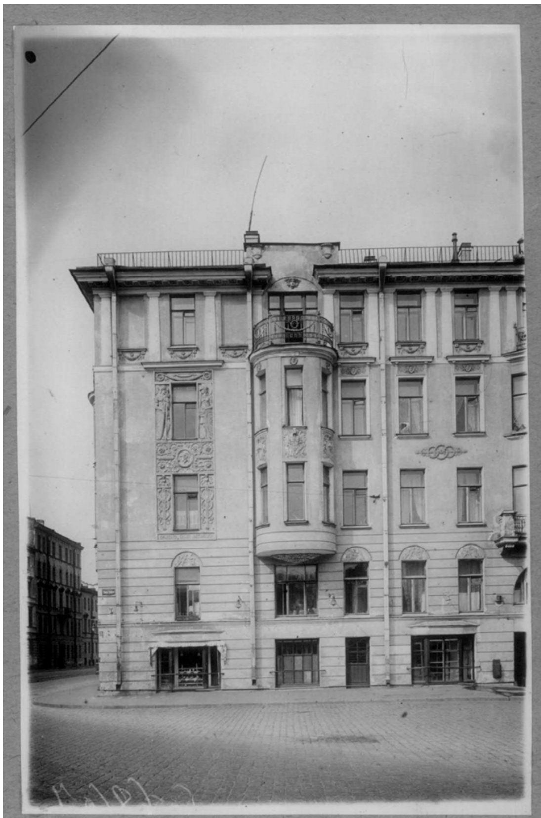
Илл. 24. Вид части фасада дома № 111 на улице 3-го Июля у площади Тургенева. Дата съемки: 1938 г. Авторы съемки: Автор съемки не установлен. // ЦГАКФФД СПб. Фотодокументы. Опись 1ГР-45. Ед.хр.68607.
