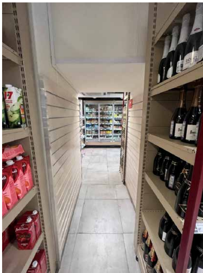
Фото №18. Помещение 1-Н, торговый зал, проем в капитальной стене.
