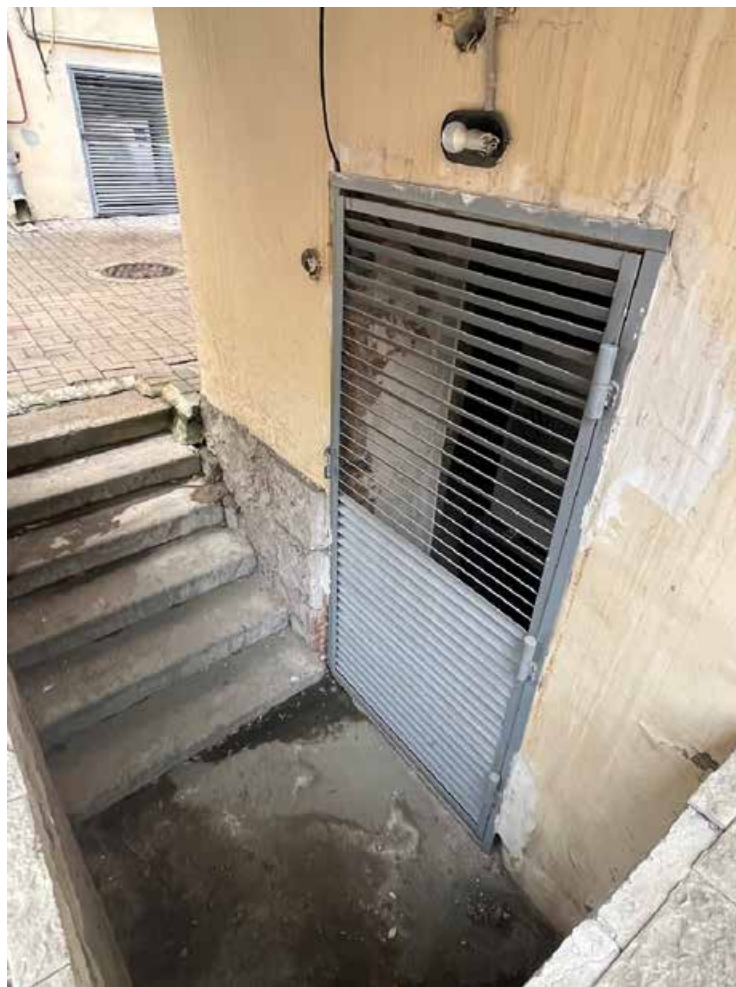
Фото №6. Дворовый северо-западный фасад, приямок, заполнение проема.
