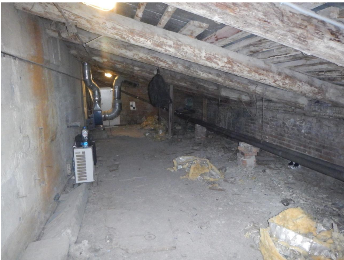
Фото 10. Общий вид чердачного помещения.
