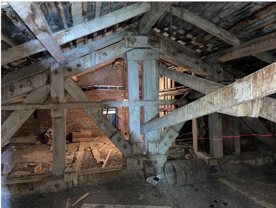
Фото 17. Общий вид стропильной системы крыши.
