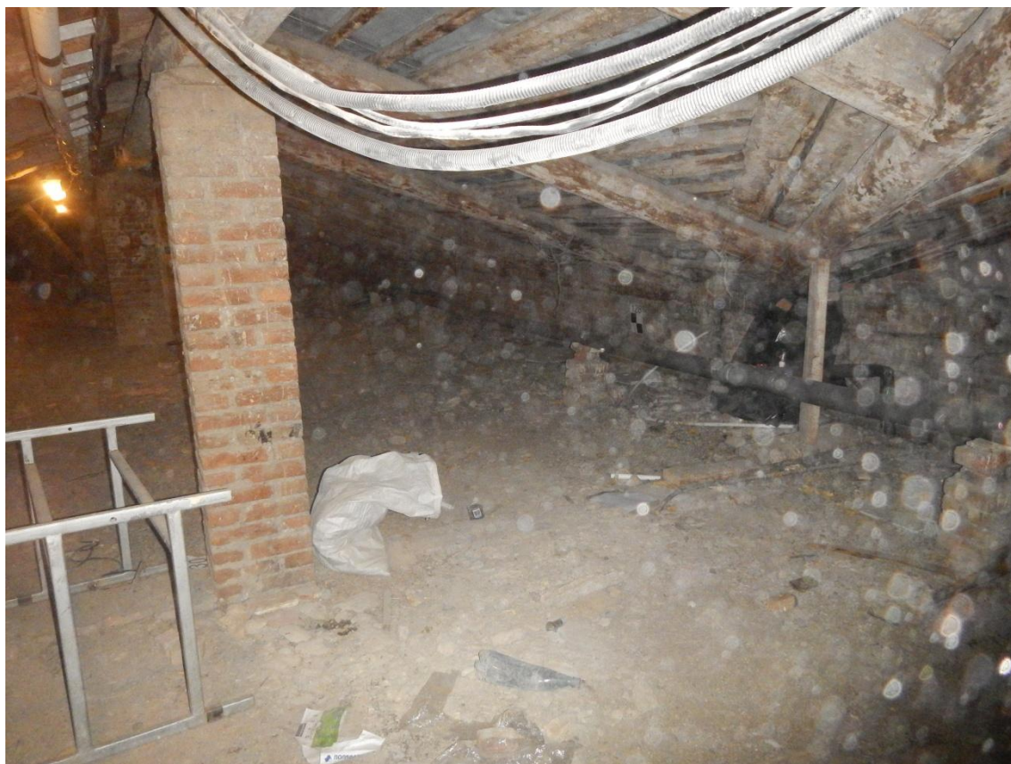
Фото 20. Фрагмент чердачного помещения.
