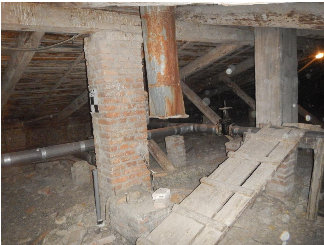
Фото 4. Общий вид чердачного помещения в осях «10-11/И/12-К/12».
