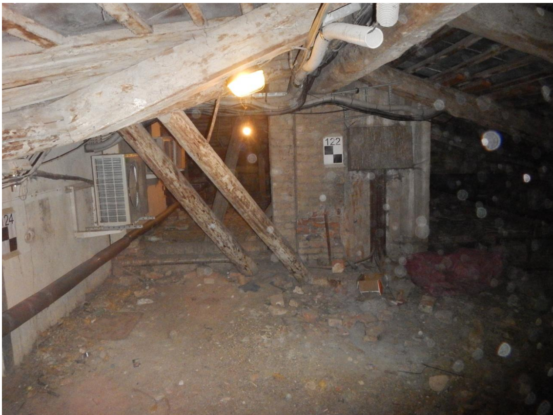
Фото 19. Устройство подкосов стропильной системы.
