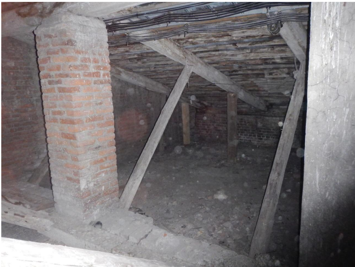
Фото 11. Общий вид стропильной системы крыши
