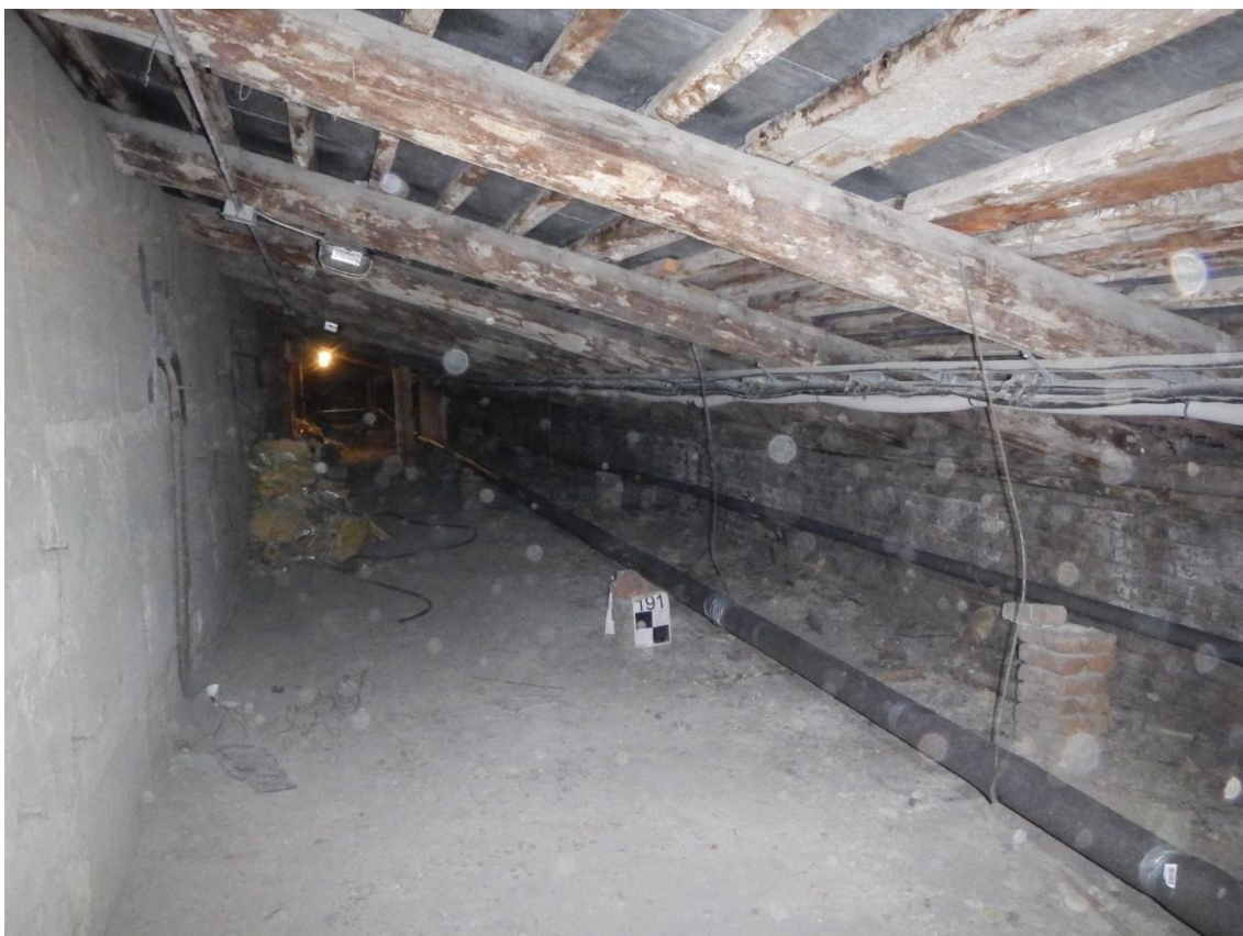
Фото 7. Общий вид чердачного помещения.
