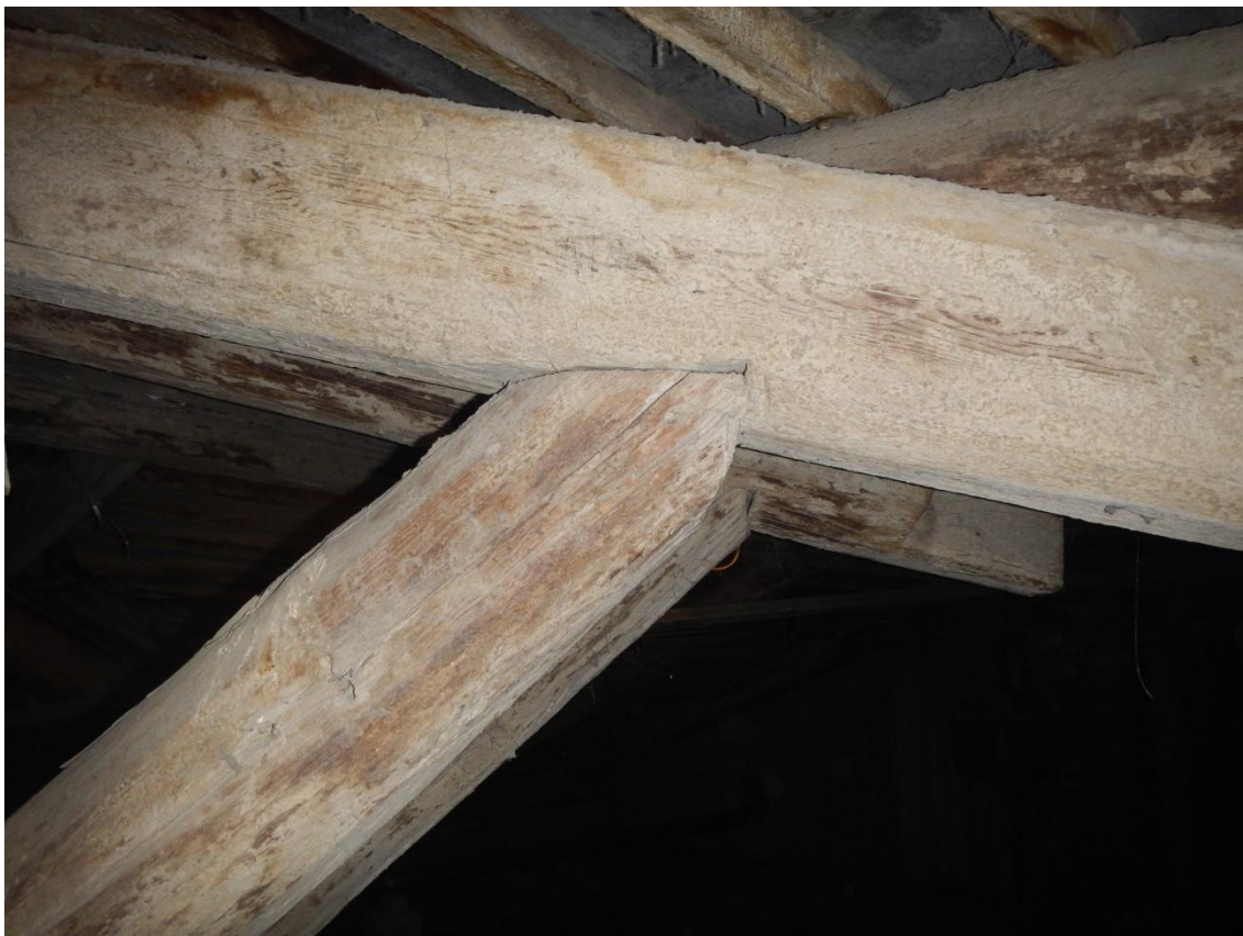
Фото 5. Общий вид сопряжения подкоса и стропильной ноги.
