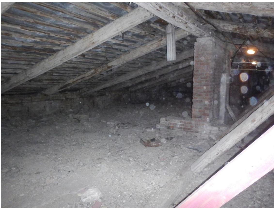
Фото 12. Общий вид чердачного помещения
