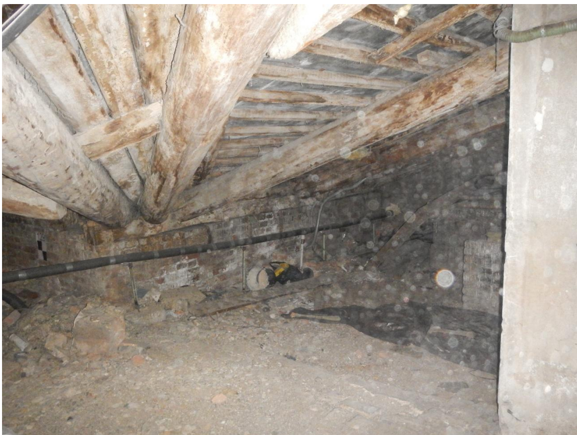
Фото 18. Устройство ендовы крыши.
