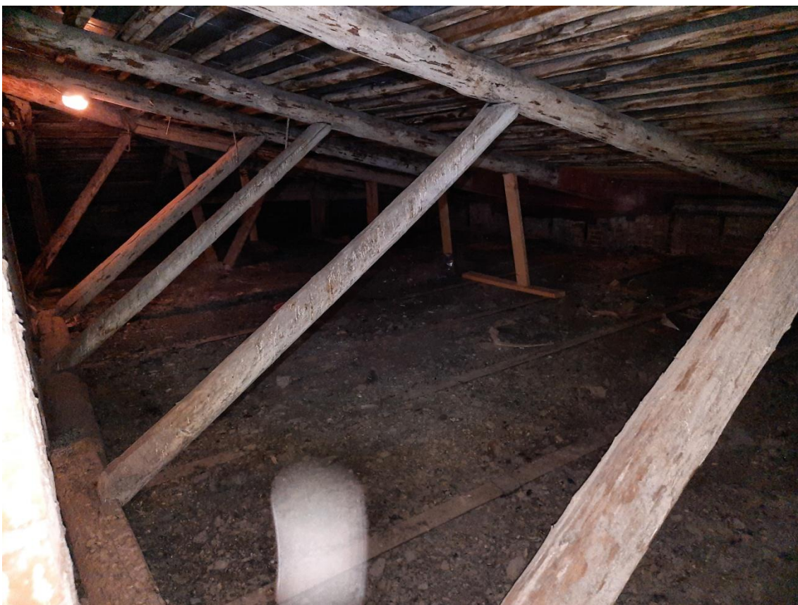
Фото 14. Общий вид стропильной системы крыши.
