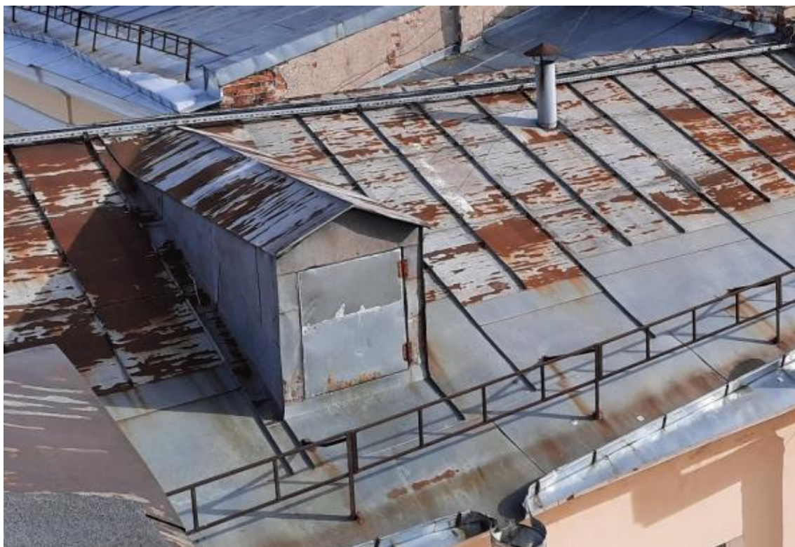
Фото 7. Общий вид слухового окна.
