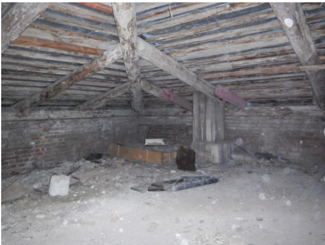
Фото 9. Общий вид чердачного помещения.
