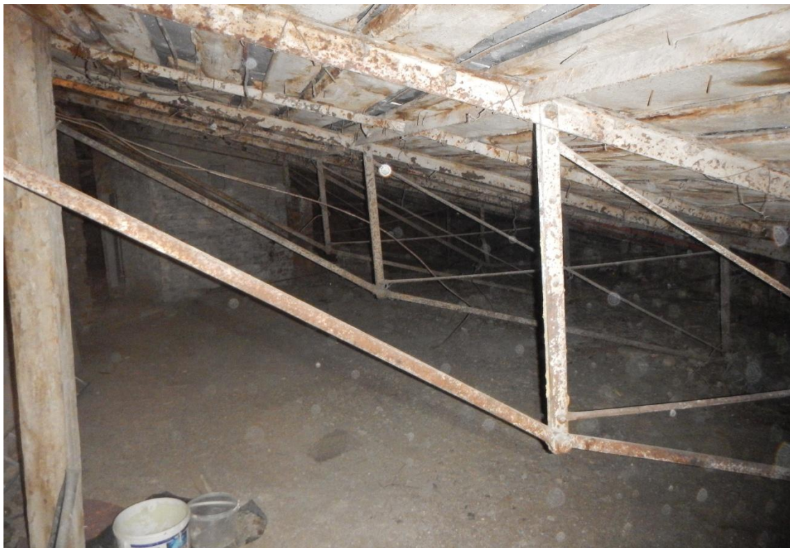
Фото 1. Общий вид стропильных конструкции крыши.
