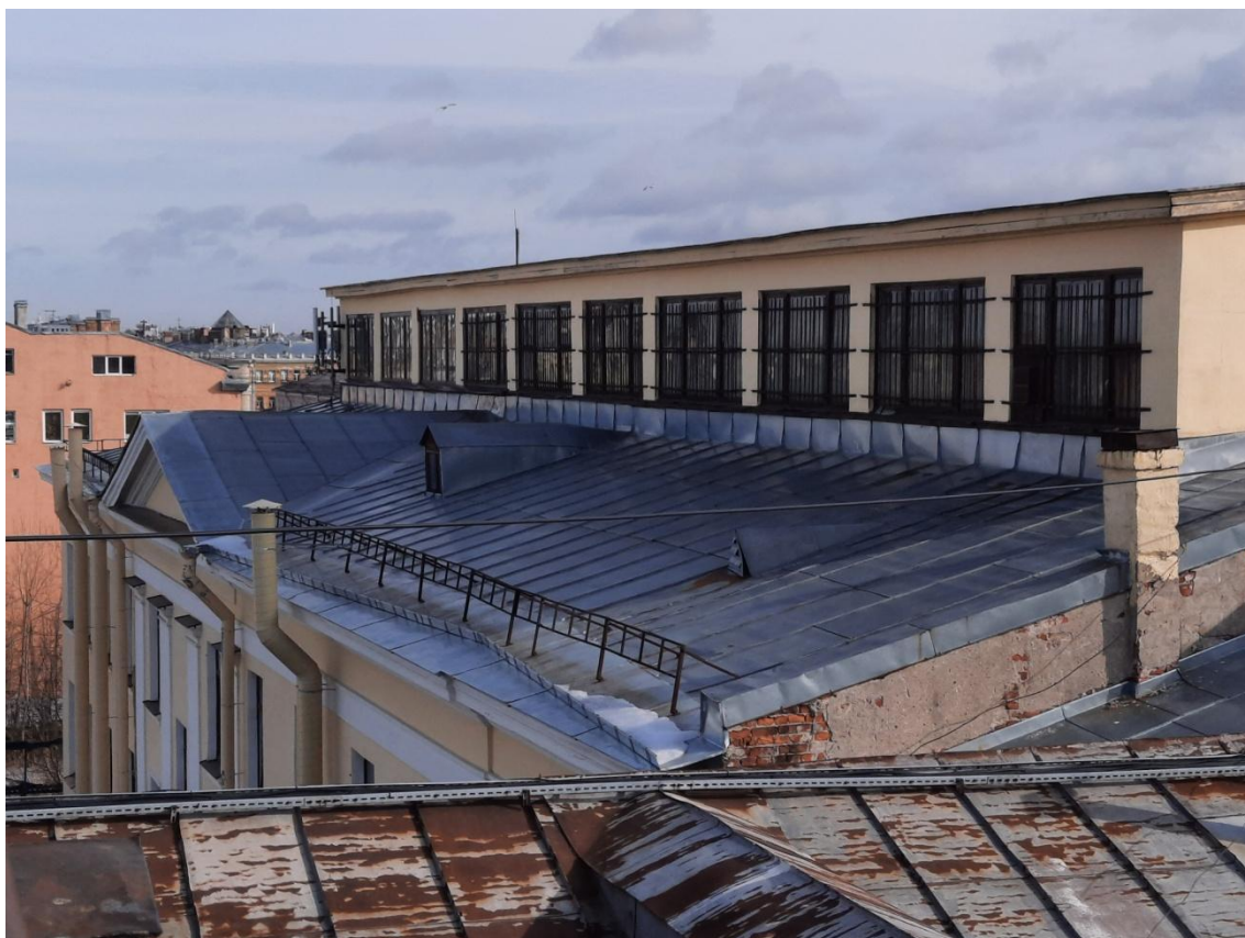
Фото 8. Общий вид кровли.
