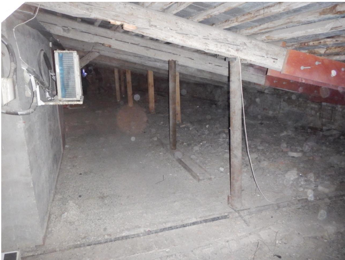
Фото 13. Общий вид стропильной системы крыши
