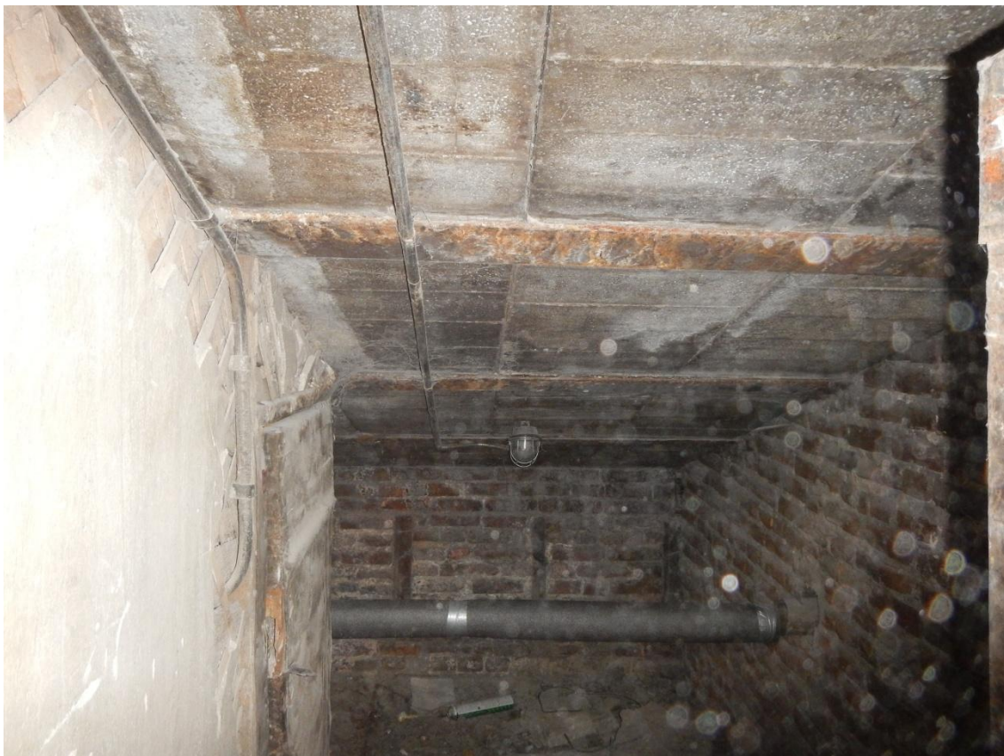
Фото 21. Общий вид стропильной системы крыши.
