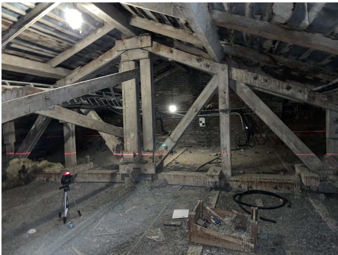
Фото 15. Общий вид стропильной системы крыши.
