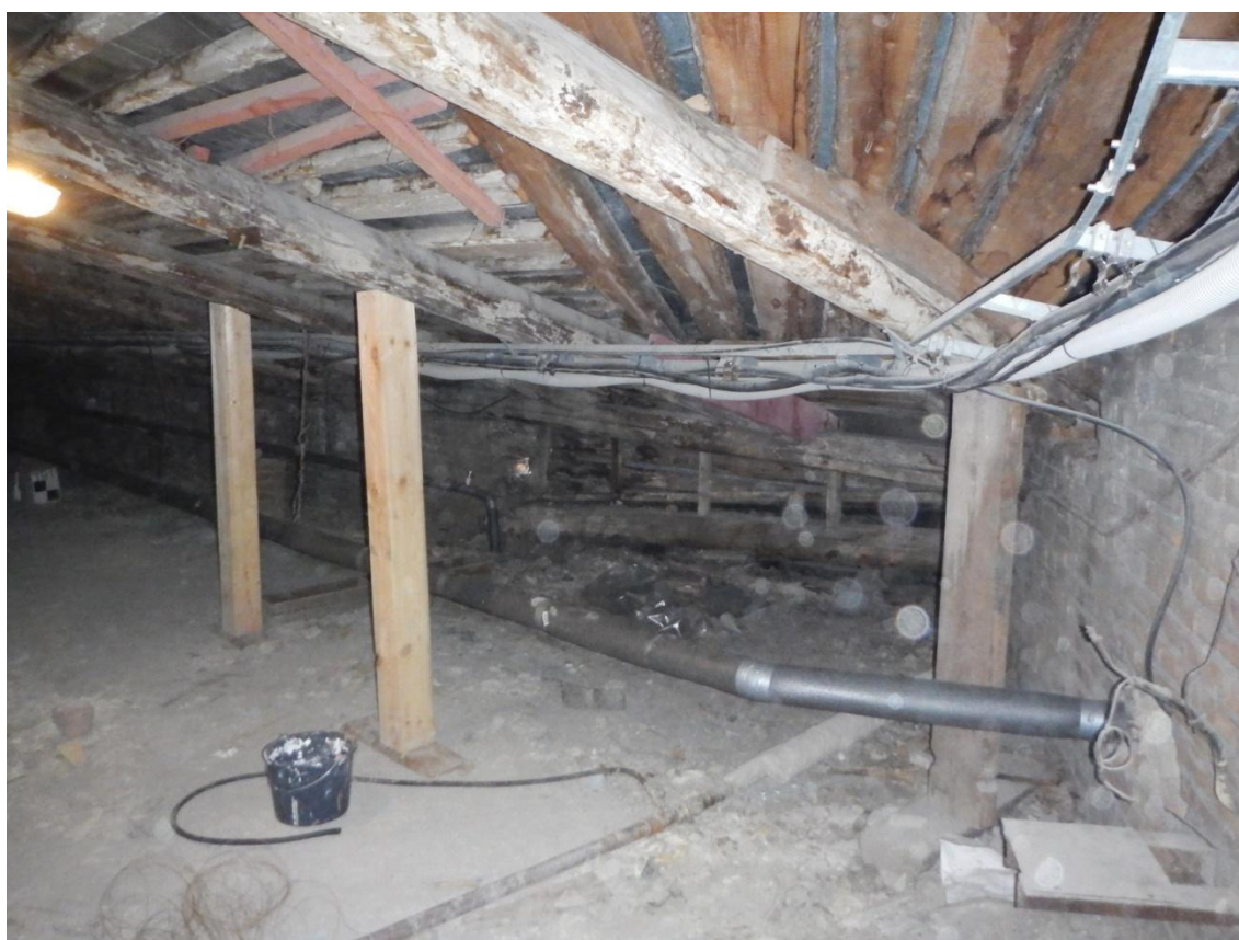
Фото 6. Общий вид чердачного помещения
