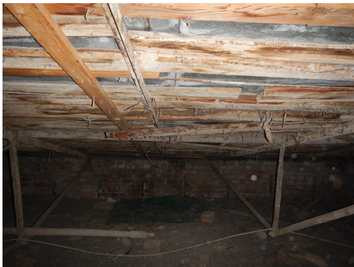
Фото 2. Общий вид стропильных конструкции крыши.
