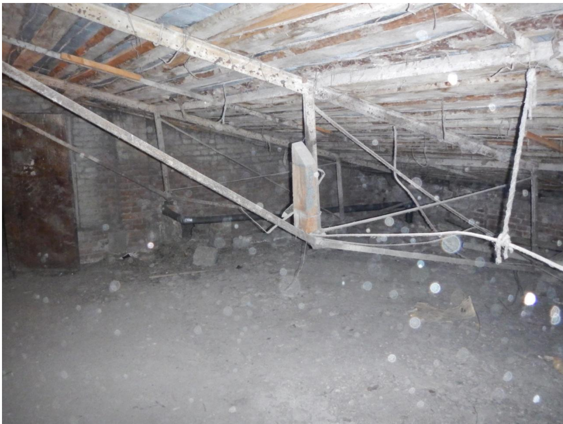
Фото 3. Общий вид стропильных конструкции крыши.
