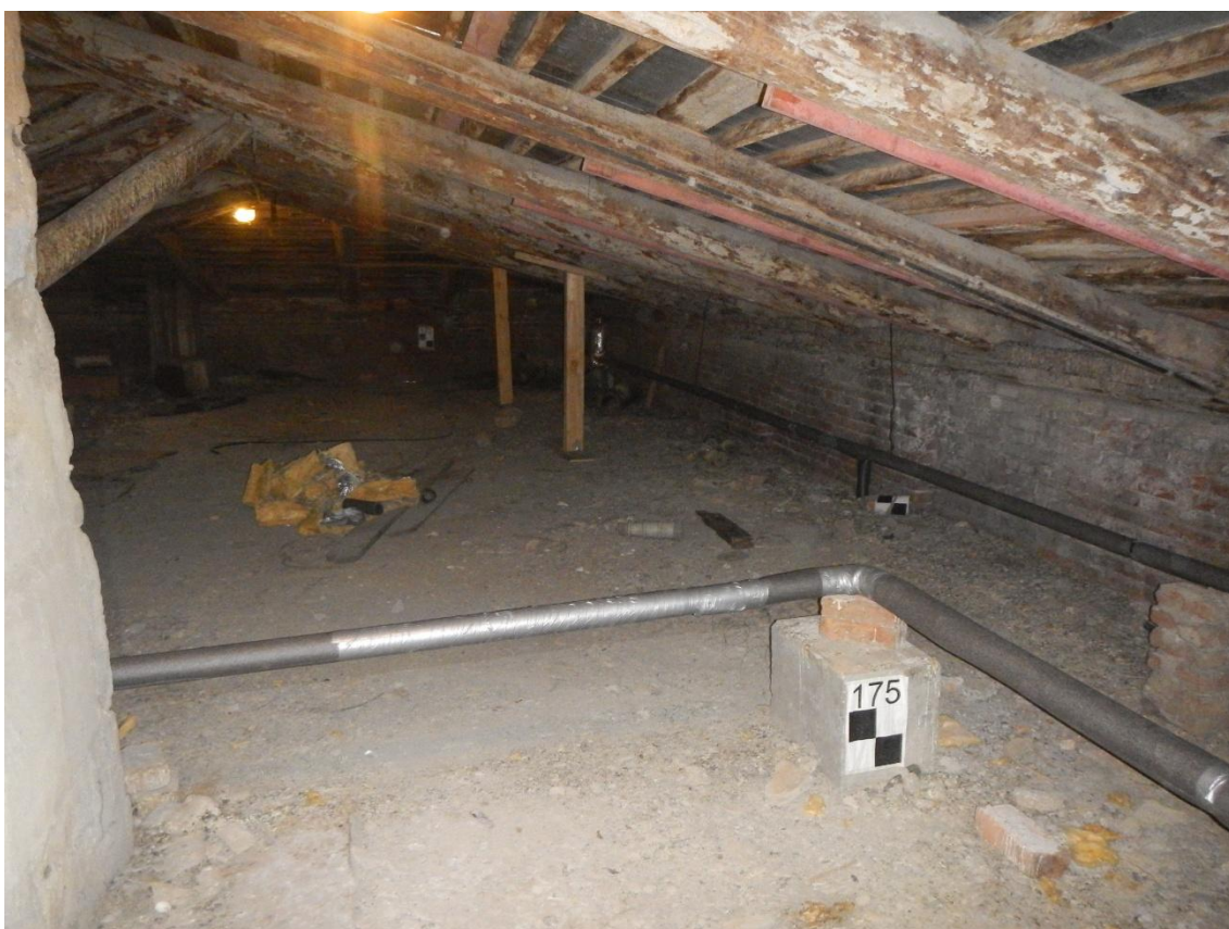
Фото 8. Общий вид чердачного помещения.
