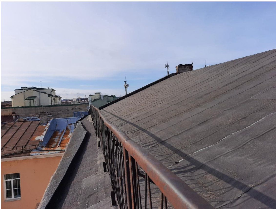
Фото 3. Общий вид кровли.
