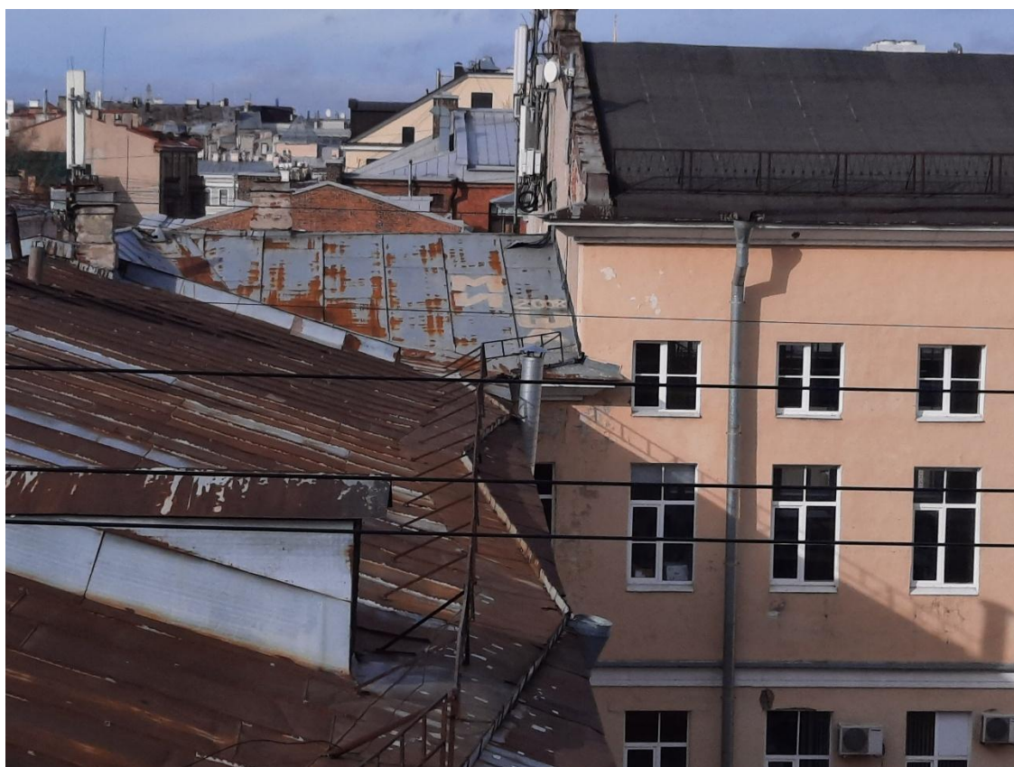
Фото 4. Общий вид кровли.
