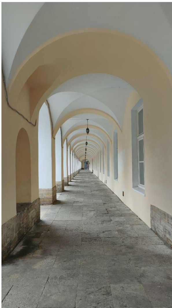
Фото 6. Вид вдоль фасада объекта культурного наследия федерального значения «Гостиный двор Новобиржевой» по адресу: Санкт-Петербург, Смольный проезд, д.1, по Тифлисскому переулку.
