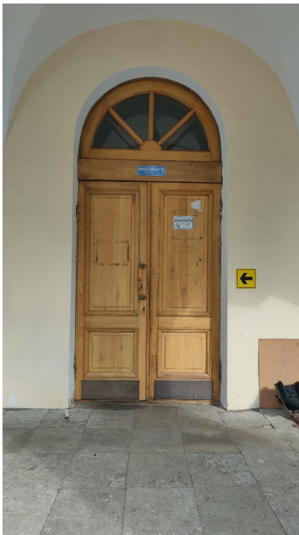
Фото 20. Вид на дверное заполнение объекта культурного наследия федерального значения «Гостиный двор Новобиржевой» по адресу: Санкт-Петербург, Смольный проезд, д.1, лит. Б со стороны Биржевого проезда.
