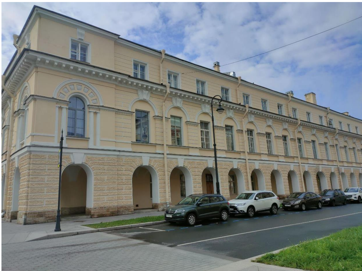
Фото 8. Вид на фрагмент фасад объекта культурного наследия федерального значения «Гостиный двор Новобиржевой» по адресу: Санкт-Петербург, Смольный проезд, д.1, лит. Б со стороны Тифлисского переулка.
