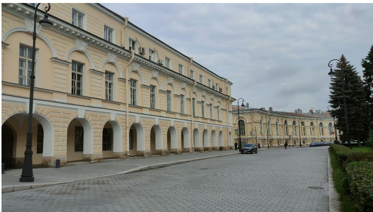
Фото 3. Вид на фасад объекта культурного наследия федерального значения «Гостиный двор Новобиржевой» по адресу: Санкт-Петербург, Смольный проезд, д.1, лит. Б со стороны Тифлисского переулка.
