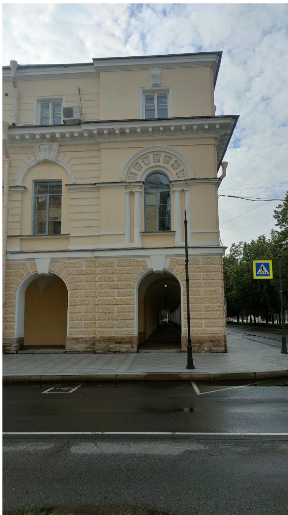
Фото 11. Вид на фрагмент фасад объекта культурного наследия федерального значения «Гостиный двор Новобиржевой» по адресу: Санкт-Петербург, Смольный проезд, д.1, лит. Б со стороны Тифлисского переулка.
