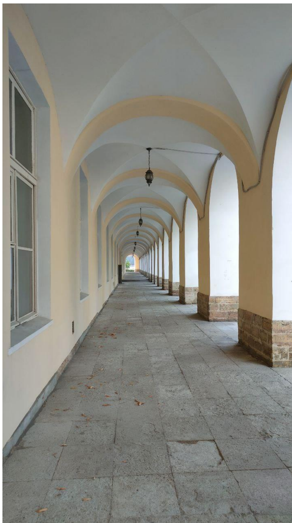
Фото 15. Вид вдоль фасада объекта культурного наследия федерального значения «Гостиный двор Новобиржевой» по адресу: Санкт-Петербург, Смольный проезд, д.1, по Менделеевской линии.
