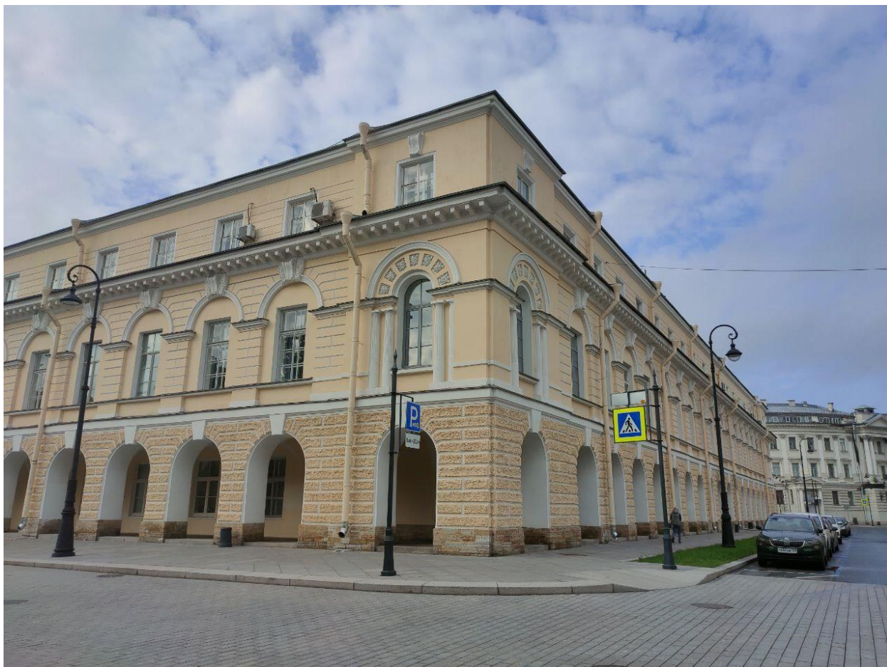
Фото 5. Вид на фасад объекта культурного наследия федерального значения «Гостиный двор Новобиржевой» по адресу: Санкт-Петербург, Смольный проезд, д.1, лит. Б со стороны угла Тифлисского переулка и Тифлисской улицы.
