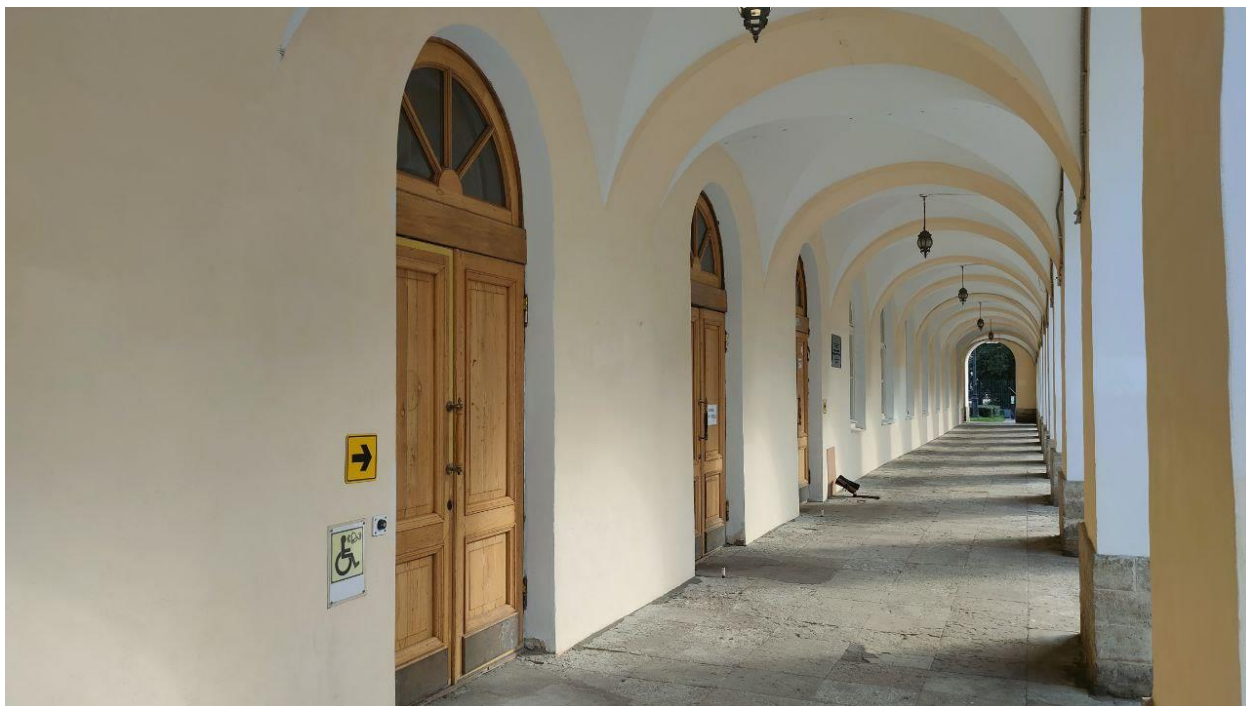
Фото 19. Вид на входную группу на фасаде объекта культурного наследия федерального значения «Гостиный двор Новобиржевой» по адресу: Санкт-Петербург, Смольный проезд, д.1, лит. Б со стороны Биржевого проезда.
