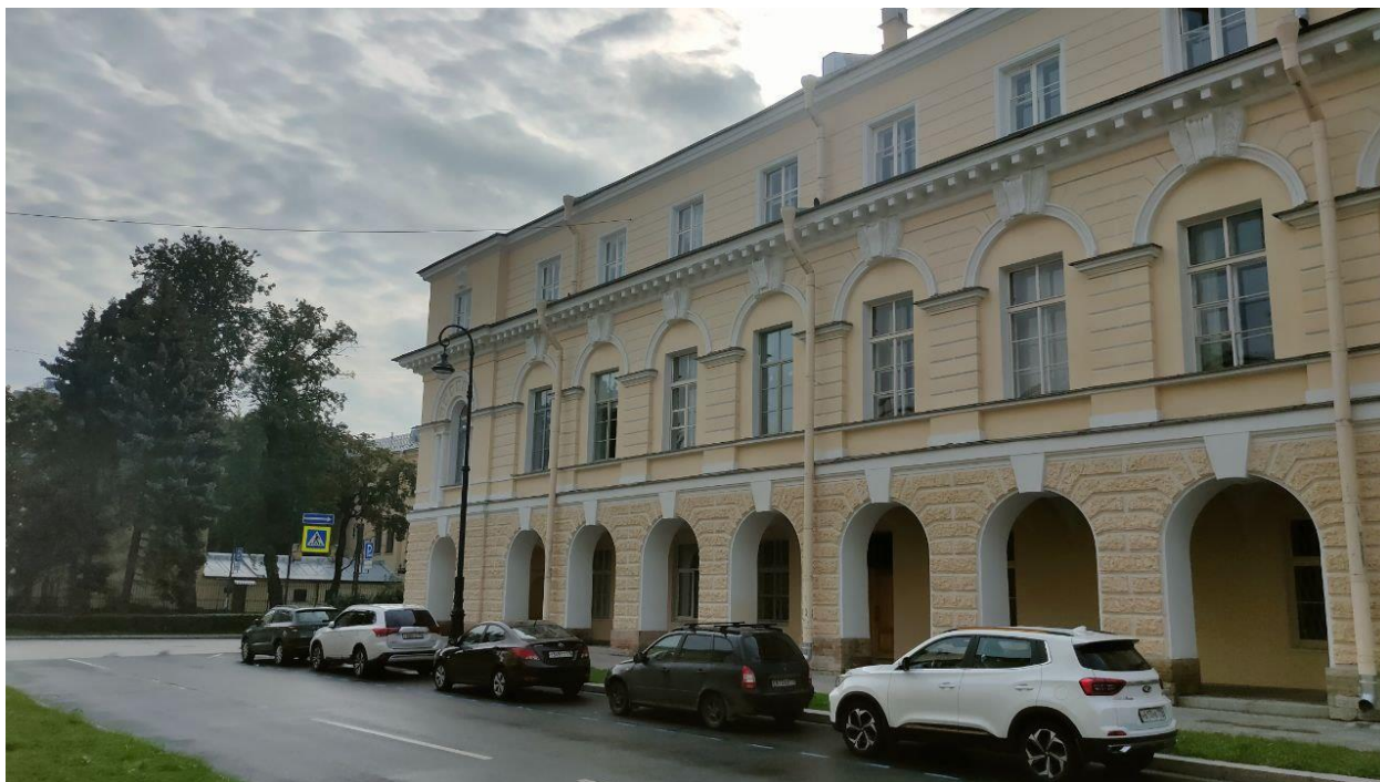
Фото 10. Вид на фрагмент фасада объекта культурного наследия федерального значения «Гостиный двор Новобиржевой» по адресу: Санкт-Петербург, Смольный проезд, д.1, лит. Б со стороны Тифлисского переулка.
