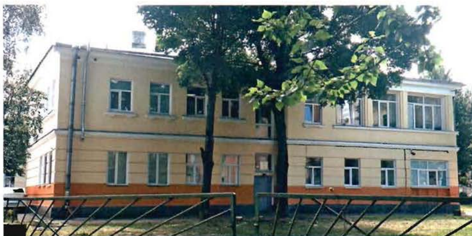
4. Общий вид дворовых фасадов.
