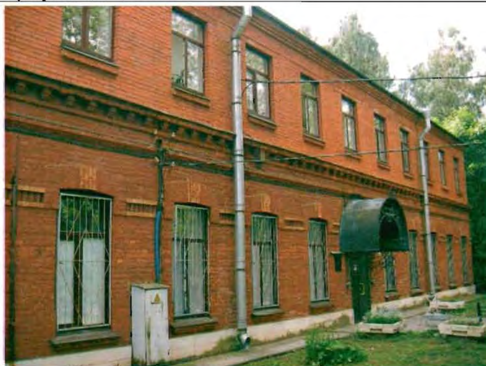
Фото 78. Западный фасад. Общий вид.
