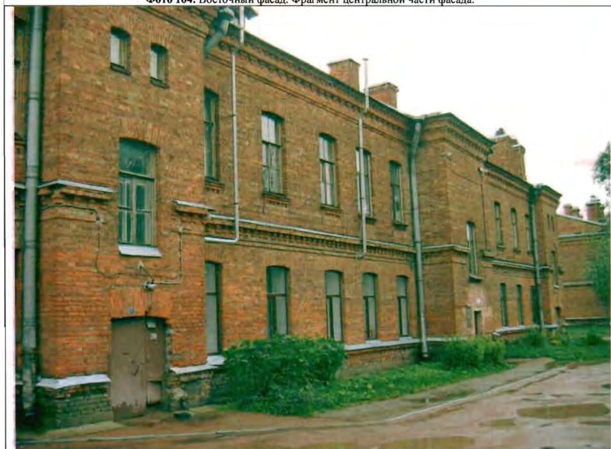
Фото 165. Западный фасад. Общий вид.
