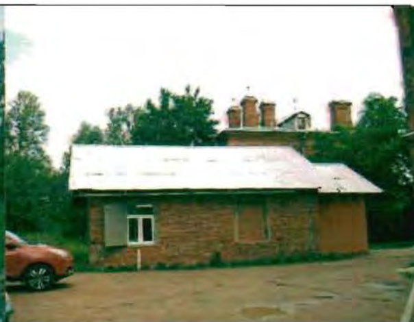
Фото 154. Южный фасад. Общий вид.
