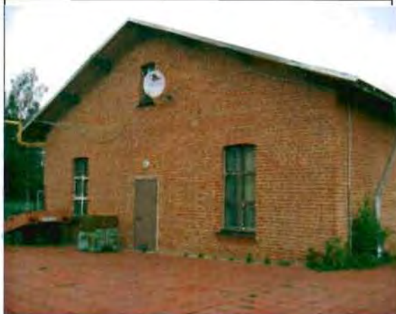
Фото 21. Южный фасад. Общий вид.
