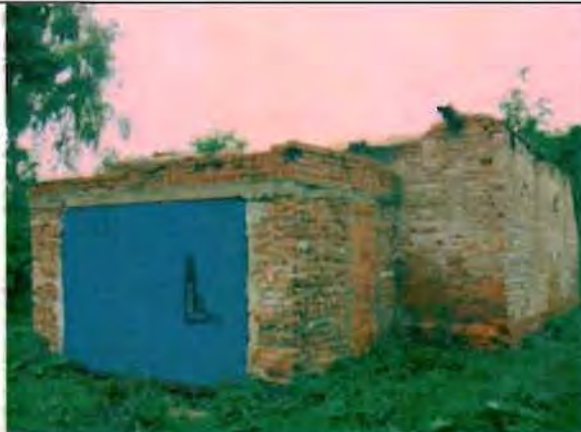
Фото 185. Восточный фасад. Общий вид.
