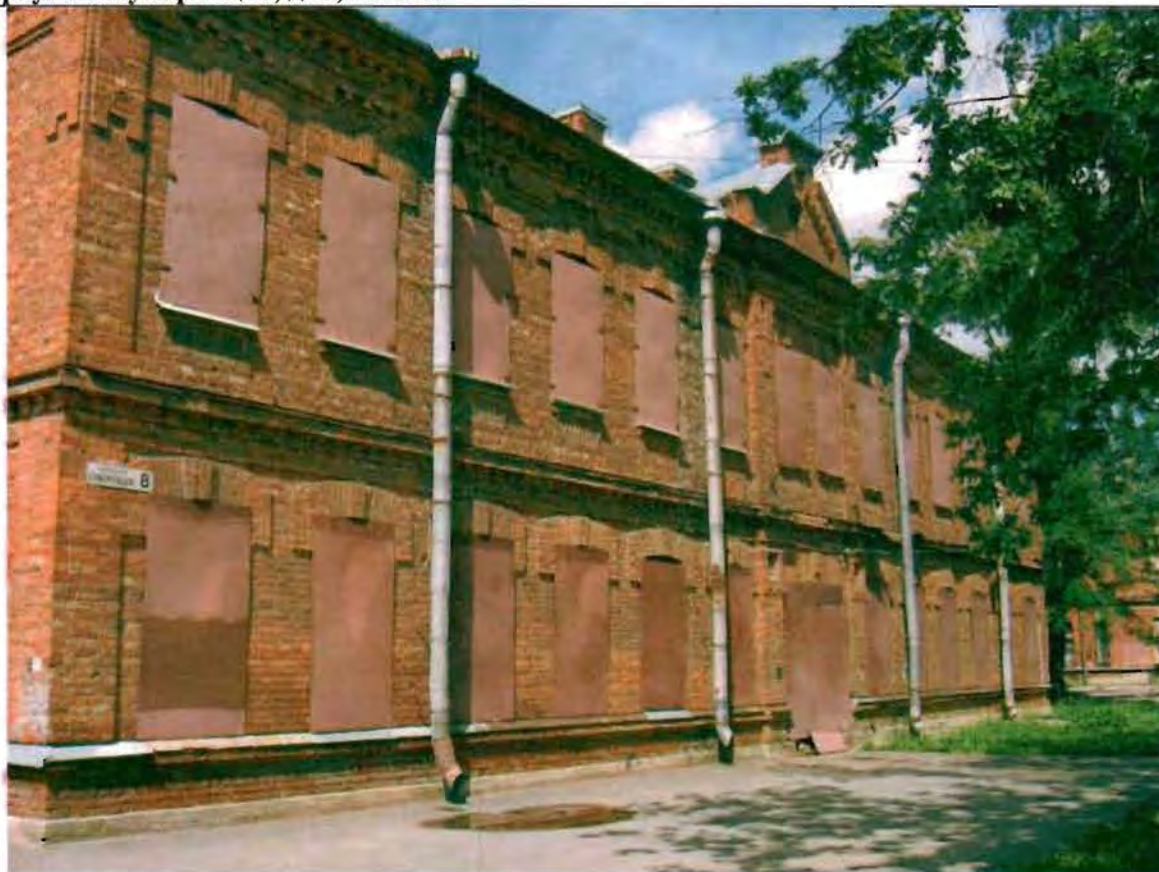
Фото 116. Восточный фасад. Общий вид.
