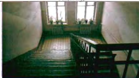
Фото 34. Интерьер. Лестница. Общий вид.
