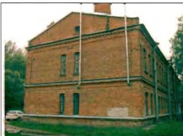
Фото 166. Южный фасад. Общий вид.
