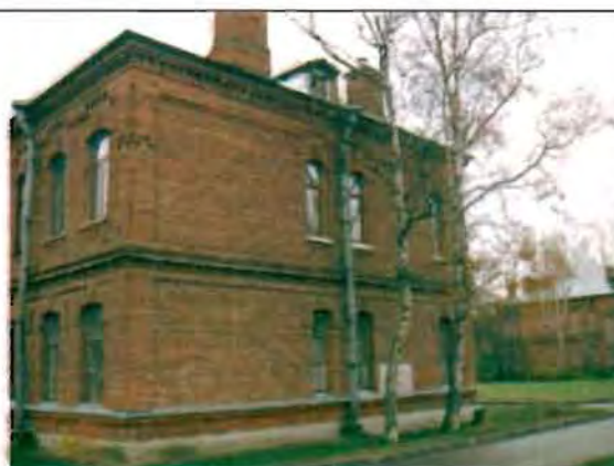
Фото 160. Северный фасад. Общий вид.
