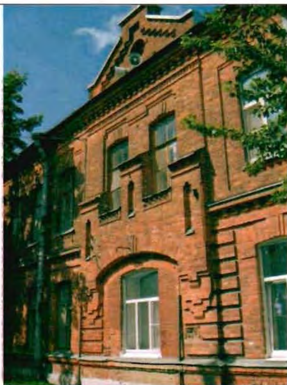
Фото 137. Восточный фасад. Фрагмент.
