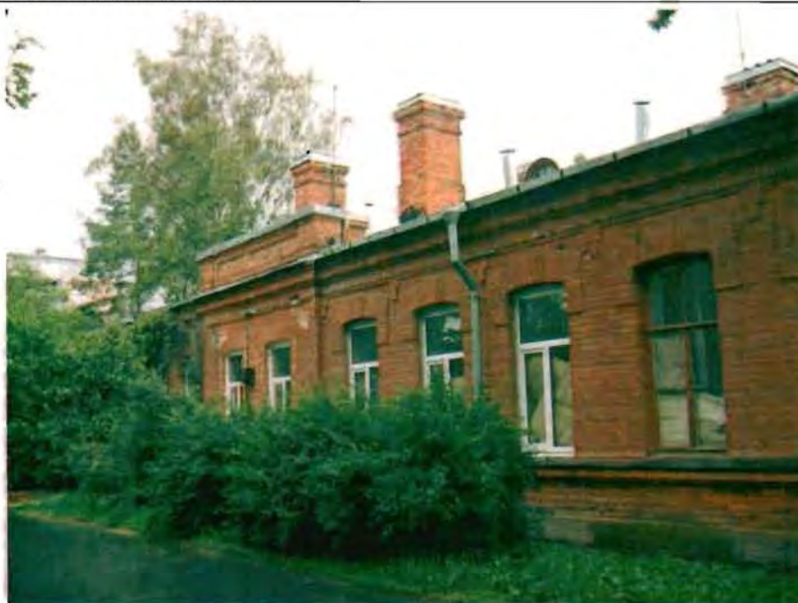
Фото 188. Восточный фасад. Фрагмент.
