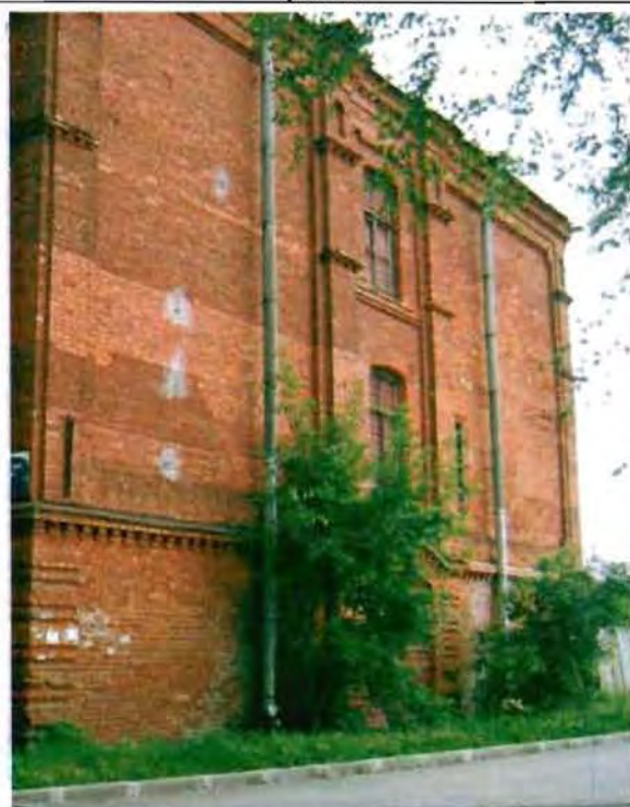
Фото 5. Южный фасад. Общий вид.
