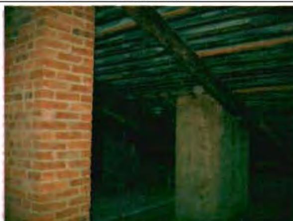
Фото 152. Конструкции крыши. Фрагмент.
