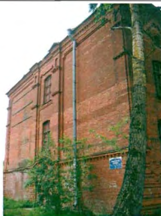
Фото 6. Северный фасад. Общий вид.
