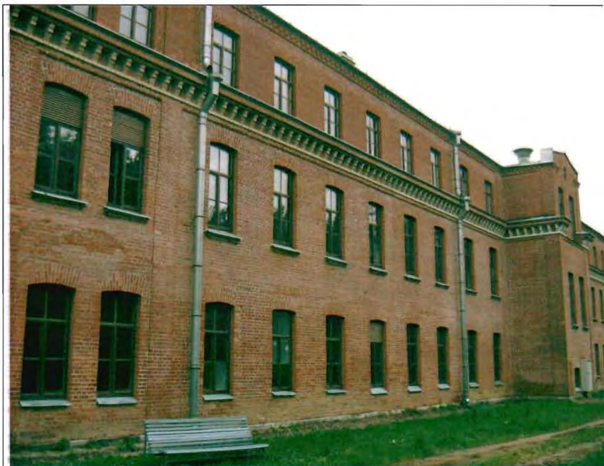
Фото 66. Южный фасад. Общий вид. 05.07.2016.
