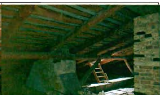
Фото 63. Конструкции крыши. Общий вид.
