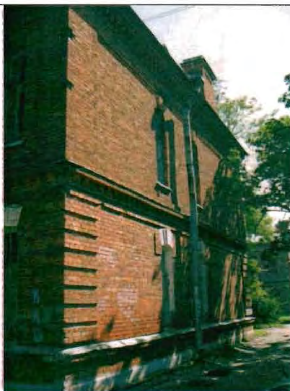
Фото 138. Южный фасад. Общий вид.
