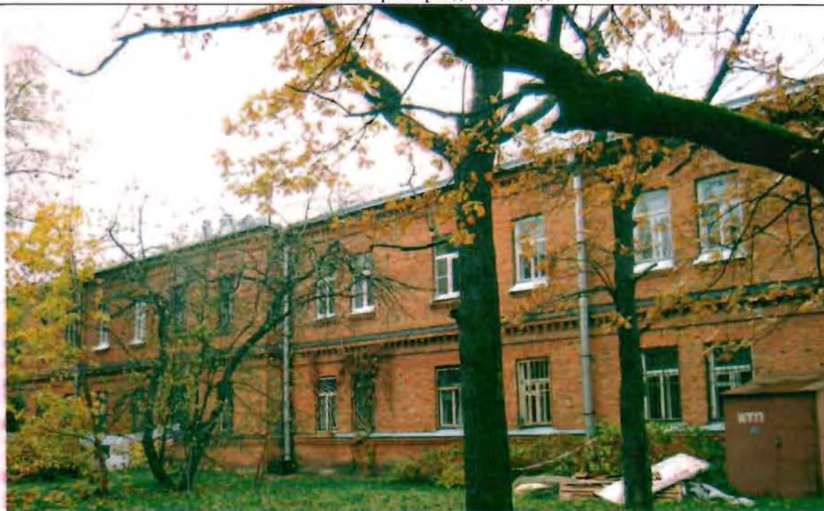
Фото 84. Южный фасад. Общий вид.
