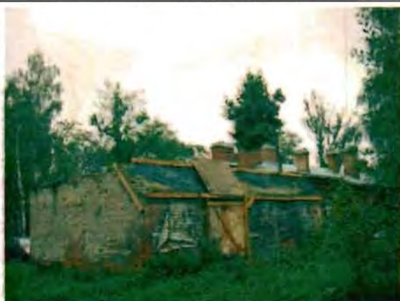
Фото 186. Западный, северный фасады. Общий вид.
