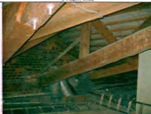
Фото 77. Конструкции крыши. Общий вид.
