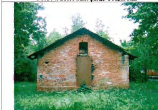
Фото 96. Западный фасад. Общий вид.
