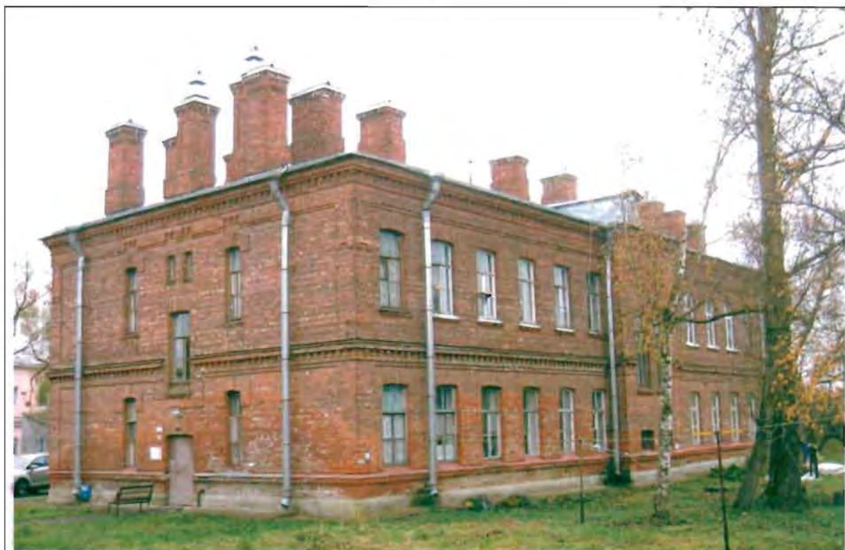
Фото 129. Западный, северный фасады. Общий вид.
