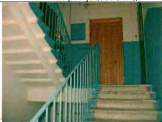
Фото 161. Лестница № 1 в южной части здания. Фрагмент.
