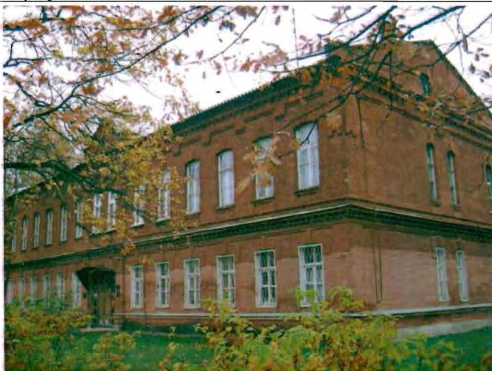
Фото 89. Западный, южный фасады. Общий вид.
