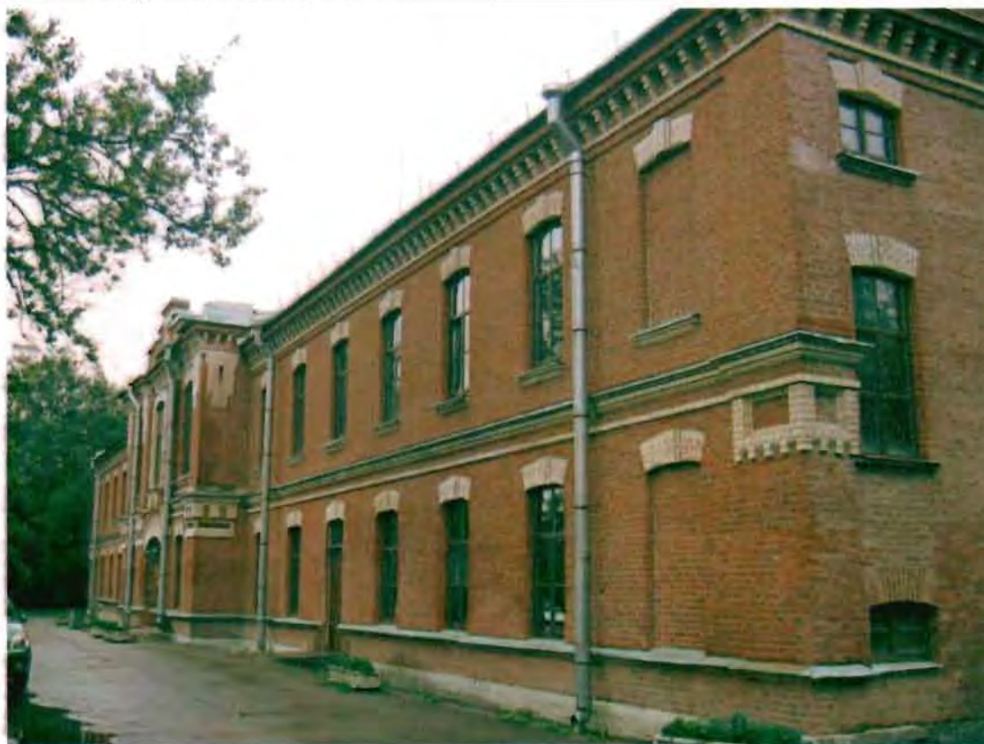
Фото 64. Северный фасад. Общий вид.
