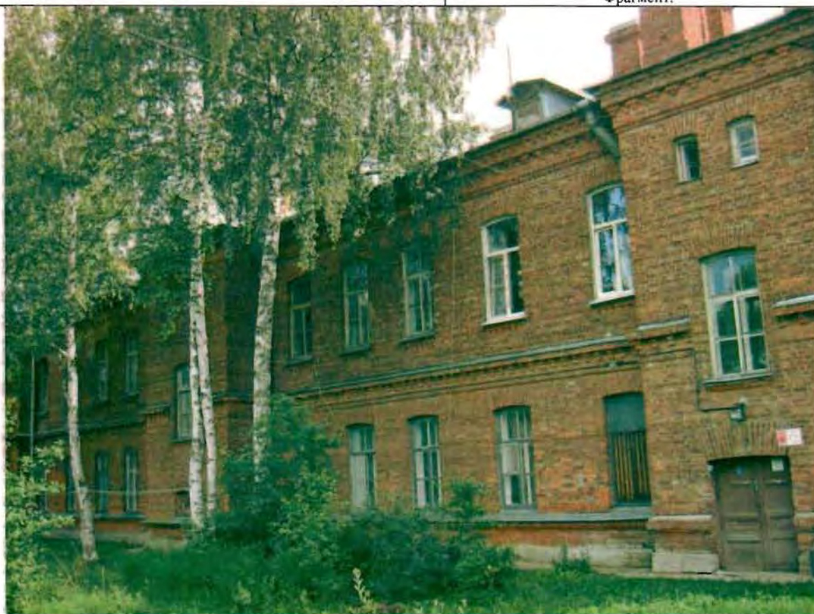
Фото 179. Западный фасад. Общий вид.
