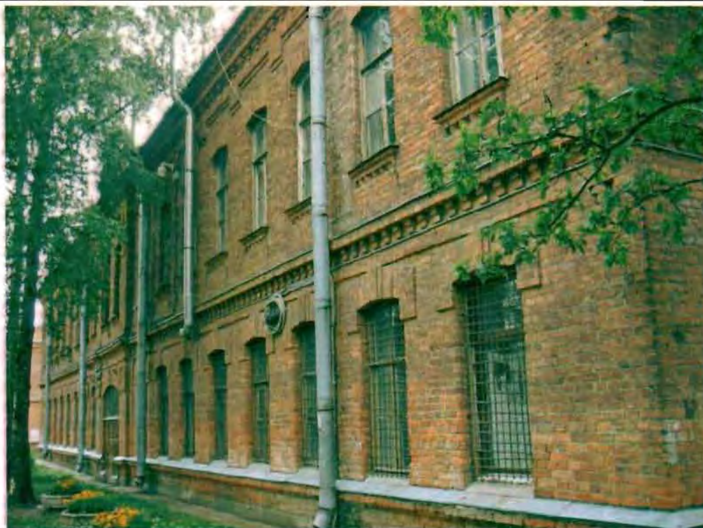
Фото 163. Восточный фасад. Общий вид.
