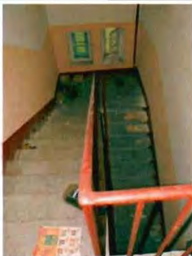
Фото 124. Лестница в южной части здания. Общий вид.
