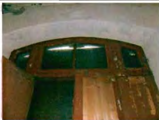
Фото 126. Дверное заполнение центральной части лестницы. Фрагмент.
