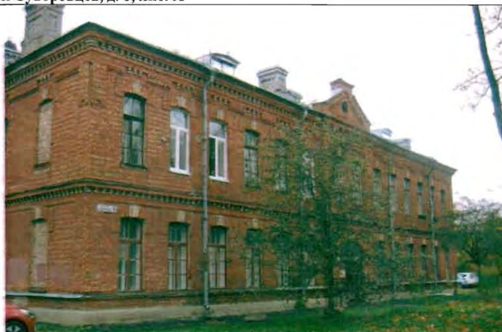
Фото 103. Восточный фасад. Общий вид.
