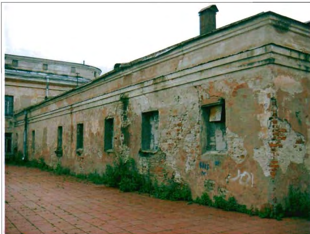
Фото 25. Восточный фасад. Общий вид.
