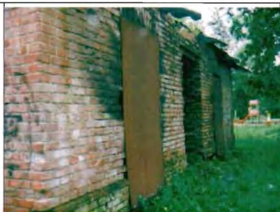
Фото 95. Северный фасад. Общий вид.
