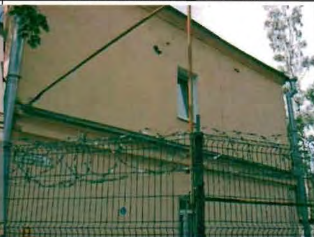
Фото 113. Северный фасад. Общий вид.
