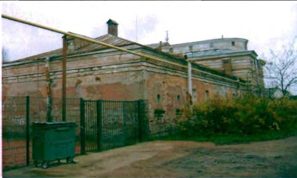
Фото 24. Западный, северный фасады. Общий вид.
