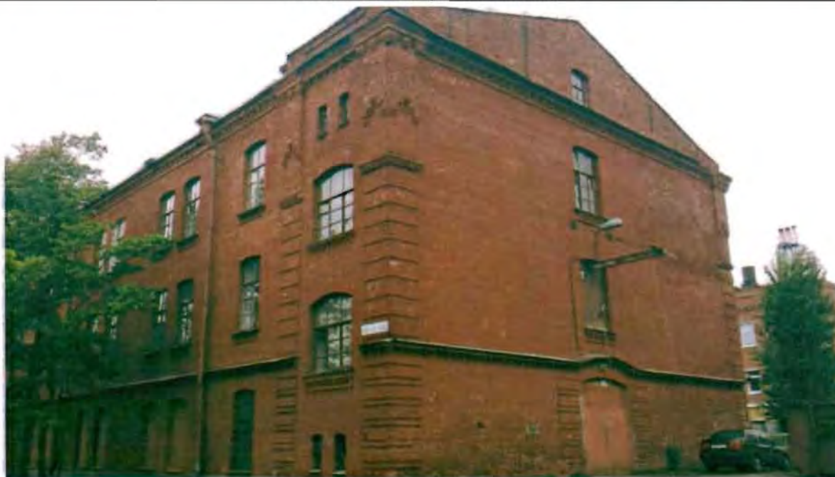
Фото 30. Северный фасад. Общий вид.
