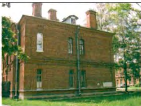
Фото 159. Северный фасад. Общий вид.
