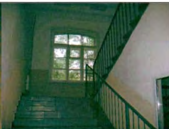
Фото 59. Интерьер. Лестница в северной части здания. Фрагмент.
