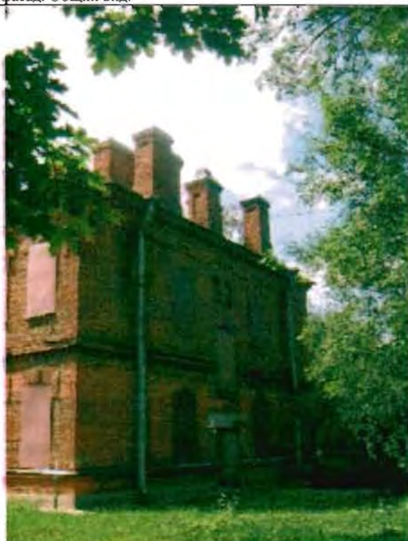
Фото 118. Северный фасад. Общий вид.
