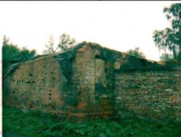
Фото 187. Северный фасад. Общий вид.
