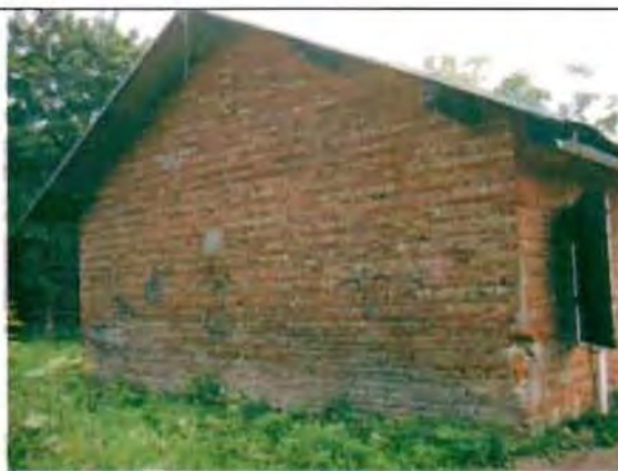
Фото 155. Северный фасад. Общий вид.
