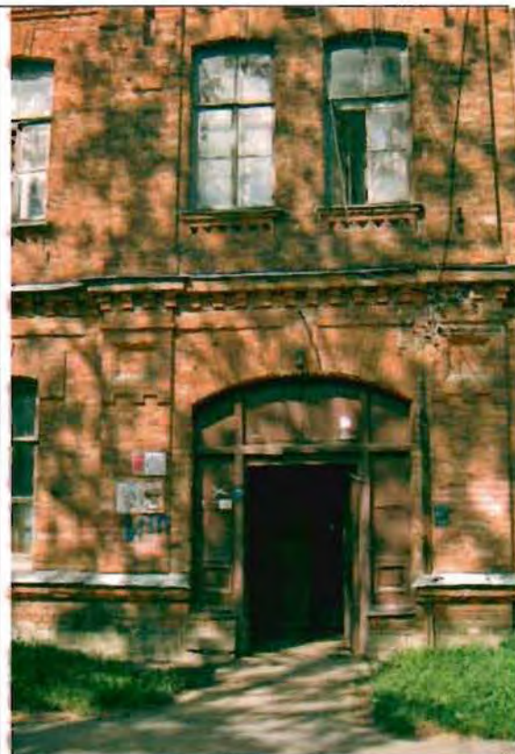
Фото 178. Восточный фасад. Центральная часть. Фрагмент.
