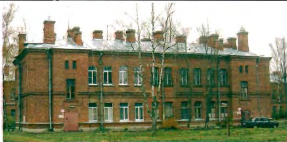
Фото 158. Восточный фасад. Общий вид.
