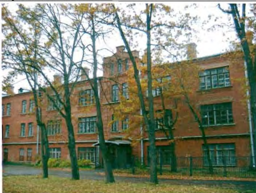
Фото 47. Восточный фасад. Общий вид.
