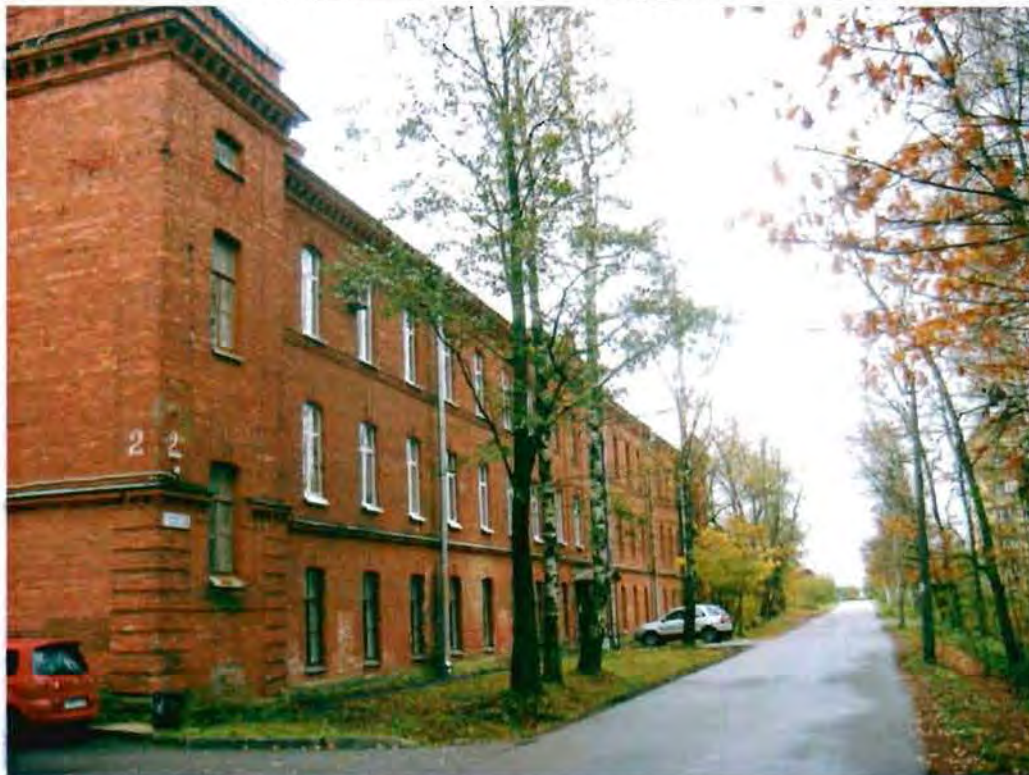
Фото 13. Западный фасад. Общий вид.
