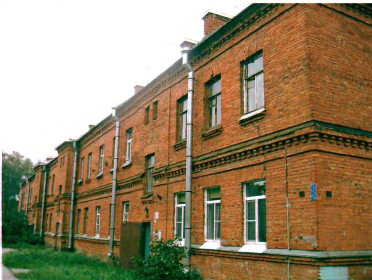
Фото 83. Северный фасад. Общий вид.
