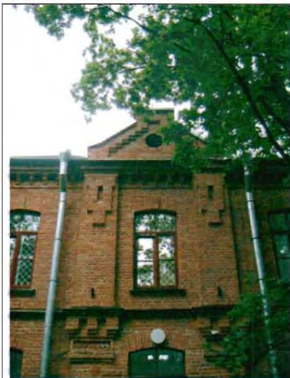
Фото 40. Восточный фасад. Фрагмент центральной части фасада.
