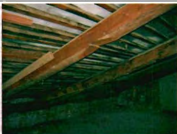
Фото 151. Конструкции крыши. Фрагмент.
