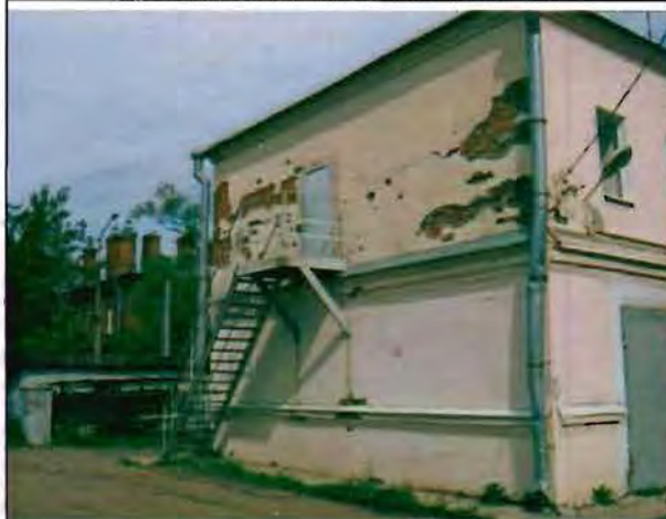
Фото 112. Южный фасад. Общий вид.
