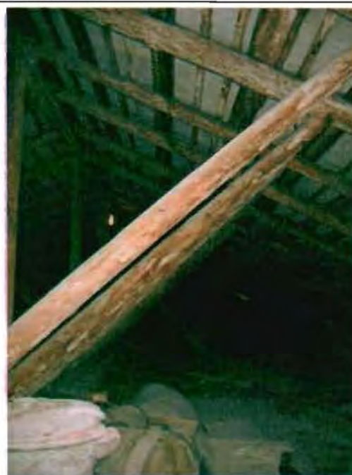
Фото 27. Конструкции крыши. Фрагмент.
