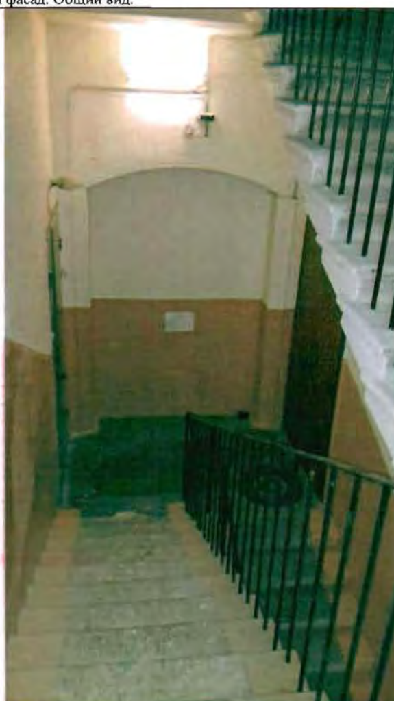
Фото 173. Лестница № 1 в северной части здания. Фрагмент.
