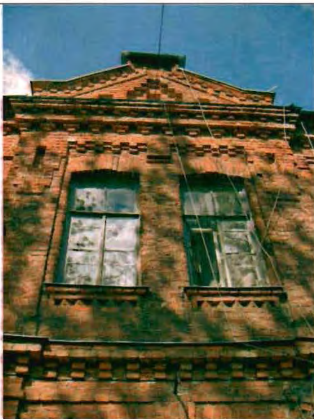
Фото 177. Восточный фасад. Центральная часть. Фрагмент.
