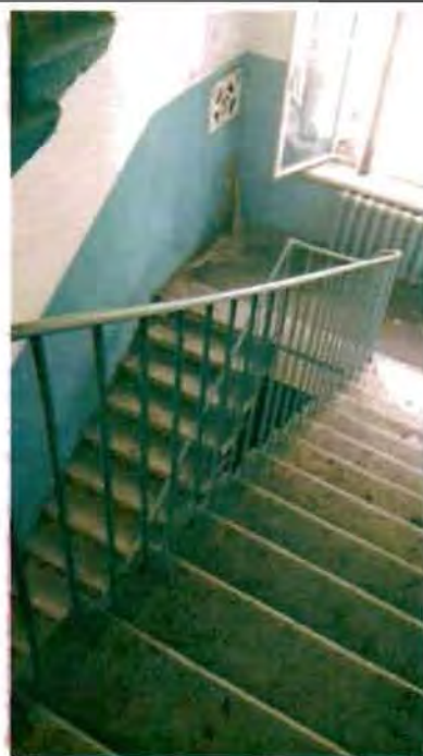
Фото 144. Лестница № 2 в южной части здания. Общий вид.
