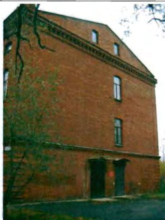
Фото 16. Южный фасад. Общий вид.
