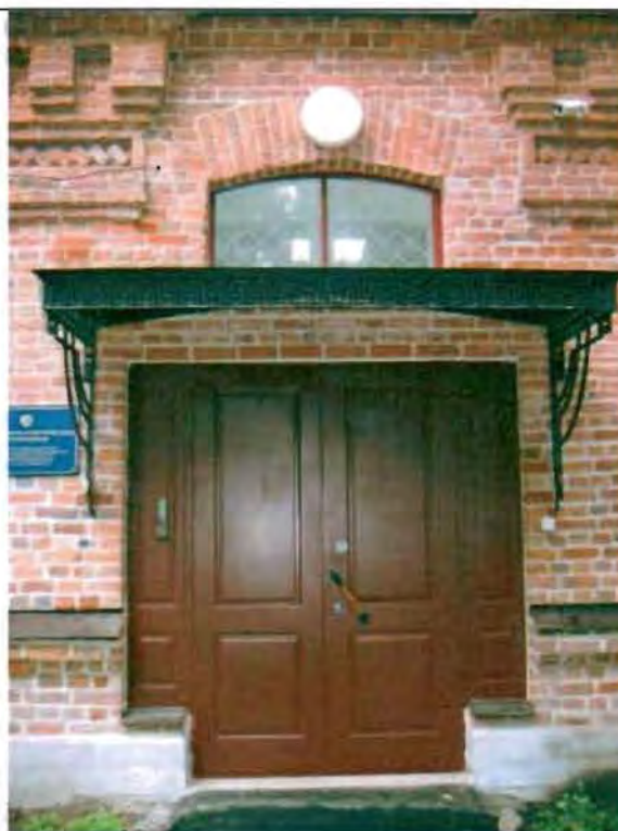
Фото 41. Дверной проем восточного фасада. Общий вид.
