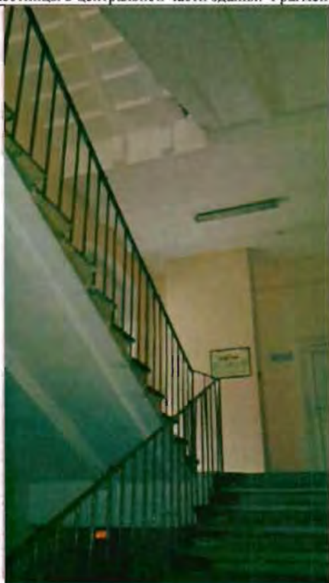
Фото 60. Интерьер. Лестница в южной части здания. Фрагмент.
