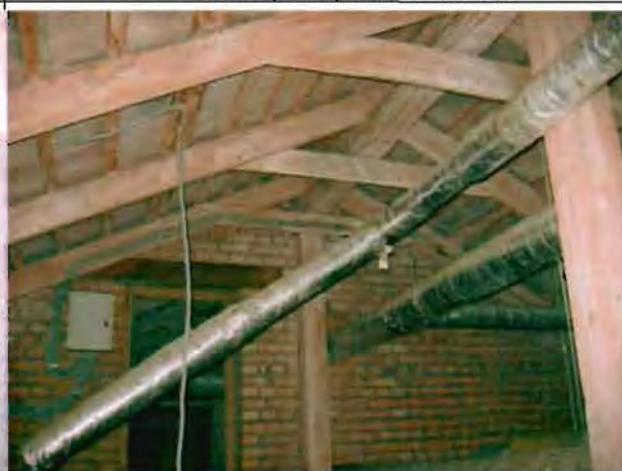
Фото 115. Конструкции крыши. Фрагмент.
