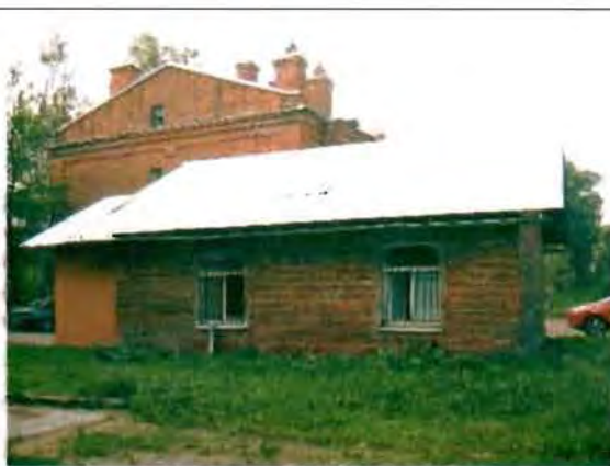
Фото 156. Западный фасад. Общий вид.
