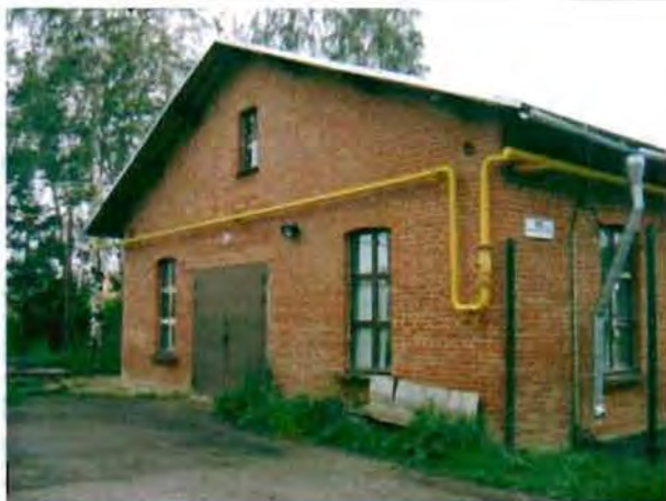
Фото 20. Северный фасад. Общий вид.
