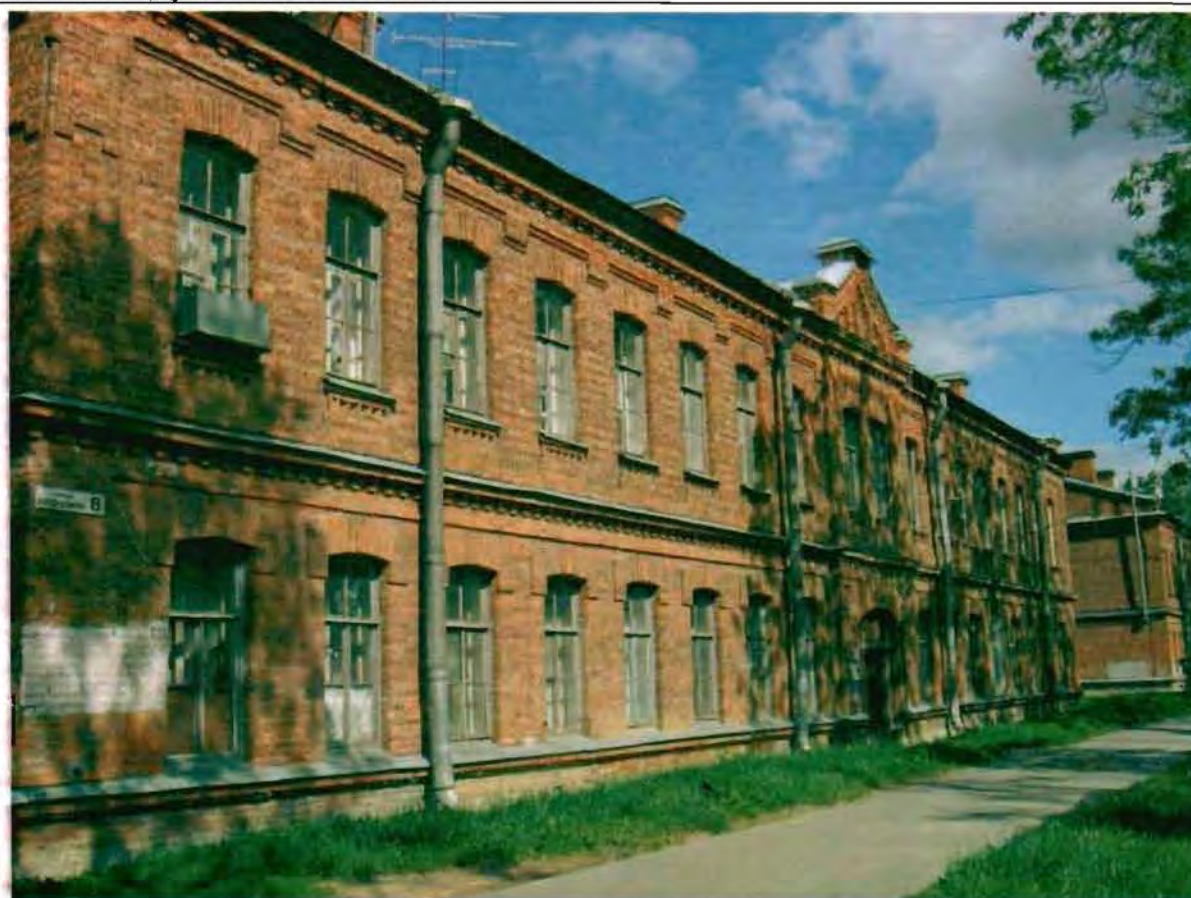
Фото 176. Восточный фасад. Общий вид.
