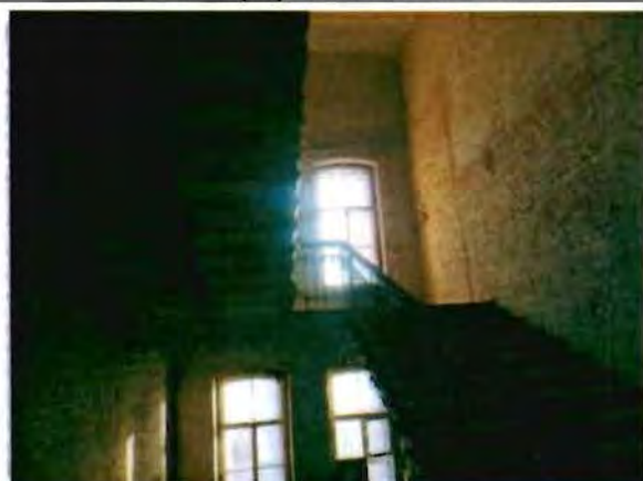
Фото 11. Интерьер. Лестница. Общий вид. 29.12.2015.
