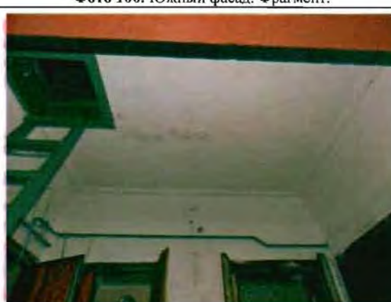
Фото 102. Отделка потолка тамбура. Общий вид.
