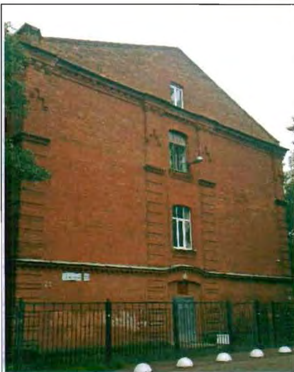
Фото 49. Северный фасад. Общий вид.
