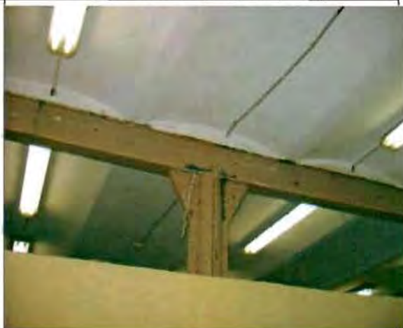
Фото 23. Интерьер. Металлические клепанные колонны и балки. Фрагмент.
