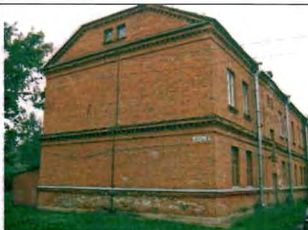
Фото 85. Восточный фасад. Общий вид.
