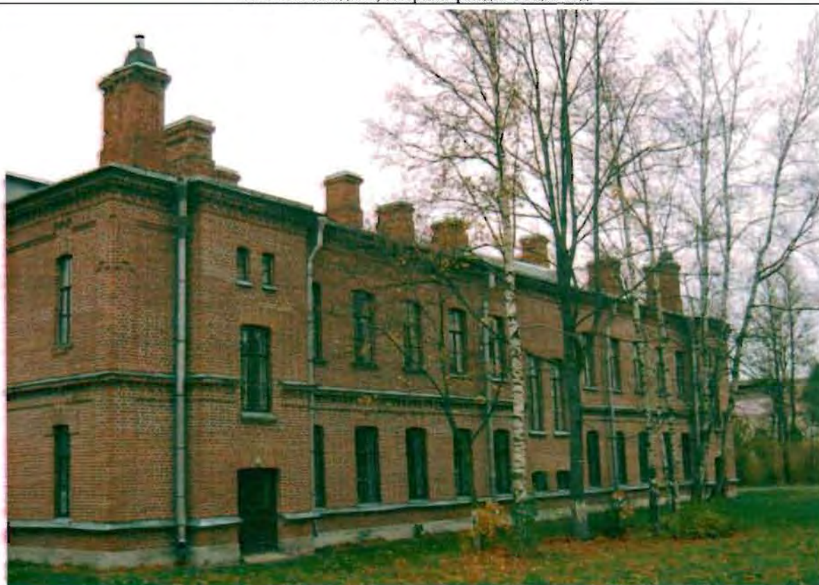
Фото 133. Восточный фасад. Общий вид.
