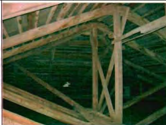
Фото 82. Конструкции крыши. Общий вид.
