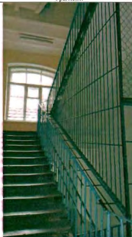
Фото 61. Интерьер. Лестница в южной части здания. Фрагмент.
