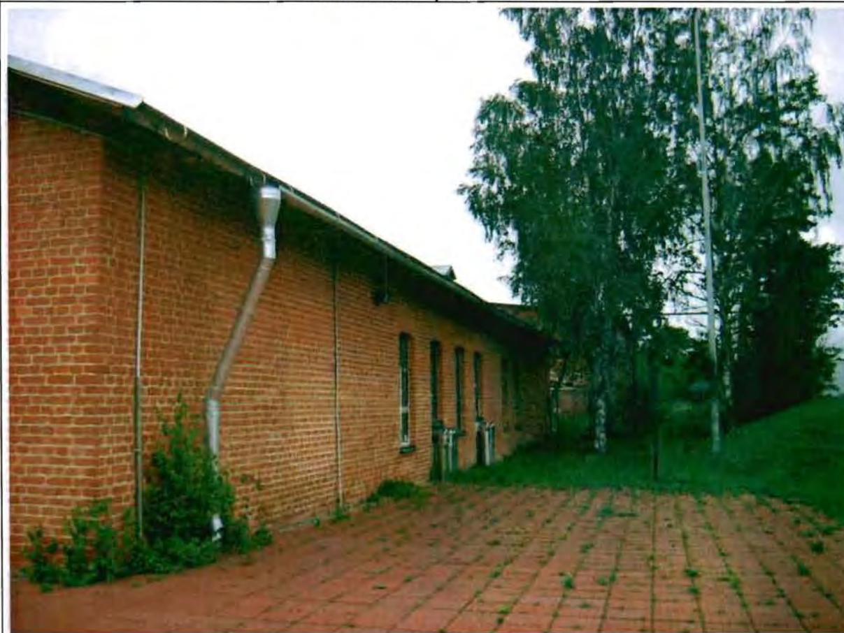
Фото 19. Восточный фасад. Общий вид.
