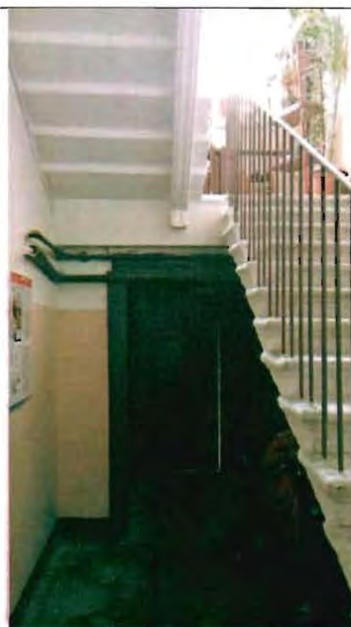
Фото 131. Лестница № 2 в северной части здания. Общий вид.
