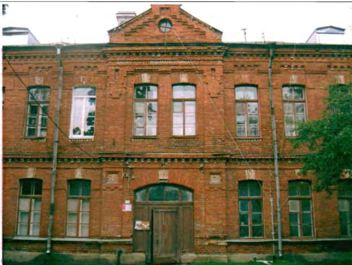
Фото 104. Восточный фасад. Центральная часть. Общий вид.
