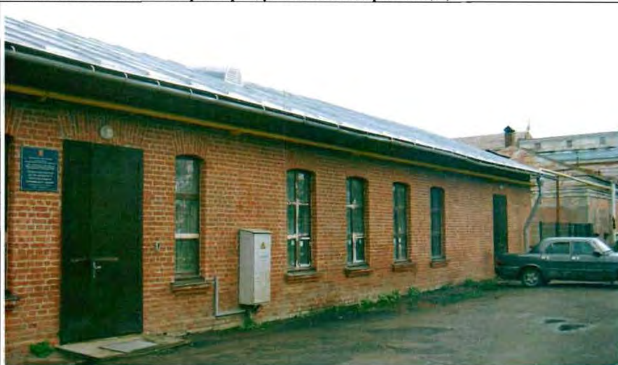
Фото 18. Западный фасад. Общий вид.
