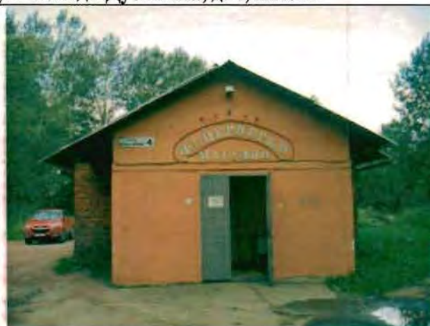
Фото 153. Восточный фасад. Общий вид.
