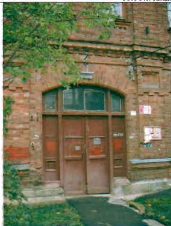
Фото 147. Дверной проем западного фасада. Общий вид.
