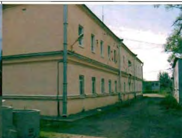
Фото 111. Западный фасад. Общий вид.
