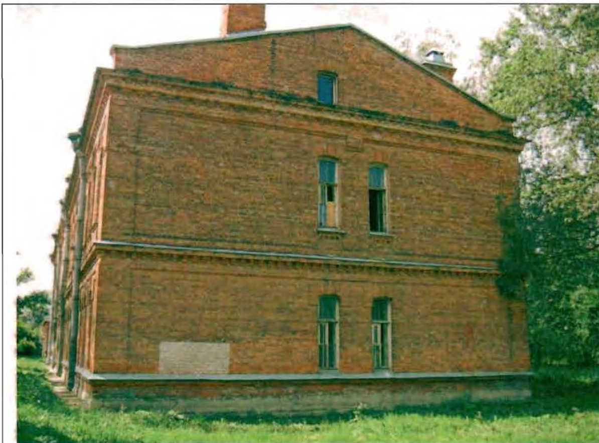
Фото 180. Северный фасад. Общий вид.
