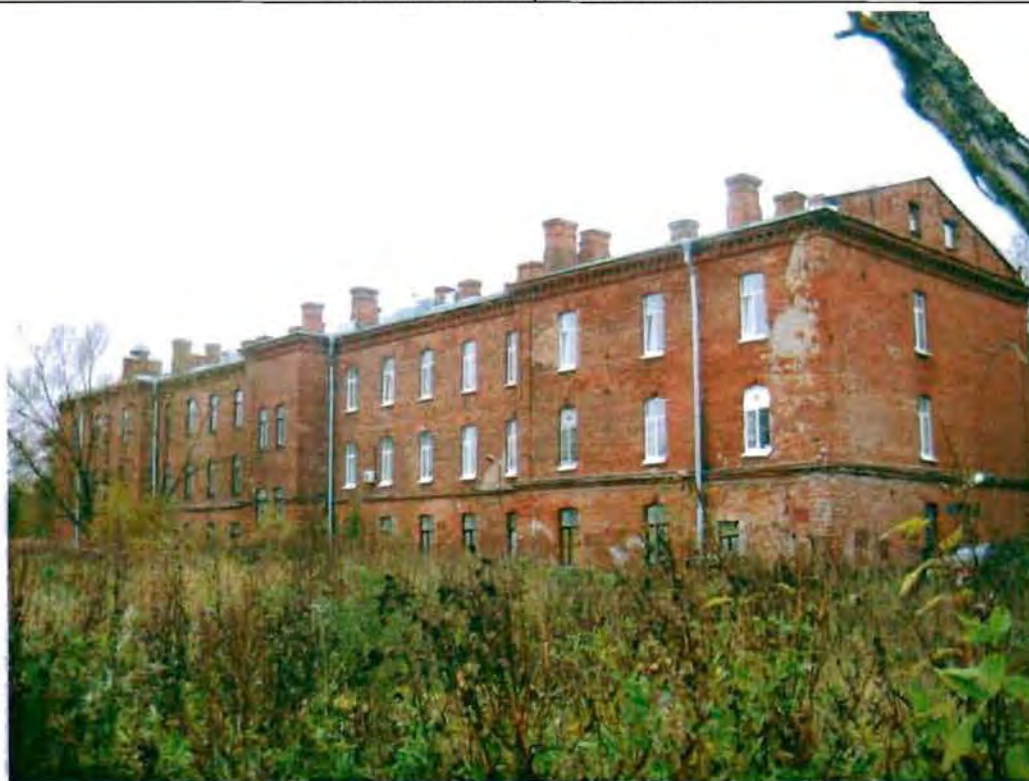
Фото 14. Восточный фасад. Общий вид.
