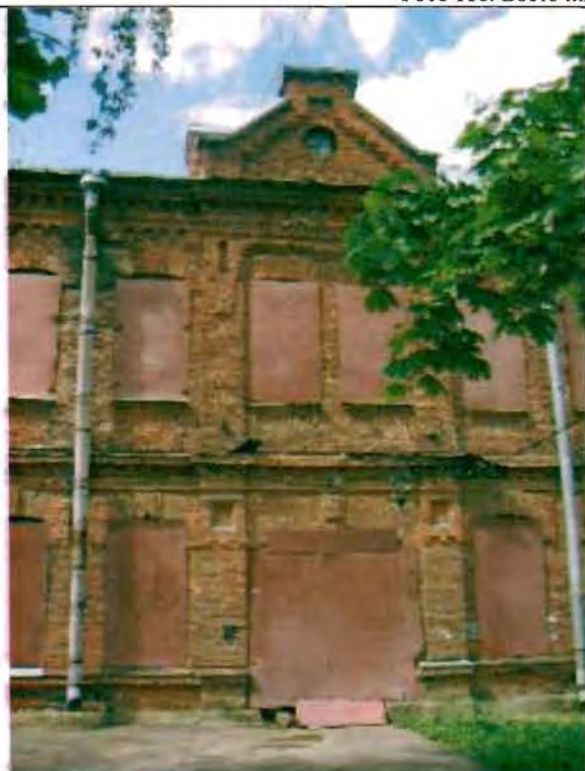
Фото 117. Восточный фасад. Фрагмент центральной части фасада.
