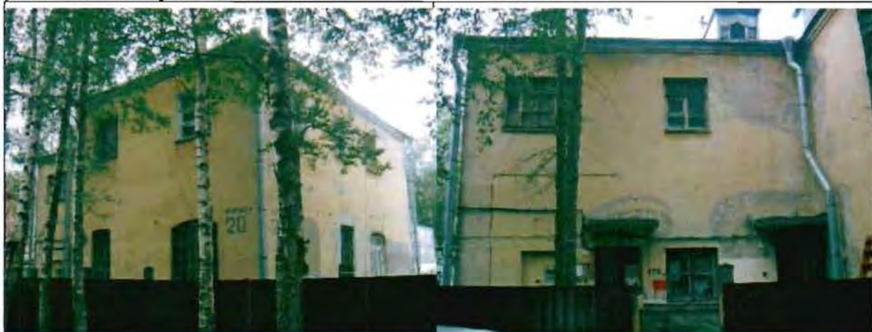
Фото 43. Северный, восточный фасады. Общий вид.
