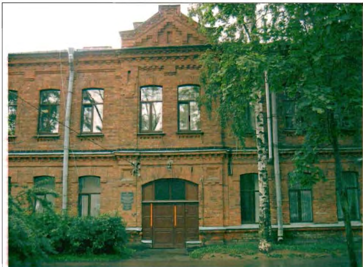
Фото 164. Восточный фасад. Фрагмент центральной части фасада.
