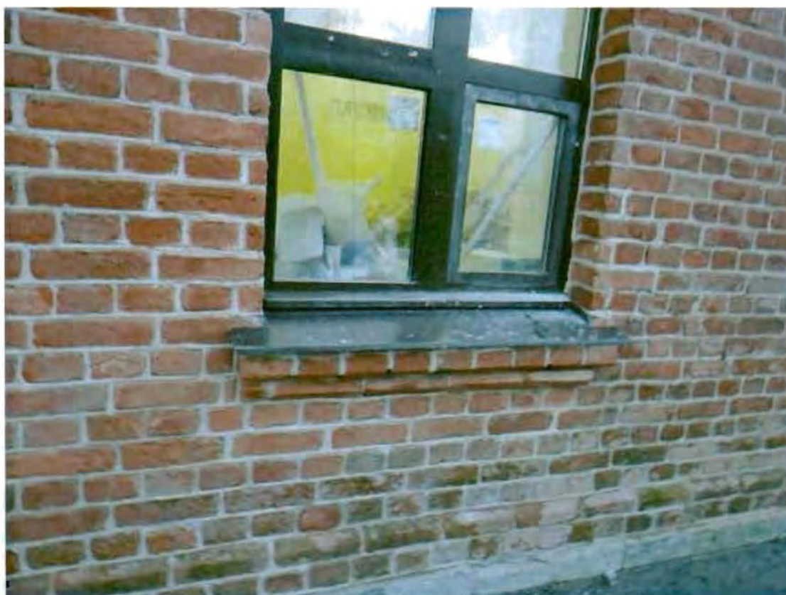
Ступенчатые подоконные доски. Съемка 20.11.2012, Воронина Н.В.
