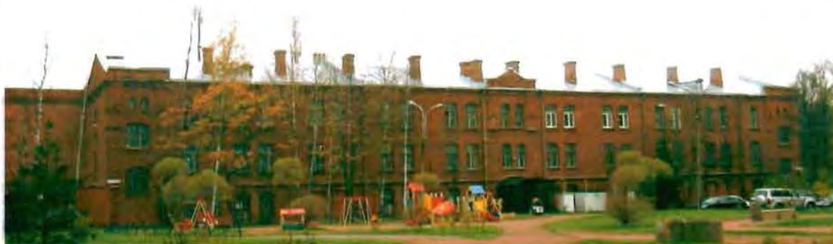
Фото 28. Восточный фасад. Общий вид.
