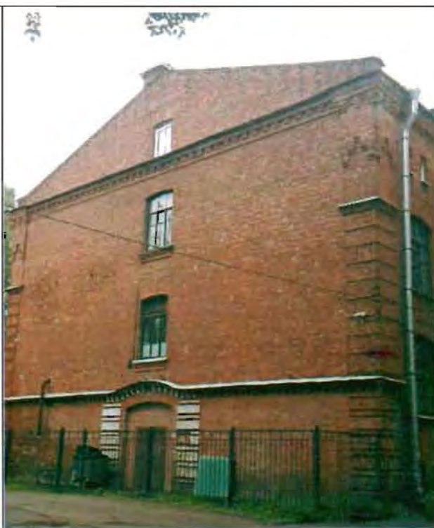
Фото 50. Южный фасад. Общий вид.
