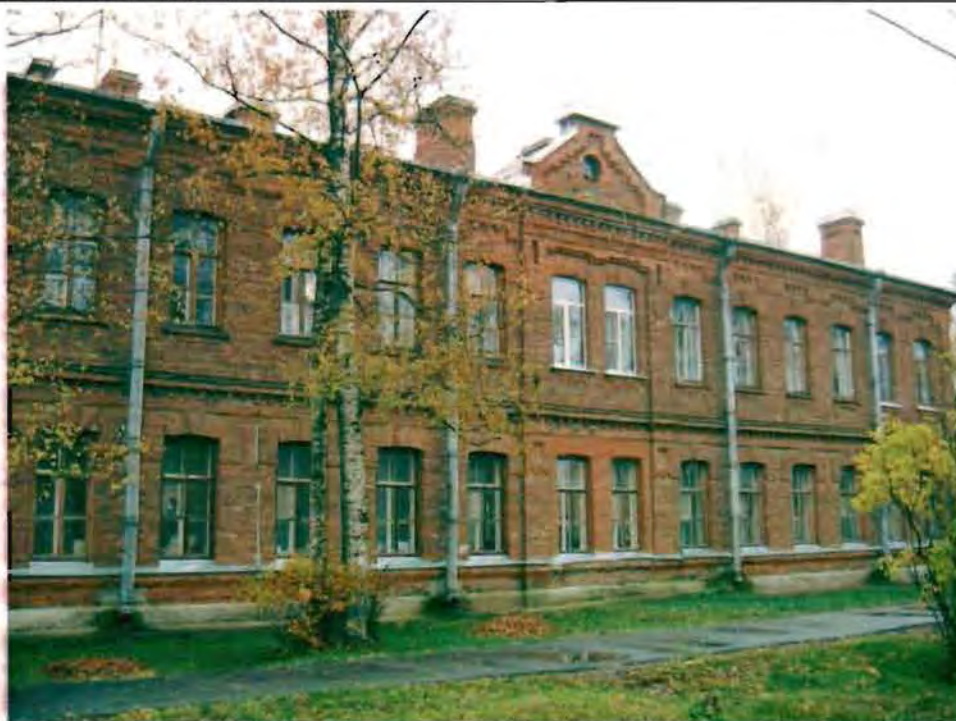
Фото 157. Западный фасад. Общий вид.
