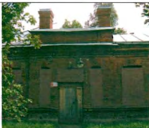
Фото 99. Западный фасад. Центральная часть. Общий вид.
