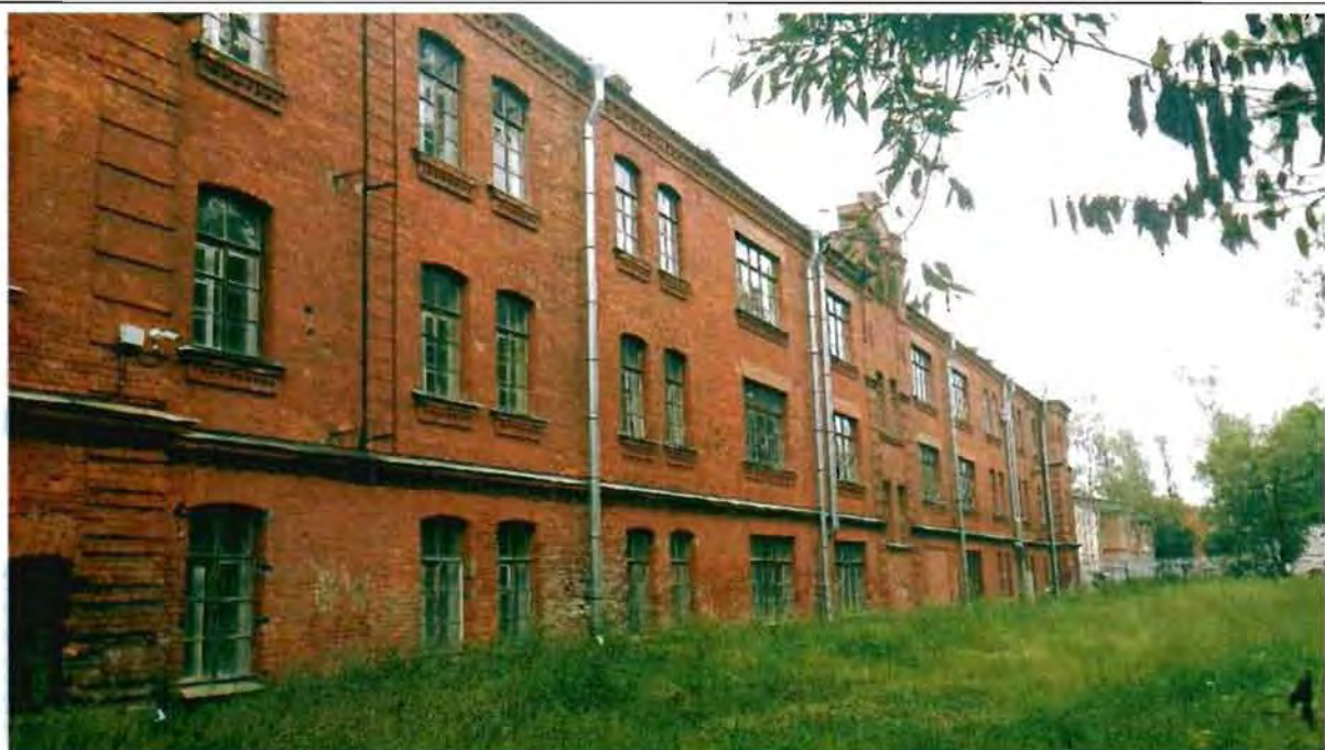
Фото 48. Западный фасад. Общий вид.
