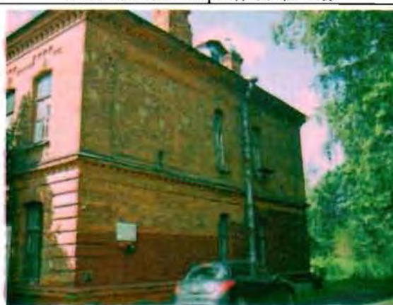
Фото 140. Северный фасад. Общий вид.
