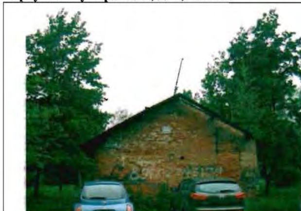
Фото 94. Восточный фасад. Общий вид.
