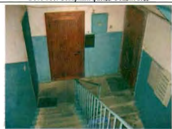
Фото 162. Лестница № 2 в северной части здания. Фрагмент.
