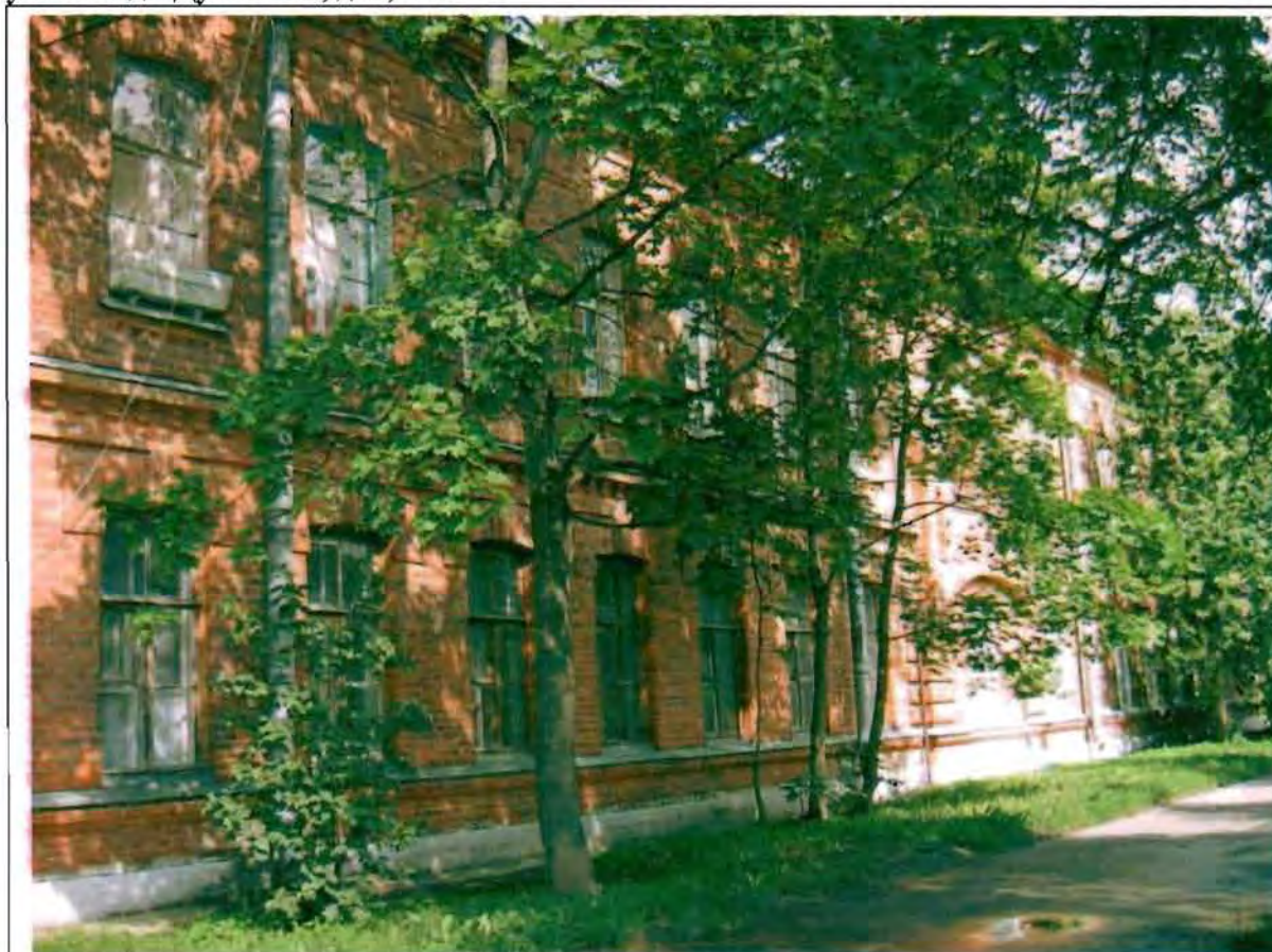
Фото 136. Восточный фасад. Общий вид.
