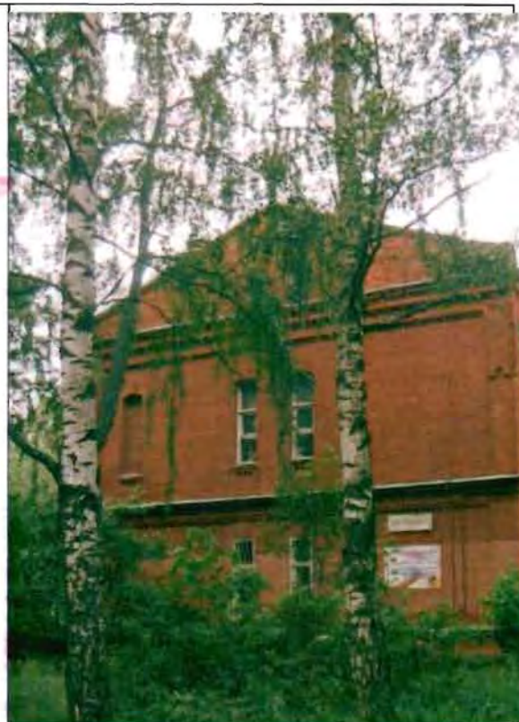
Фото 91. Северный фасад. Общий вид.
