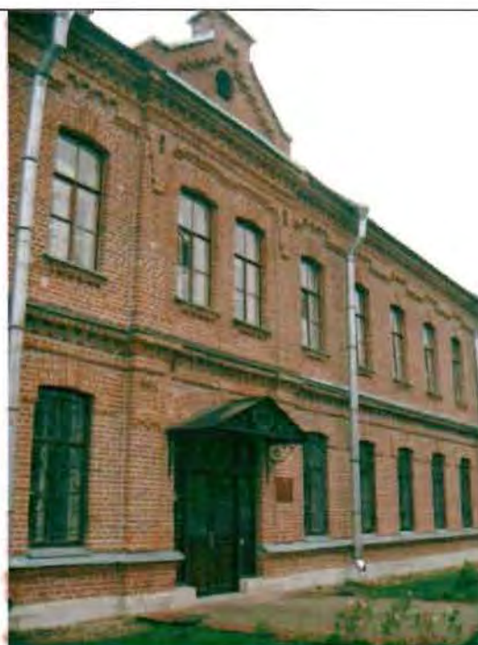
Фото 135. Западный фасад. Фрагмент центральной части фасада.
