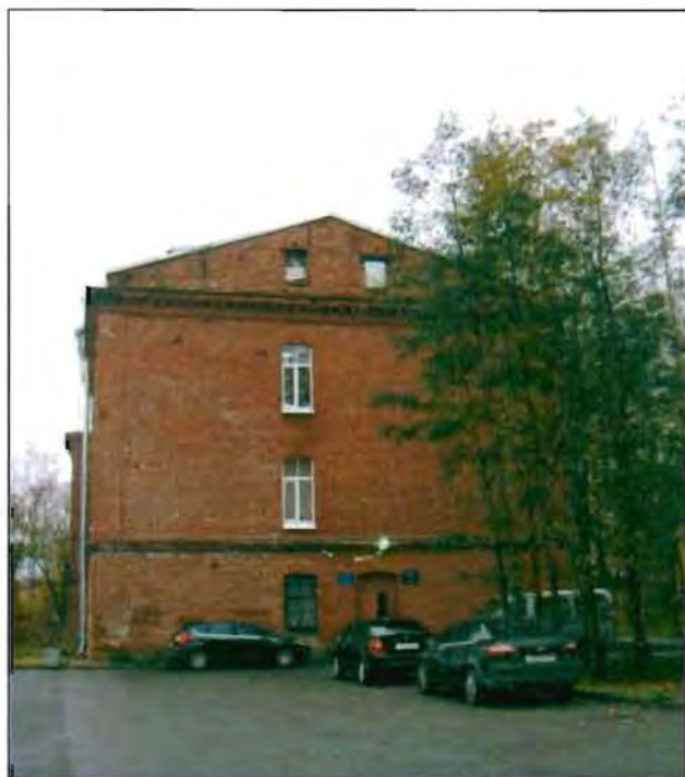
Фото 15. Северный фасад. Общий вид.
