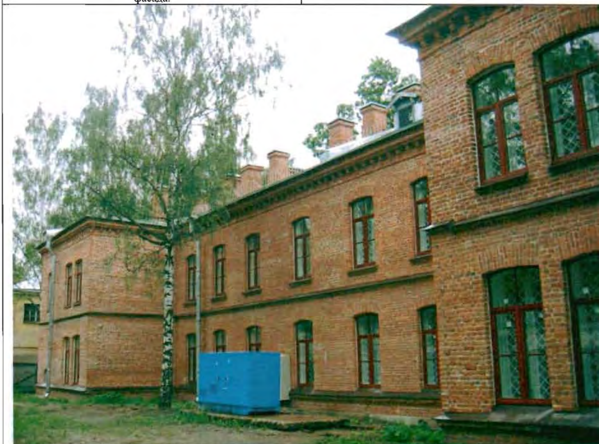
Фото 42. Западный фасад. Общий вид.
