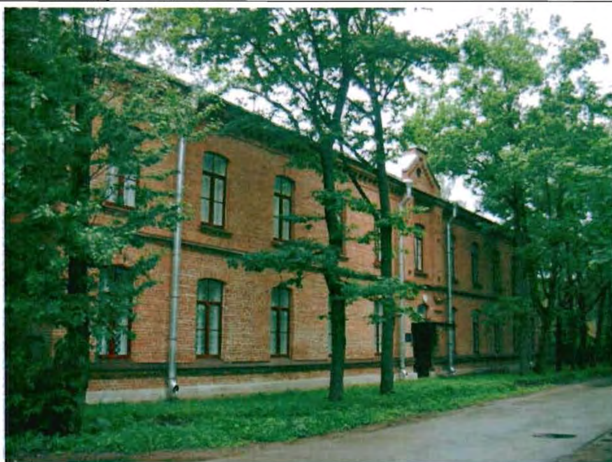
Фото 39. Восточный фасад. Общий вид.
