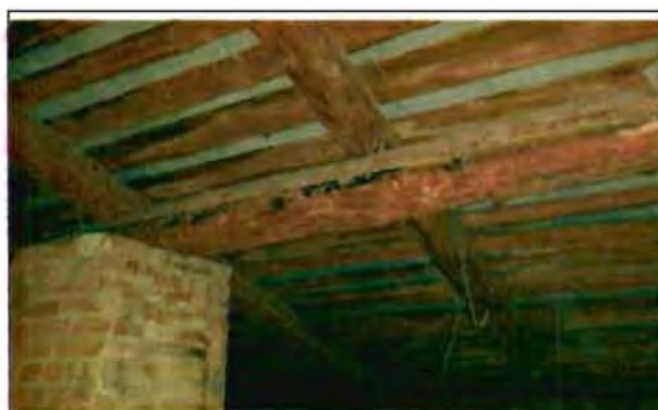
Фото 62. Конструкции крыши. Общий вид.
