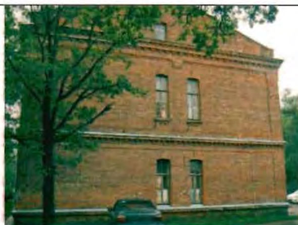
Фото 167. Северный фасад. Общий вид.
