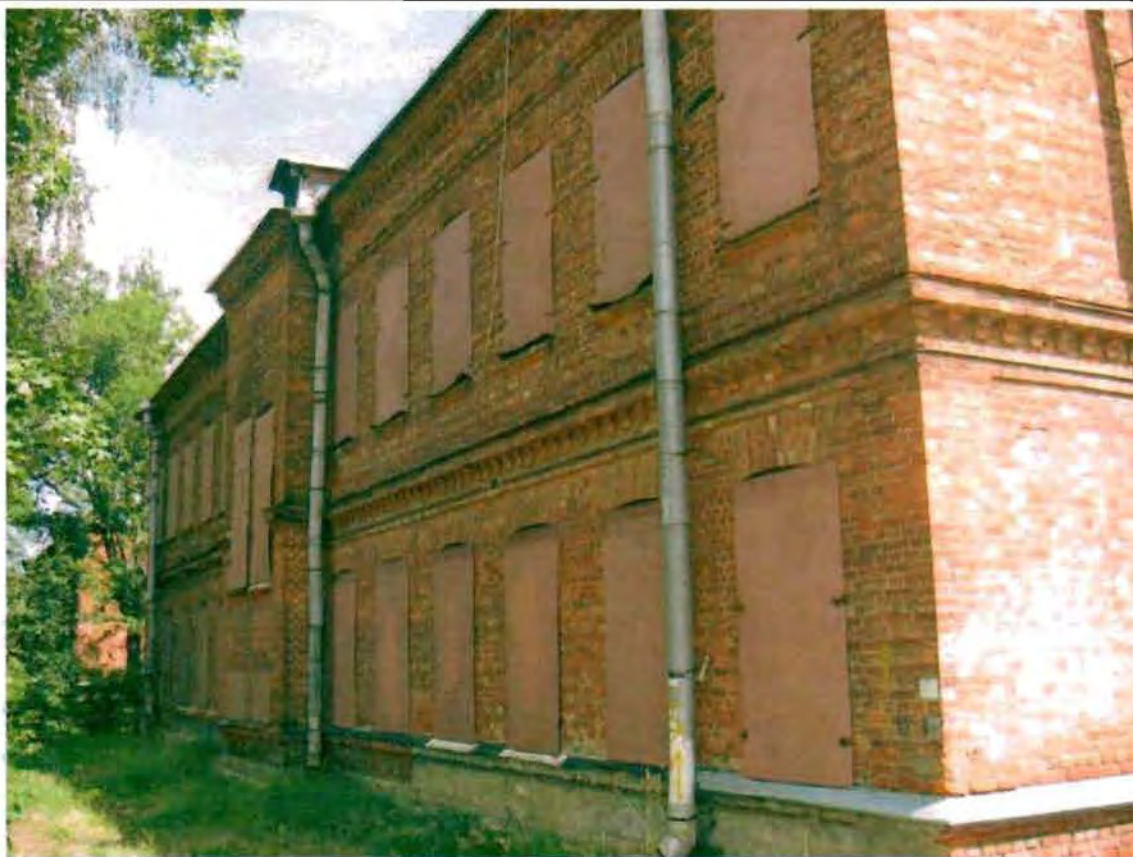
Фото 119. Западный фасад. Общий вид.
