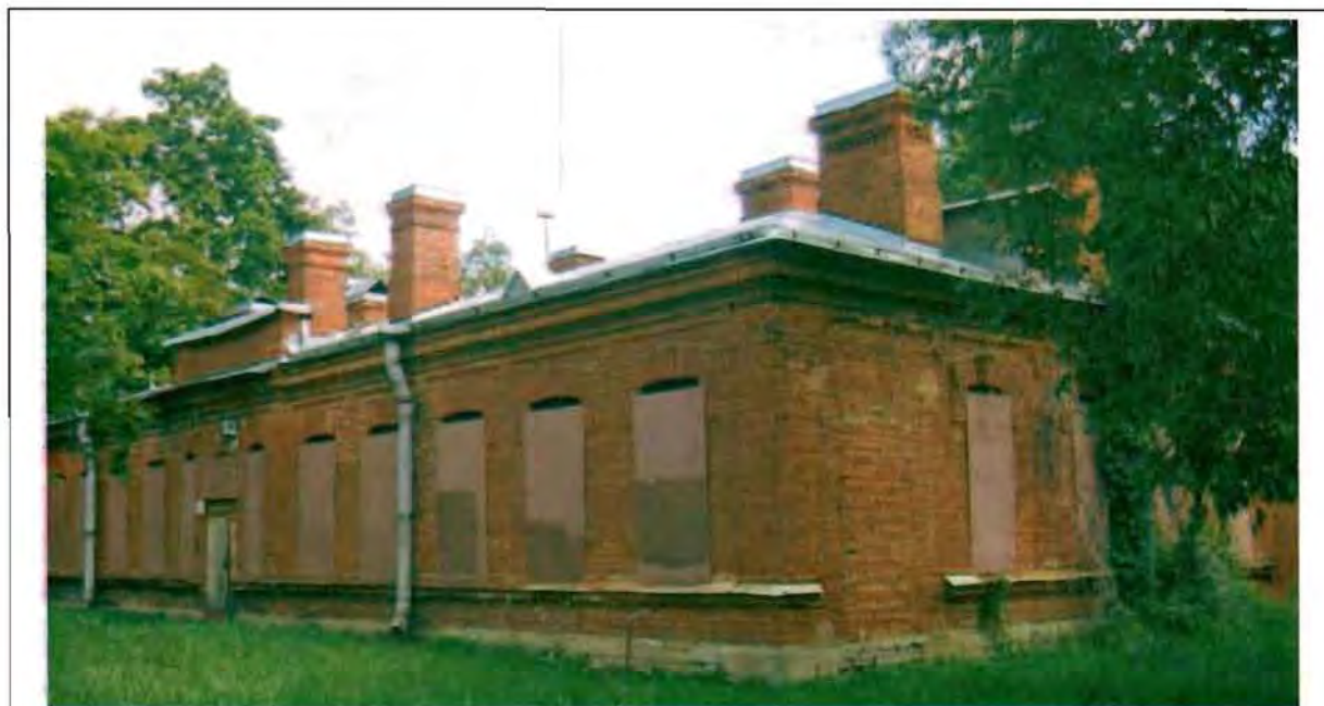
Фото 98. Западный фасад. Общий вид.
