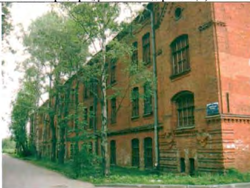
Фото 1. Западный фасад. Общий вид.
