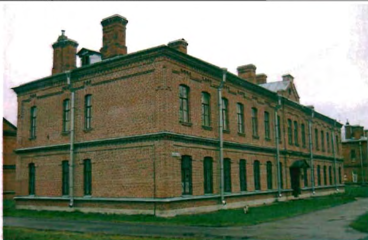
Фото 132. Западный, северный фасады. Общий вид.
