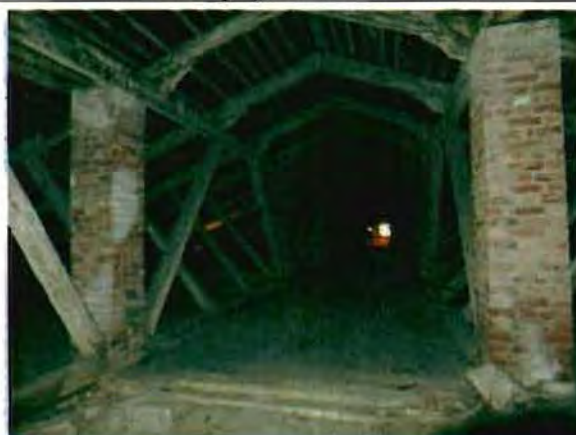
Фото 12. Конструкции крыши. Общий вид. 29.12.2015.
