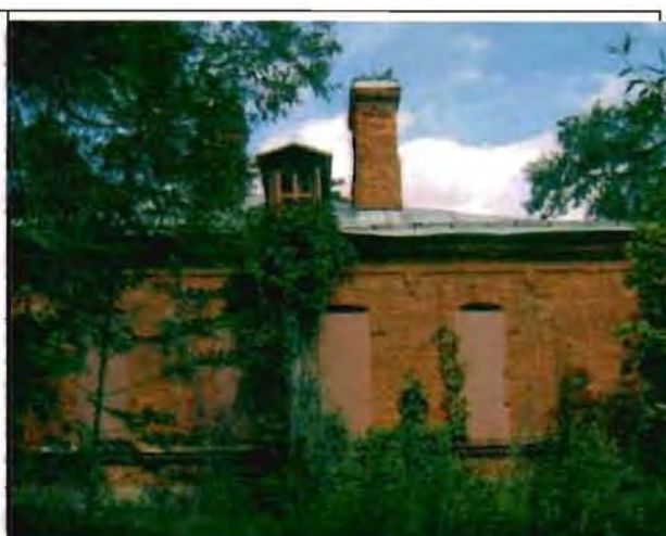
Фото 100. Южный фасад. Фрагмент.
