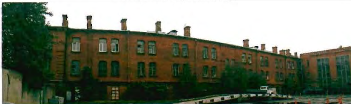
Фото 29. Западный фасад. Общий вид.
