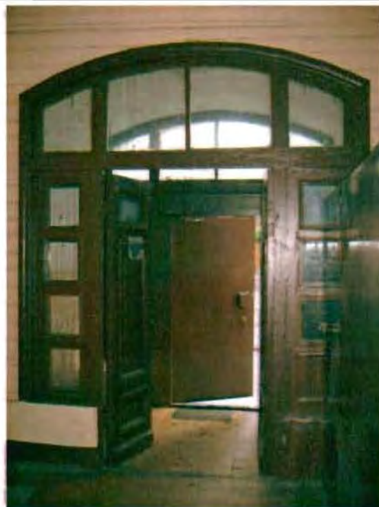
Фото 107. Дверной проем тамбура. Общий вид.
