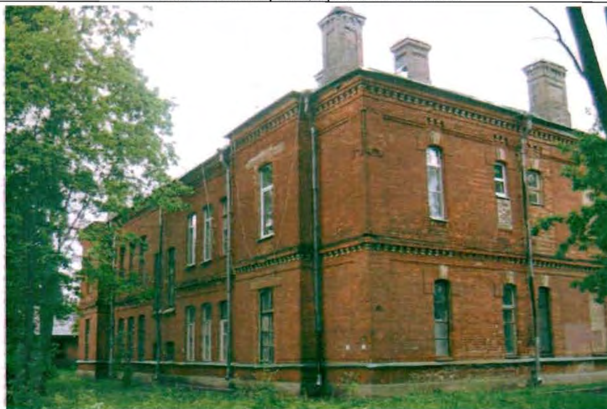
Фото 105. Западный, южный фасады. Общий вид.
