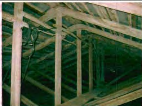
Фото 81 Конструкции крыши. Общий вид.
