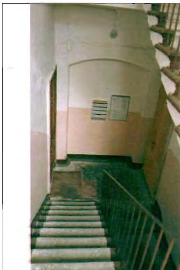
Фото 130. Лестница № 1 в южной части здания. Общий вид.
