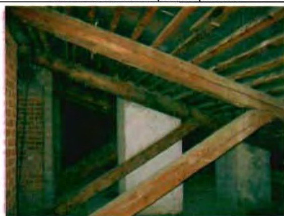
Фото 141. Конструкции крыши. Фрагмент.
