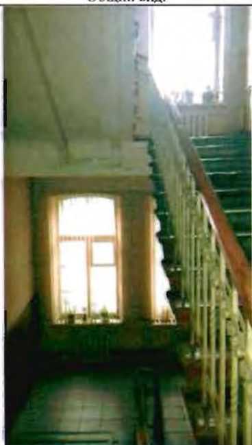
Фото 35. Интерьер. Лестница. Общий вид.
