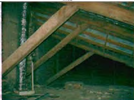
Фото 76. Конструкции крыши. Общий вид.
