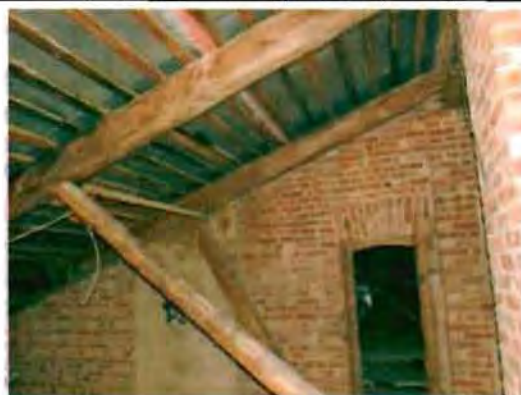
Фото 127. Конструкции крыши. Общий вид.
