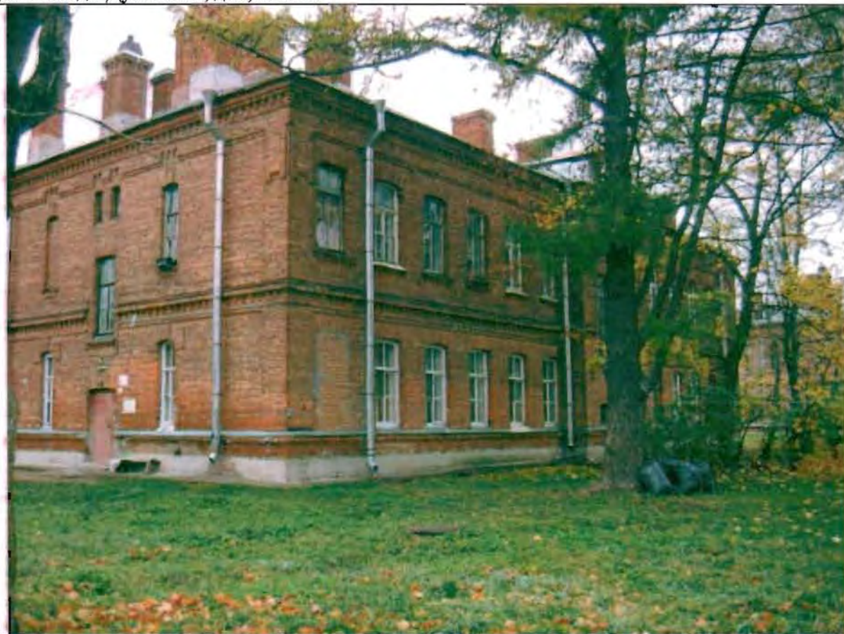
Фото 145. Восточный фасад. Общий вид.
