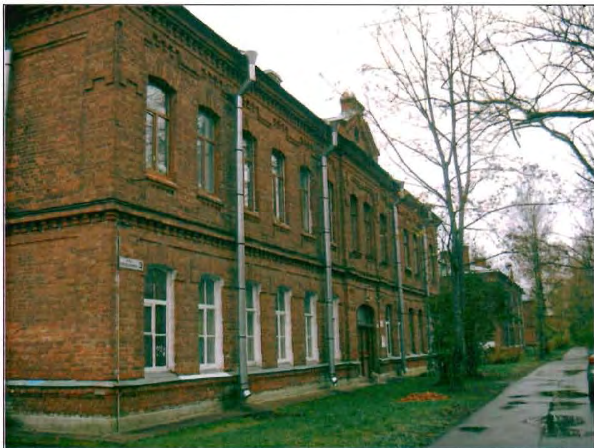
Фото 146. Западный фасад. Общий вид.
