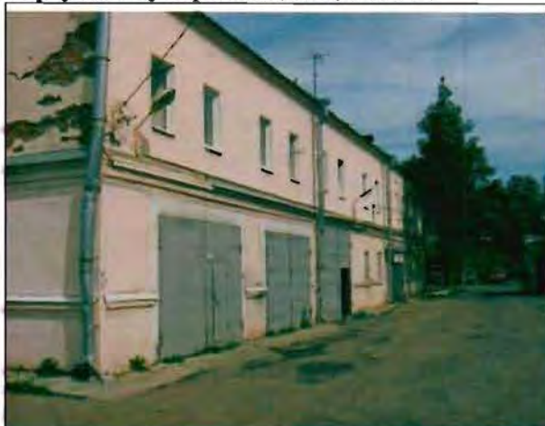
Фото 110. Восточный фасад. Общий вид.
