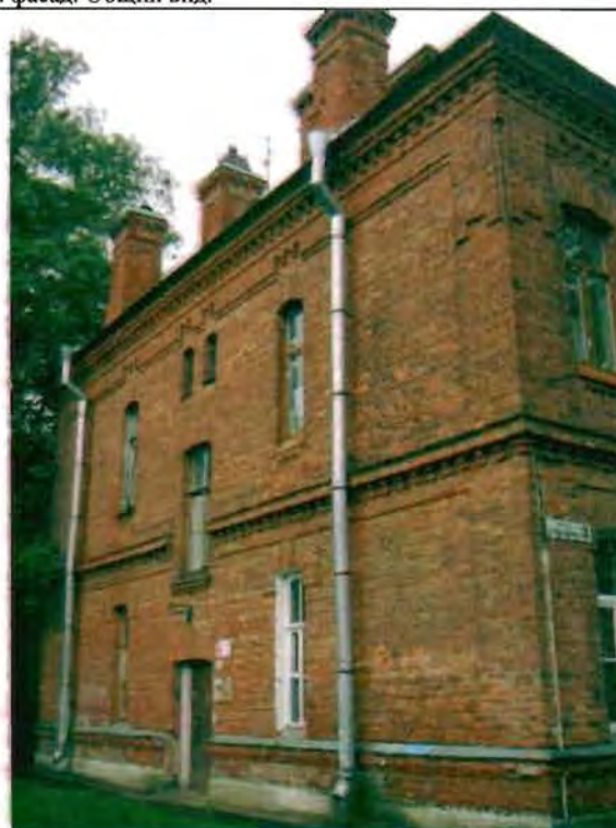
Фото 148. Северный фасад. Общий вид.
