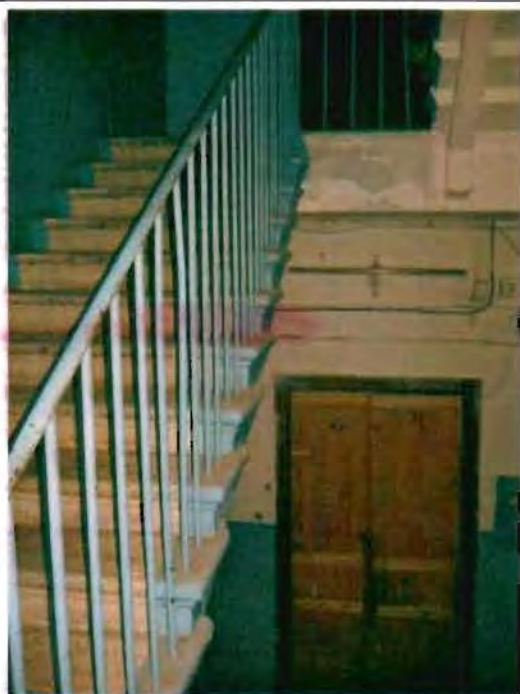
Фото 143. Лестница № 1 в северной части здания. Общий вид.
