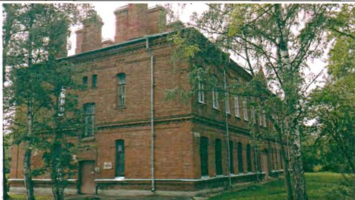
Фото 170. Северный, западный фасады. Общий вид.
