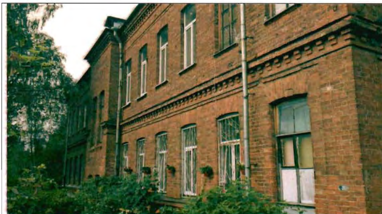
Фото 171. Восточный фасад. Общий вид.
