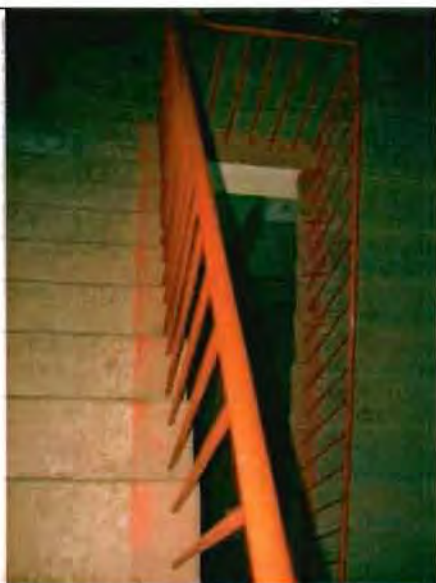
Фото149. Лестница № 1 в северной части здания. Общий вид.
