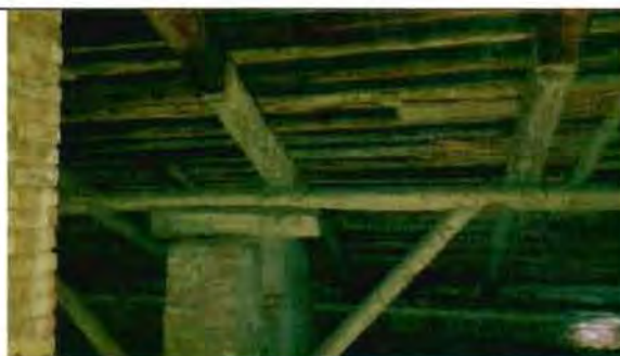
Фото 38. Конструкции крыши. Фрагмент.
