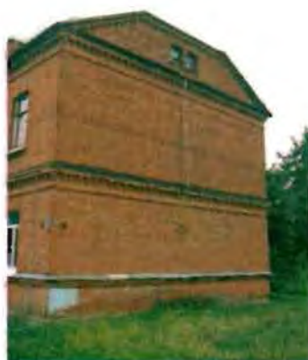
Фото 86. Западный фасад. Общий вид.
