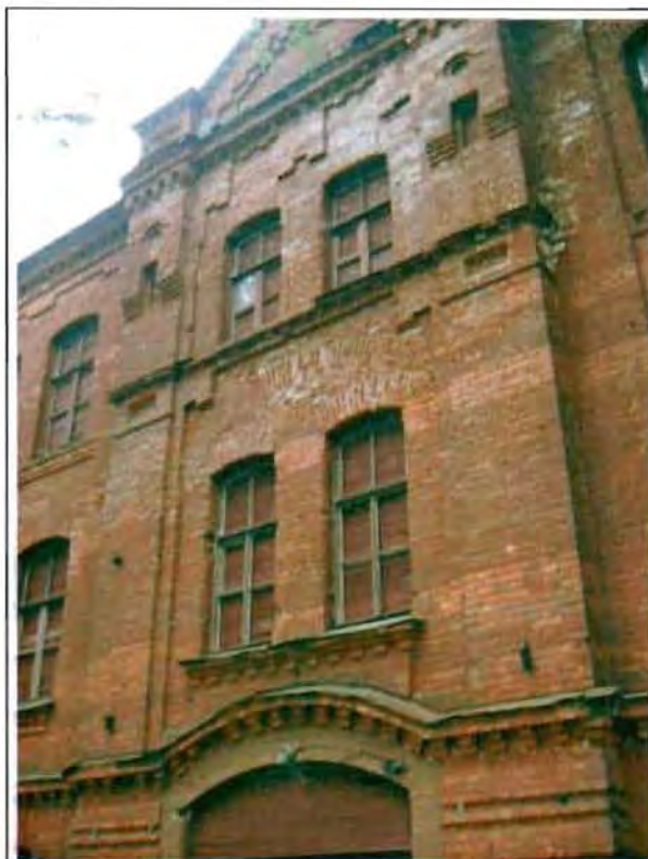
Фото 3. Западный фасад. Фрагмент центральной части фасада.
