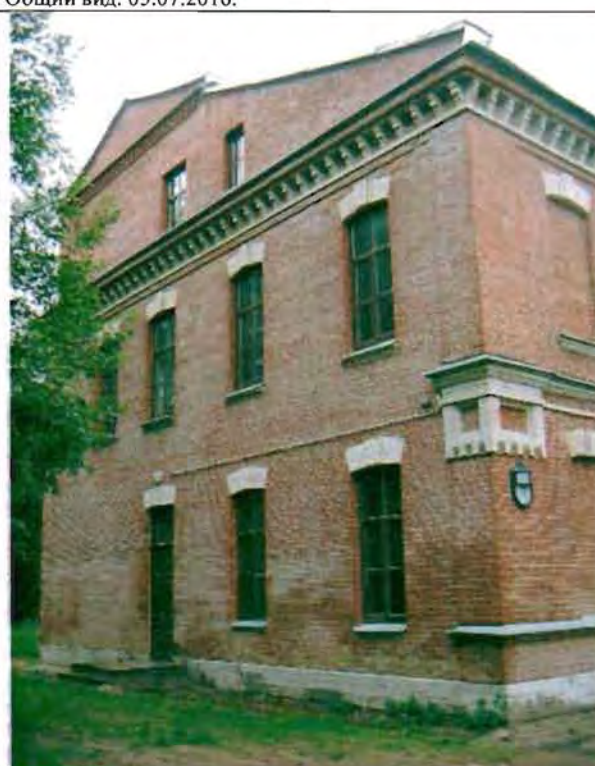
Фото 68. Восточный фасад. Общий вид.
