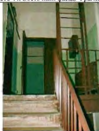
Фото 46. Интерьер. Лестница. Фрагмент.
