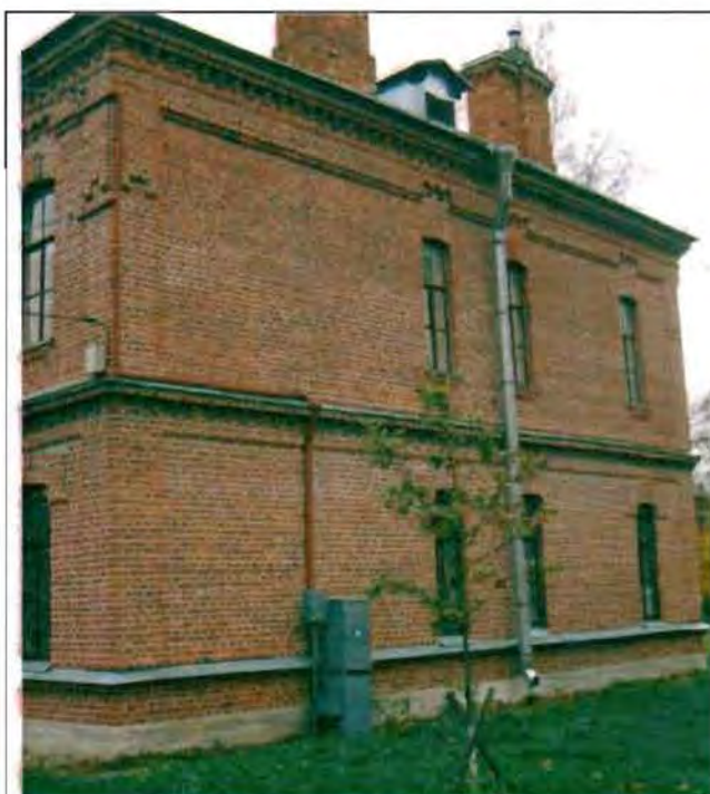
Фото 134. Южный фасад. Общий вид.
