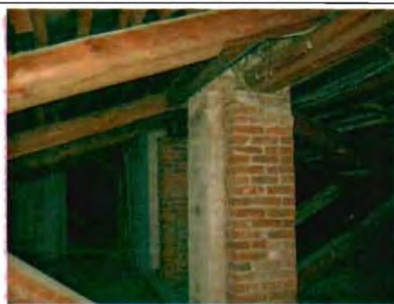
Фото 142. Конструкции крыши. Фрагмент.
