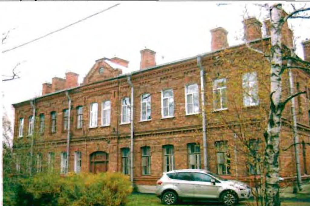
Фото 128. Восточный фасад. Общий вид.
