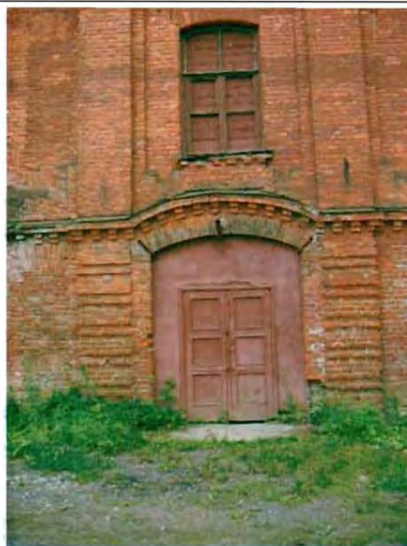
Фото 4. Западный фасад. Фрагмент центральной части фасада.
