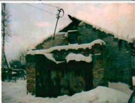
Фото 184. Восточный фасад. Общий вид. 14.01.2015.
