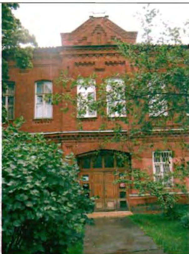
Фото 90. Восточный фасад. Центральная часть. Общий вид.
