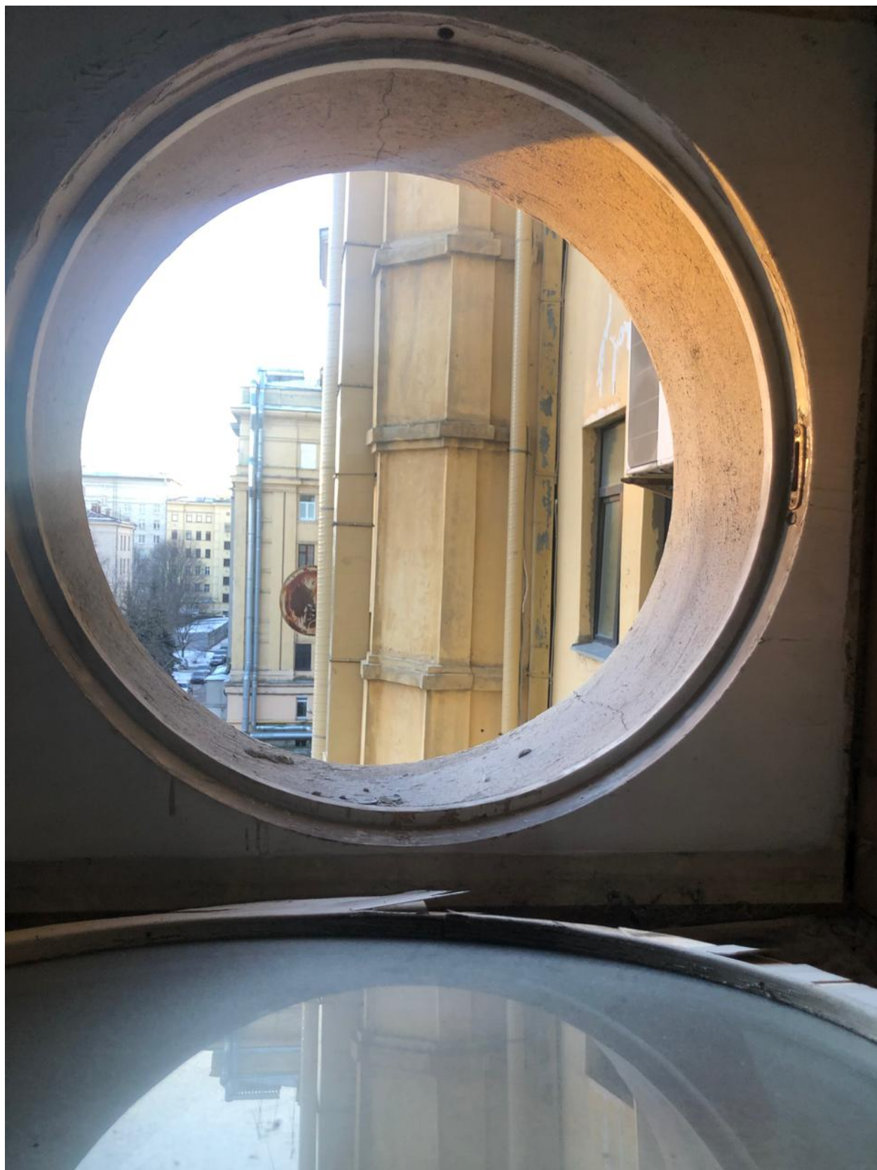
19. Помещение 8 (согласно техническому паспорту). Оконный проем.
