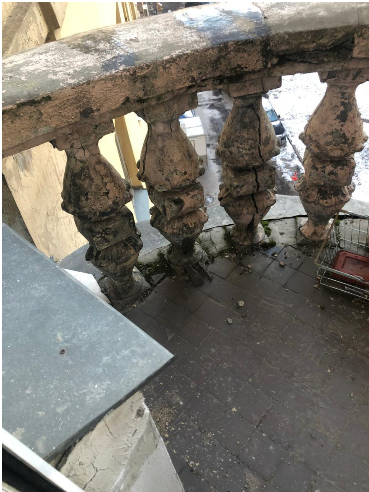
22. Балкон со стороны двора.
