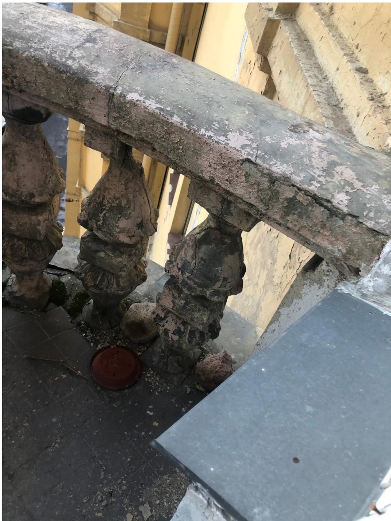
23.Балкон со стороны двора.
