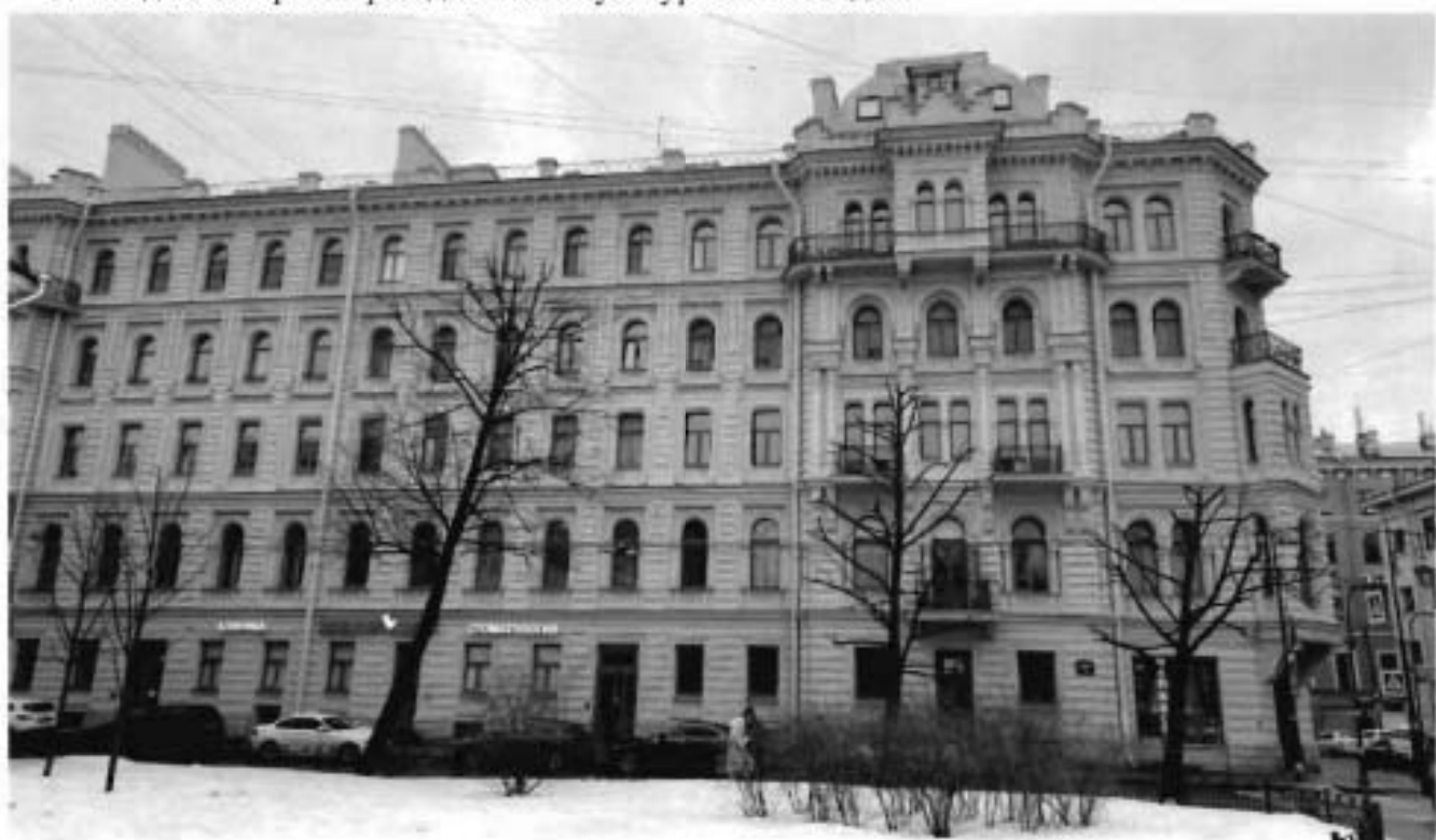
3. Вид на северный фасад объекта культурного наследия.
