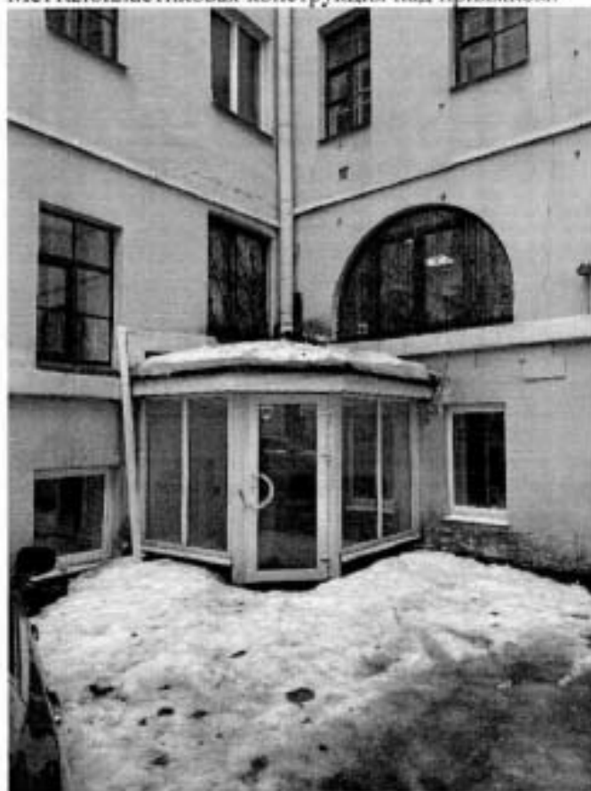
13. Фрагмент северного фасада. Металлопластиковая конструкция над приямок.
