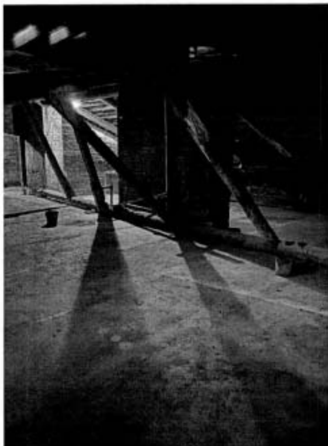
42. Устройство нового перекрытия над кв. 9.
