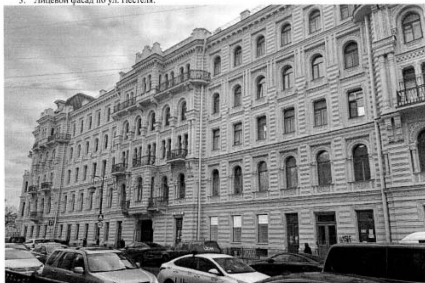
3. Лицевой фасад по ул. Пестеля.
