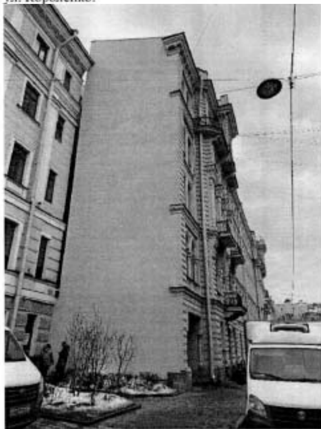
5. Брандмауэрный фасад со стороны ул. Короленко.
