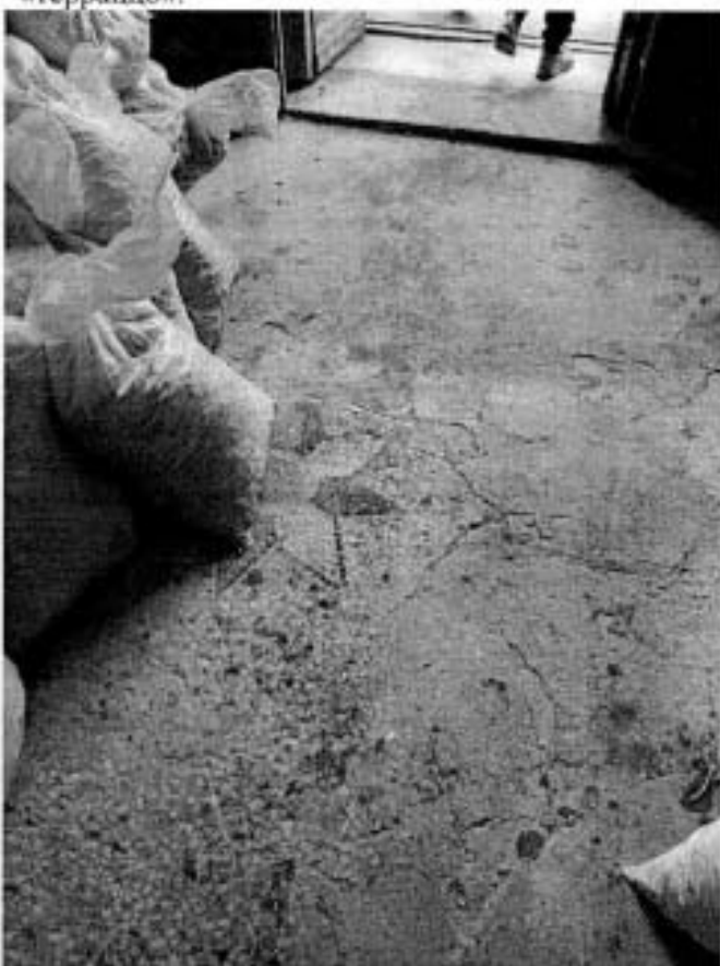
18. Покрытие пола 1ЛК – мозаика в технике «терраццо».
