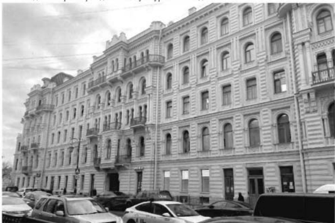
2. Вид на северный фасад объекта культурного наследия.
