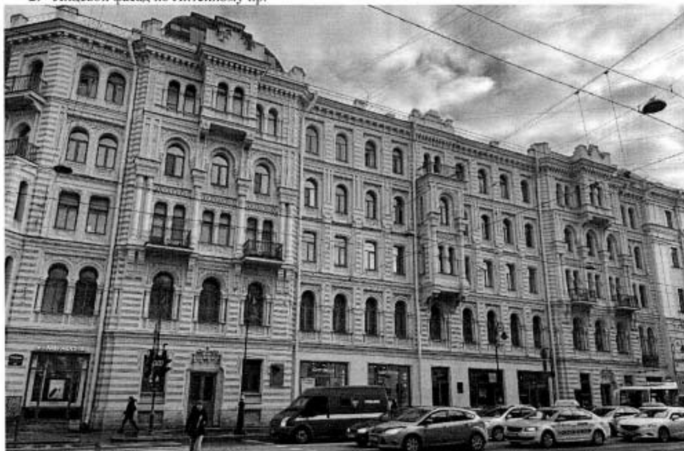
2. Лицевой фасад по Литейному пр.
