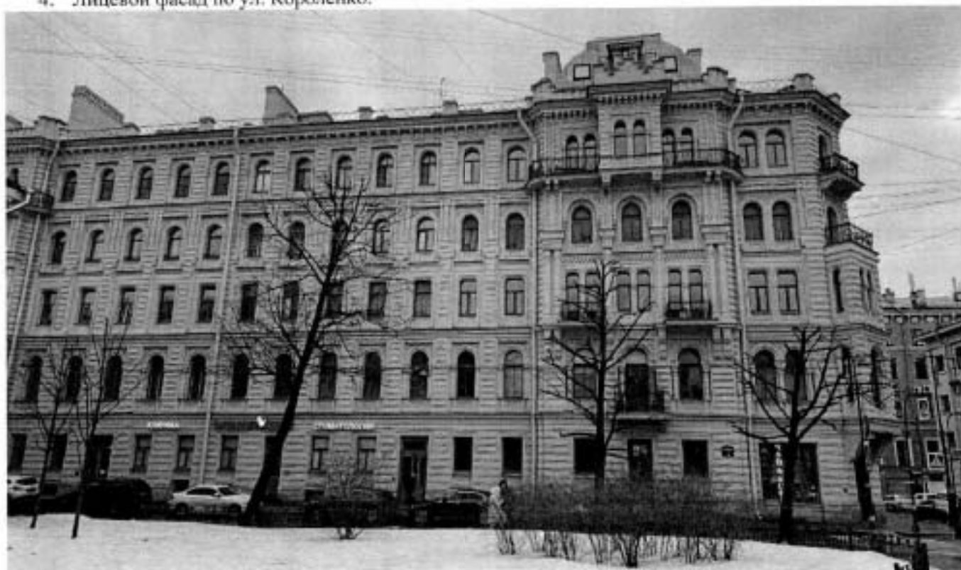
4. Лицевой фасад по ул. Короленко.
