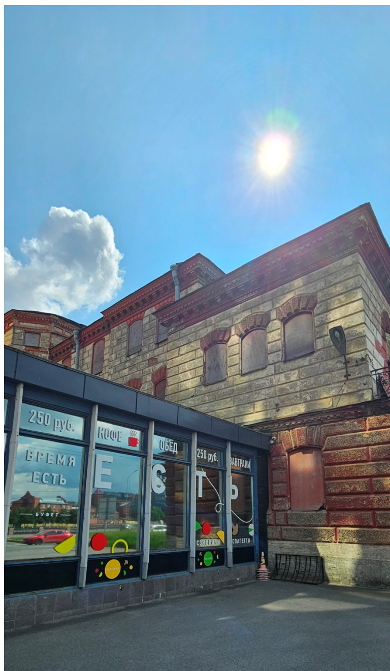
3. Место примыкания современного 1-эт. объема к северному фасаду объекта культурного наследия федерального значения «Особняк и заводоуправление Механического завода «Людвиг Нобель» с зимним садом».
