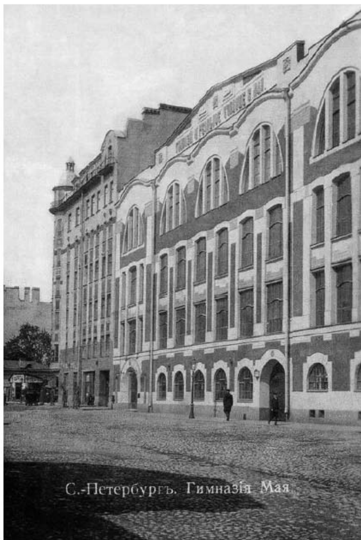
61. Гимназия К.Мая на 14-й линии В.О. Фотография. Автор фото неизвестен. 1914 г. // Источник: [Электронный ресурс] URL: https://pastvu.com/p/121101 .
