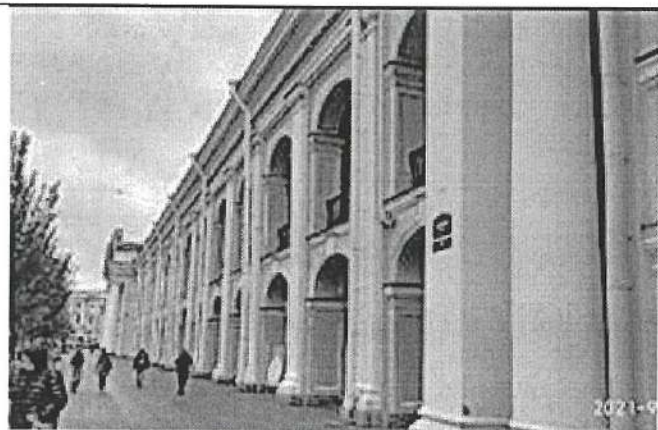
Фото 1. Фасад Невской линии
