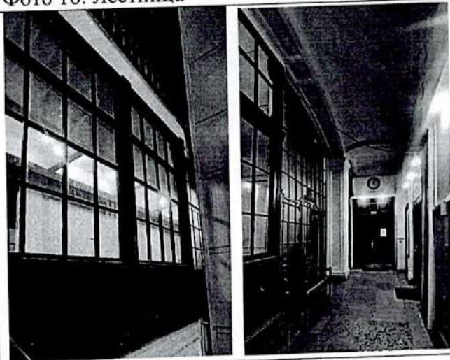
Фото 18. Заполнения проемов лестничной площадки
