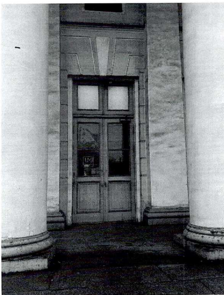
Дверное заполнение лицевого фасада
