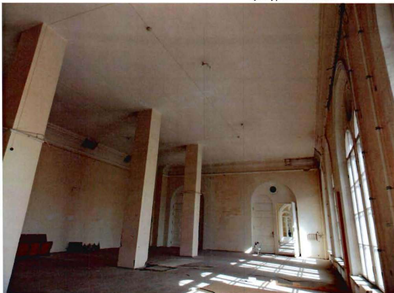
6. Помещение 3 этажа (41-Н).
