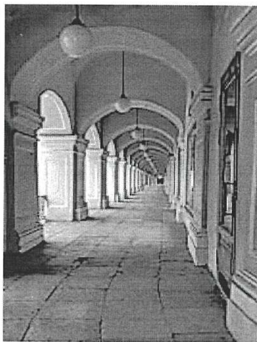
Фото 7. Крытая арочная галерея Садовой линии 1 этажа
