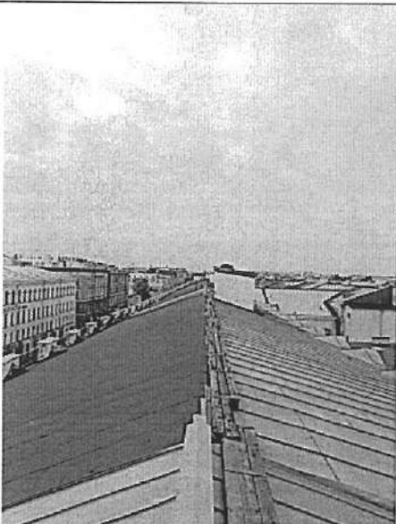
Фото 17. Кровля по Садовой линии
