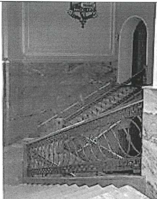
Фото 21. Лестница угла Ломоносовской и Перинной линий
