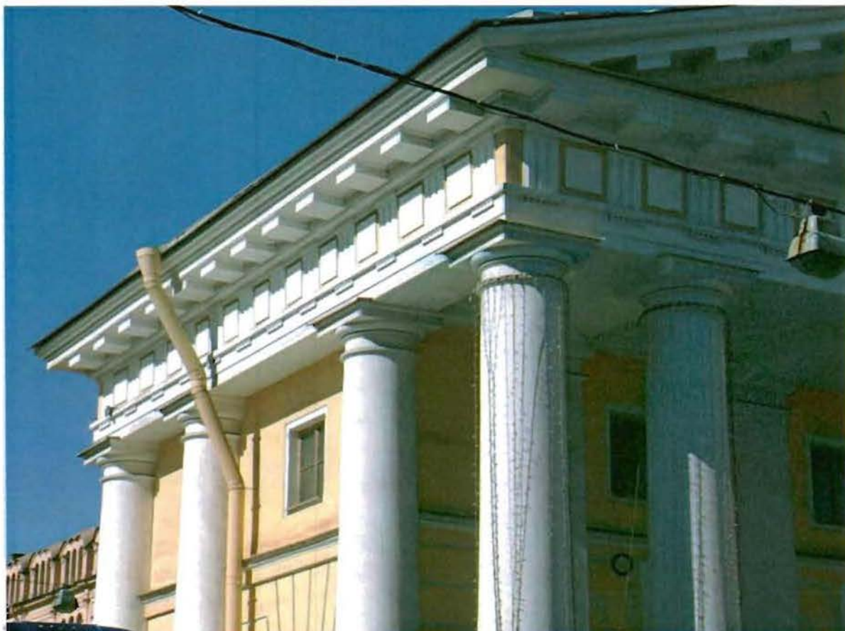
Фото 4. Часть восточного фасада.
