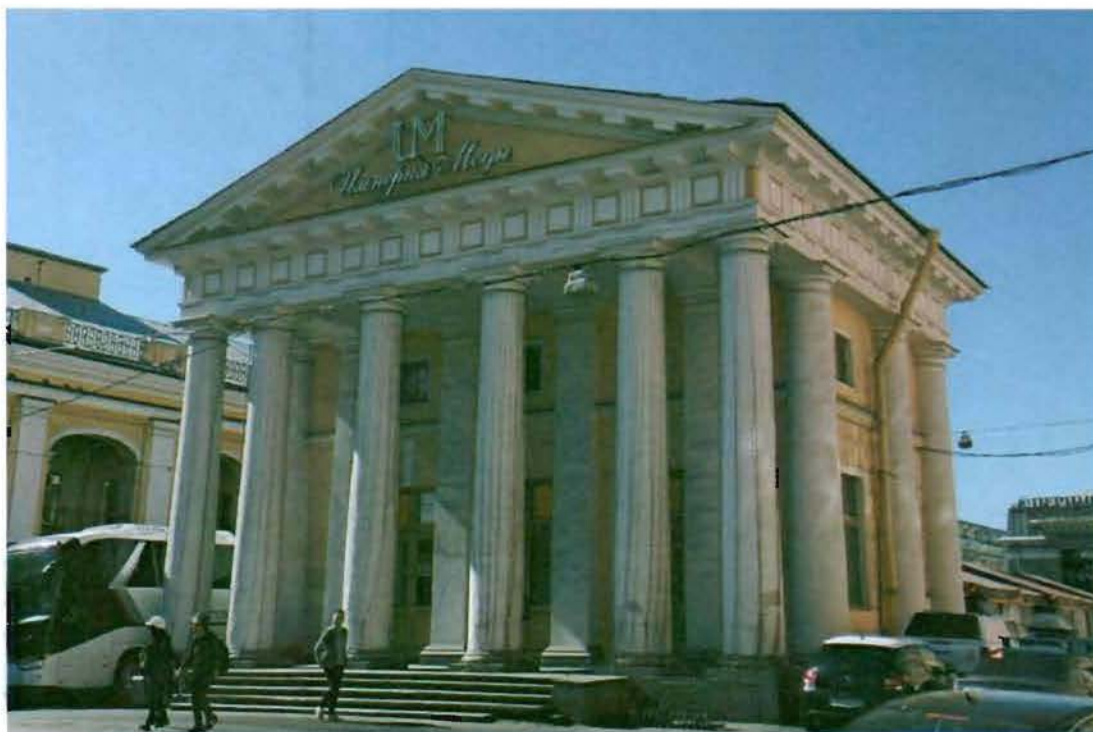
Фото 1. Северный и западный фасад.
