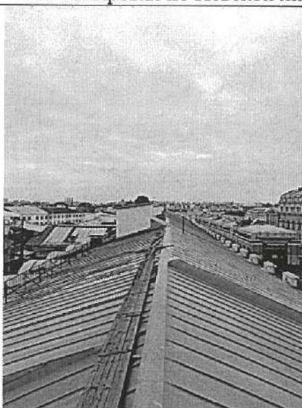
Фото 18. Кровля по Перинной линии
