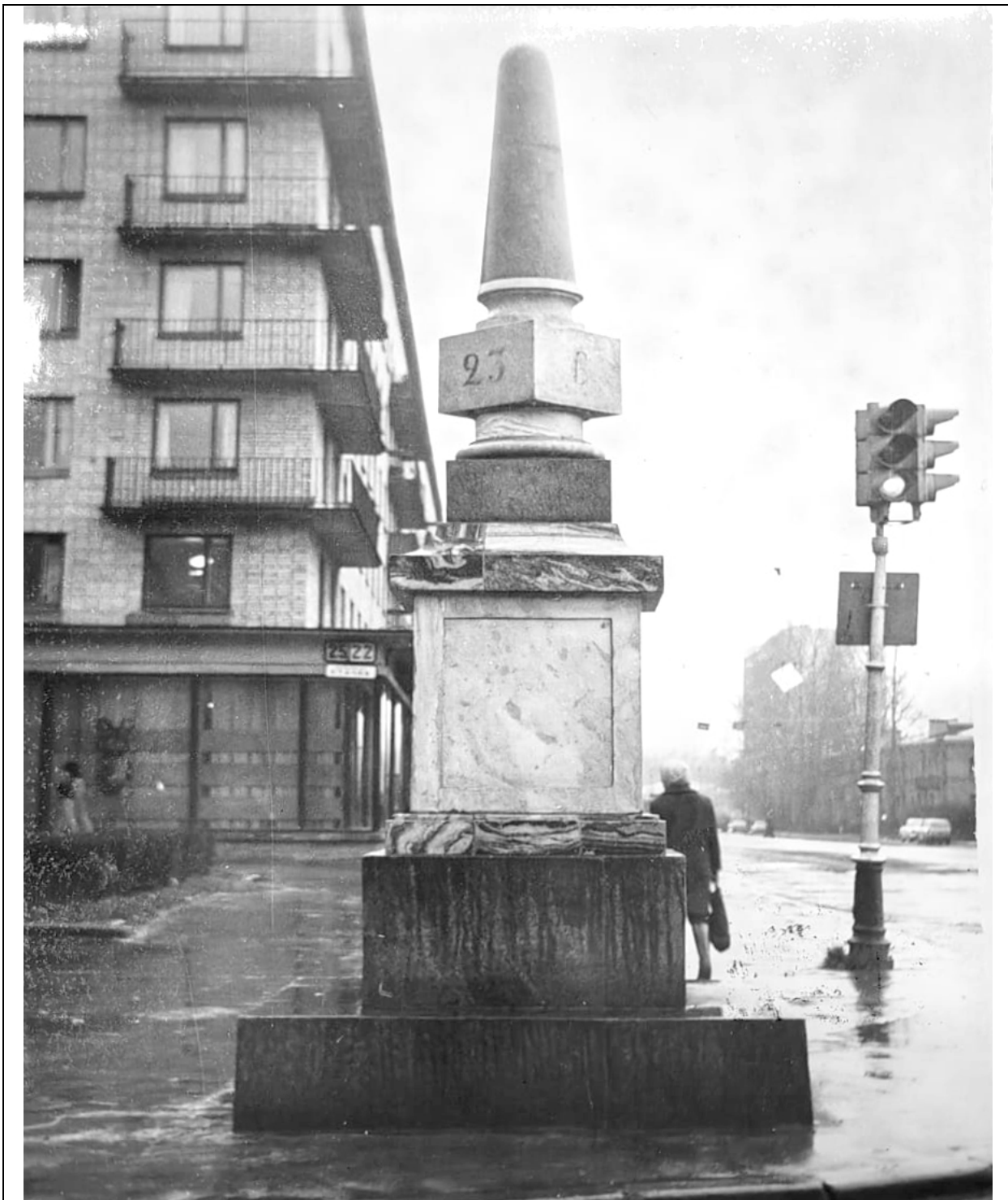
10. Архив КГИОП. Инв. №84432/2. Верстовой столб 23/6. на углу пр. Стачек и ул. Трефолева. Общий вид с западной стороны. После реставрации. Фото 1979 г.
