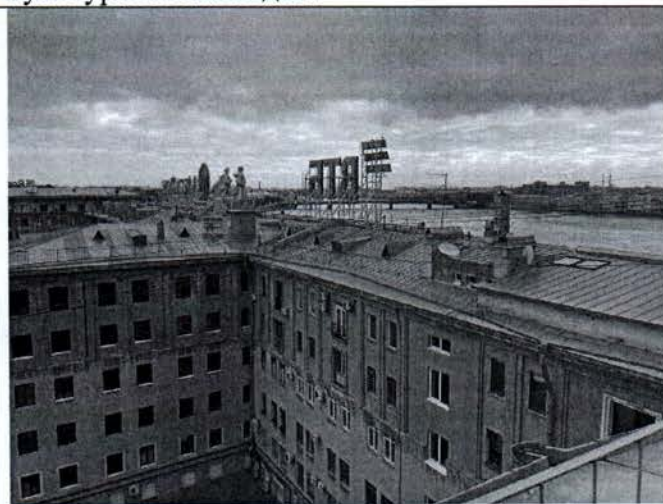
Фото 9. Фрагмент крыши и дворовых фасадов объекта культурного наследия.
