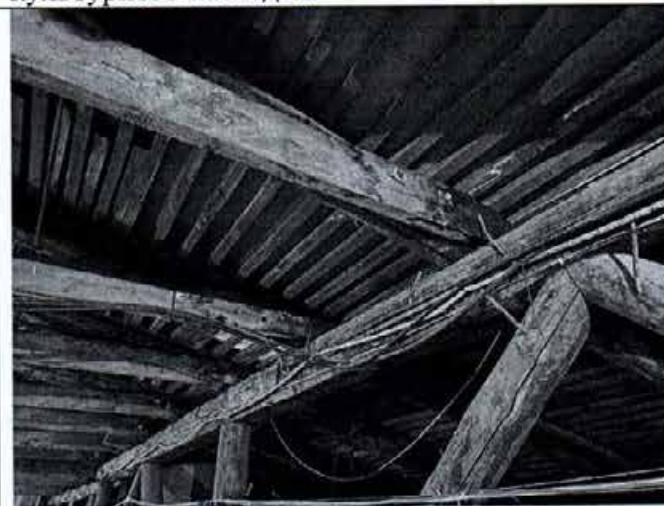
Фото 22. Фрагмент стропильной системы объекта культурного наследия.
