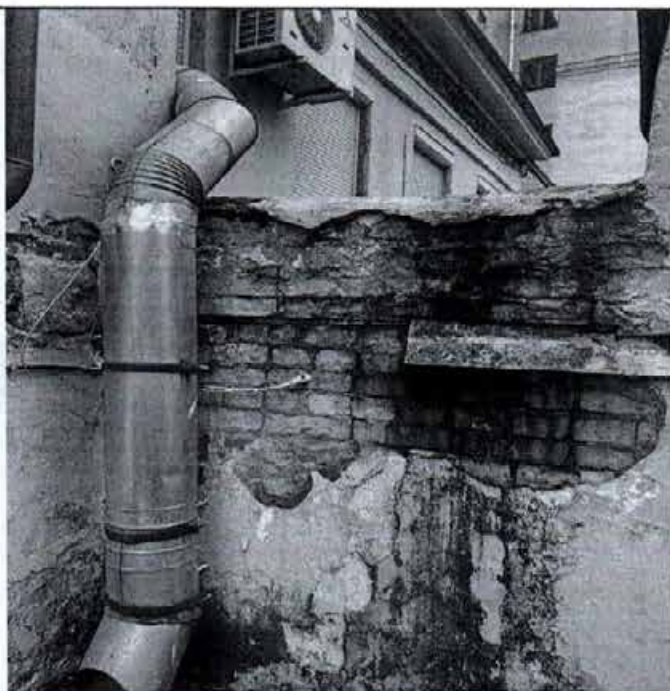
Фото 19. Фрагмент северного дворового фасада объекта культурного наследия.
