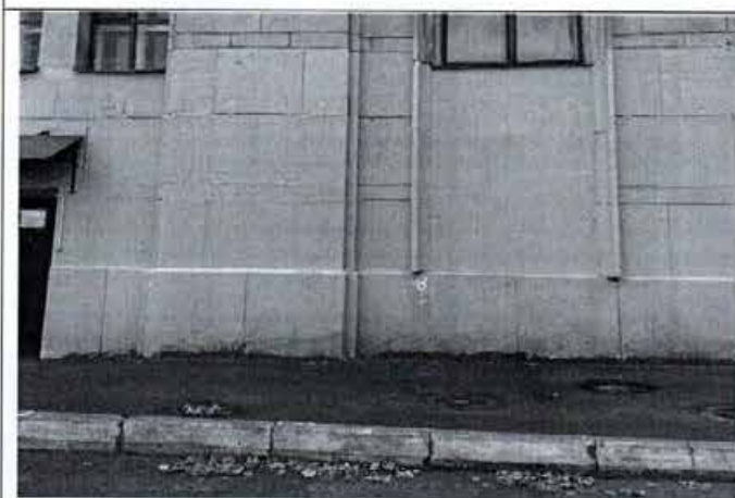
Фото 15. Фрагмент отмостки и цоколя северного дворового фасада объекта культурного наследия.
