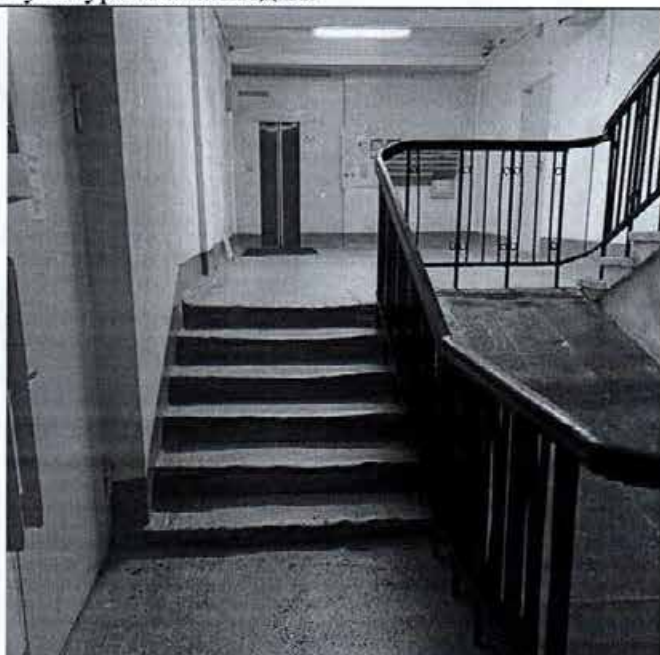
Фото 36. Лестница объекта культурного наследия.
