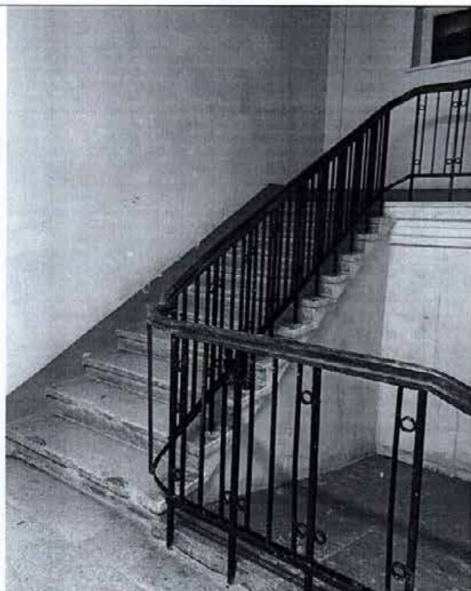
Фото 33. Лестница объекта культурного наследия.
