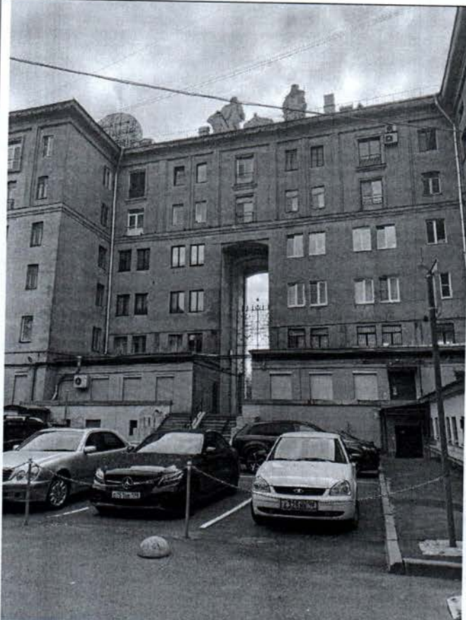
Фото 5. Фрагмент центральной части северного дворового фасада объекта культурного наследия.
