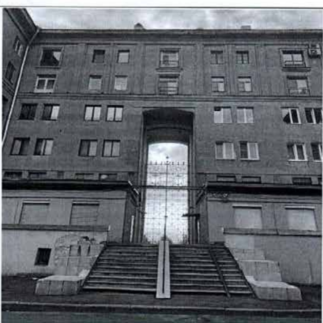
Фото 18. Крыльцо и арочный проем в центральной части северного дворового фасада объекта культурного наследия.
