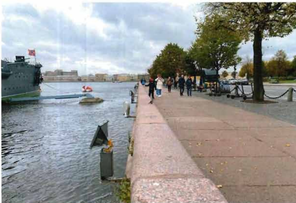
1. Общий вид на объект культурного наследия.
