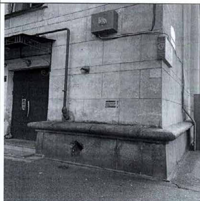
Фото 17. Фрагмент отмостки и цоколя северного фасада западного бокового флигеля объекта культурного наследия.
