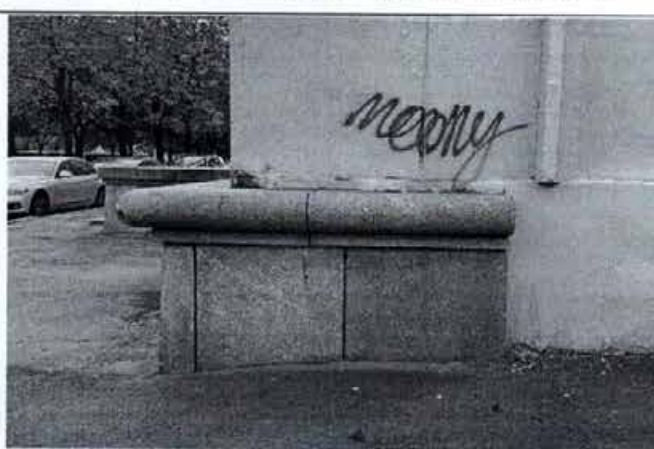
Фото 16. Фрагмент отмостки и цоколя лицевого фасада восточного бокового флигеля объекта культурного наследия.
