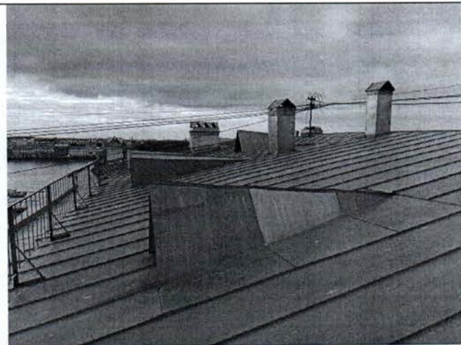
Фото 10. Фрагмент кровельного покрытия объекта культурного наследия.
