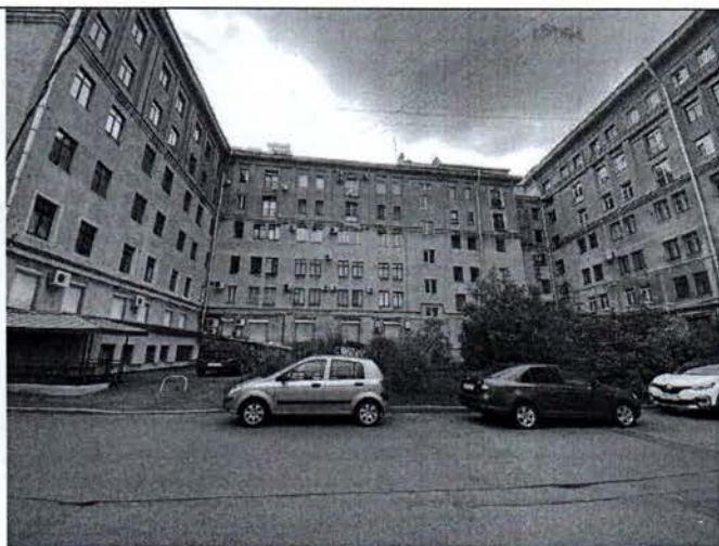
Фото 7. Фрагмент западной части северного и западного дворовых фасадов и восточный дворовой фасад выступающего объема объекта культурного наследия.
