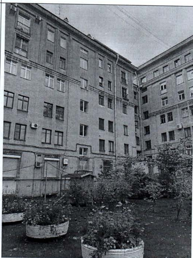
Фото 6. Фрагмент западной части северного и южной части западных фасадов объекта культурного наследия.
