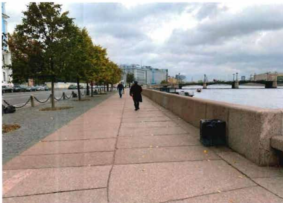
2. Общий вид на объект культурного наследия.
