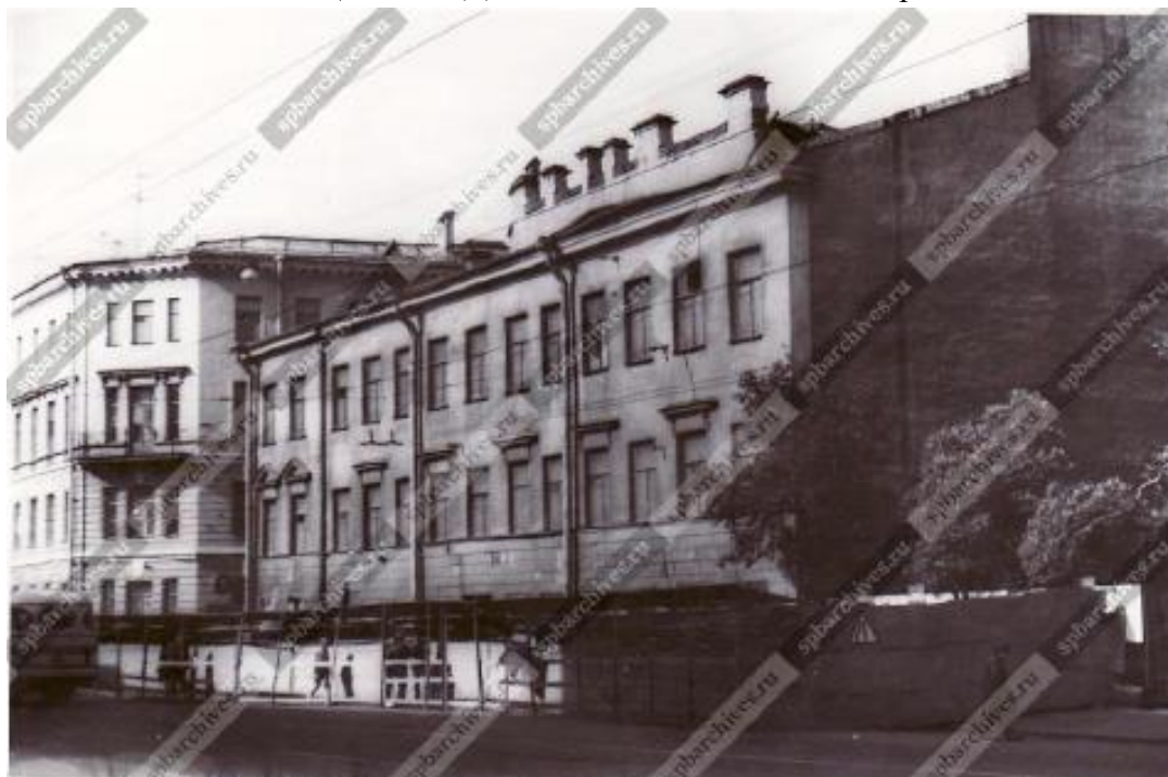
24. Вид фасада дома №11/10 со стороны Владимирского проспекта во время капитального ремонта (архитектор В.Е.Морган, 1839 г.) Фото 1986 г. // ЦГАКФФД СПб. Опись 1 АР-154. Ед.хр.217648
