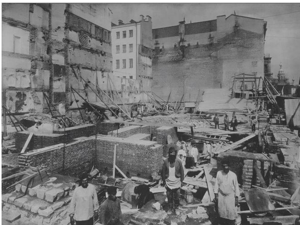
22. Строительство Дома компании «Зингер» на углу Невского проспекта. Фотография. 1902 г. https://www.citywalls.ru/
