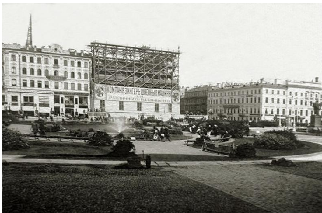
23. Строительство Дома компании «Зингер» на углу Невского проспекта. Фотография. 1902 г. https://www.citywalls.ru/
