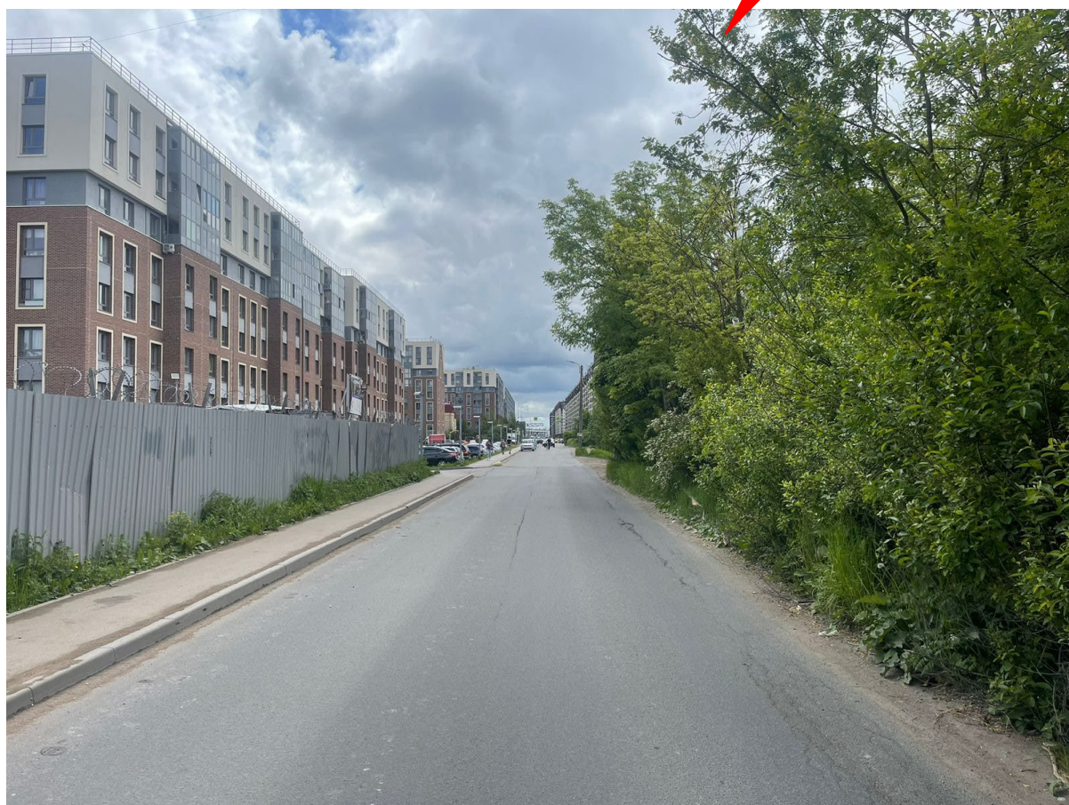
6. Вид на зону производства работ.
