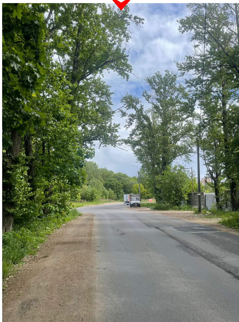
8. Вид на зону производства работ.
