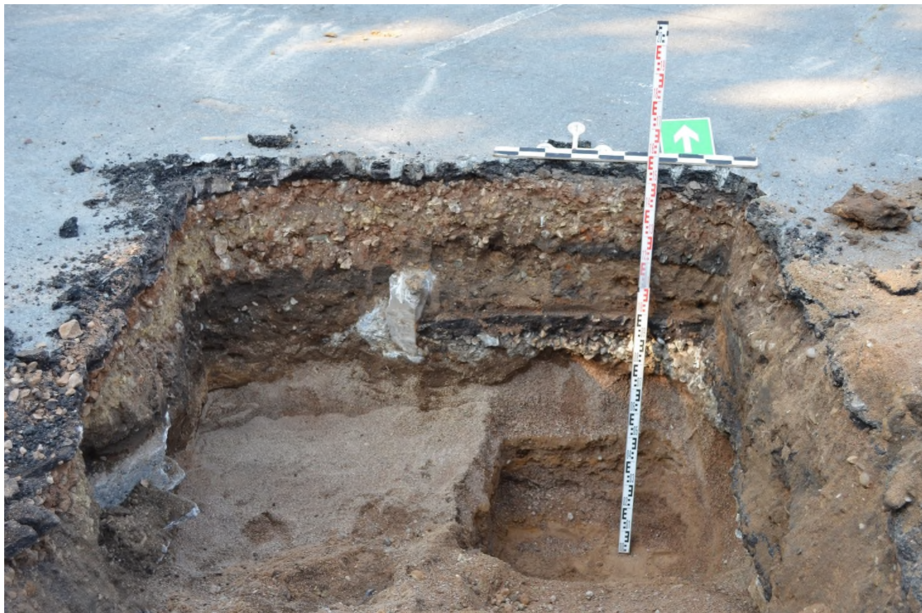
Рис. 30. Санкт-Петербург, проспект Тореза, дом 42, корпус 1, литера А, земельный участок с кадастровым номером: 78:36:0535303:12. Шурф 1. Северная стенка после контрольного прокопа. Вид с Ю.
