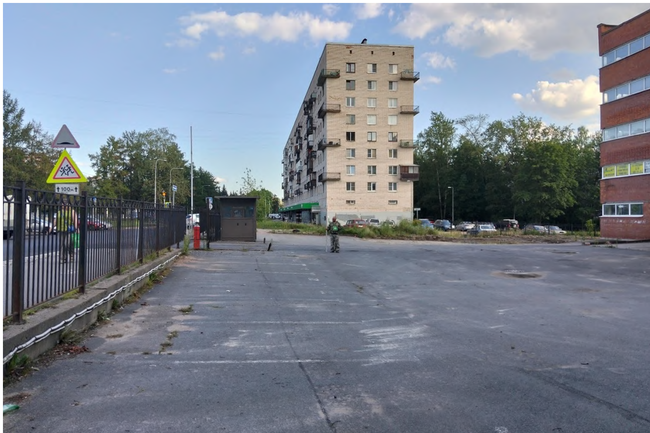
Рис. 22. Санкт-Петербург, проспект Тореза, дом 42, корпус 1, литера А, земельный участок с кадастровым номером: 78:36:0535303:12. Точка фотофиксации 3. Вид с СЗ.
