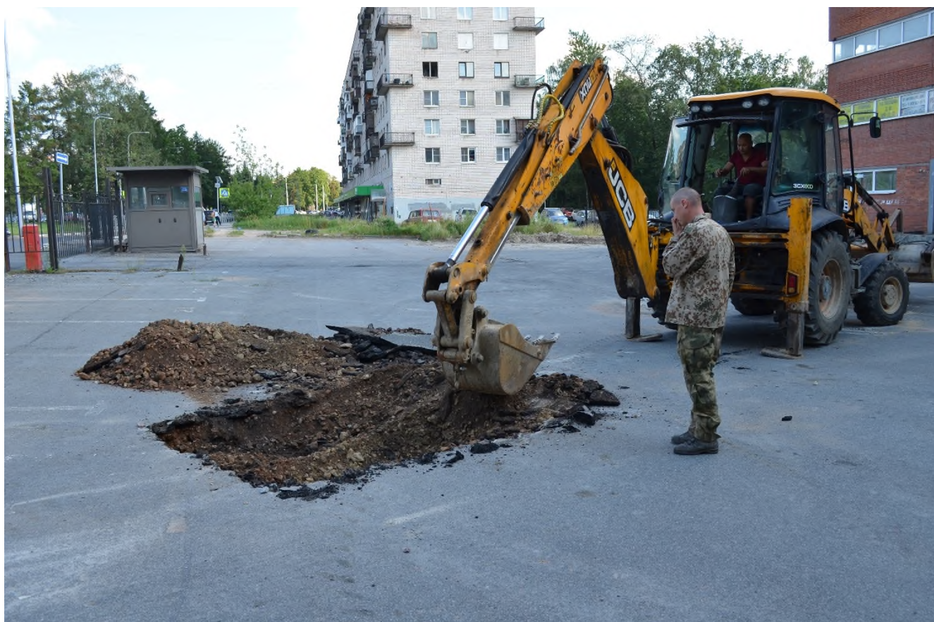
Рис. 27. Санкт-Петербург, проспект Тореза, дом 42, корпус 1, литера А, земельный участок с кадастровым номером: 78:36:0535303:12. Шурф 1. Снятие асфальтового покрытия. Рабочий момент. Вид с Ю.
