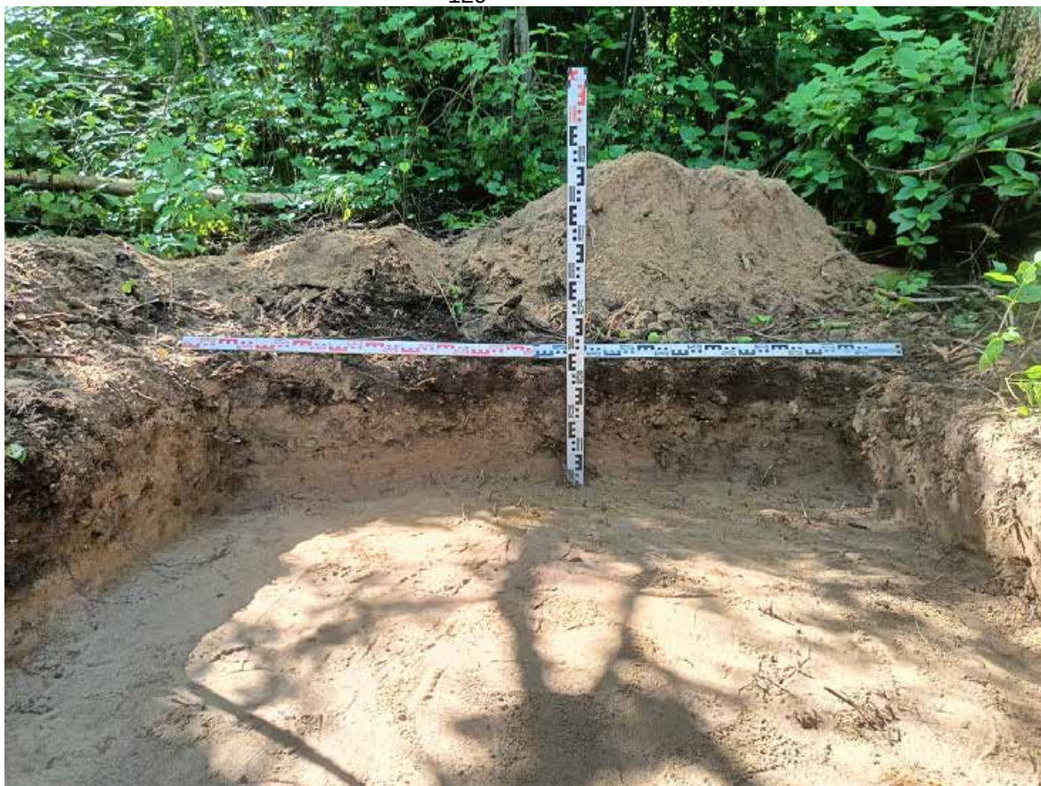
Рис. 38. СПб-2025, г. Кронштадт, ул. Литке. Шурф 1, фиксация по уровню окончания работ, южная стенка.
