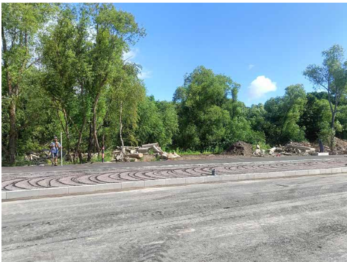
Рис. 27. СПб-2025, г. Кронштадт, ул. Литке. Точка фотофиксации 5, вид с юго-запада.
