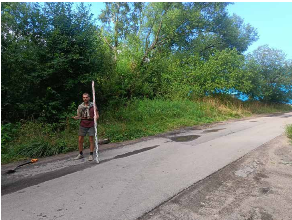
Рис. 17. СПб-2025, г. Кронштадт, ул. Литке. Точка фотофиксации 1, вид с востока.
