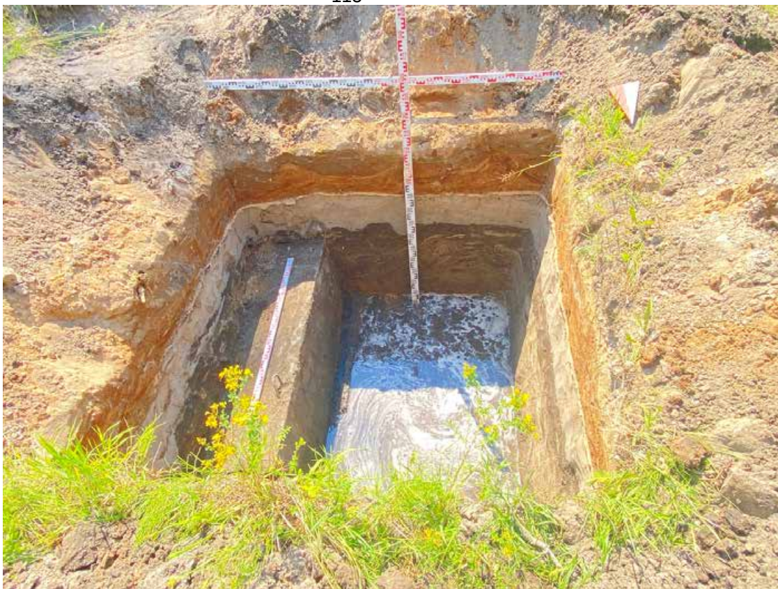
Рис. 38. Санкт-Петербург, Внутриквартальное муниципальное образование города федерального значения Санкт-Петербурга муниципальный округ Пискаревка, проспект Маршала Блюхера, земельный участок 16п (кадастровый номер: 78:10:0005125:20907). Шурф №1. Зачистка дна шурфа на уровне стояния грунтовых вод по материку. Вид с севера
