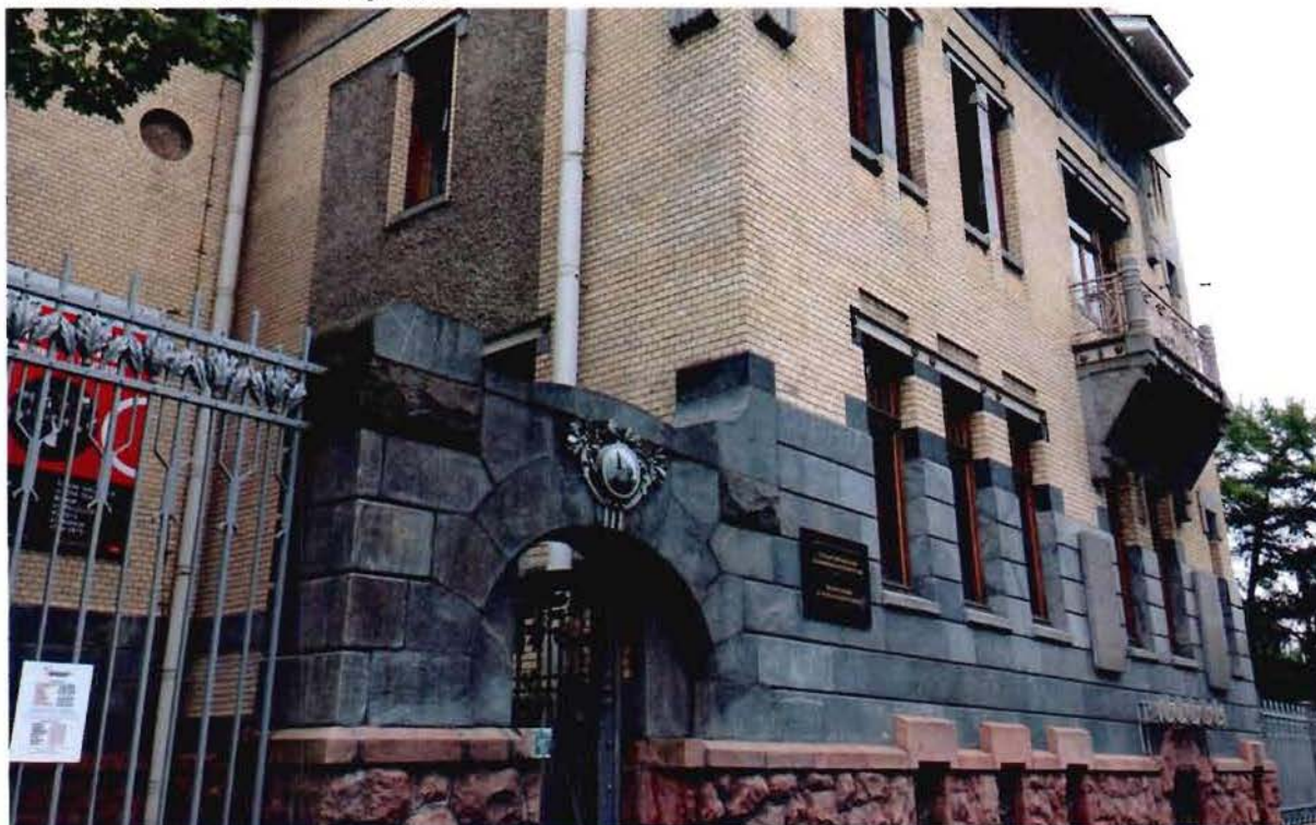
2. Вид на юго-западный фасад.
