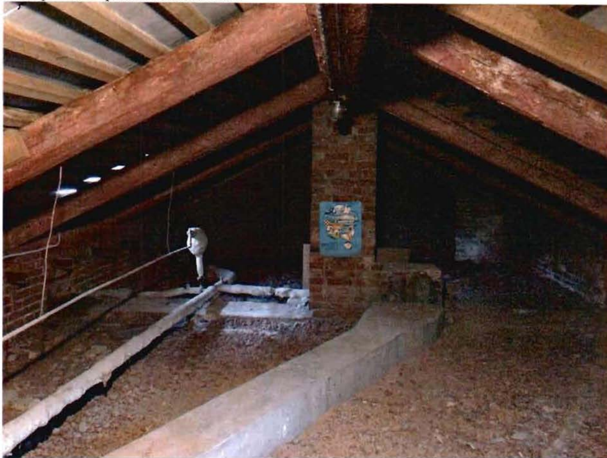
16. Крыша. Стропильная система.
