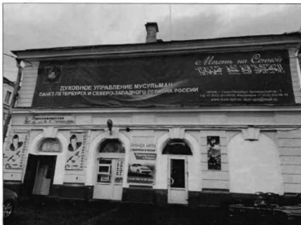
10. Южный фасад части объекта культурного наследия.
