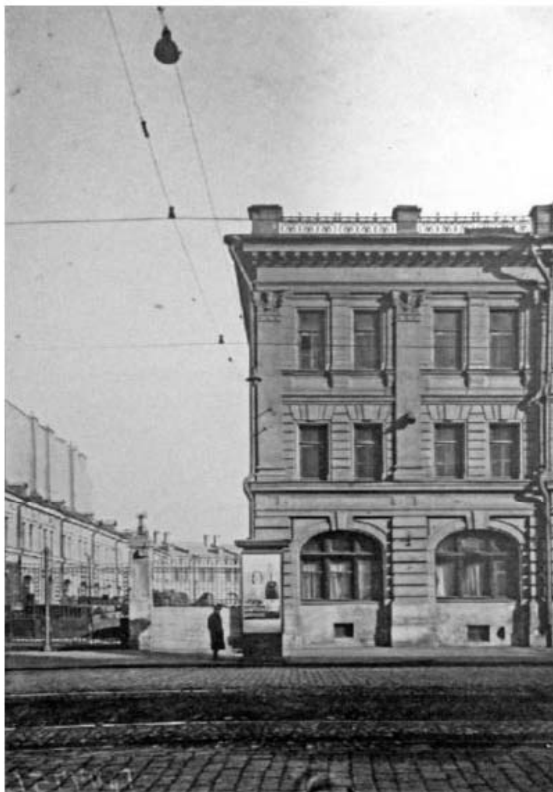
56. Фрагментарная фотофиксация лицевого фасада центрального корпуса Швейной фабрики артели им. тов. Огородникова (бывшего Рыбного рынка) до его надстройки четвертым этажом в 1940 г. 1939 г.// Источник: ЦГАКФФД. Гр. 777 58. Инд. 732.33.
