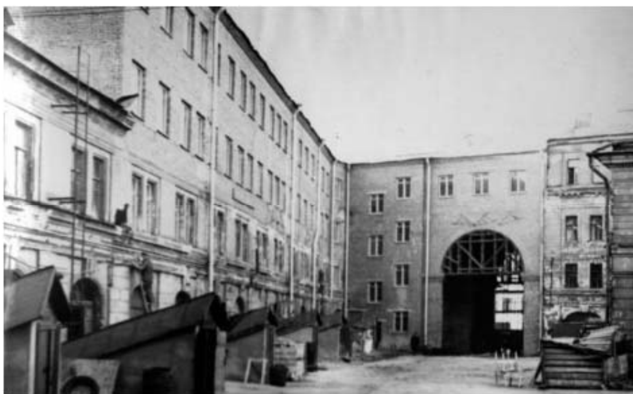
103. Фотофиксация завершения строительных работ на дворовых фасадах зданий и дворовой территории. 1966 г. // Источник: Архив ФГУП «Гидрографическое предприятие» Госкорпорации «Росатом». Московский пр., д. 12, Санкт-Петербург.
