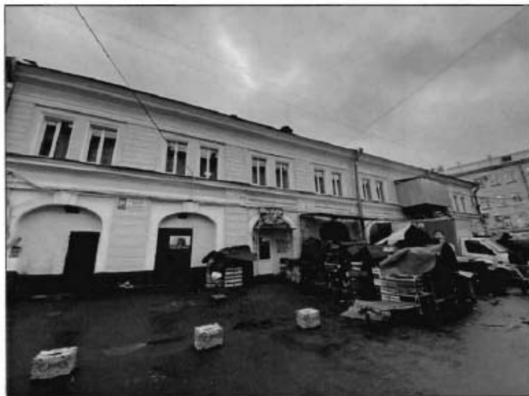
11. Фрагмент восточного фасада части объекта культурного наследия.
