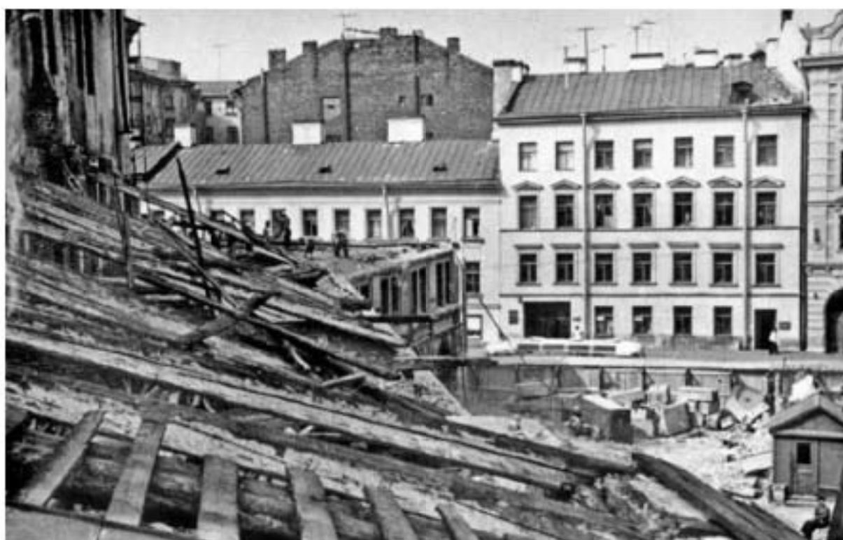
99. Фотофиксация начала разборки южного дворового флигеля. 1965 г. // Источник: Архив ФГУП «Гидрографическое предприятие» Госкорпорации «Росатом». Московский пр., д. 12, Санкт-Петербург.
