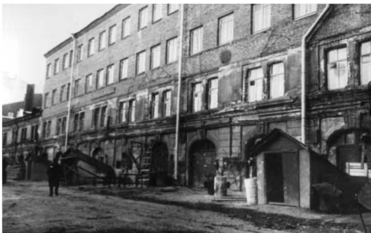
104. Фотофиксация завершения строительных работ на дворовом фасаде жилого флигеля. 1966 г. // Источник: Архив ФГУП «Гидрографическое предприятие» Госкорпорации «Росатом». Московский пр., д. 12, Санкт-Петербург.
