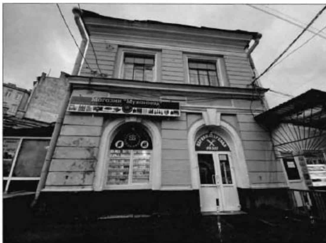
12. Северный фасад части объекта культурного наследия.
