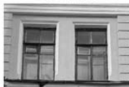
Восточный и западный фасады
