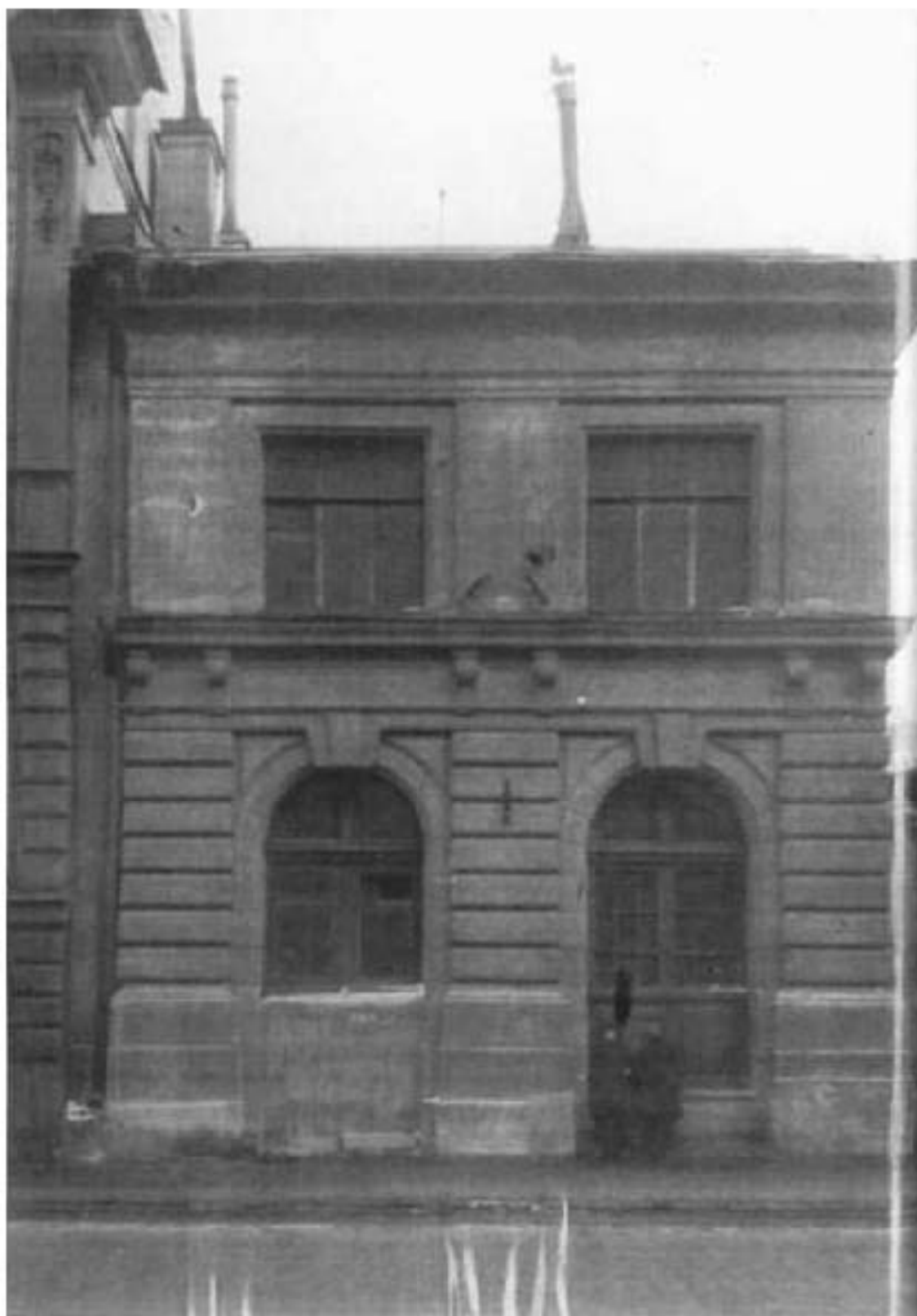
67. Паспорт фасада № 843, дома 10-12 по Международному проспекту, Октябрьского района. Литер А. Лицевой фасад. Здание складов. Владелец: Трест нежилого фонда эксплуатационного хозяйства № 16. Назначение здания – склады. 1941 г.
