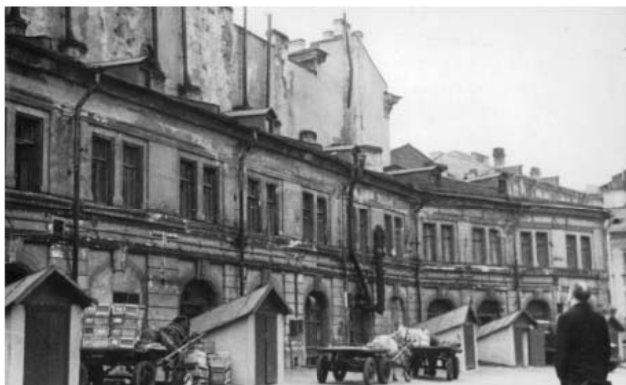
98. Фотофиксация перед перестройкой южного дворового флигеля. 1965 г. // Источник: Архив ФГУП «Гидрографическое предприятие» Госкорпорации «Росатом». Московский пр., д. 12, Санкт-Петербург.
