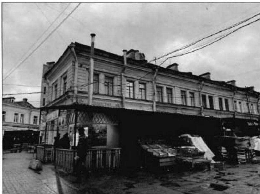
13. Фрагмент западного фасада части объекта культурного наследия.
