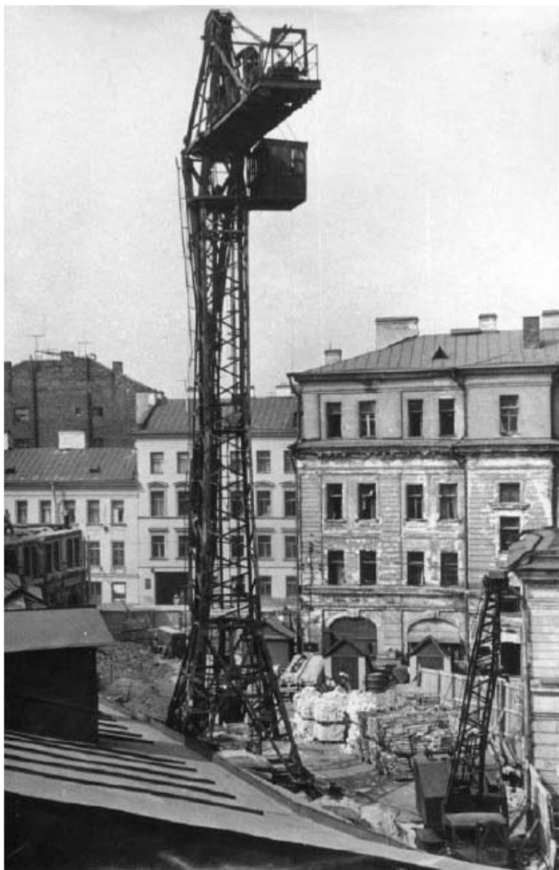
101. Фотофиксация строительных работ по реконструкции южного дворового флигеля. 1965 г. // Источник: Архив ФГУП «Гидрографическое предприятие» Госкорпорация «Росатом». Московский пр., д. 12, Санкт-Петербург.
