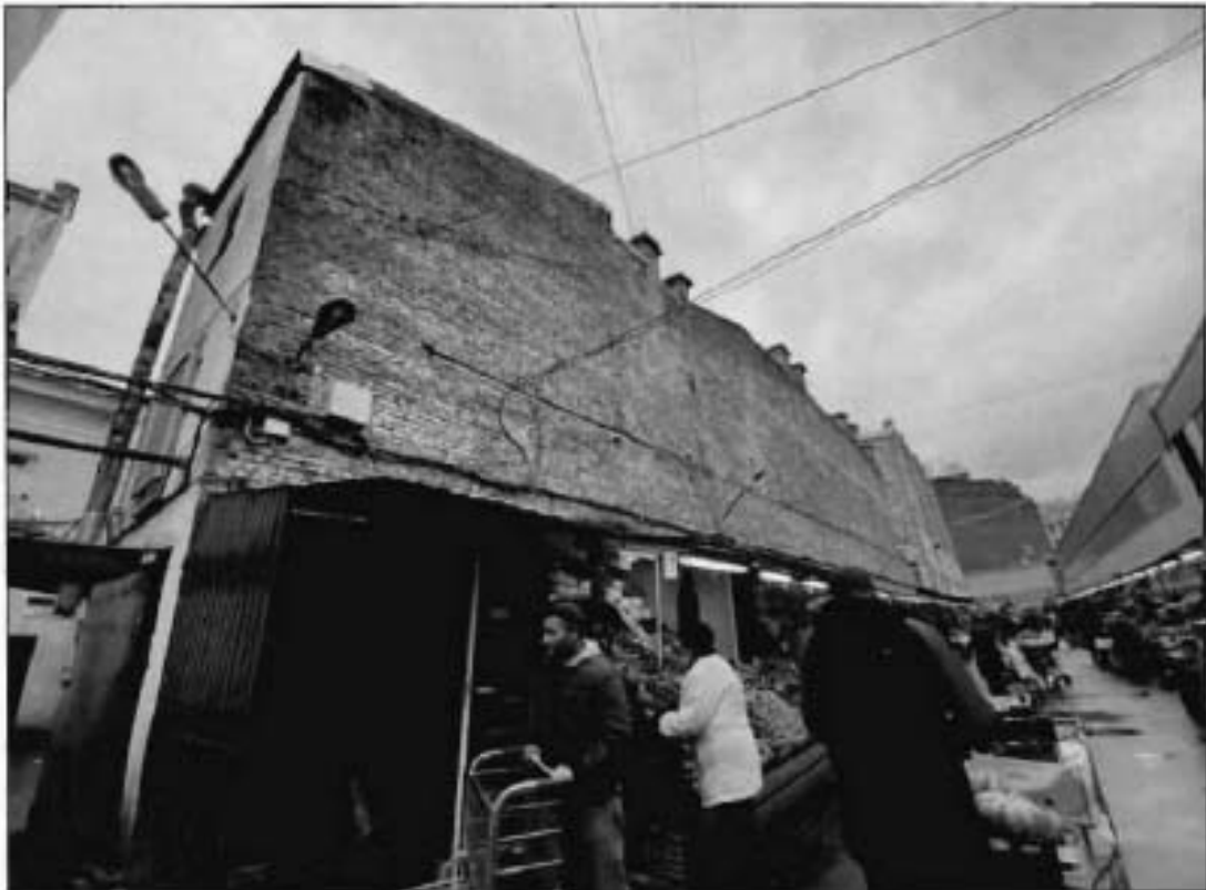
15. Северо-восточный фасад части объекта культурного наследия.
