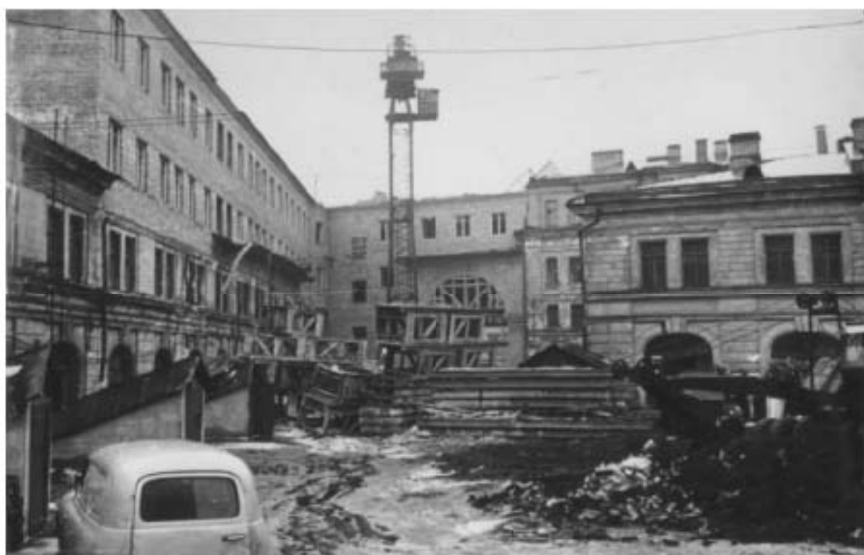
102. Фотофиксация строительных работ на дворовых фасадах зданий и дворовой территории. 1966 г. // Источник: Архив ФГУП «Гидрографическое предприятие» Госкорпорации «Росатом». Московский пр., д. 12, Санкт-Петербург.
