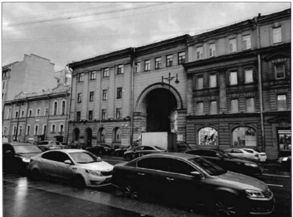
1. Западный лицевой фасад части объекта культурного наследия.
