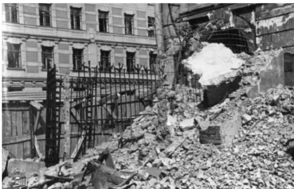
100. Фотофиксация разборки пристройки к центральному лицевому зданию со стороны южного торцевого фасада. 1965 г. // Источник: Архив ФГУП «Гидрографическое предприятие» Госкорпорации «Росатом». Московский пр., д. 12, Санкт-Петербург.
