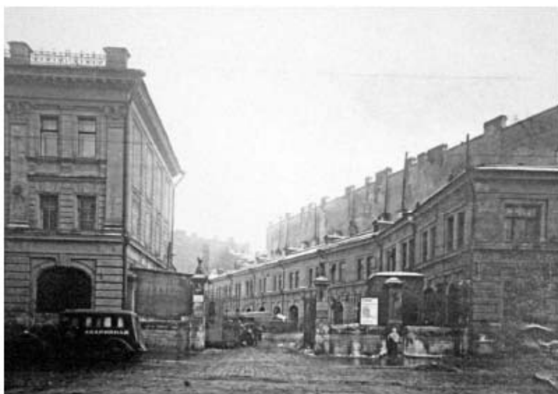
59. Фотофиксация лицевых фасадов 3-эт. здания, ложного флигеля, ограды и части двора к проекту реконструкции бывшего Рыбного рынка. 1939 г. // Источник: ЦГАКФФД. Гр. 777 59. Инд. 732.33.
