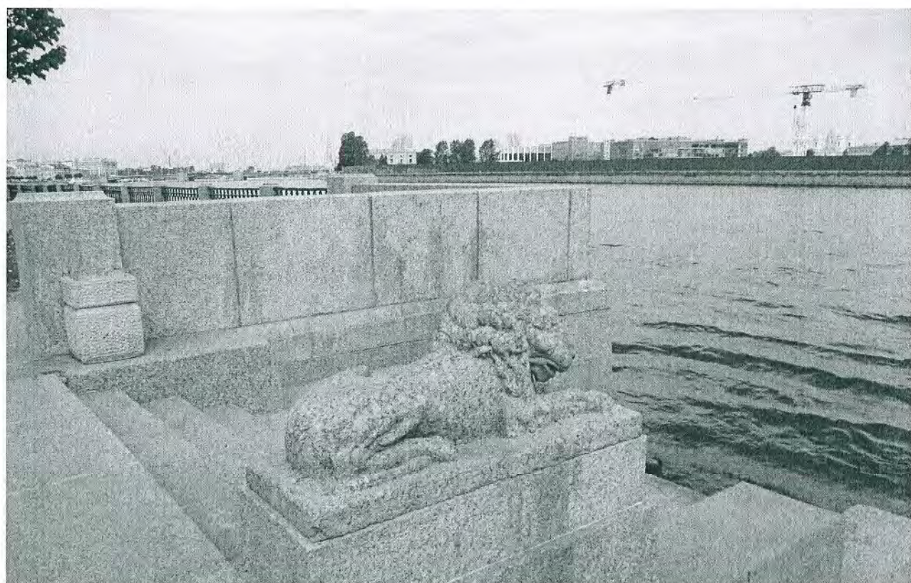
4. Западная скульптура льва. Отсутствие фрагмента (верхней части хвоста)
