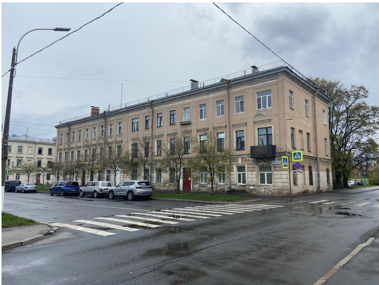
Фото 1. Вид на угол пересечения здания на улицах Ленинградской и Комсомола.
