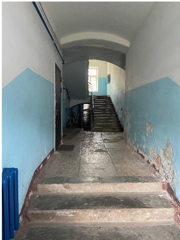
Фото 8. Вид на лестницу 1.
