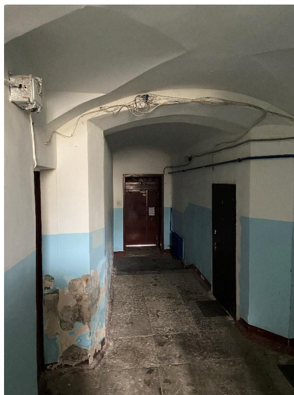
Фото 15. Вид на лестницу 1.
