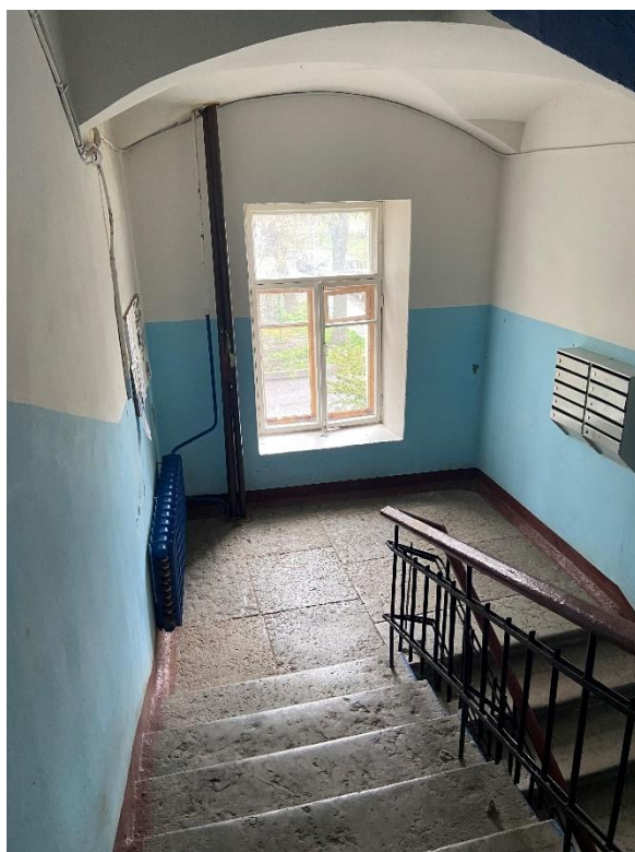
Фото 14. Вид на лестницу 1.
