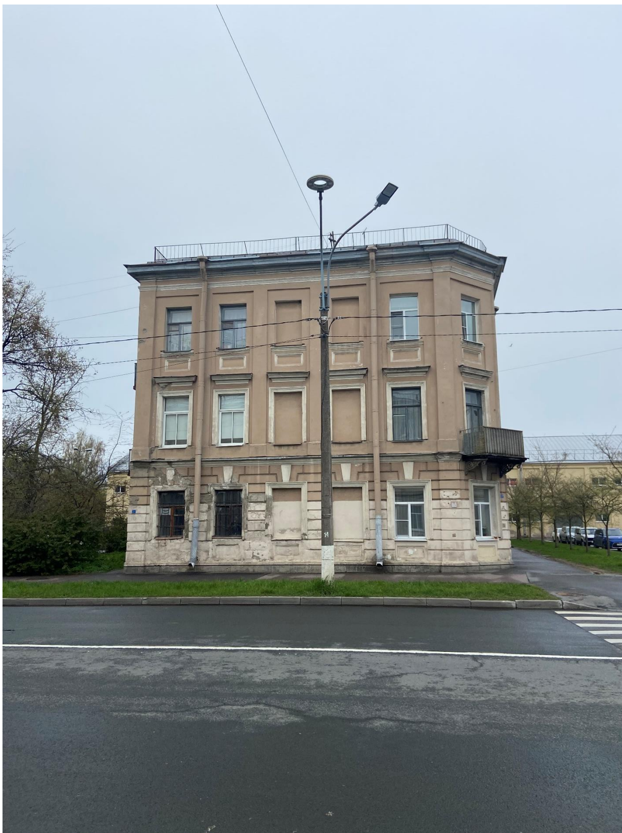
Фото 7. Вид на лицевой фасад по улице Аммермана.
