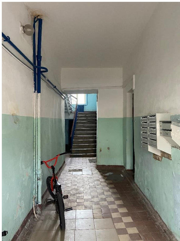
Фото 16. Вид на лестницу 2.
