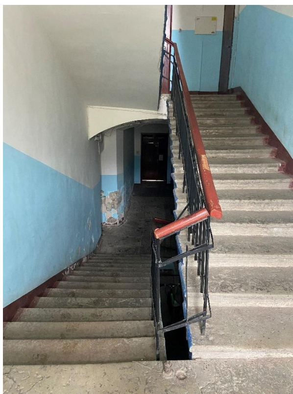
Фото 10. Вид на лестницу 1.
