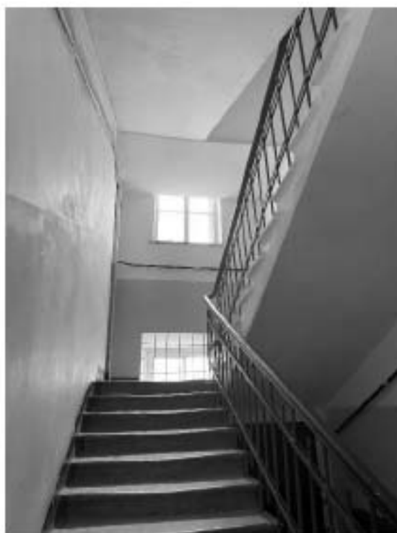
Фото 20. Вид лестницы 3 ЛК.
