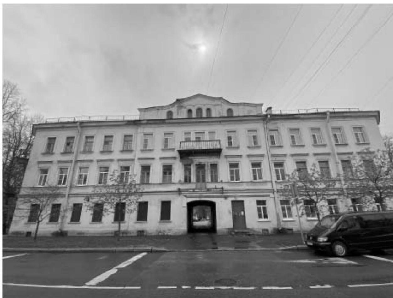
Фото 4. Вид на лицевой фасад дома № 12 по улице Ленинградской.
