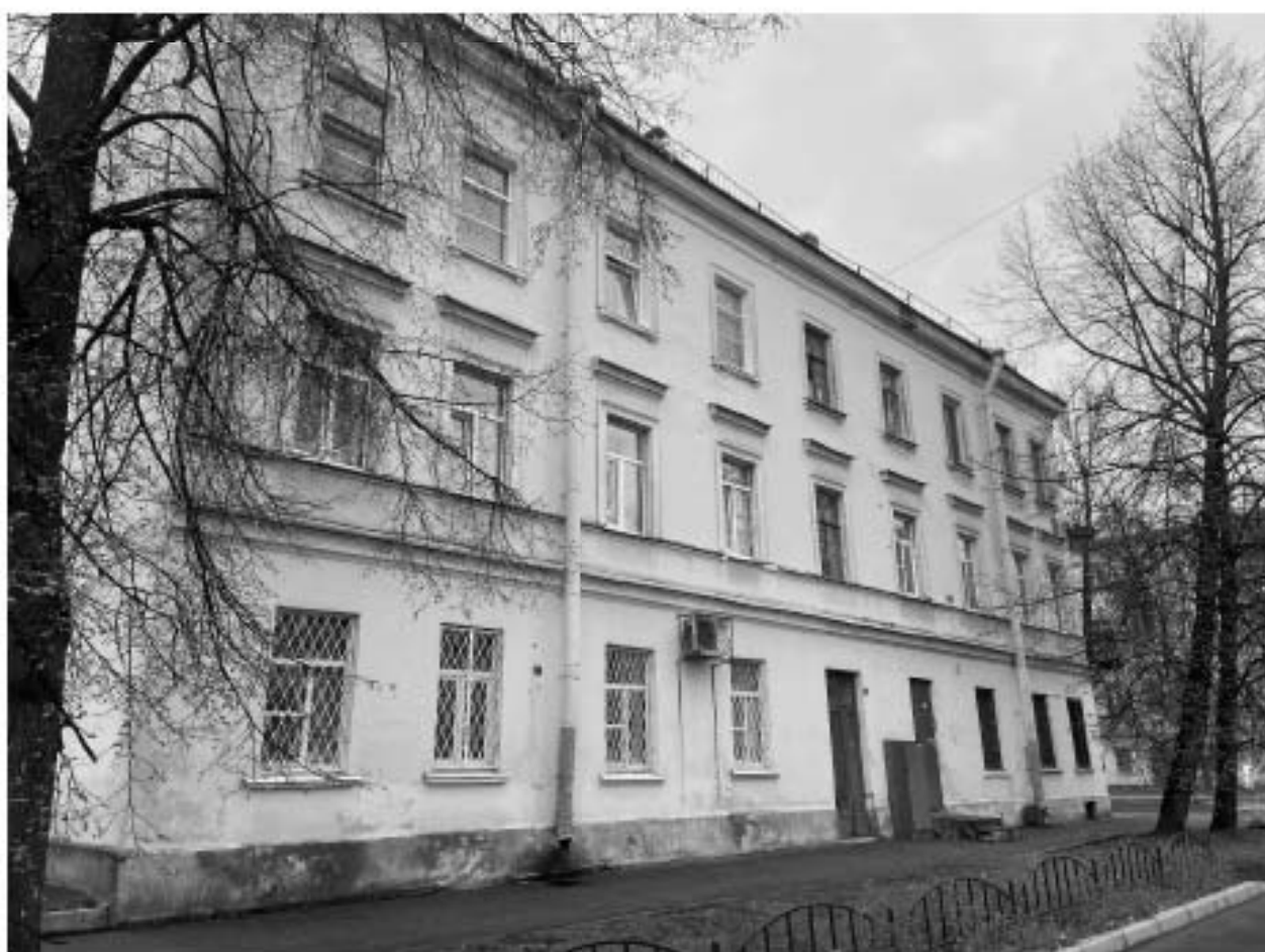
Фото 6. Вид на юго-восточный фасад дома № 12 по улице Ленинградской.
