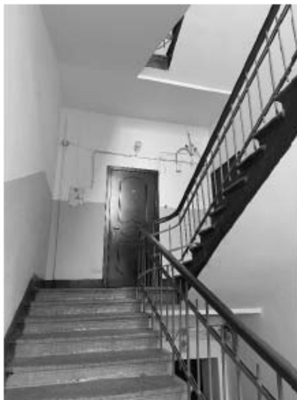
Фото 18. Вид лестницы 2 ЛК.
