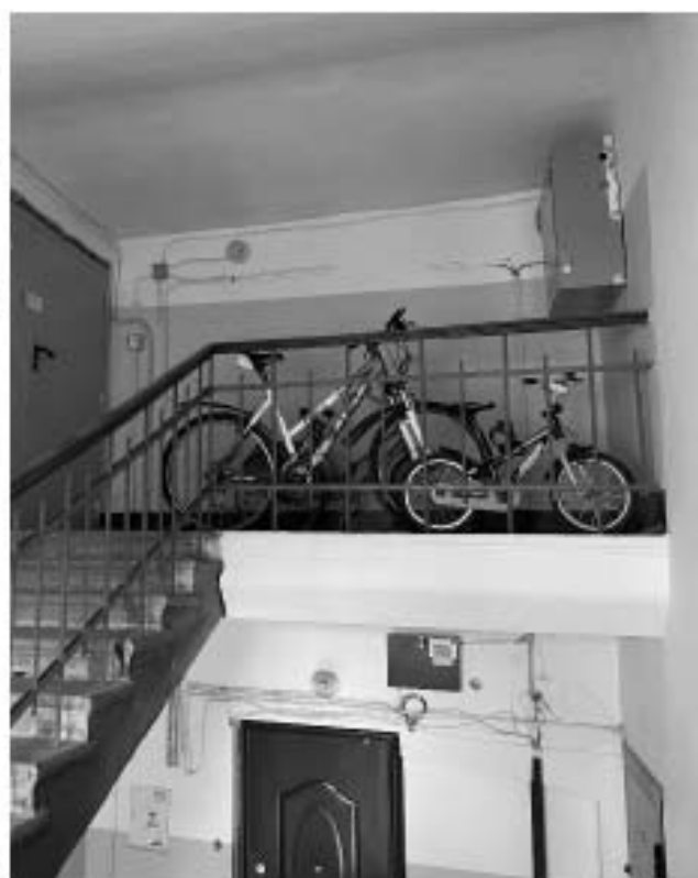
Фото 19. Вид лестницы 2 ЛК.
