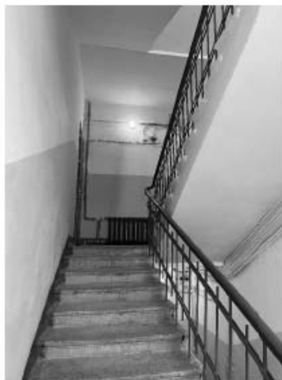
Фото 21. Вид лестницы 3 ЛК.
