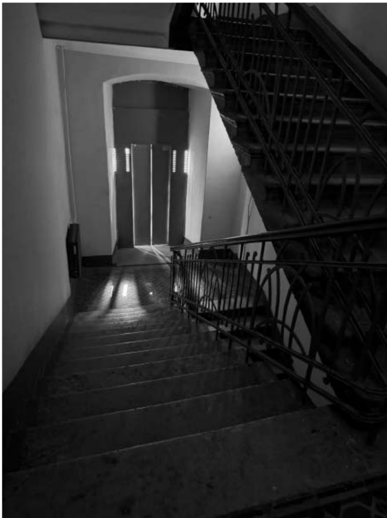
Фото 166. Вид на интерьер лестницы 2-ЛК объекта культурного наследия.
