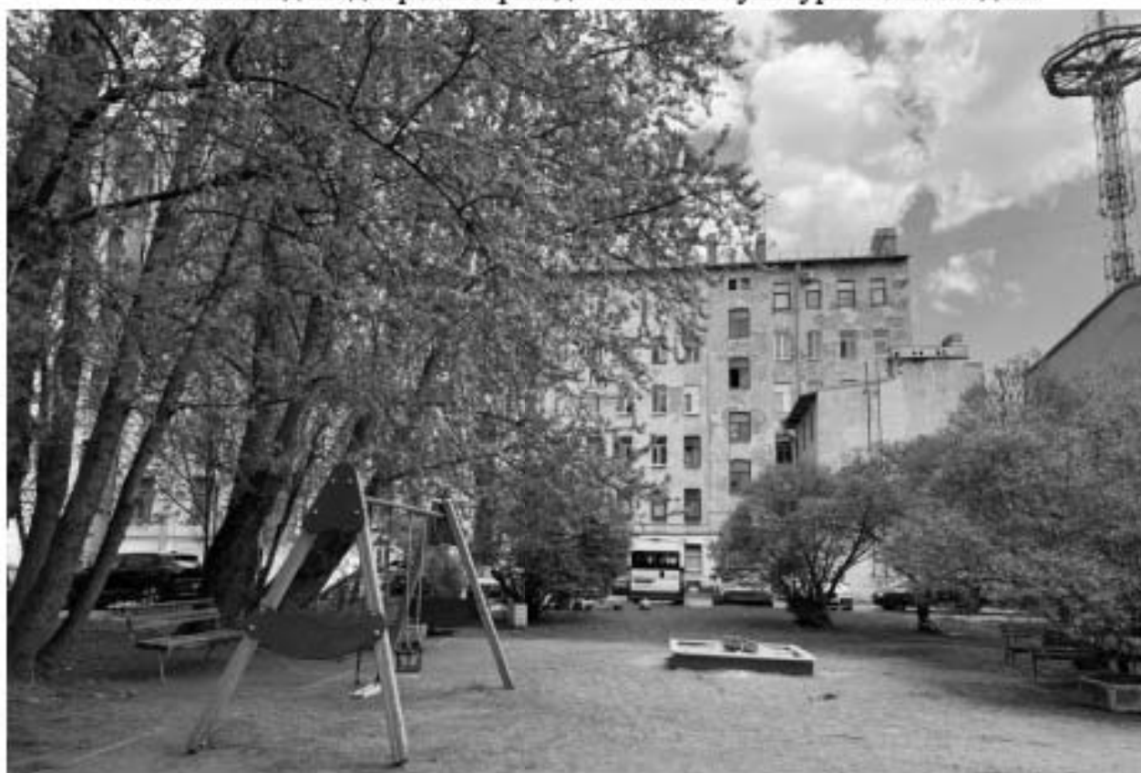
Фото 13. Вид на дворовые фасады объекта культурного наследия.
