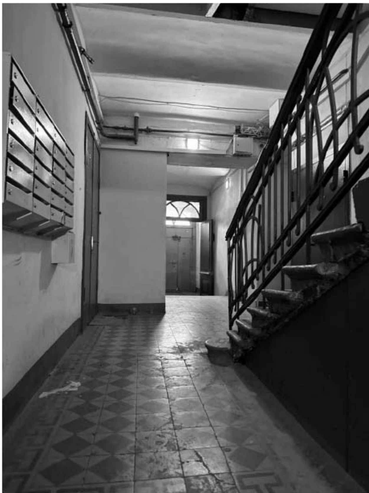
Фото 112. Вид на интерьер вестибюля лестницы 4-ЛК объекта культурного наследия.
