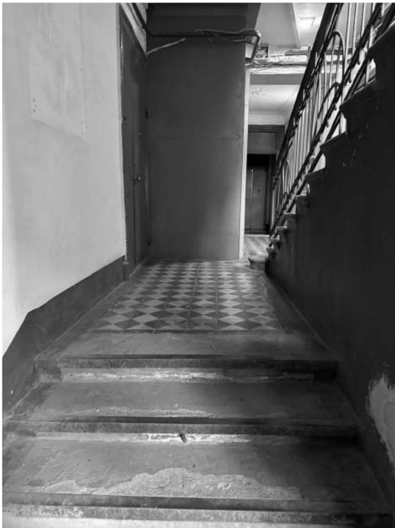
Фото 64. Вид на интерьер вестибюля лестницы 6-ЛК объекта культурного наследия.
