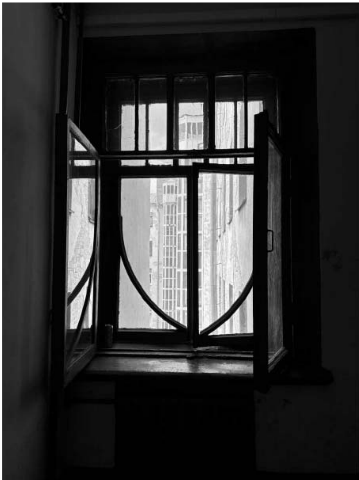
Фото 123. Вид на оконное заполнение в части лестницы 4-ЛК объекта культурного наследия.
