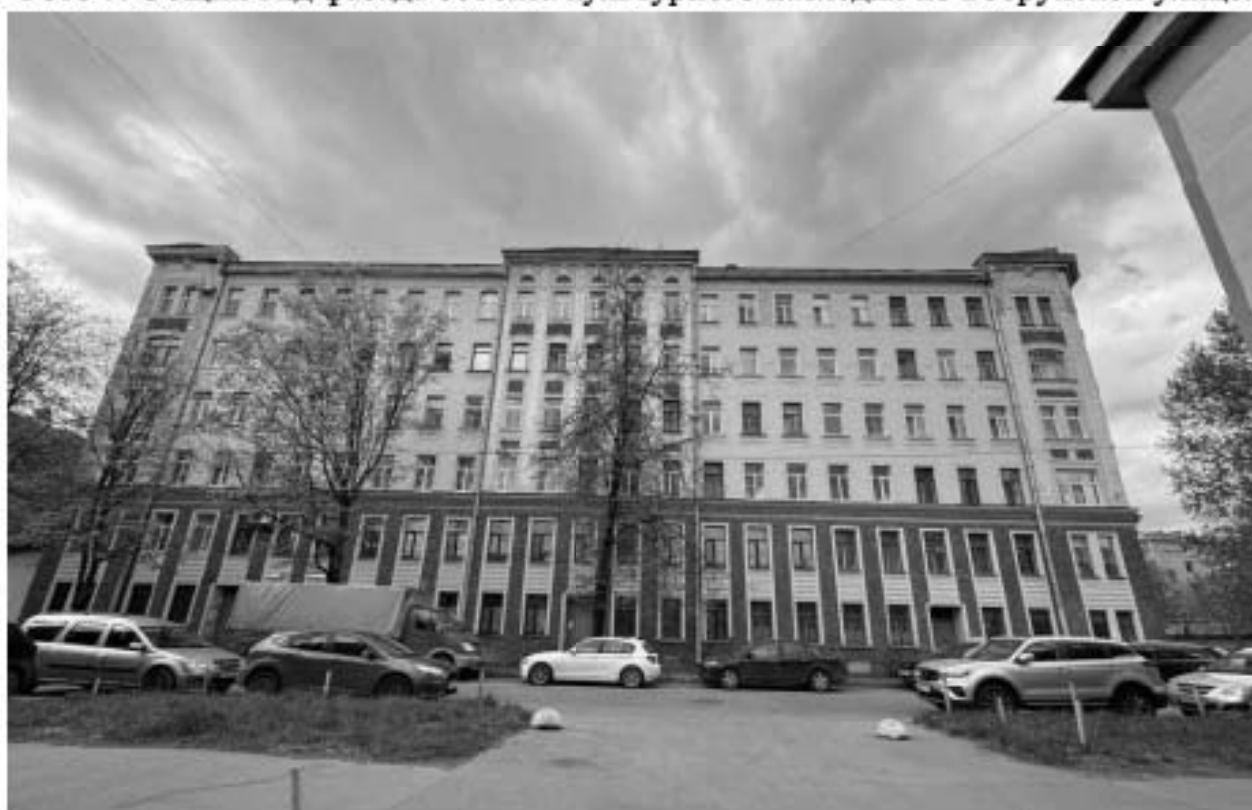
Фото 8. Общий вид фасада объекта культурного наследия по Бобруйской улице.
