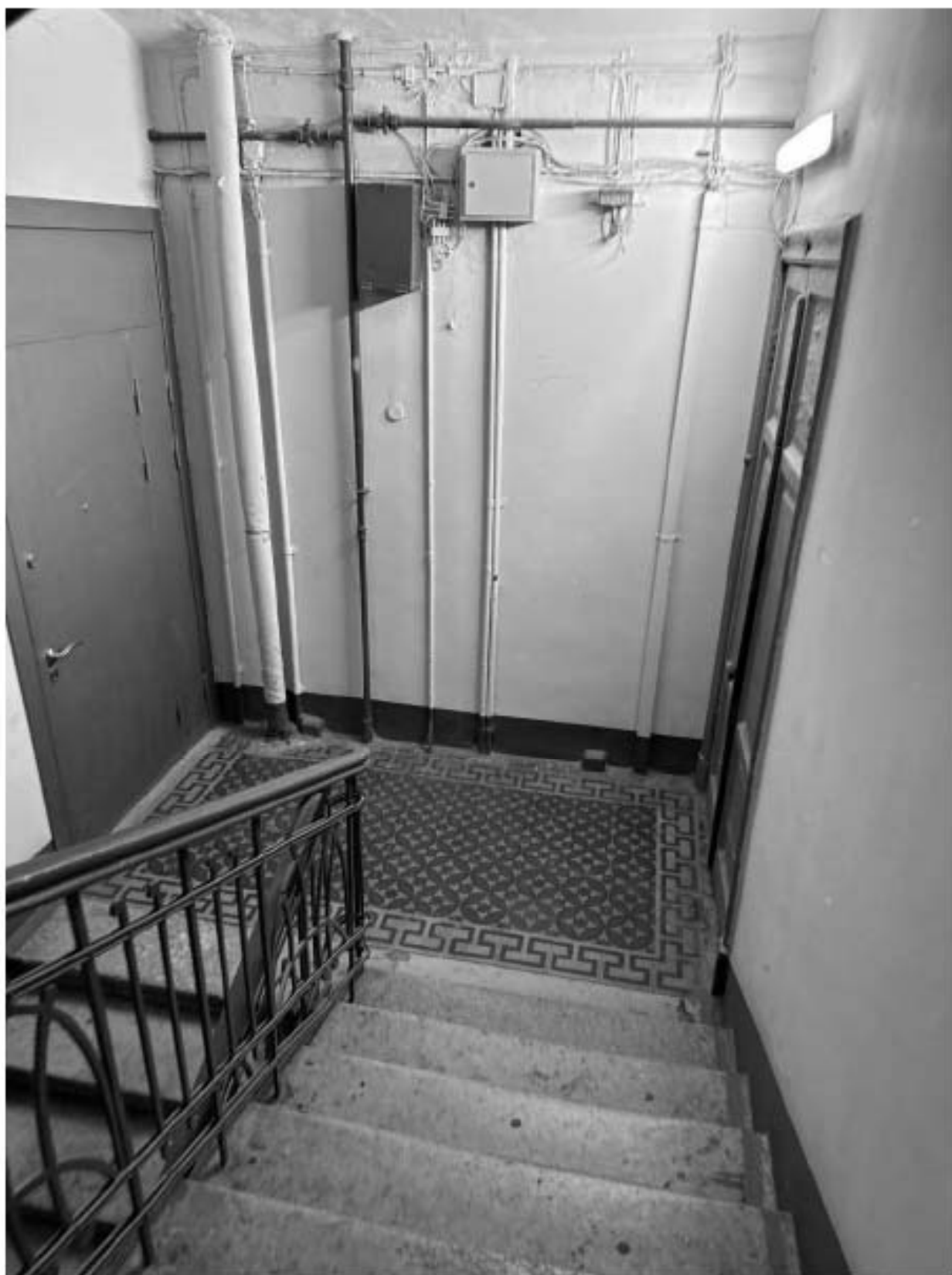
Фото 151. Вид на интерьер лестницы 3-ЛК объекта культурного наследия.
