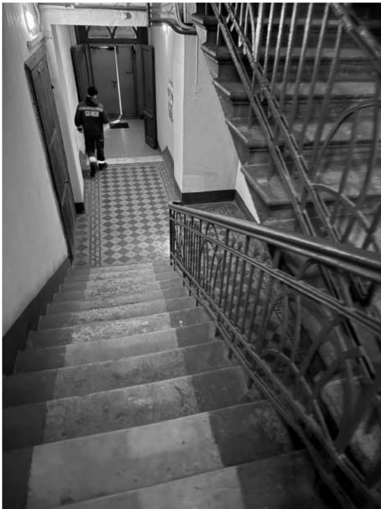
Фото 192. Вид на интерьер вестибюля лестницы 1-ЛК объекта культурного наследия.
