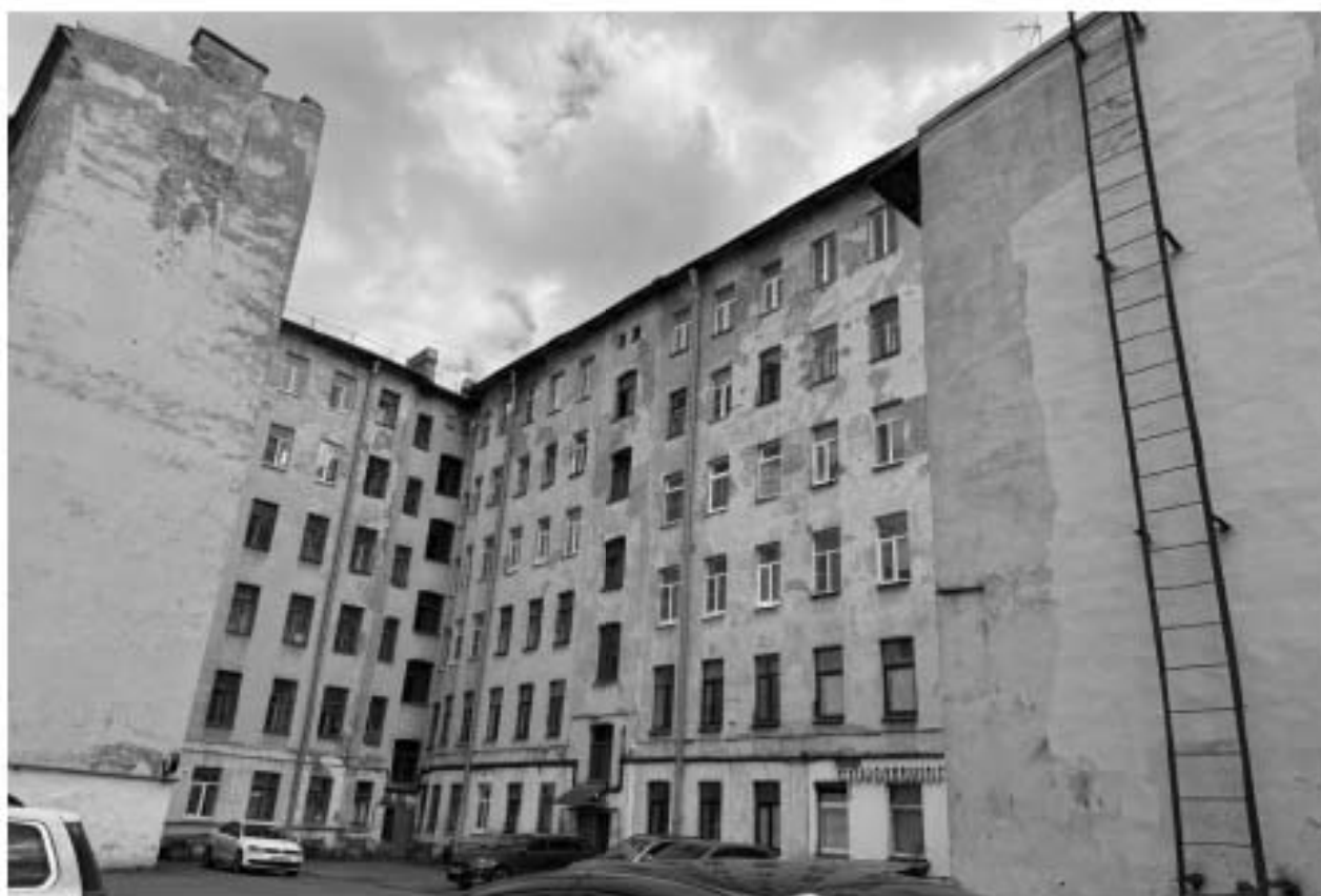
Фото 18. Вид на дворовые фасады объекта культурного наследия.
