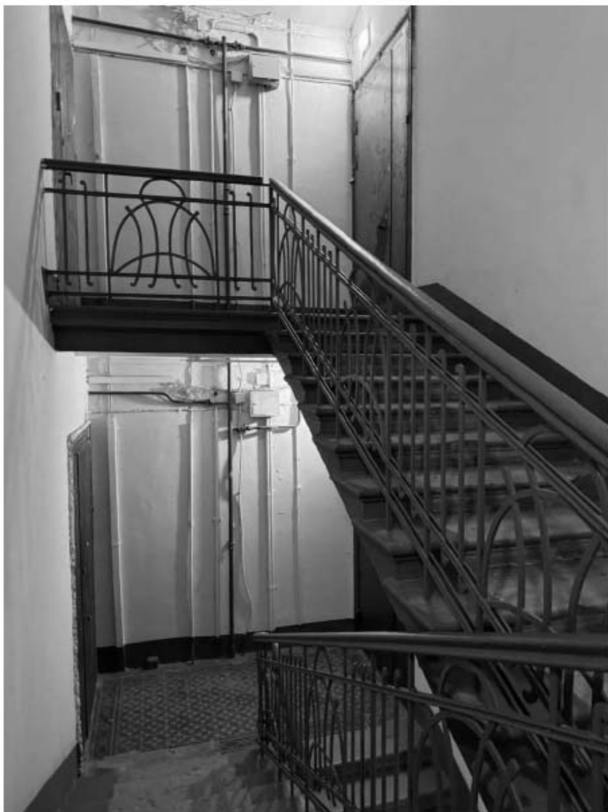
Фото 176. Вид на интерьер лестницы 1-ЛК объекта культурного наследия.
