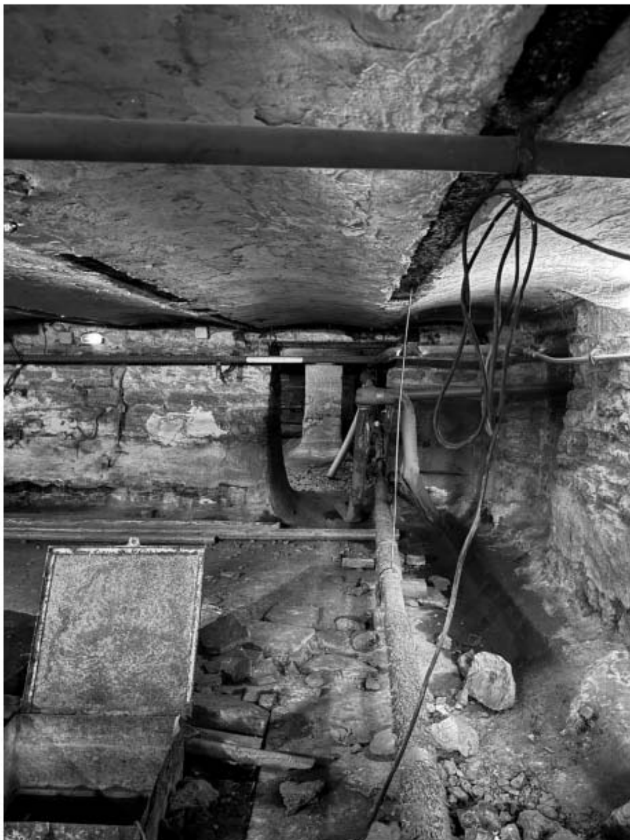
Фото 83. Вид на подвальное помещение объекта культурного наследия.
