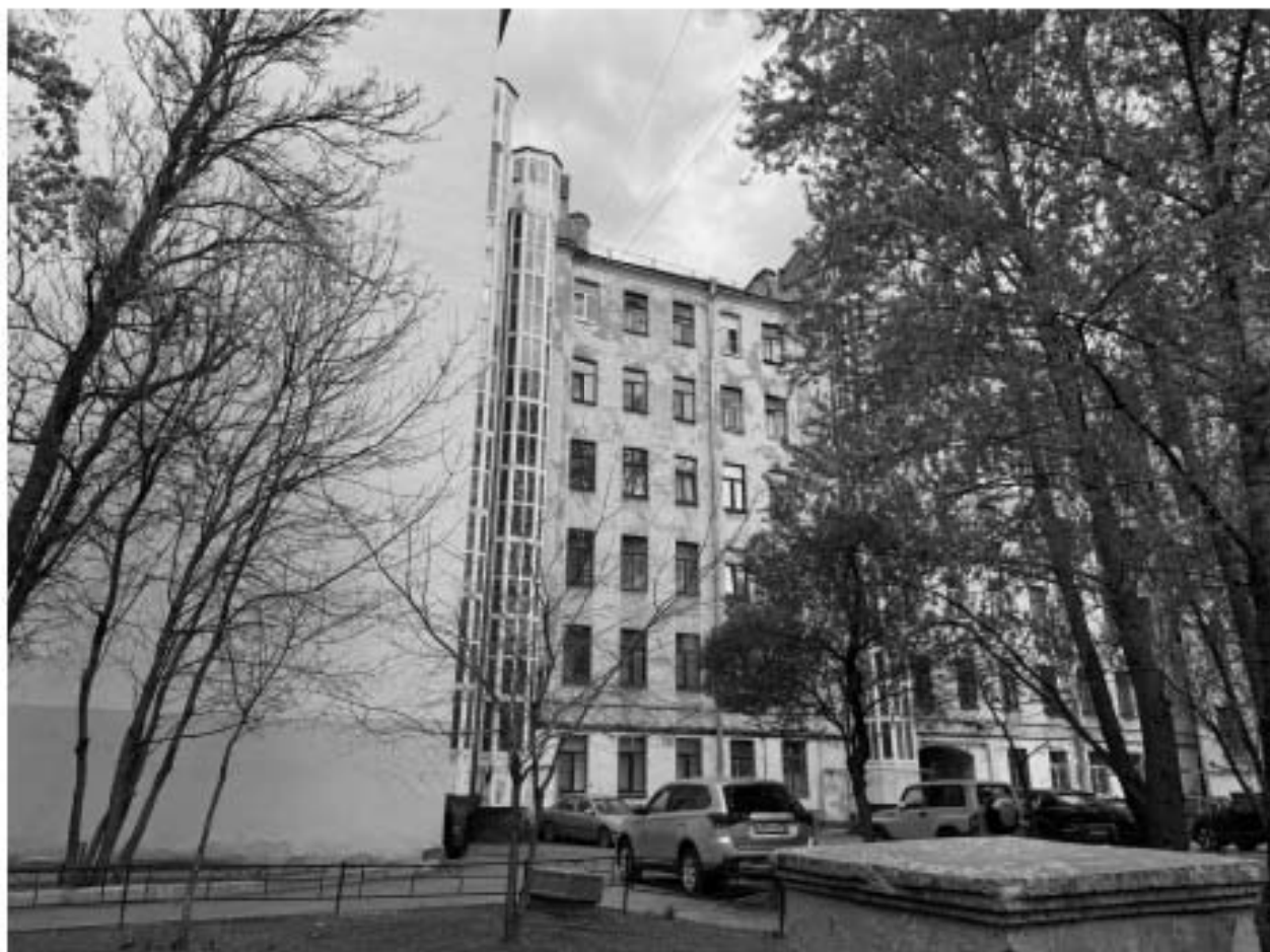
Фото 12. Вид на дворовые фасады объекта культурного наследия.
