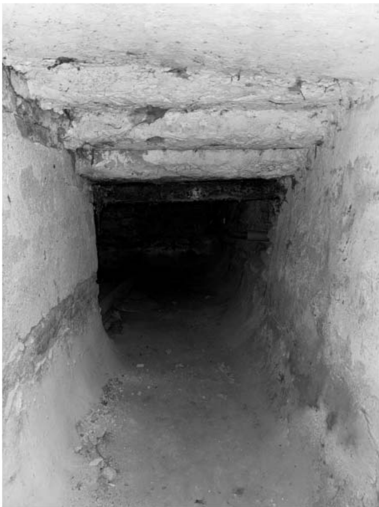
Фото 110. Вид на подвальное помещение объекта культурного наследия.
