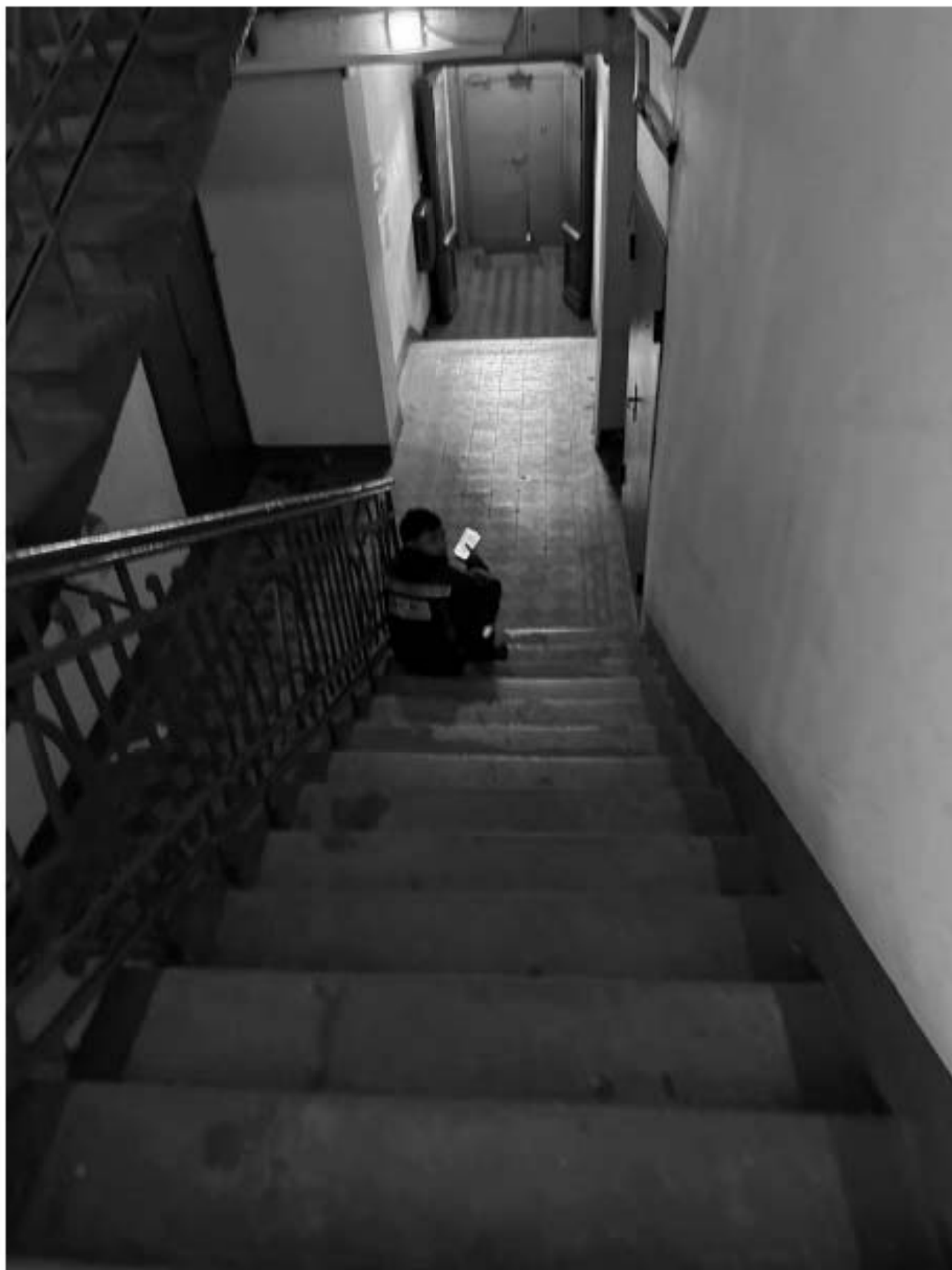
Фото 131. Вид на интерьер лестницы 4-ЛК объекта культурного наследия.
