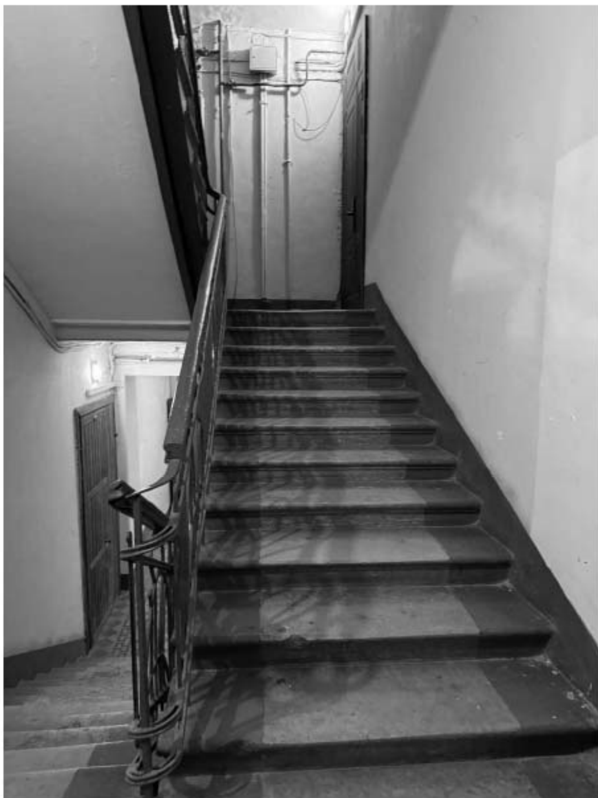
Фото 173. Вид на интерьер лестницы 1-ЛК объекта культурного наследия.
