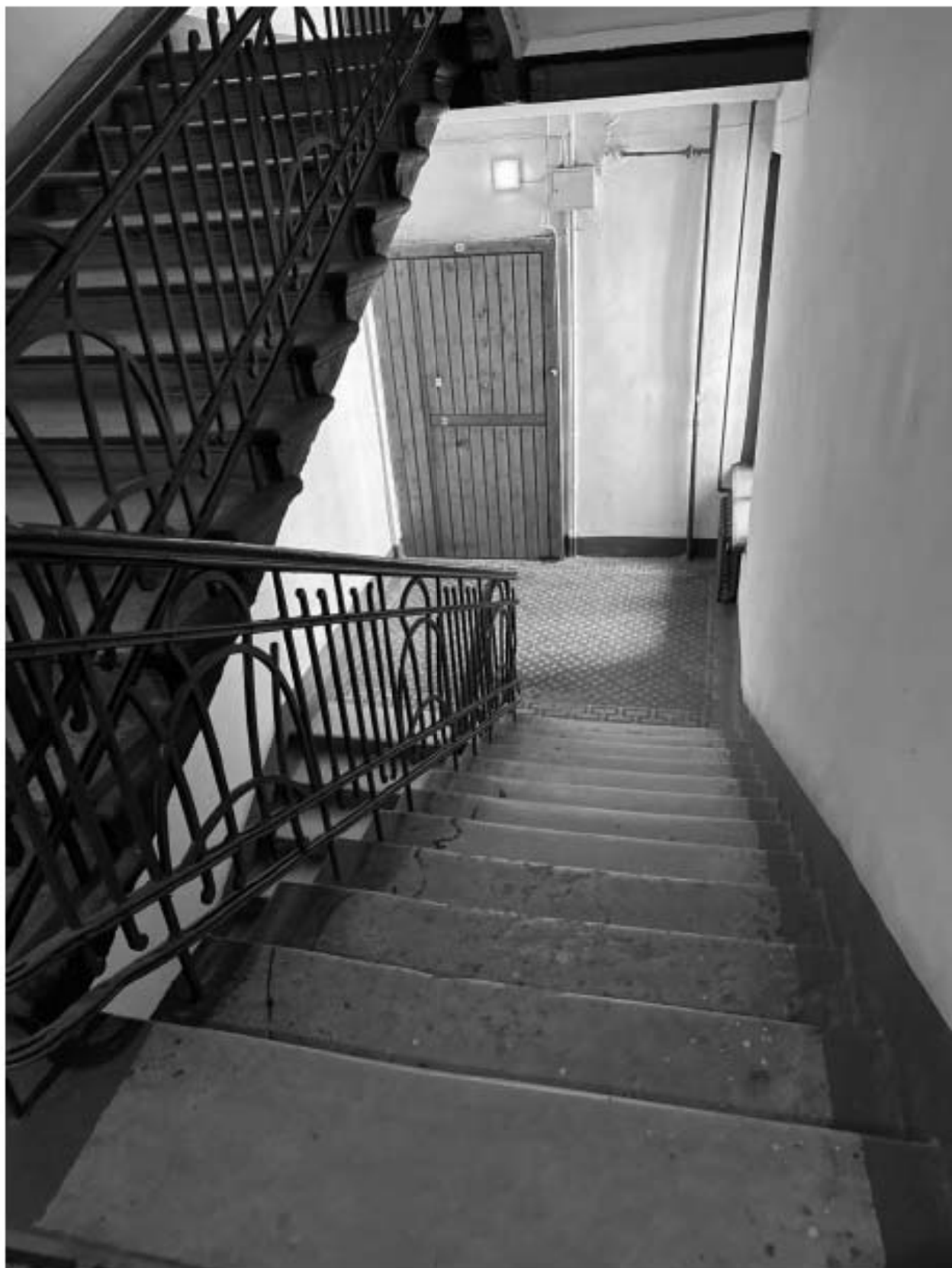
Фото 128. Вид на интерьер лестницы 4-ЛК объекта культурного наследия.
