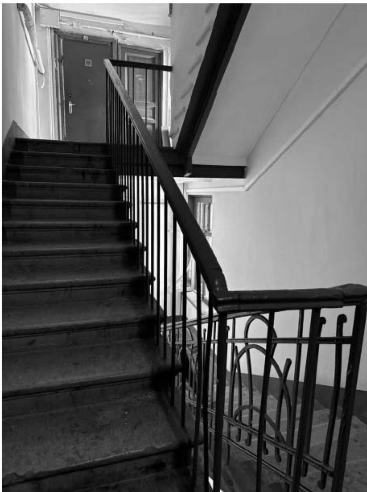
Фото 114. Вид на интерьер лестницы 4-ЛК объекта культурного наследия.
