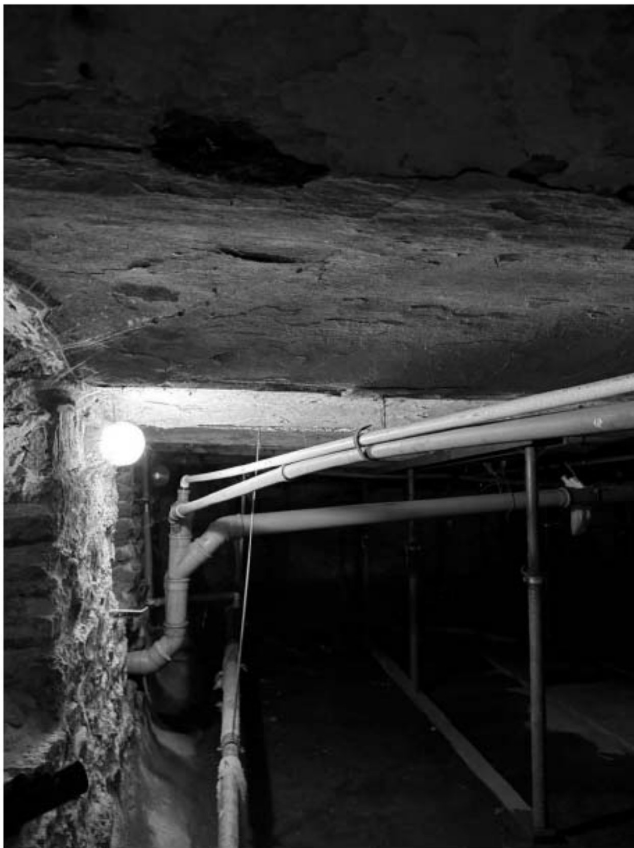
Фото 84. Вид на подвальное помещение объекта культурного наследия.
