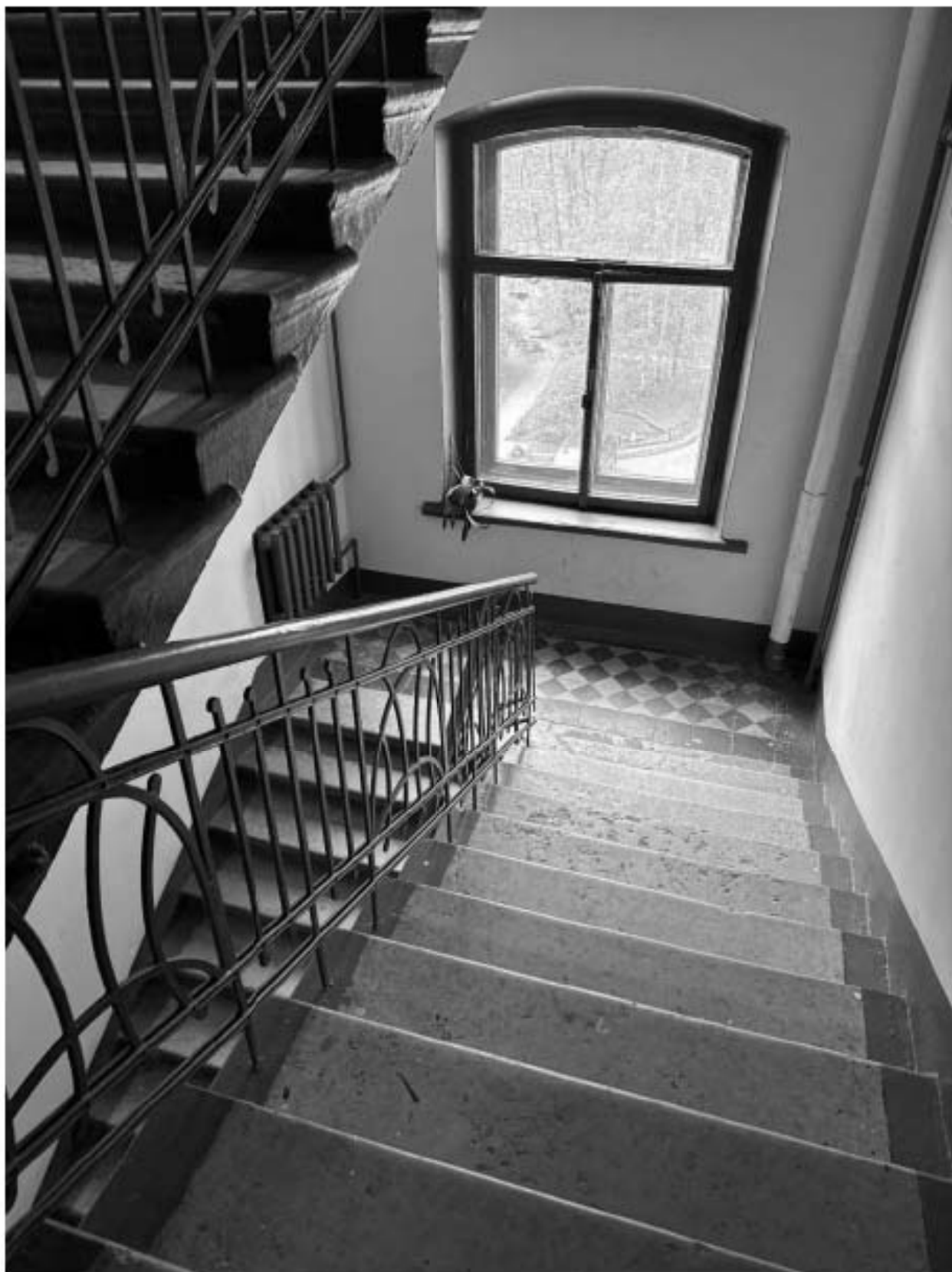
Фото 76. Вид на интерьер лестницы 6-ЛК объекта культурного наследия.
