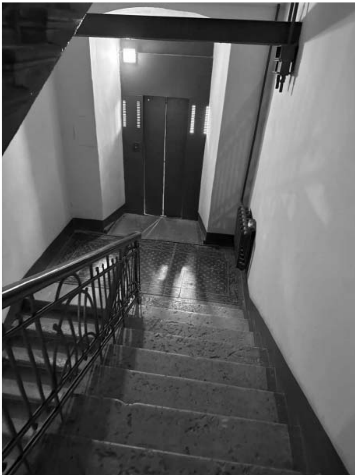
Фото 143. Вид на интерьер лестницы 3-ЛК объекта культурного наследия.
