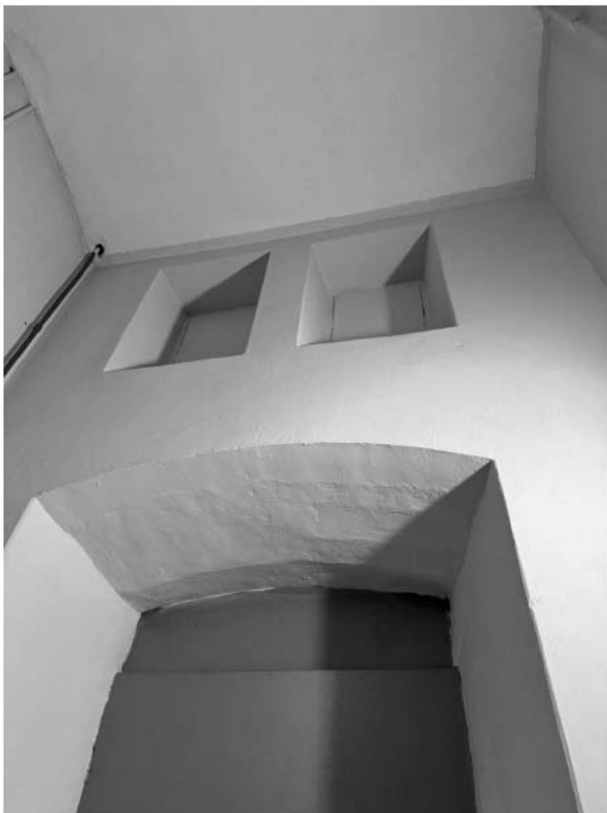
Фото 177. Вид на ниши в части лестницы 1-ЛК объекта культурного наследия.
