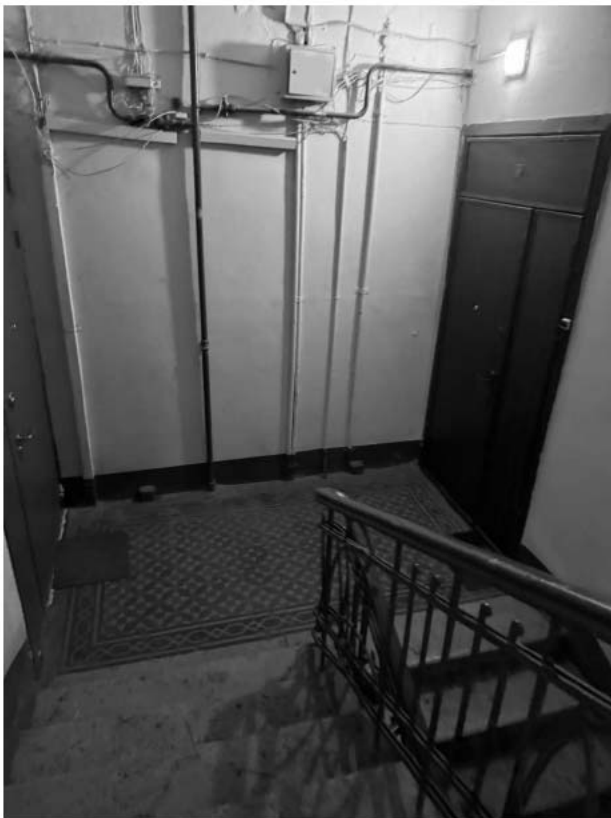
Фото 162. Вид на интерьер лестницы 2-ЛК объекта культурного наследия.
