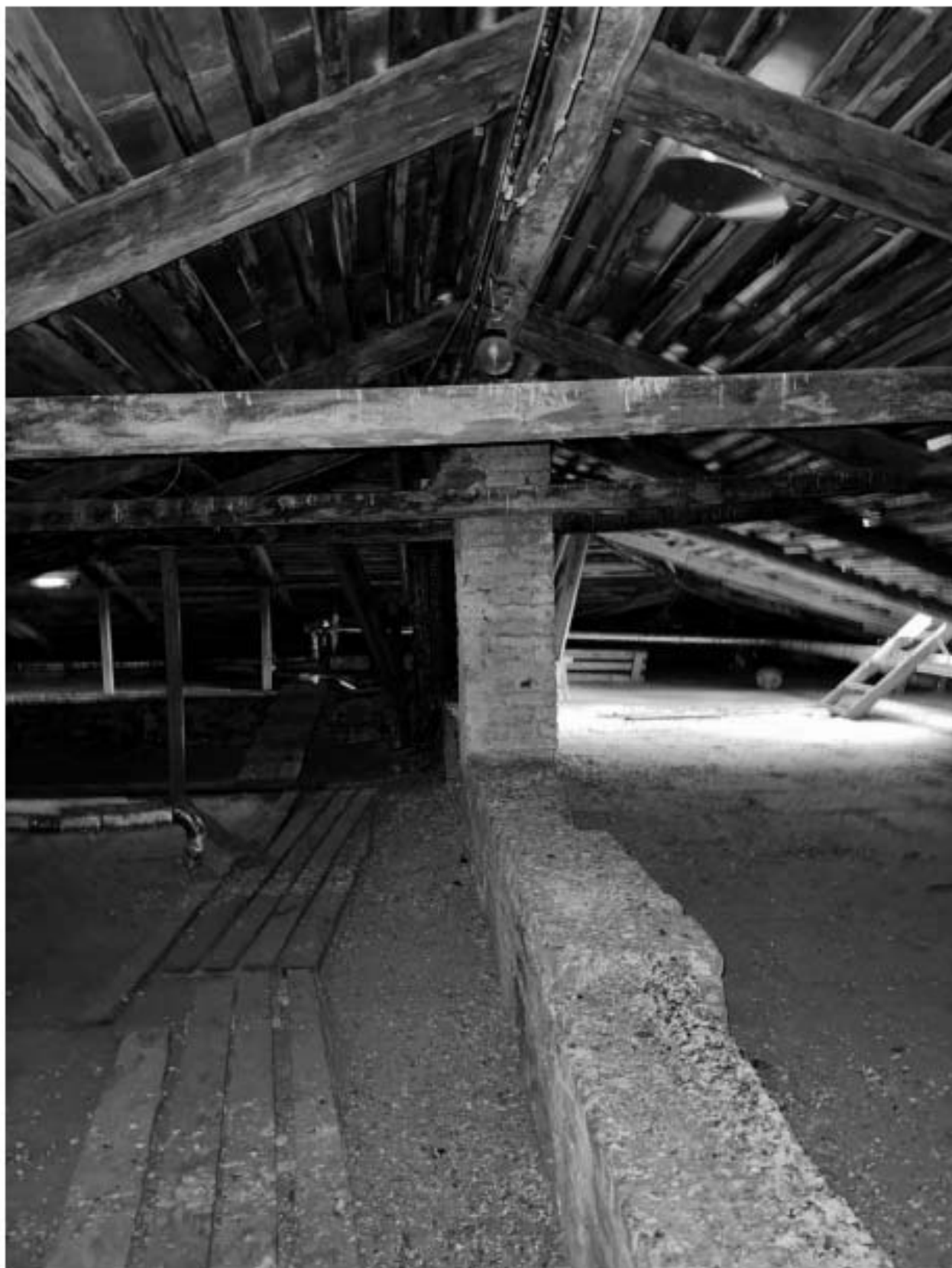
Фото 40. Вид на чердачное помещение объекта культурного наследия.
