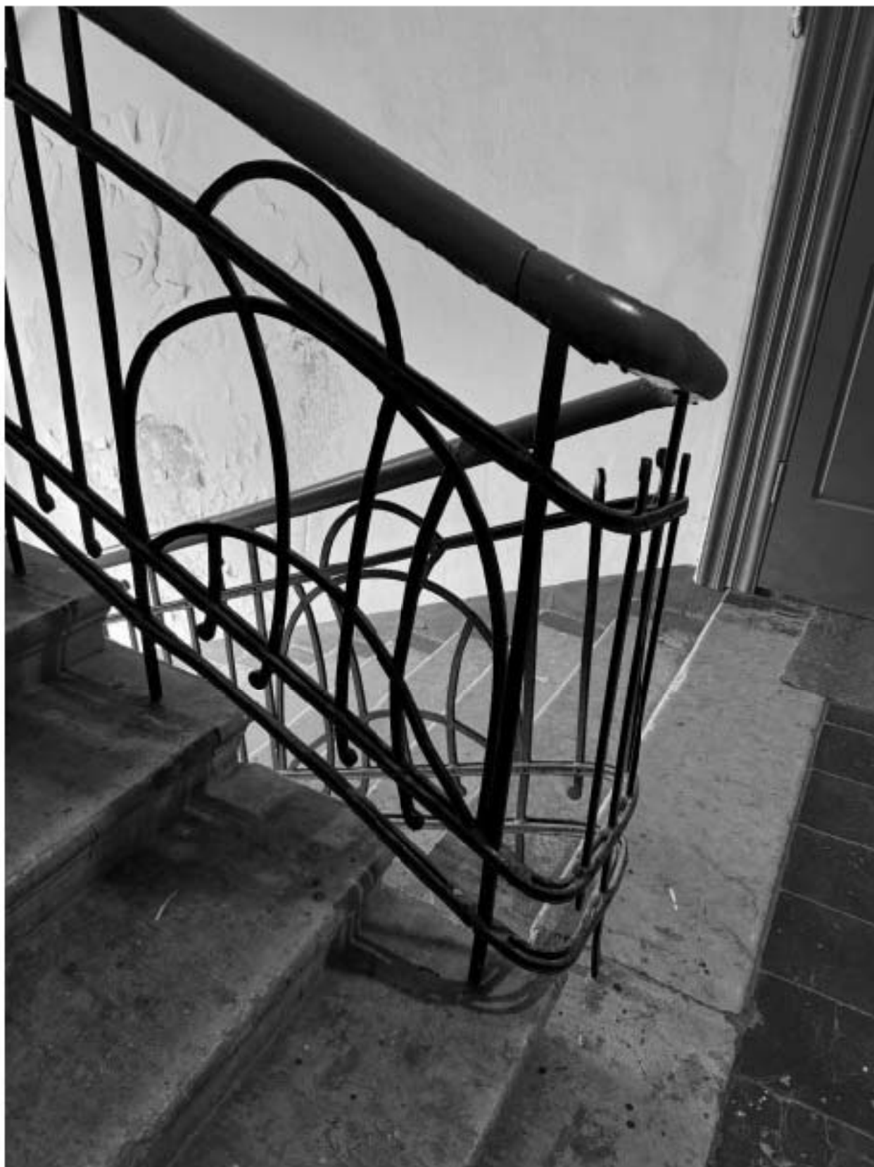
Фото 30. Вид на ограждение лестницы 7-ЛК объекта культурного наследия.
