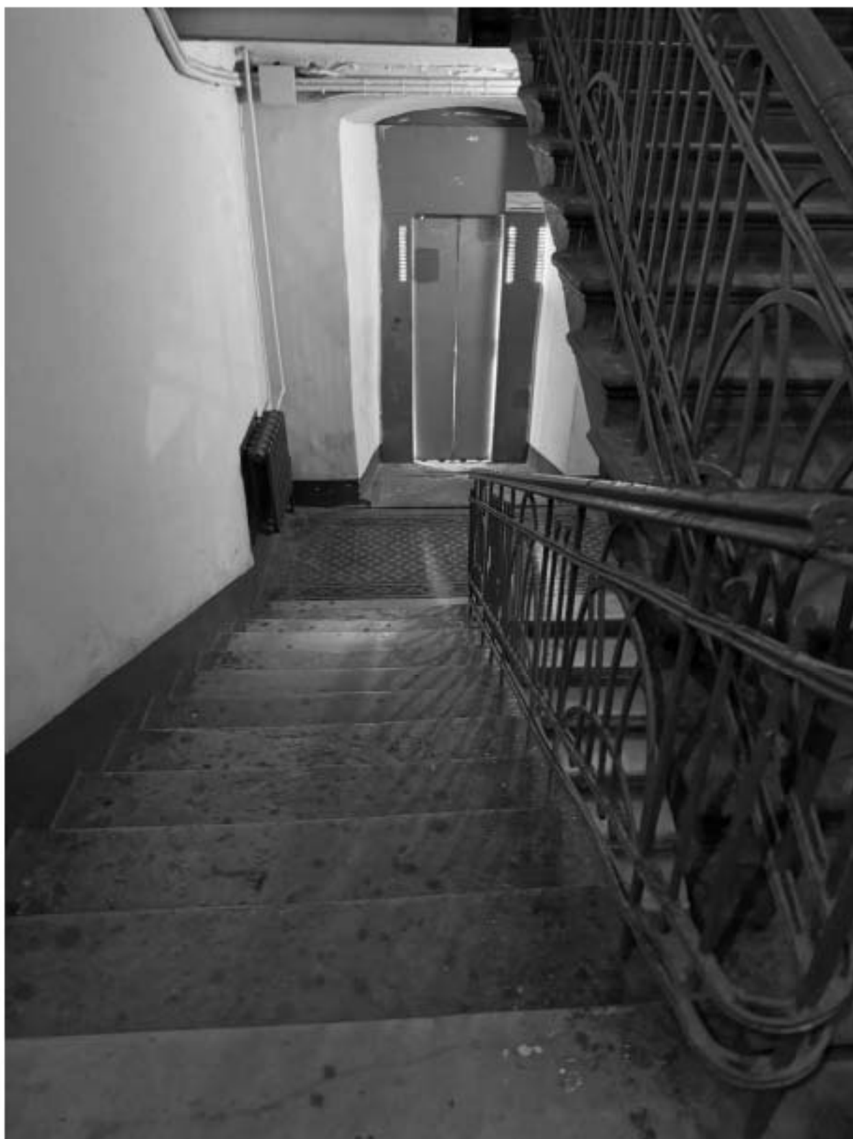
Фото 168. Вид на интерьер лестницы 2-ЛК объекта культурного наследия.
