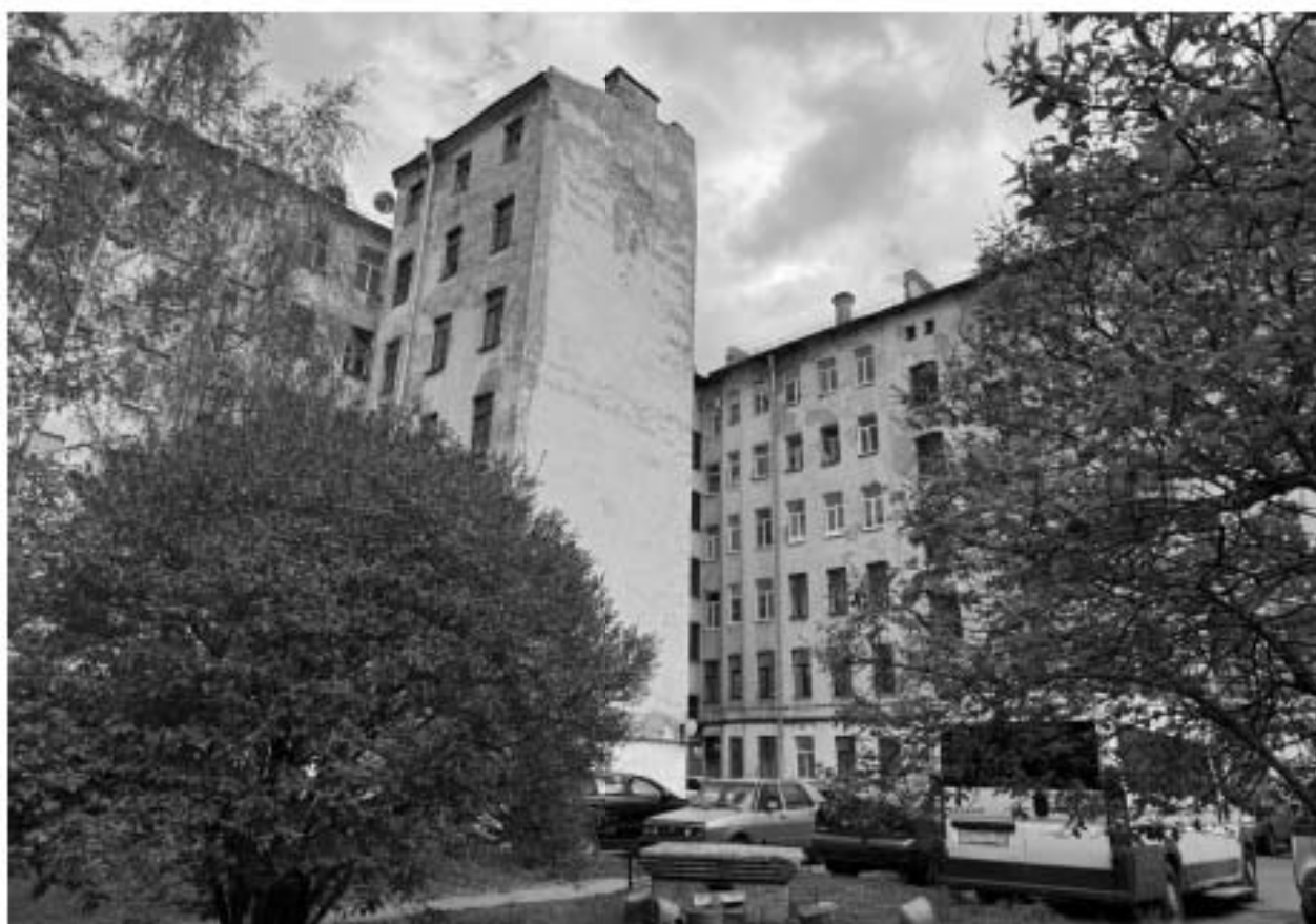
Фото 16. Вид на дворовые фасады объекта культурного наследия.
