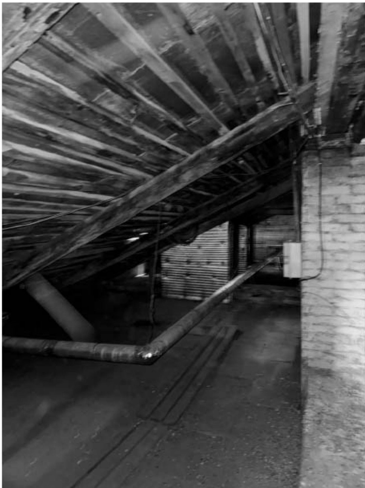
Фото 42. Вид на чердачное помещение объекта культурного наследия.
