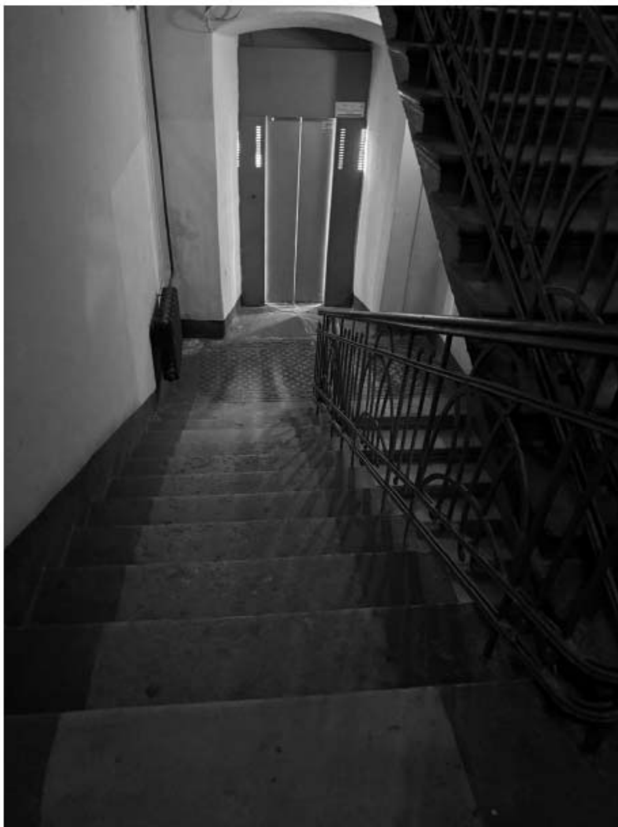
Фото 191. Вид на интерьер лестницы 1-ЛК объекта культурного наследия.
