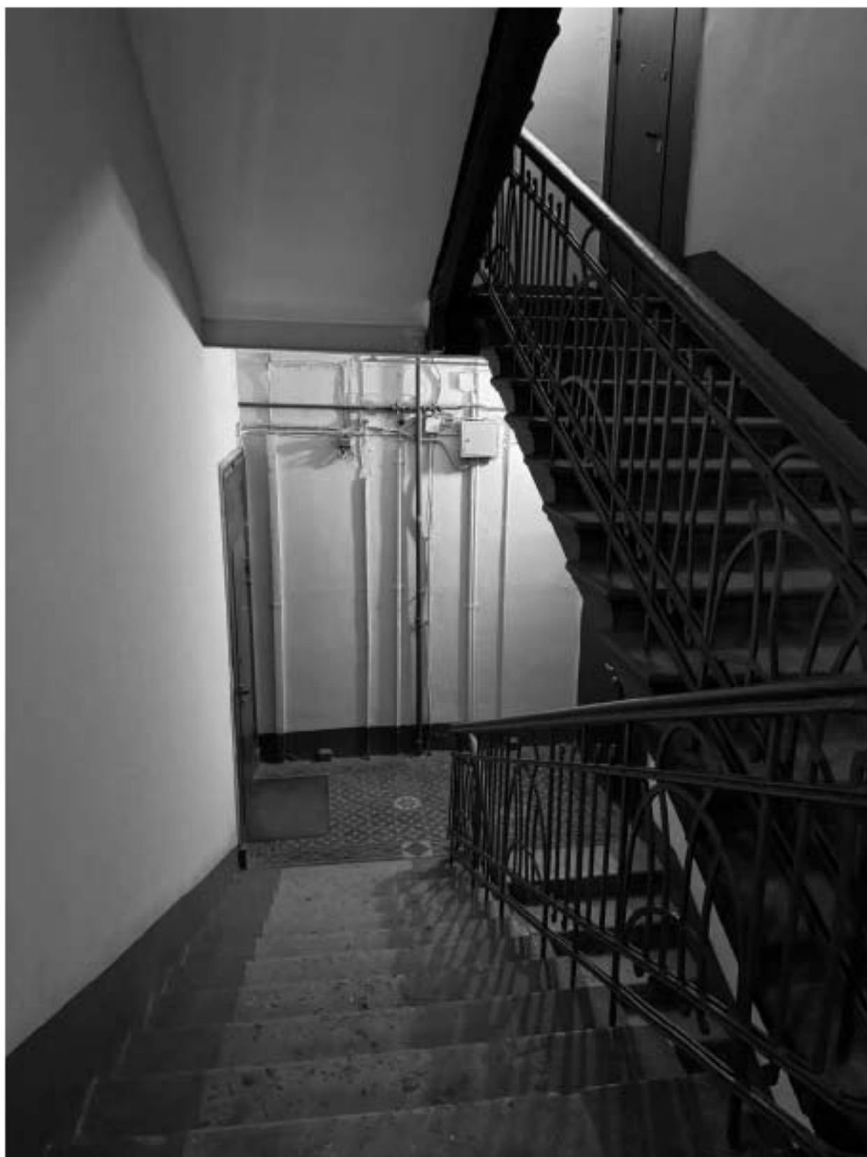
Фото 183. Вид на интерьер лестницы 1-ЛК объекта культурного наследия.
