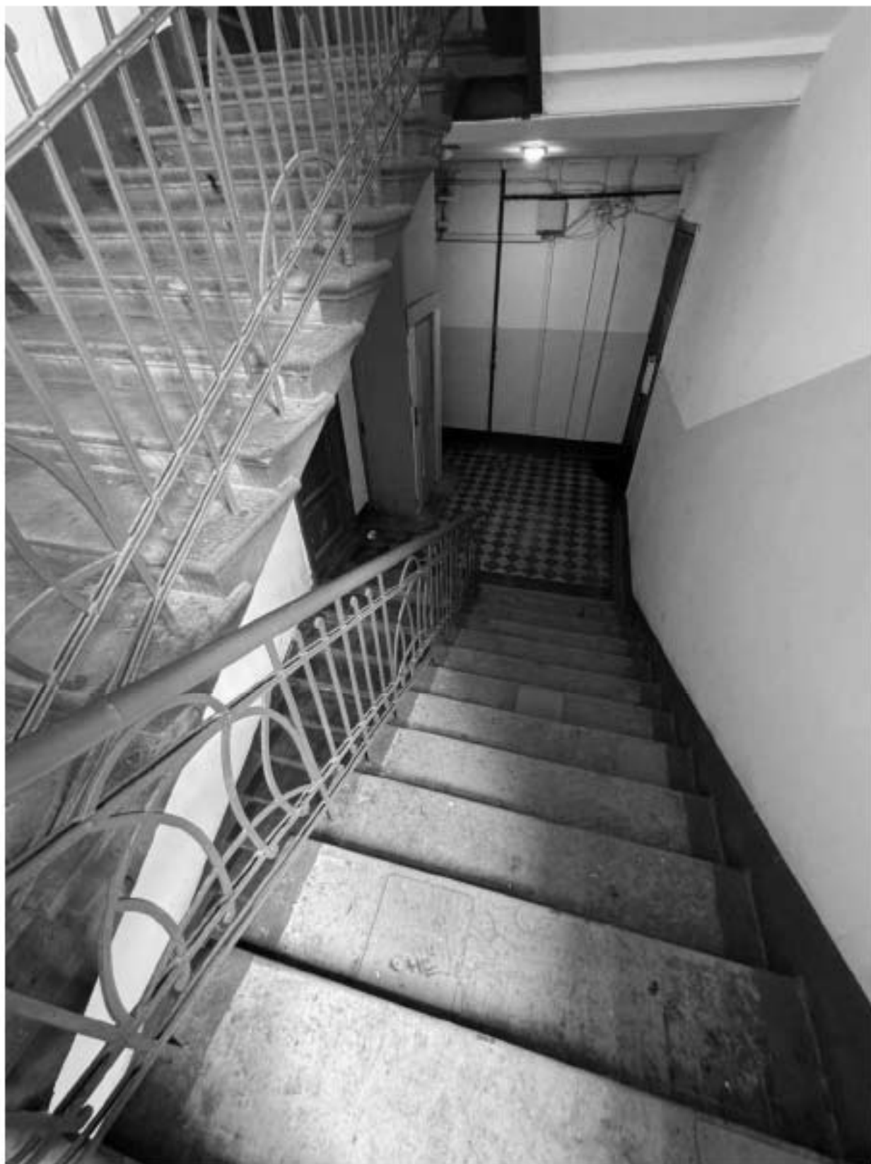
Фото 95. Вид на интерьер лестницы 5-ЛК объекта культурного наследия.
