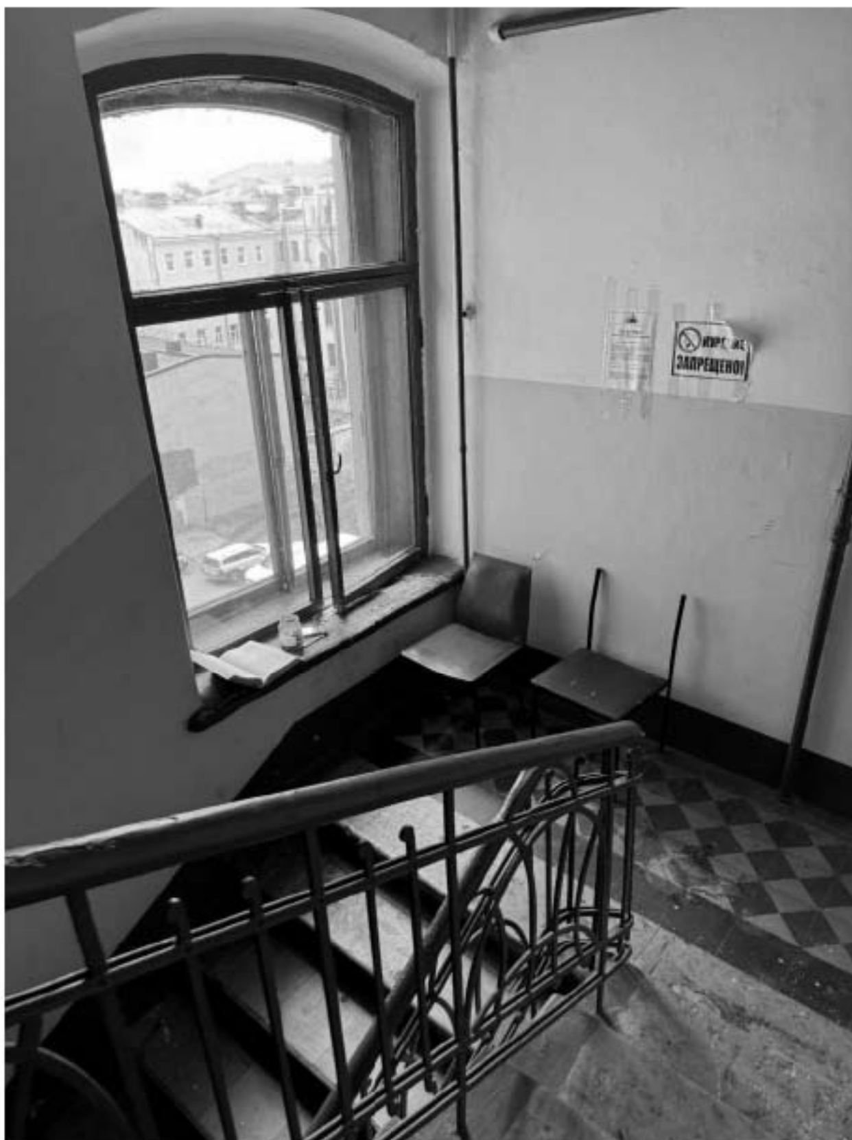
Фото 91. Вид на интерьер лестницы 5-ЛК объекта культурного наследия.
