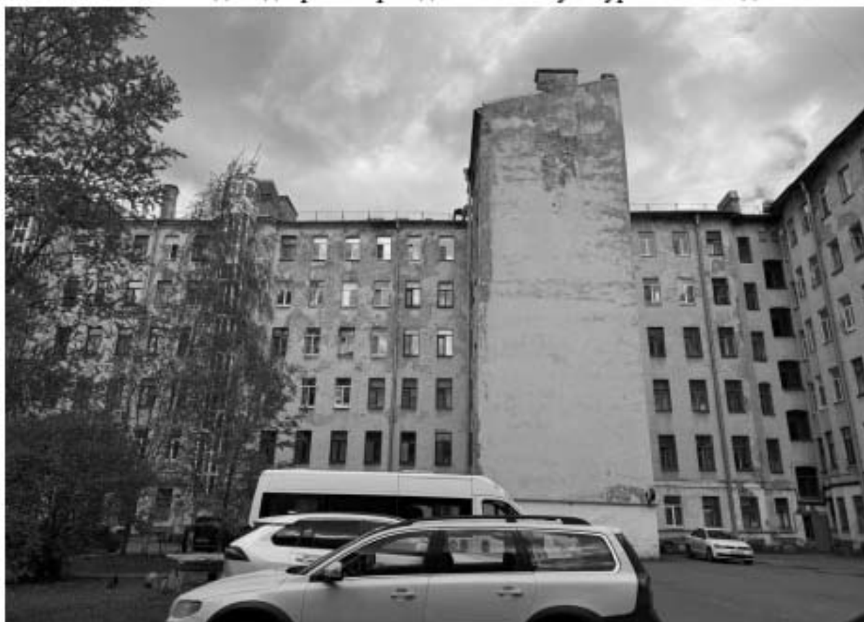
Фото 17. Вид на дворовые фасады объекта культурного наследия.
