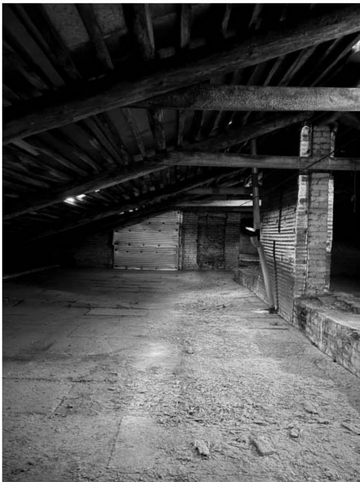
Фото 31. Вид на чердачное помещение объекта культурного наследия.
