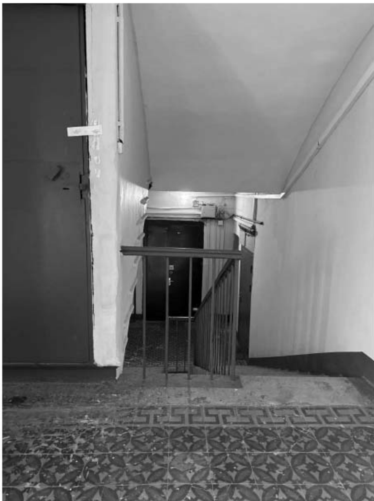
Фото 116. Вид на интерьер лестницы 4-ЛК объекта культурного наследия.
