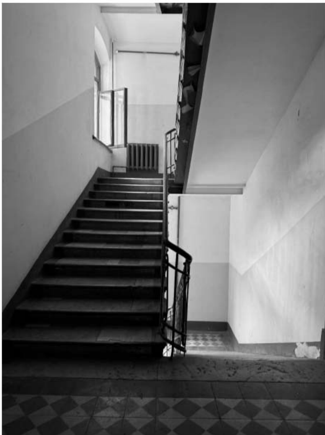
Фото 100. Вид на интерьер лестницы 5-ЛК объекта культурного наследия.
