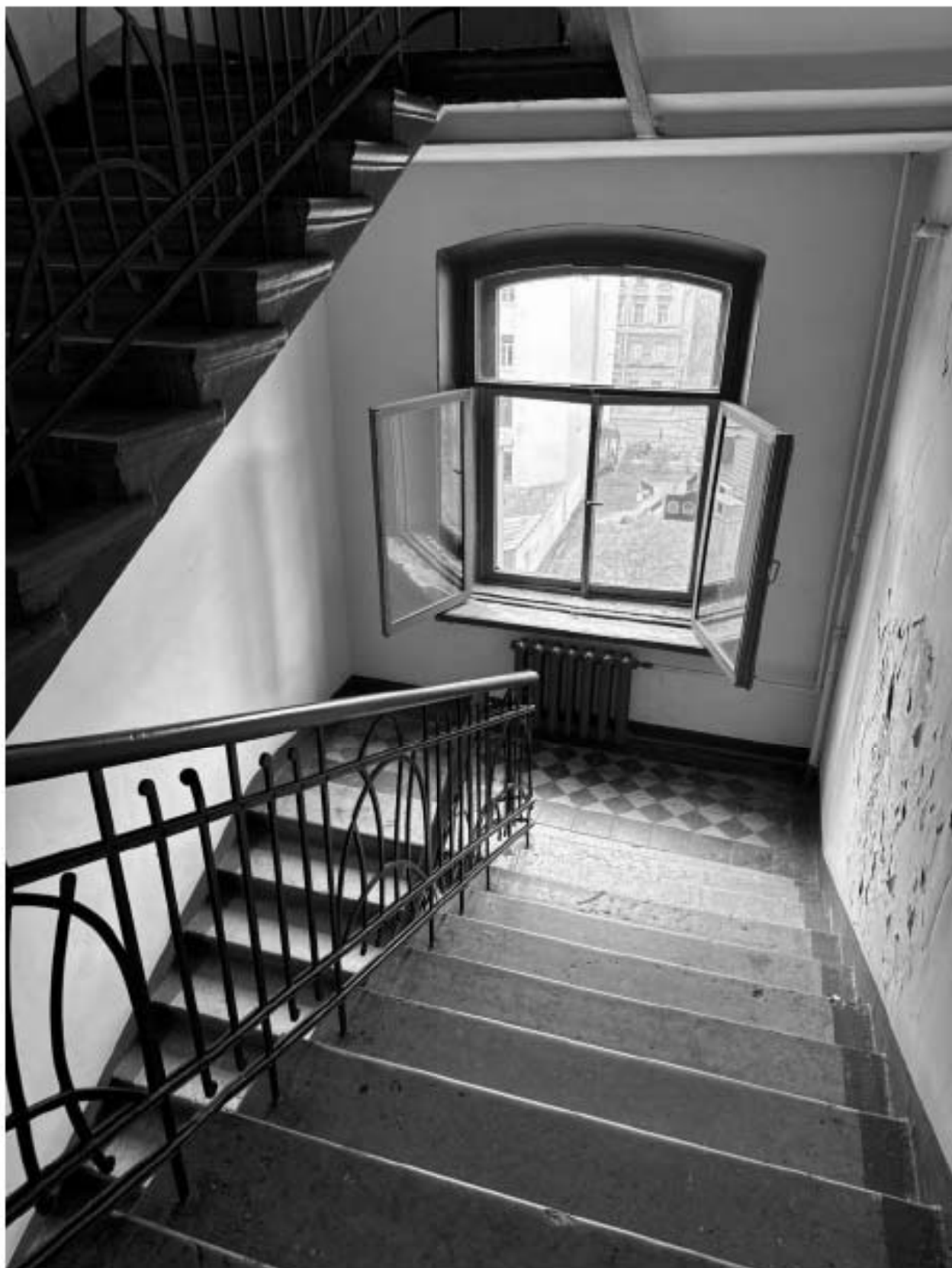
Фото 46. Вид на интерьер лестницы 7-ЛК объекта культурного наследия.
