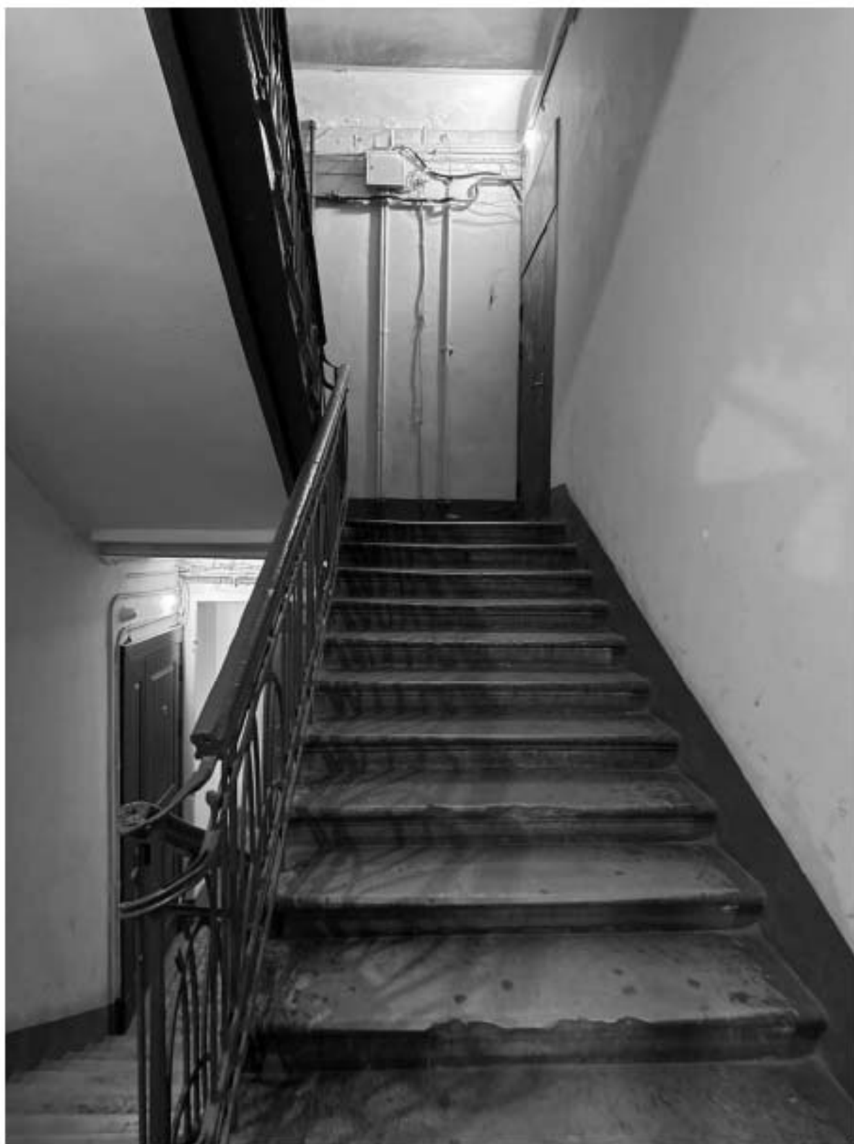
Фото 156. Вид на интерьер лестницы 2-ЛК объекта культурного наследия.
