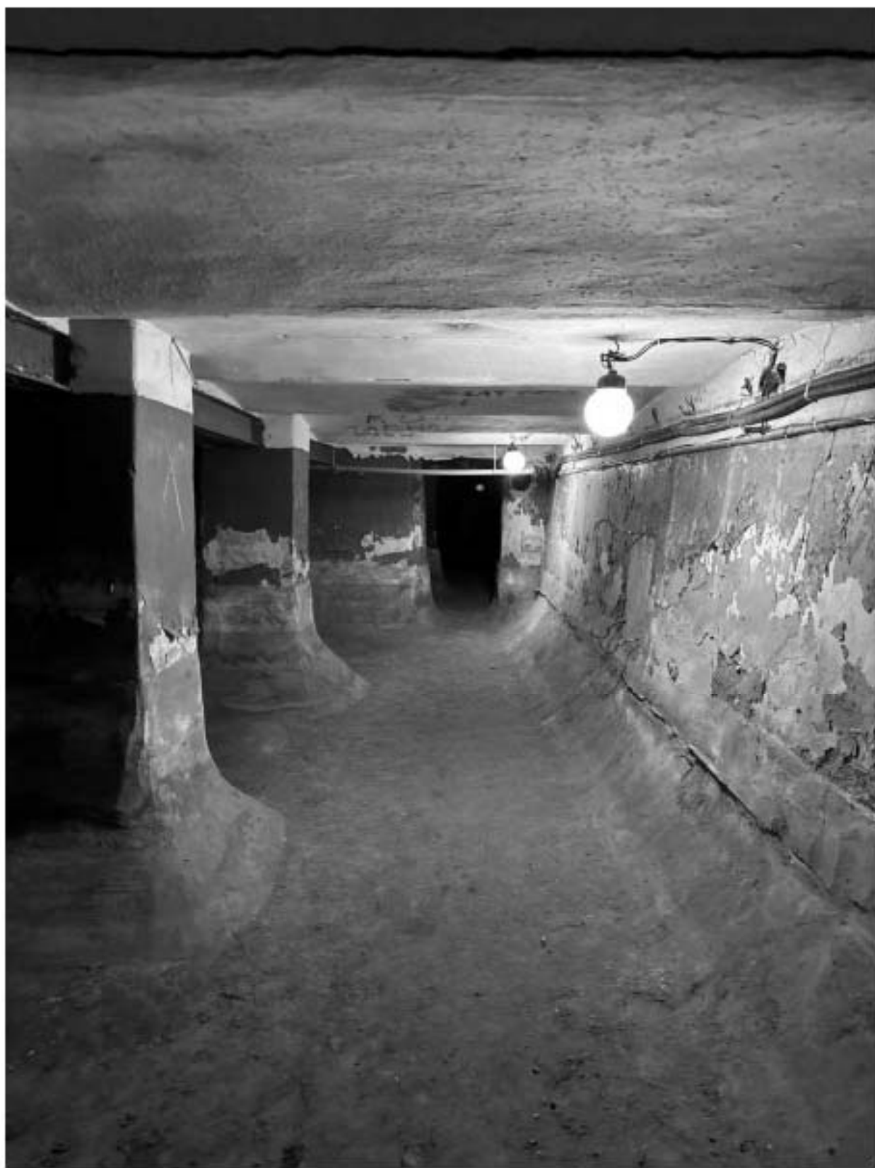
Фото 67. Вид на подвальное помещение объекта культурного наследия.
