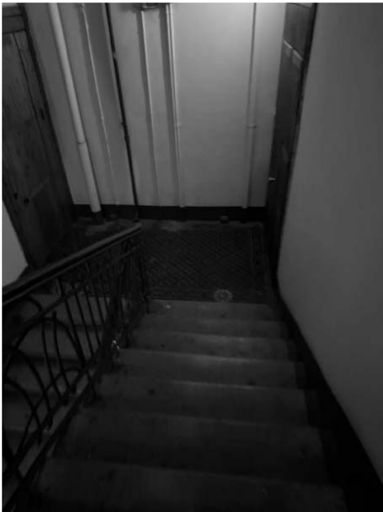
Фото 147. Вид на интерьер лестницы 3-ЛК объекта культурного наследия.
