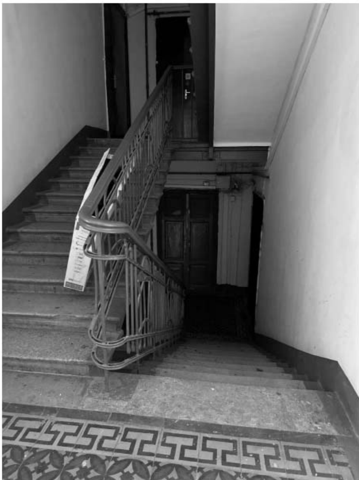
Фото 119. Вид на интерьер лестницы 4-ЛК объекта культурного наследия.
