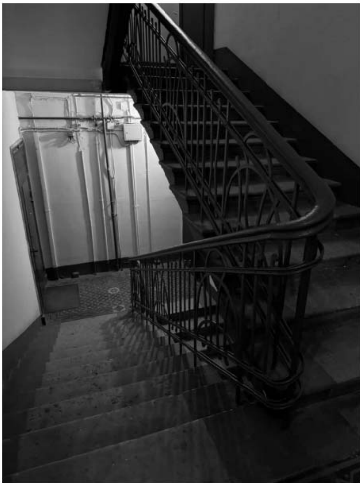
Фото 182. Вид на интерьер лестницы 1-ЛК объекта культурного наследия.
