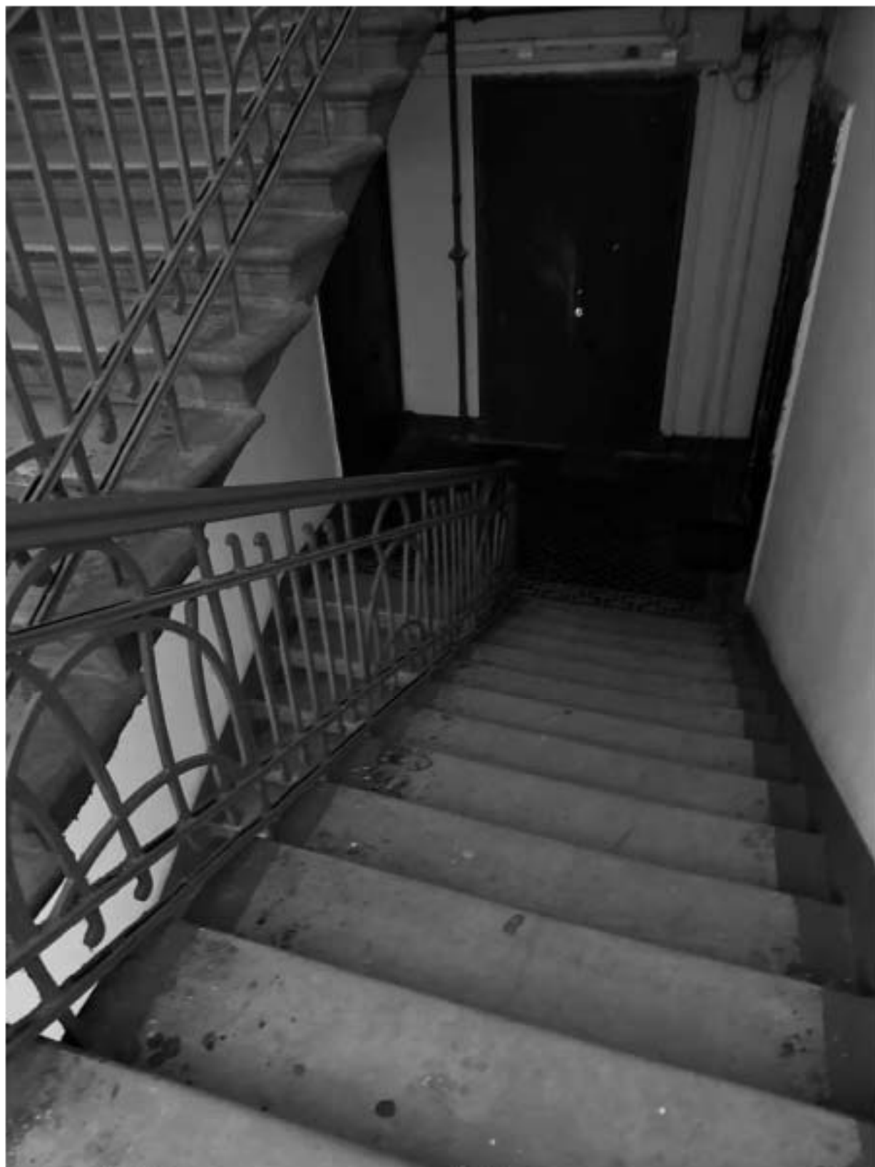
Фото 126. Вид на интерьер лестницы 4-ЛК объекта культурного наследия.
