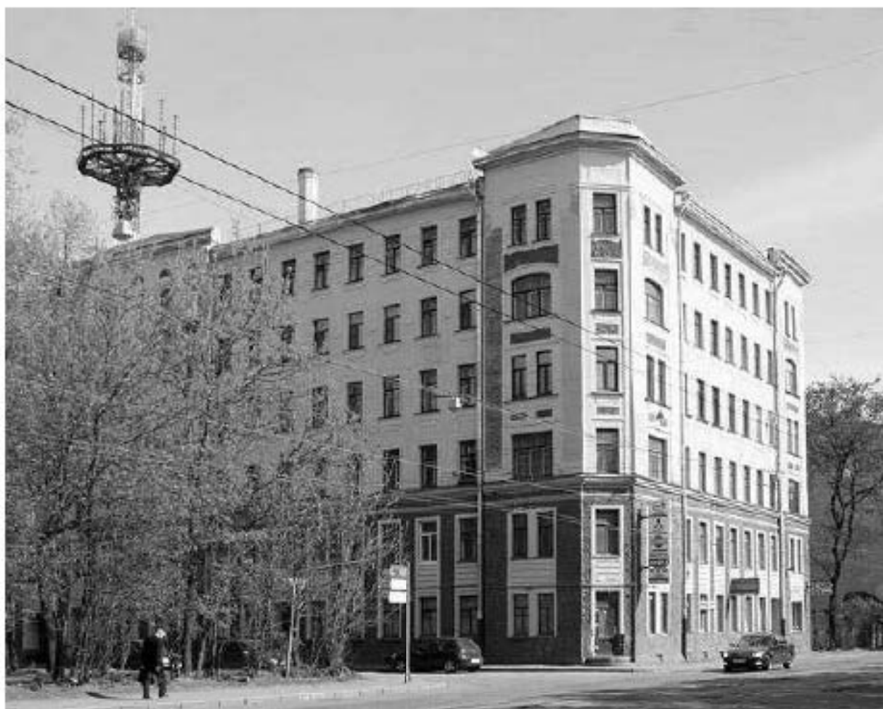
28. Лесной пр., 13/Бобруйская ул., 8, 2009 г. [Электронный ресурс] URL: https://p2.citywalls.ru/photo_26-26718.jpg?mt=1273625807
