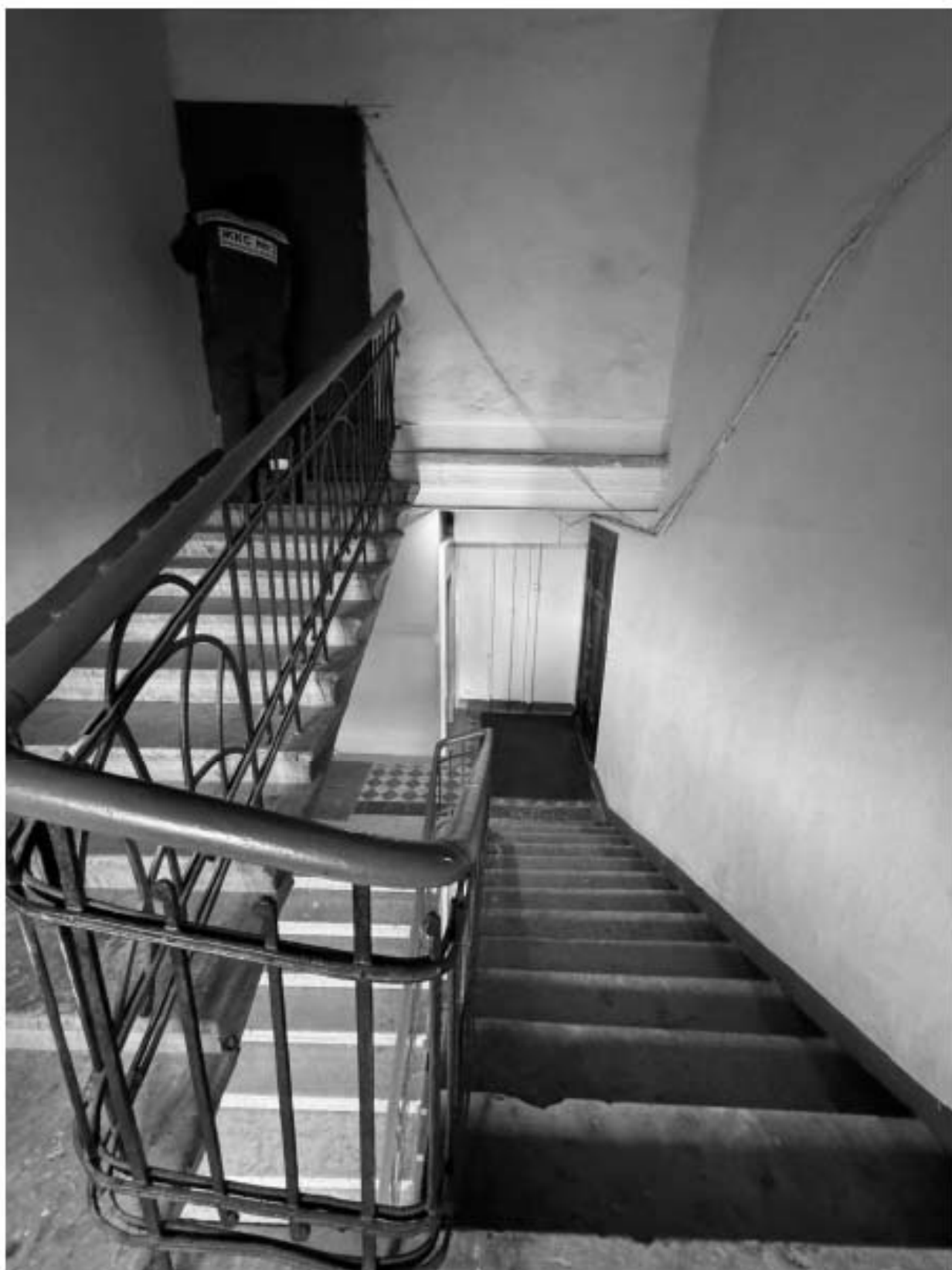
Фото 29. Вид на интерьер лестницы 7-ЛК объекта культурного наследия.
