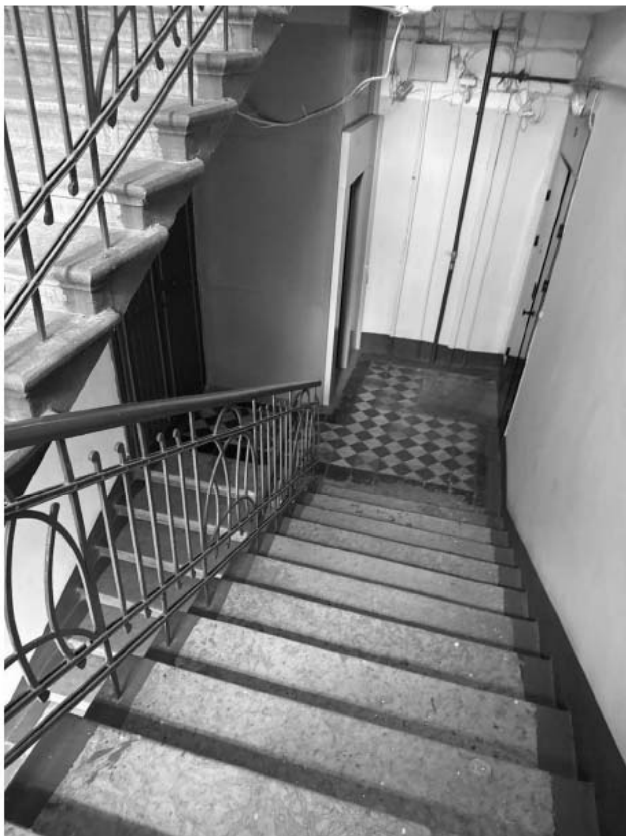
Фото 75. Вид на интерьер лестницы 6-ЛК объекта культурного наследия.
