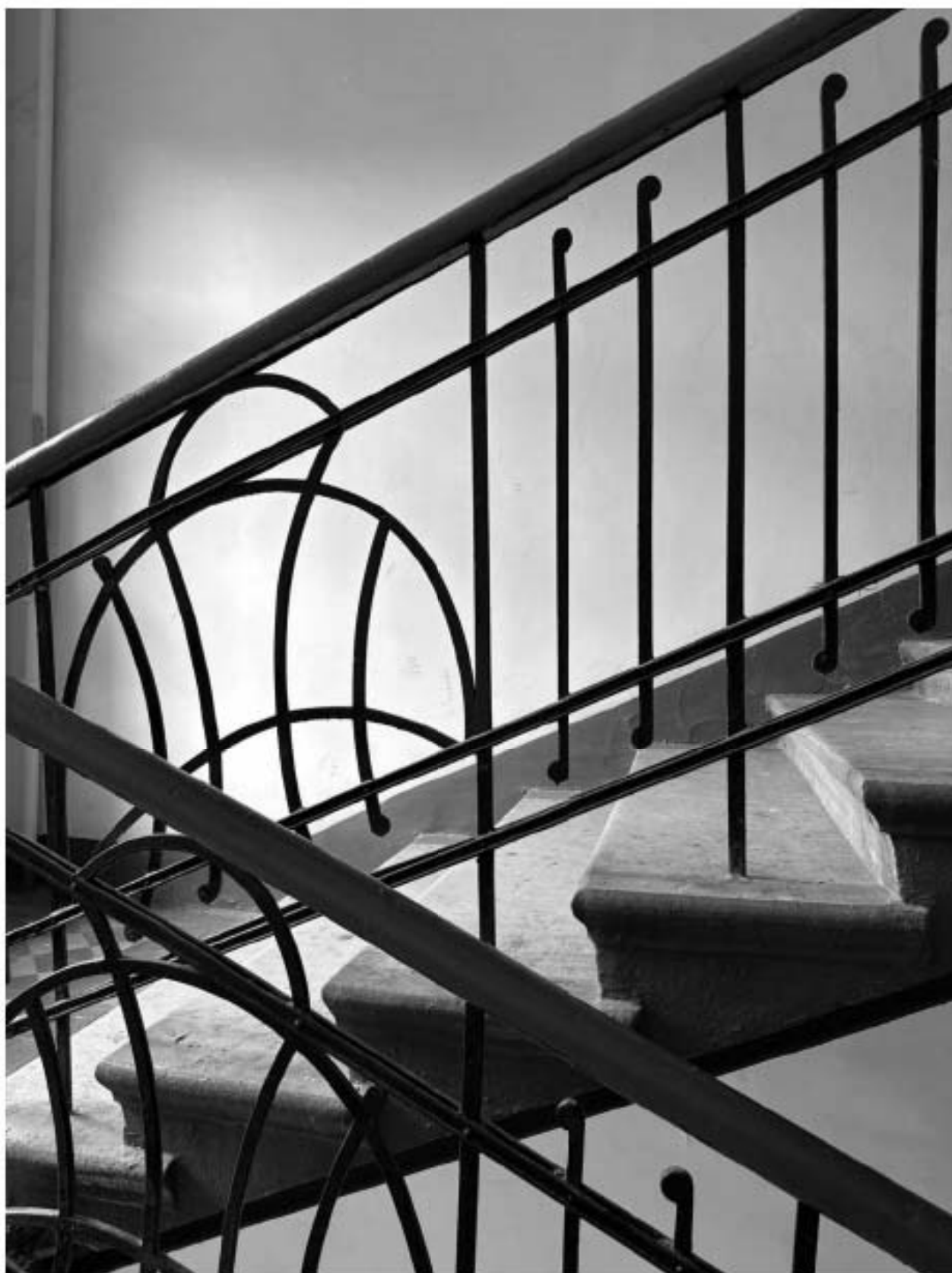
Фото 56. Вид на ограждение лестницы 7-ЛК объекта культурного наследия.
