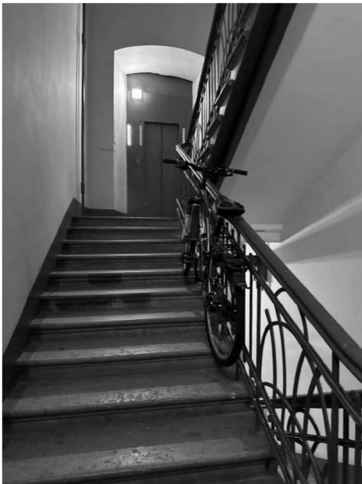
Фото 142. Вид на интерьер лестницы 3-ЛК объекта культурного наследия.
