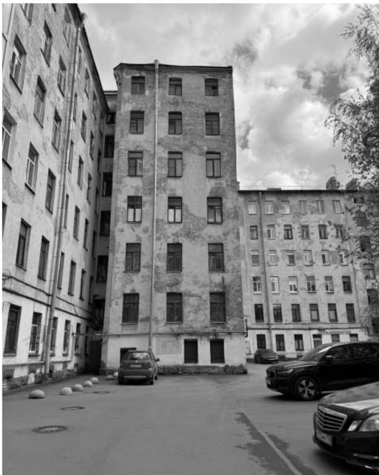
Фото 25. Вид на дворовые фасады объекта культурного наследия.
