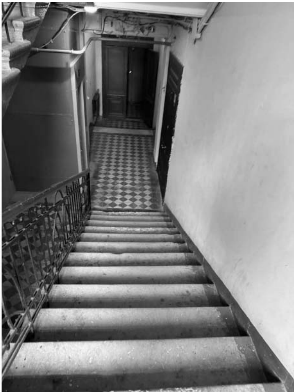
Фото 57. Вид на интерьер лестницы 7-ЛК объекта культурного наследия.
