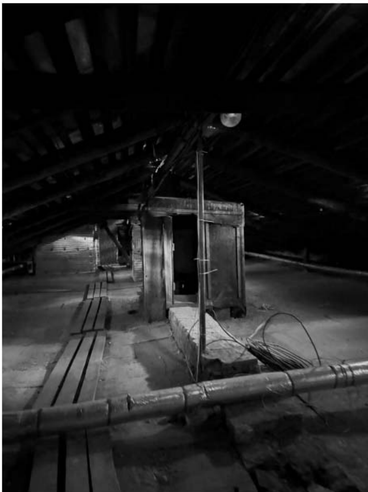
Фото 38. Вид на чердачное помещение объекта культурного наследия.
