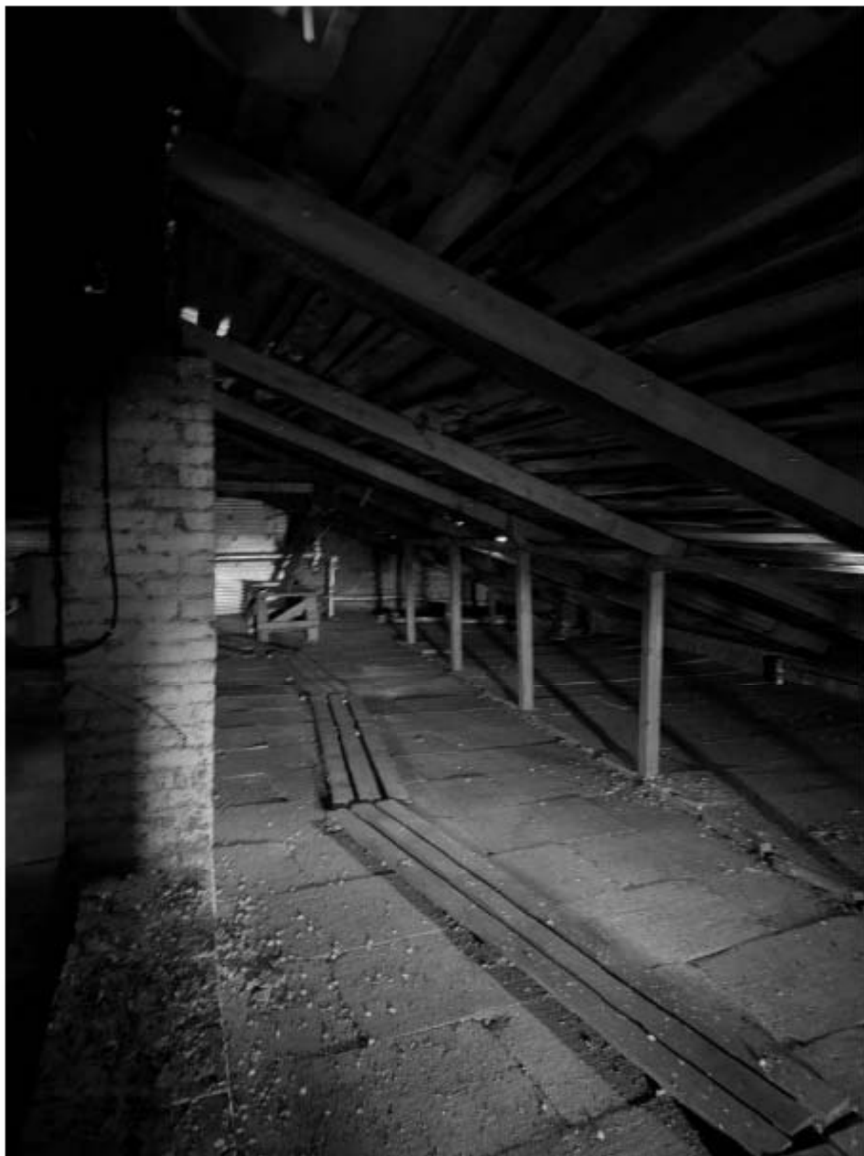
Фото 41. Вид на чердачное помещение объекта культурного наследия.
