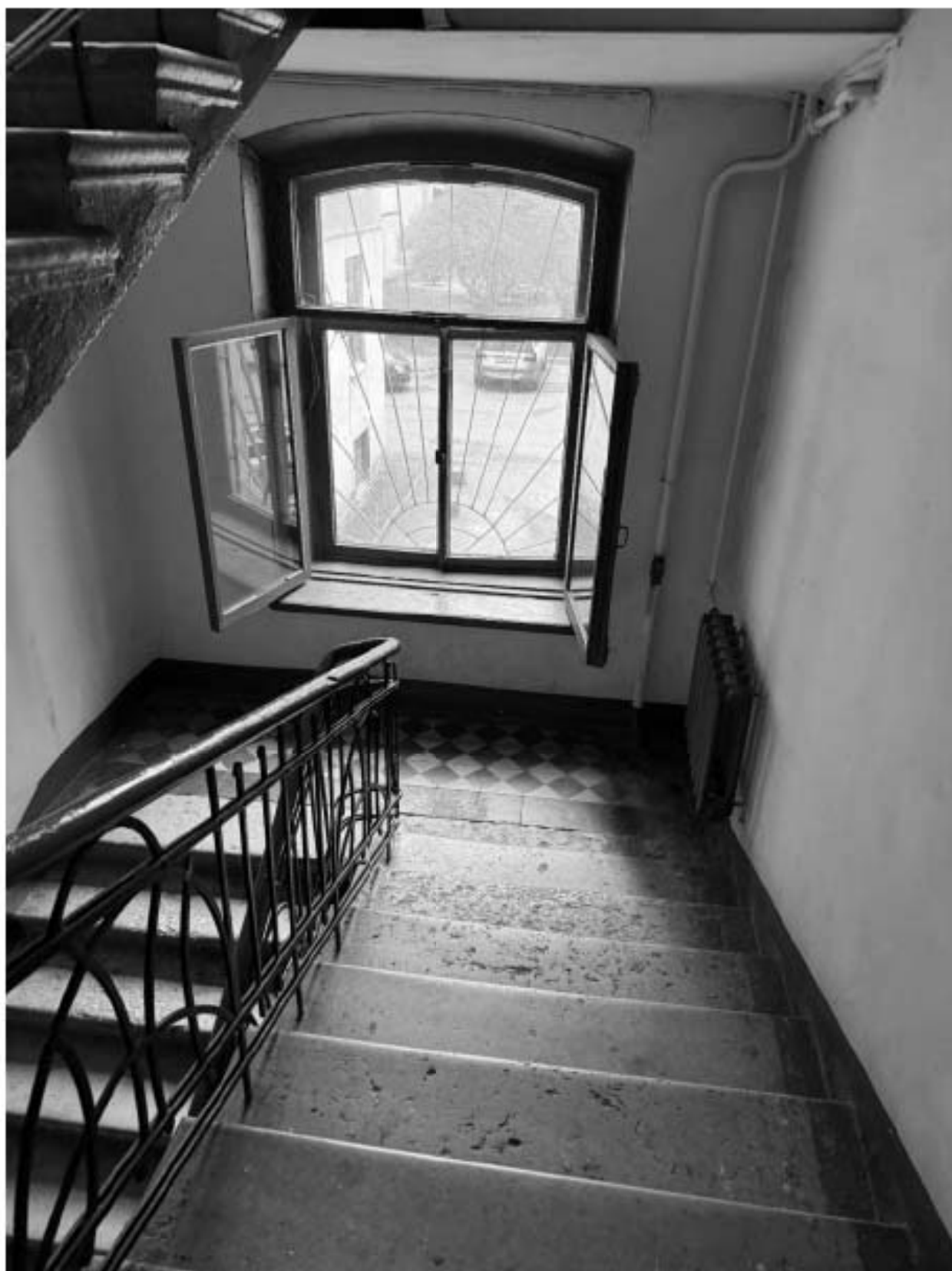
Фото 55. Вид на интерьер лестницы 7-ЛК объекта культурного наследия.
