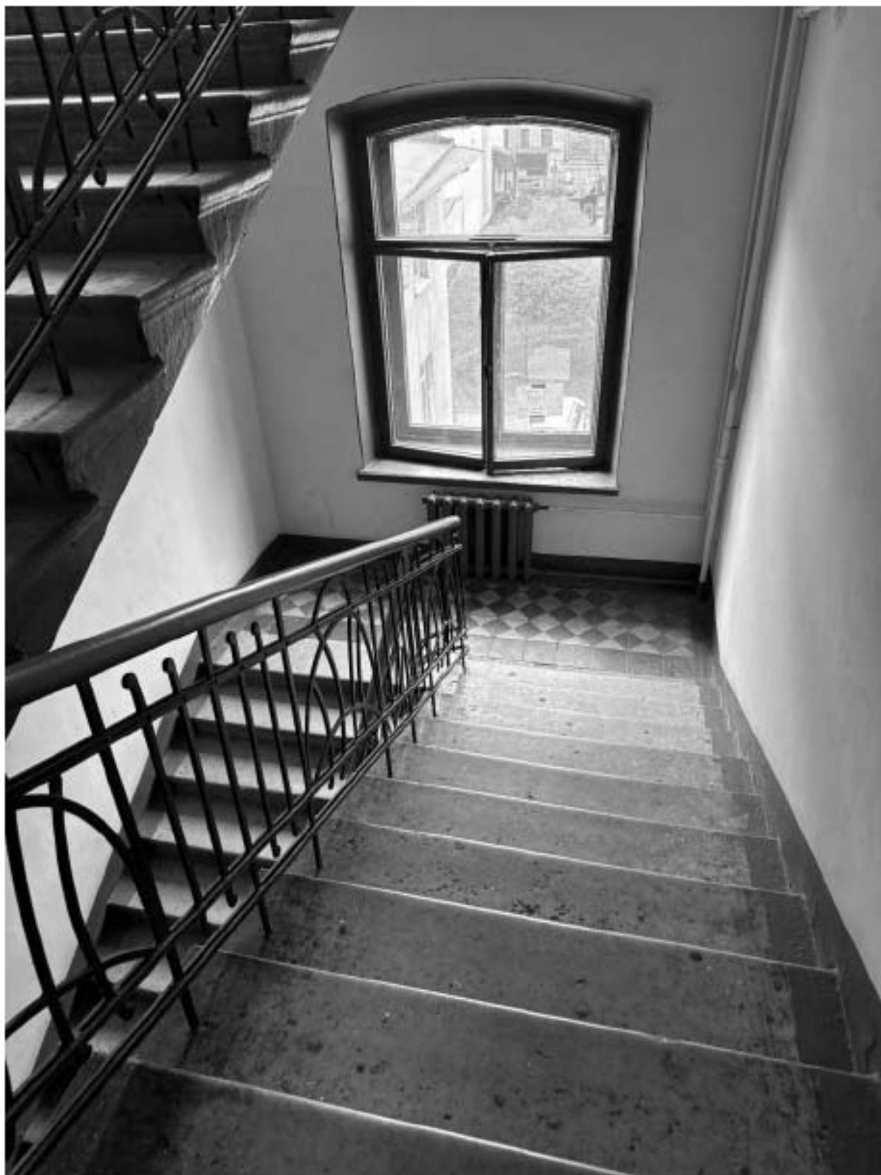
Фото 51. Вид на интерьер лестницы 7-ЛК объекта культурного наследия.
