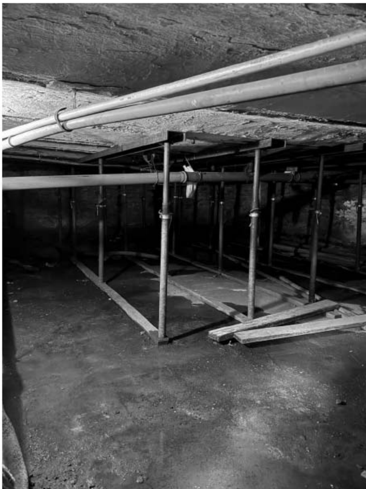
Фото 82. Вид на подвальное помещение объекта культурного наследия.
