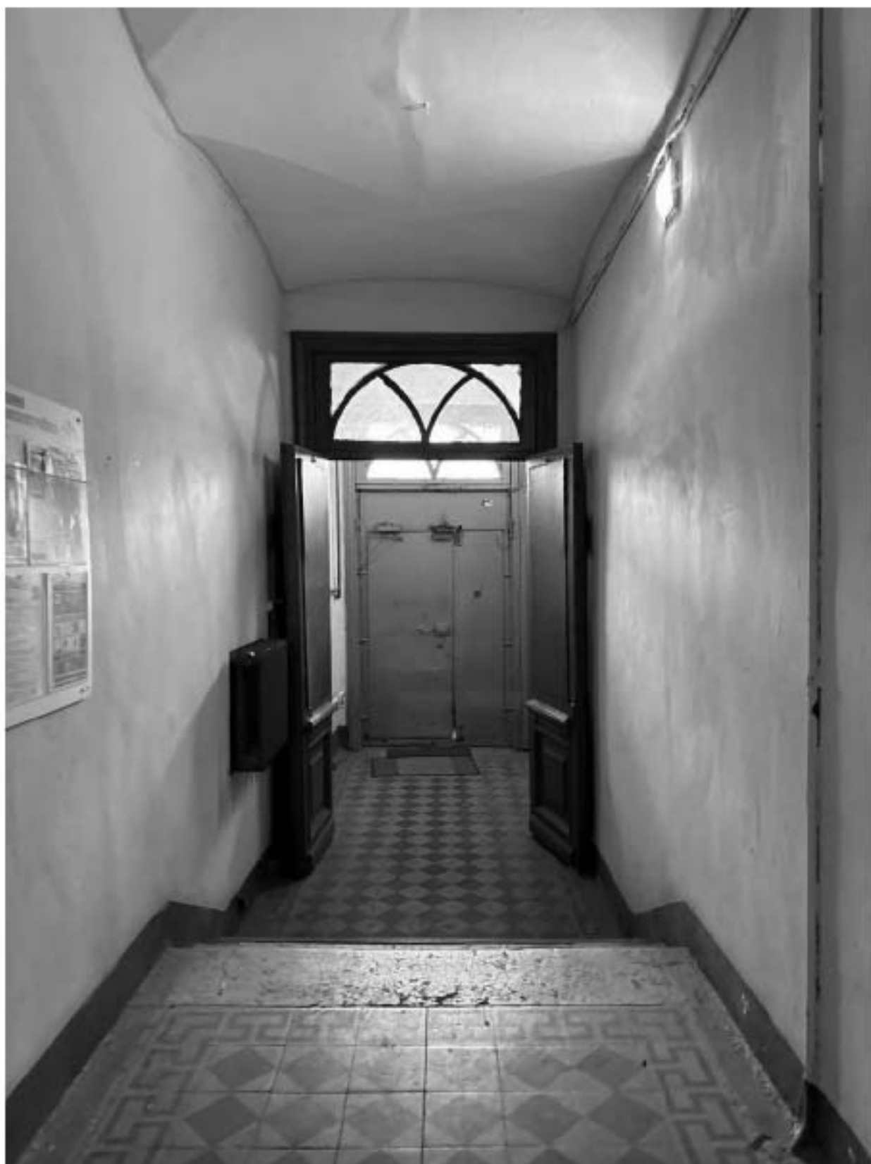
Фото 113. Вид на интерьер вестибюля лестницы 4-ЛК объекта культурного наследия.
