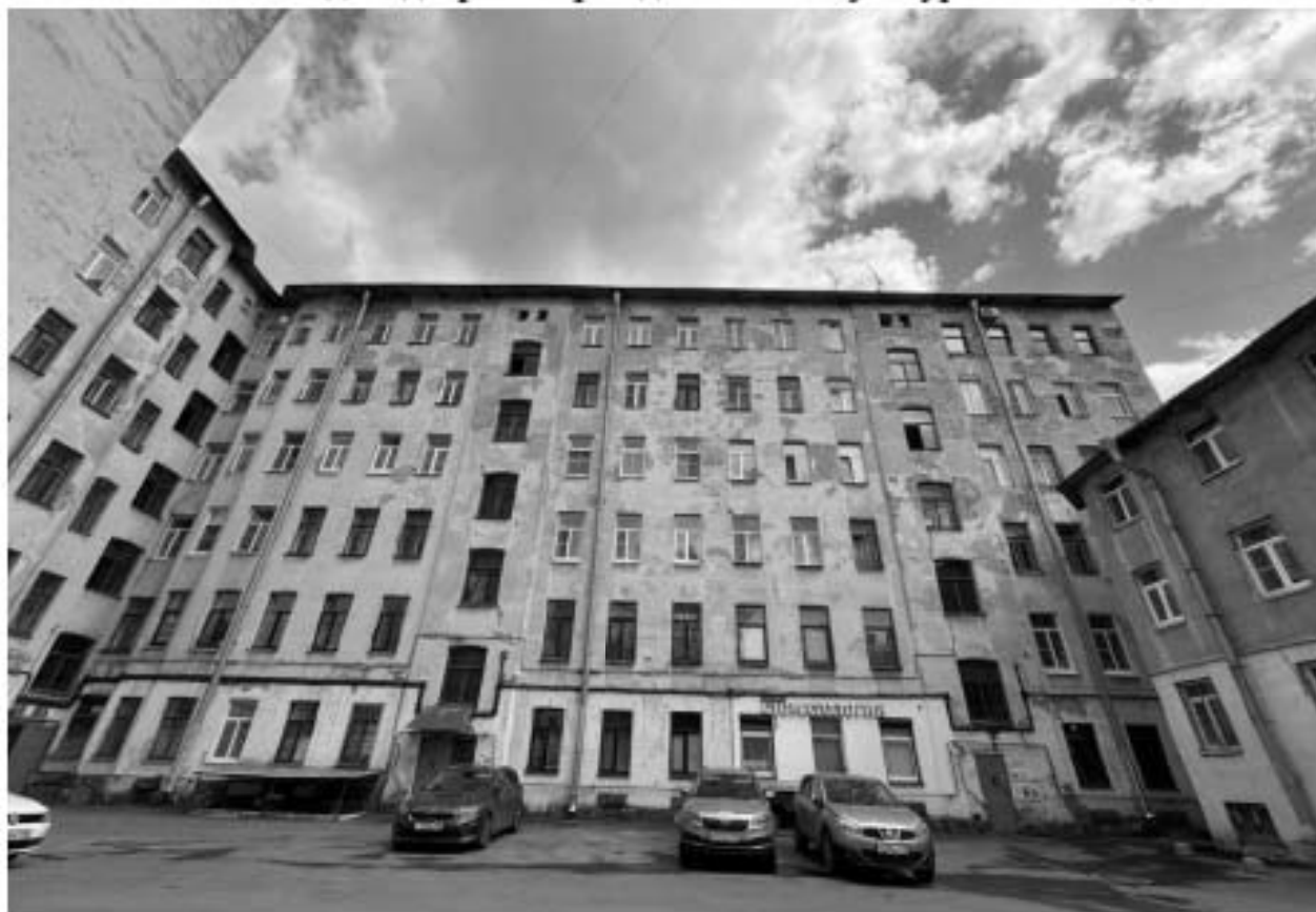
Фото 21. Вид на дворовые фасады объекта культурного наследия.
