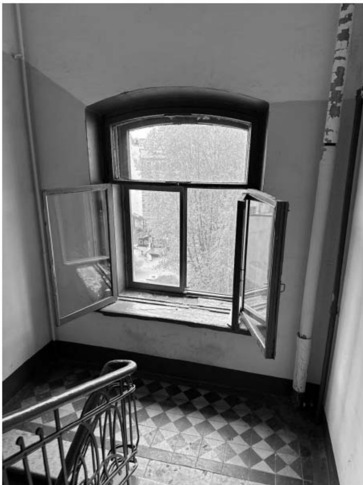
Фото 72. Вид на интерьер лестницы 6-ЛК объекта культурного наследия.
