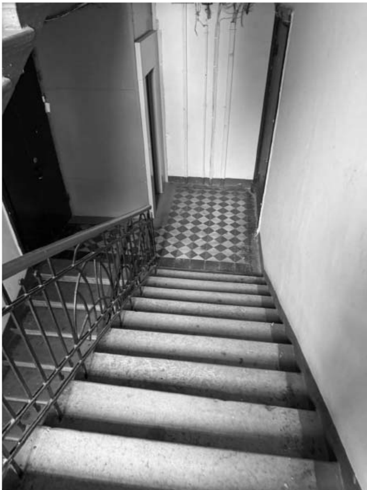
Фото 54. Вид на интерьер лестницы 7-ЛК объекта культурного наследия.
