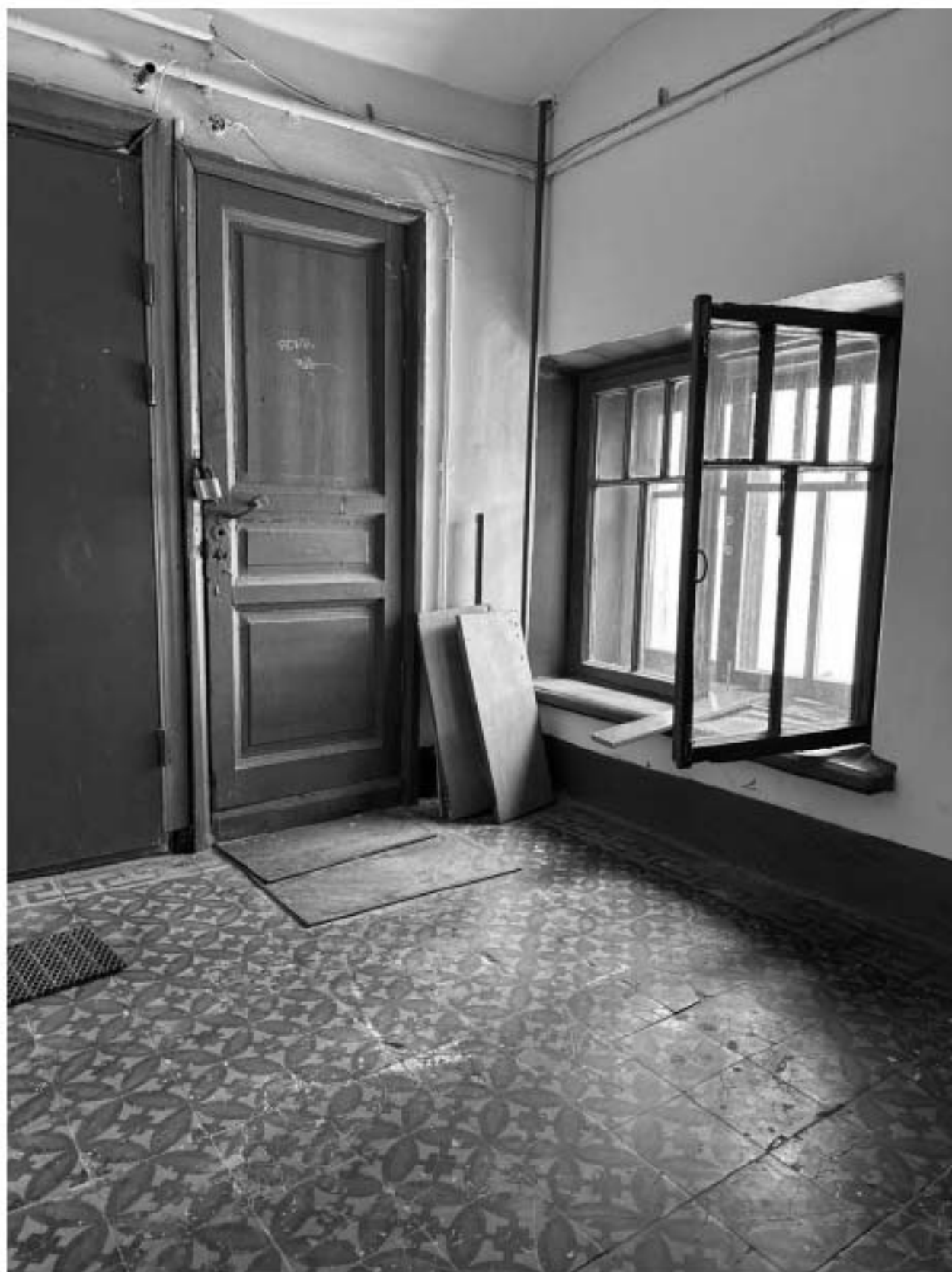
Фото 115. Вид на интерьер лестницы 4-ЛК объекта культурного наследия.
