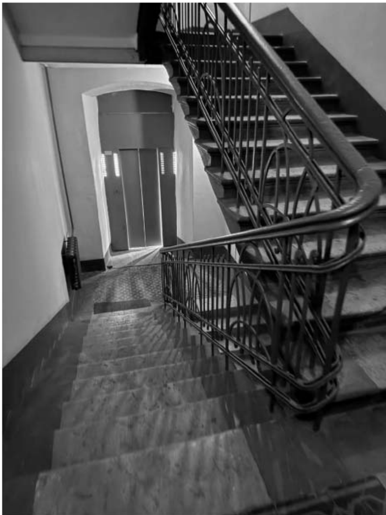
Фото 184. Вид на интерьер лестницы 1-ЛК объекта культурного наследия.
