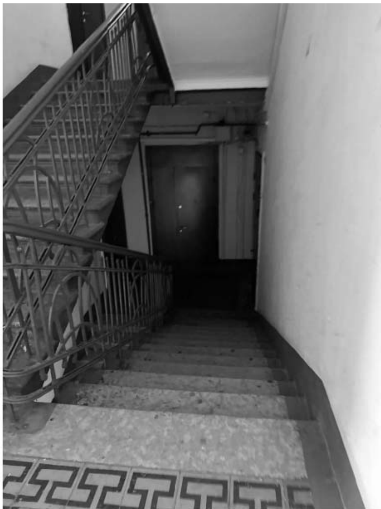
Фото 124. Вид на интерьер лестницы 4-ЛК объекта культурного наследия.
