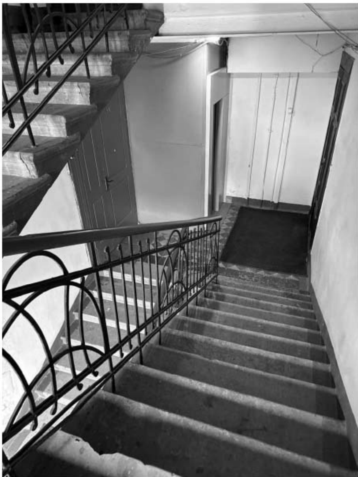
Фото 45. Вид на интерьер лестницы 7-ЛК объекта культурного наследия.
