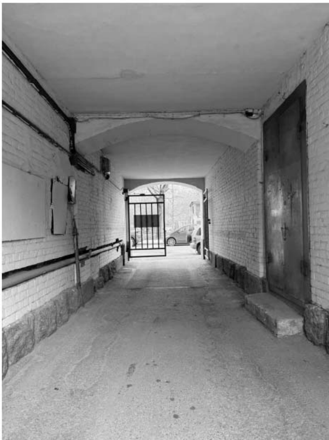
Фото 26. Вид на арку проезда объекта культурного наследия.
