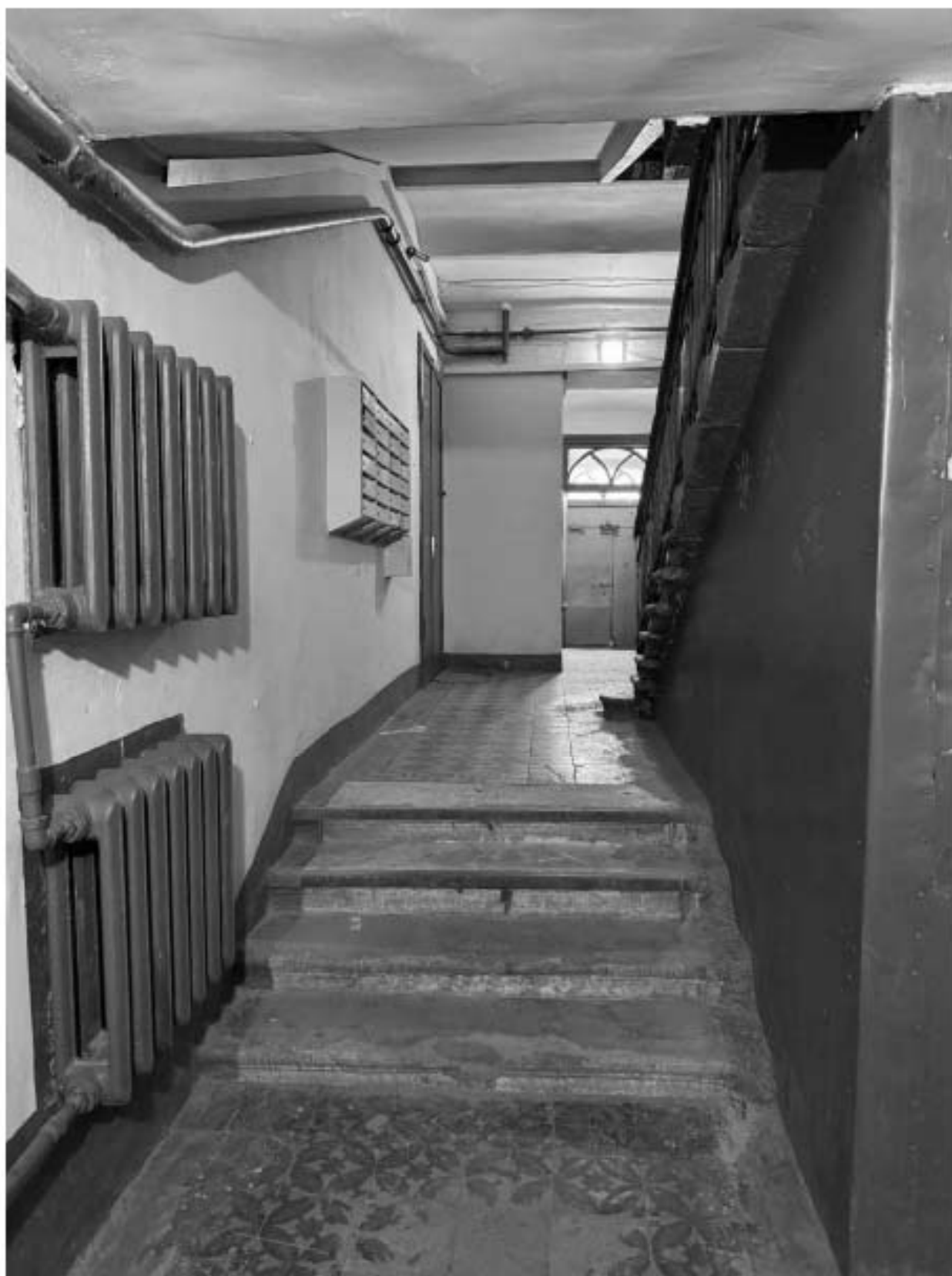
Фото 109. Вид на интерьер лестницы 4-ЛК объекта культурного наследия.
