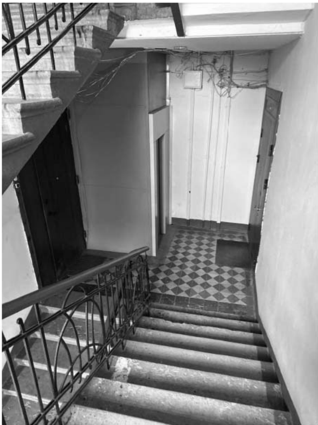
Фото 47. Вид на интерьер лестницы 7-ЛК объекта культурного наследия.
