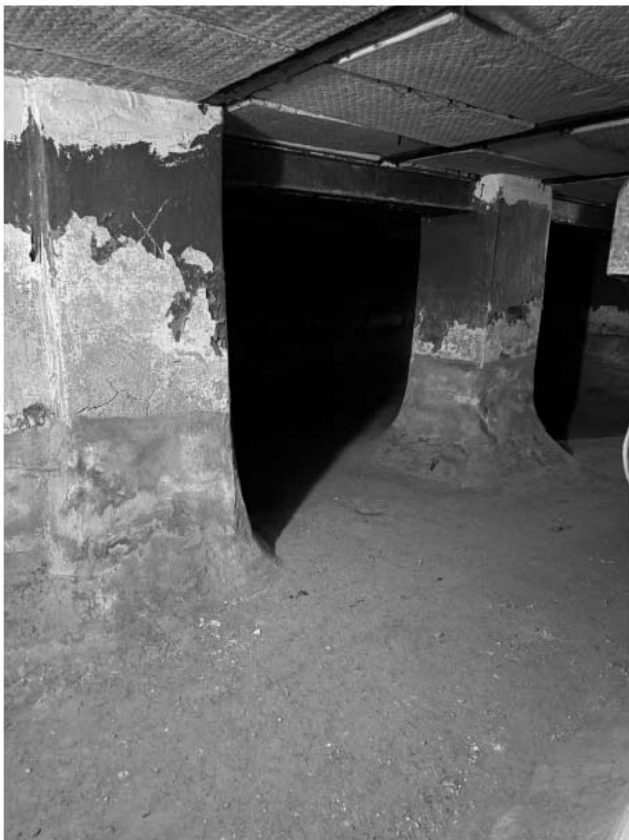
Фото 65. Вид на подвальное помещение объекта культурного наследия.
