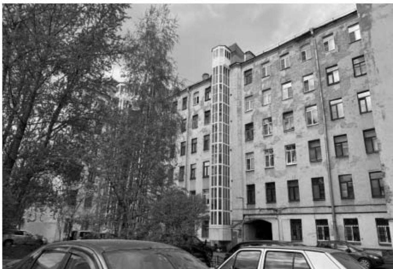
Фото 20. Вид на дворовые фасады объекта культурного наследия.
