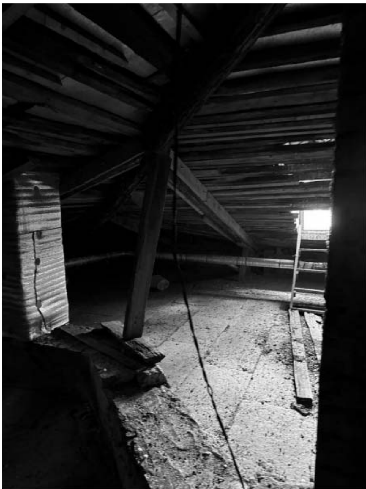
Фото 43. Вид на чердачное помещение объекта культурного наследия.
