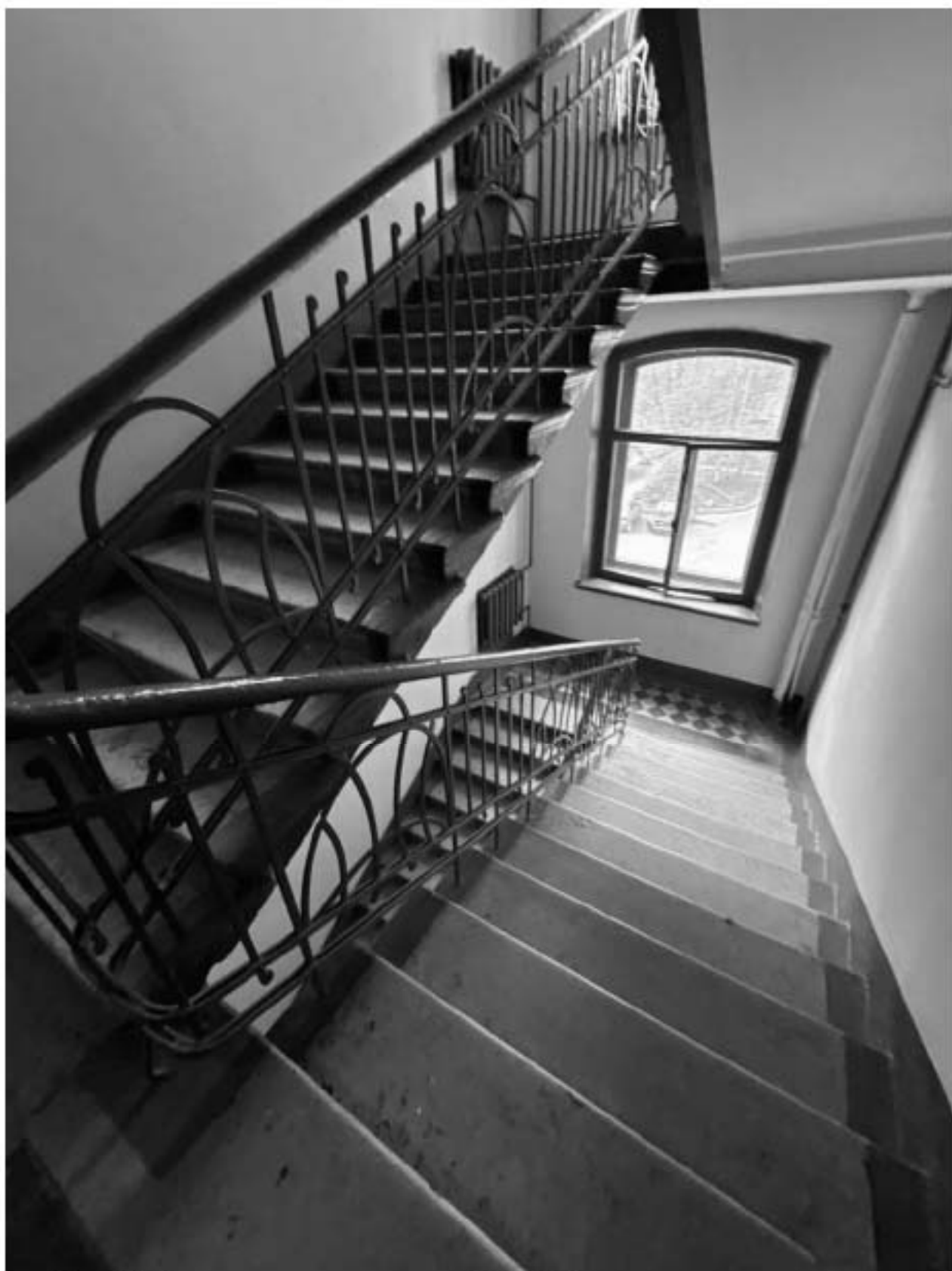
Фото 79. Вид на интерьер лестницы 6-ЛК объекта культурного наследия.
