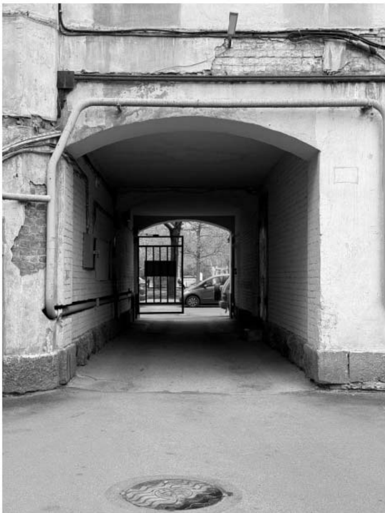
Фото 24. Вид на арку проезда объекта культурного наследия.
