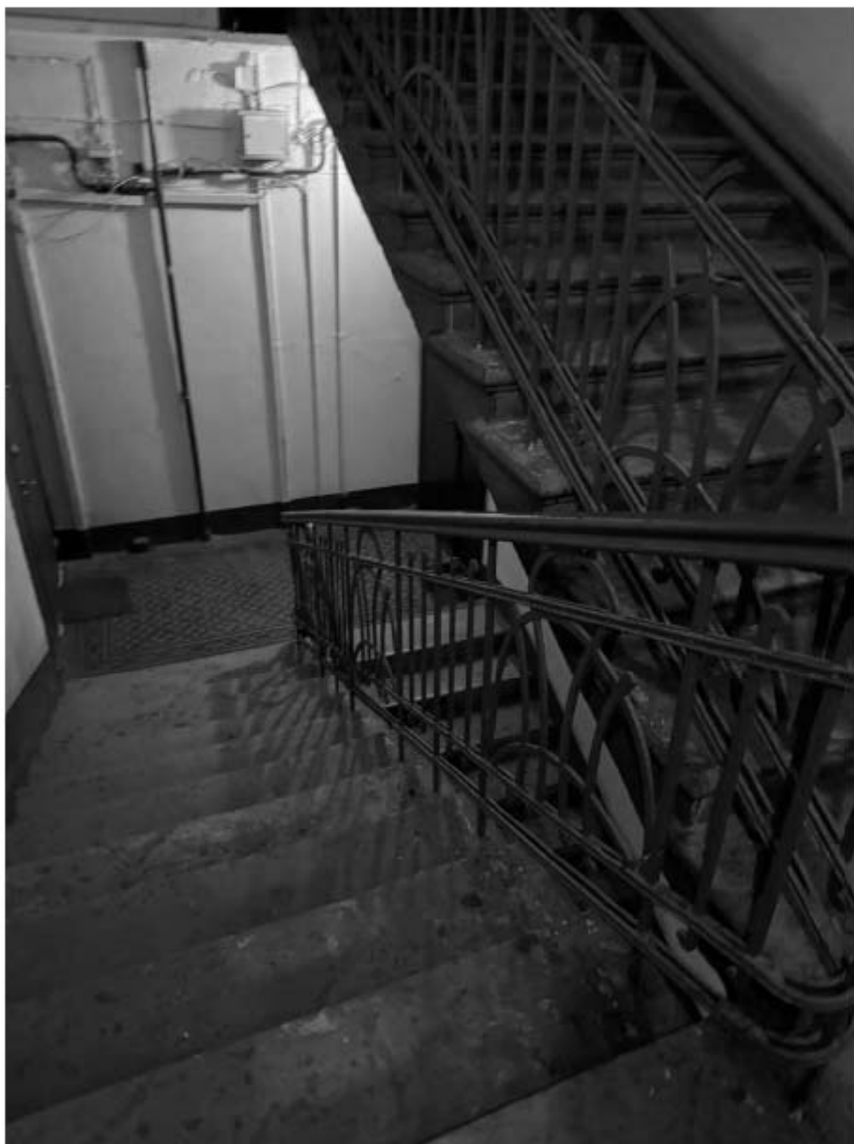
Фото 161. Вид на интерьер лестницы 2-ЛК объекта культурного наследия.
