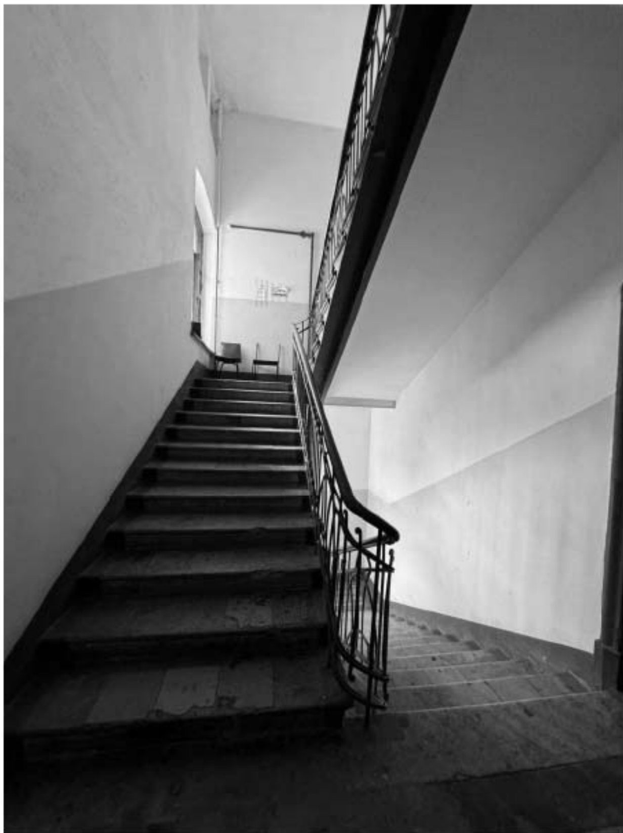
Фото 93. Вид на интерьер лестницы 5-ЛК объекта культурного наследия.
