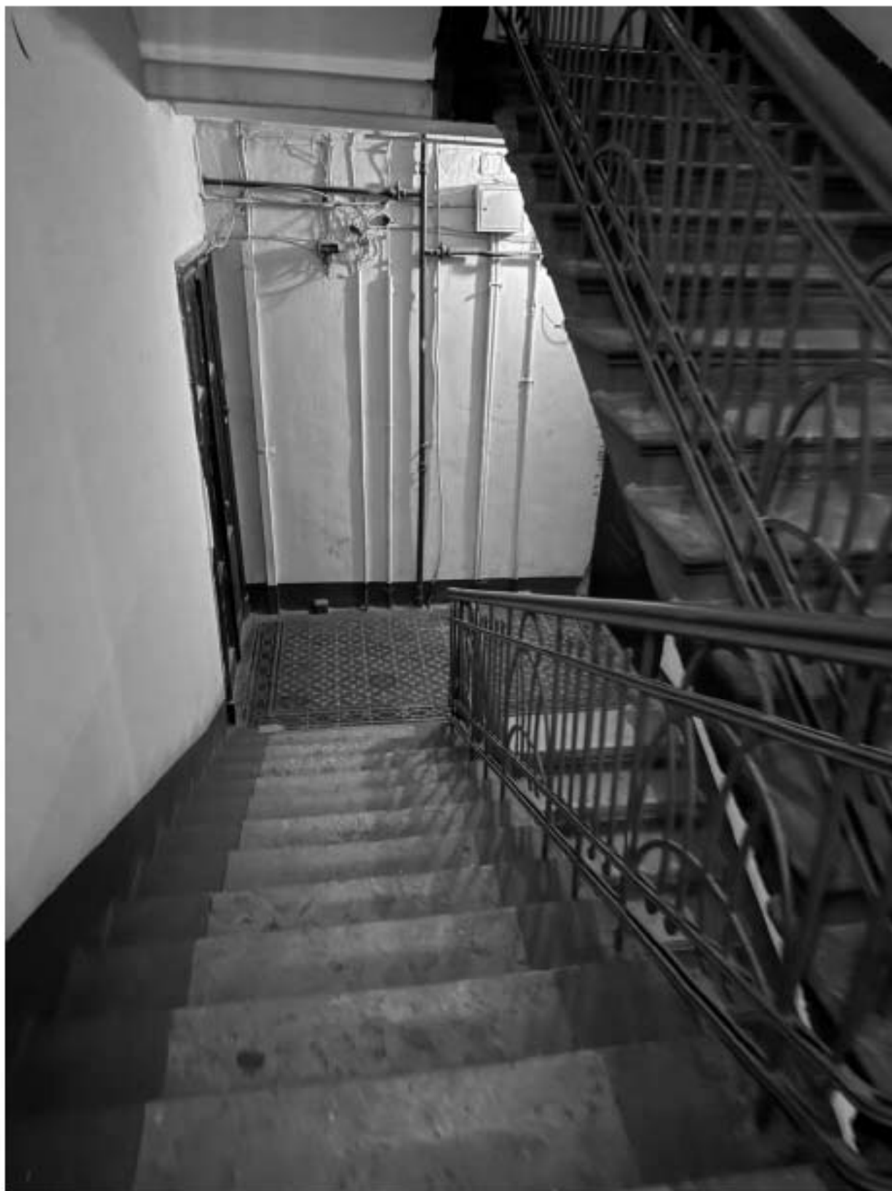
Фото 189. Вид на интерьер лестницы 1-ЛК объекта культурного наследия.
