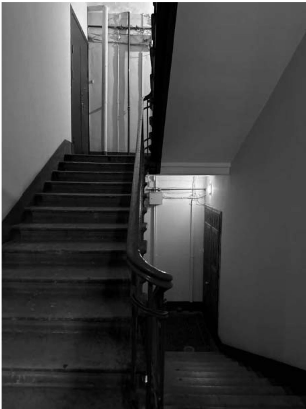
Фото 146. Вид на интерьер лестницы 3-ЛК объекта культурного наследия.
