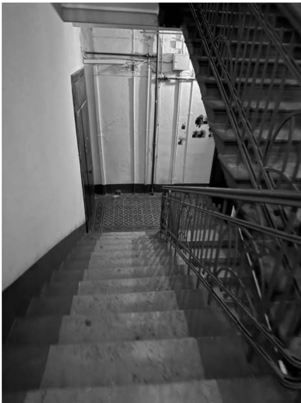
Фото 186. Вид на интерьер лестницы 1-ЛК объекта культурного наследия.
