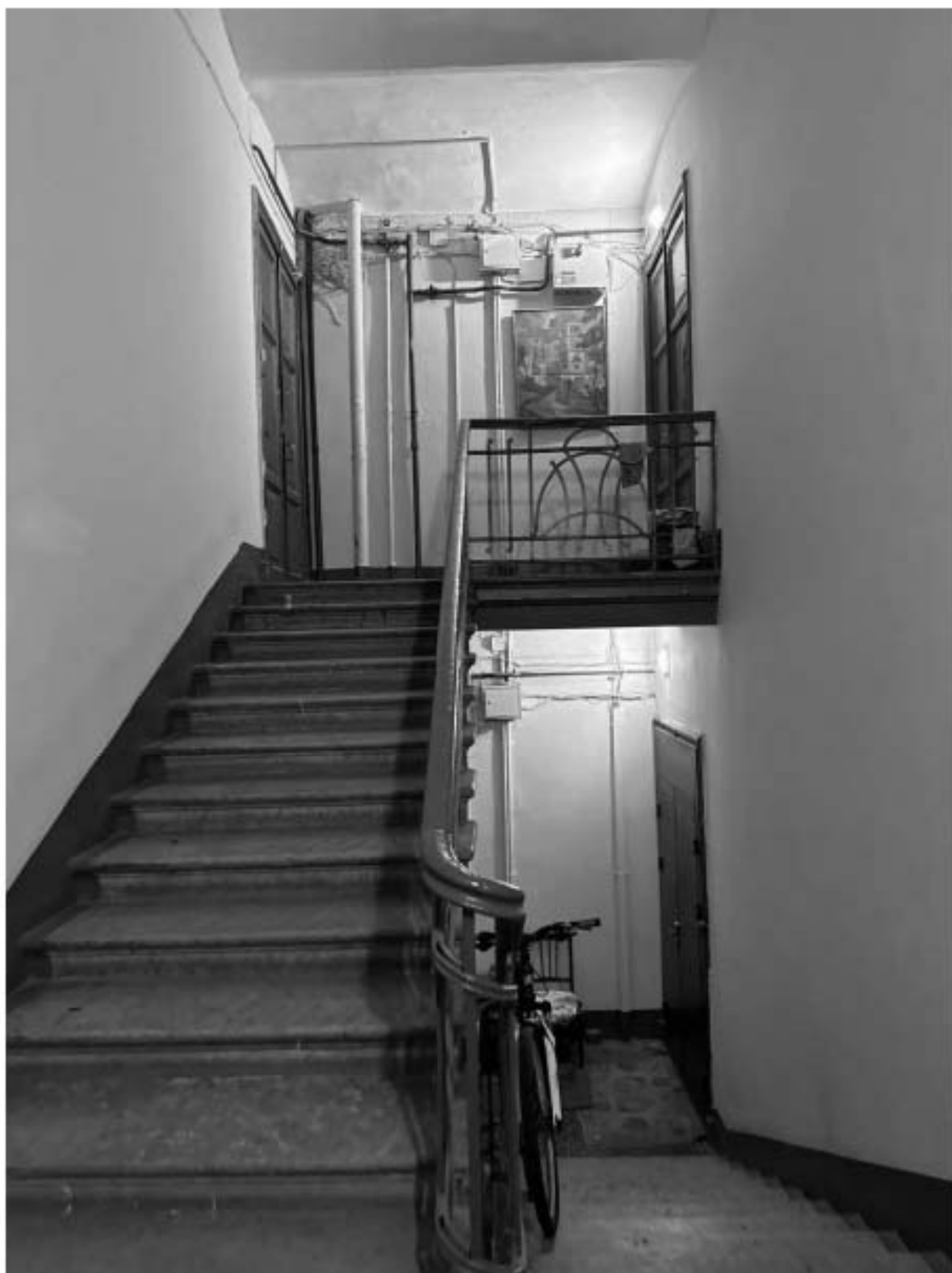
Фото 137. Вид на интерьер лестницы 3-ЛК объекта культурного наследия.
