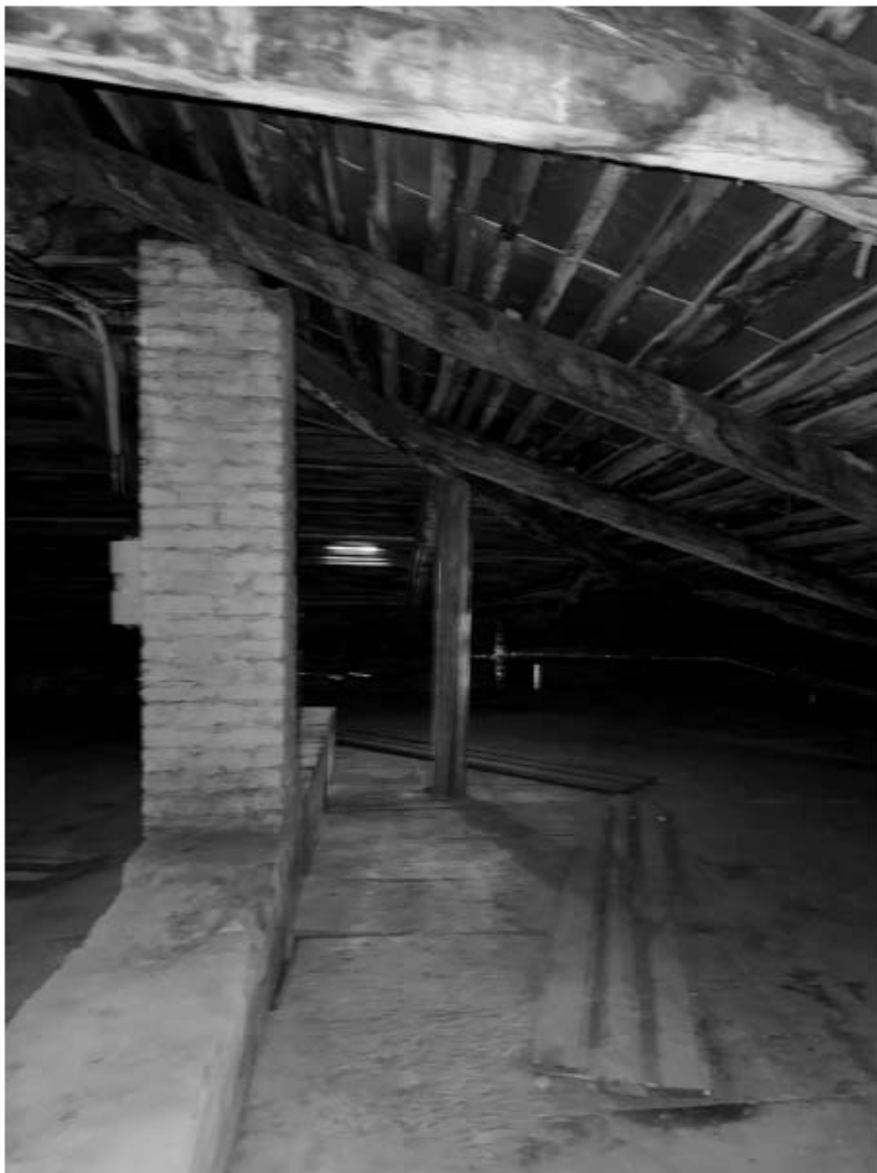
Фото 34. Вид на чердачное помещение объекта культурного наследия.
