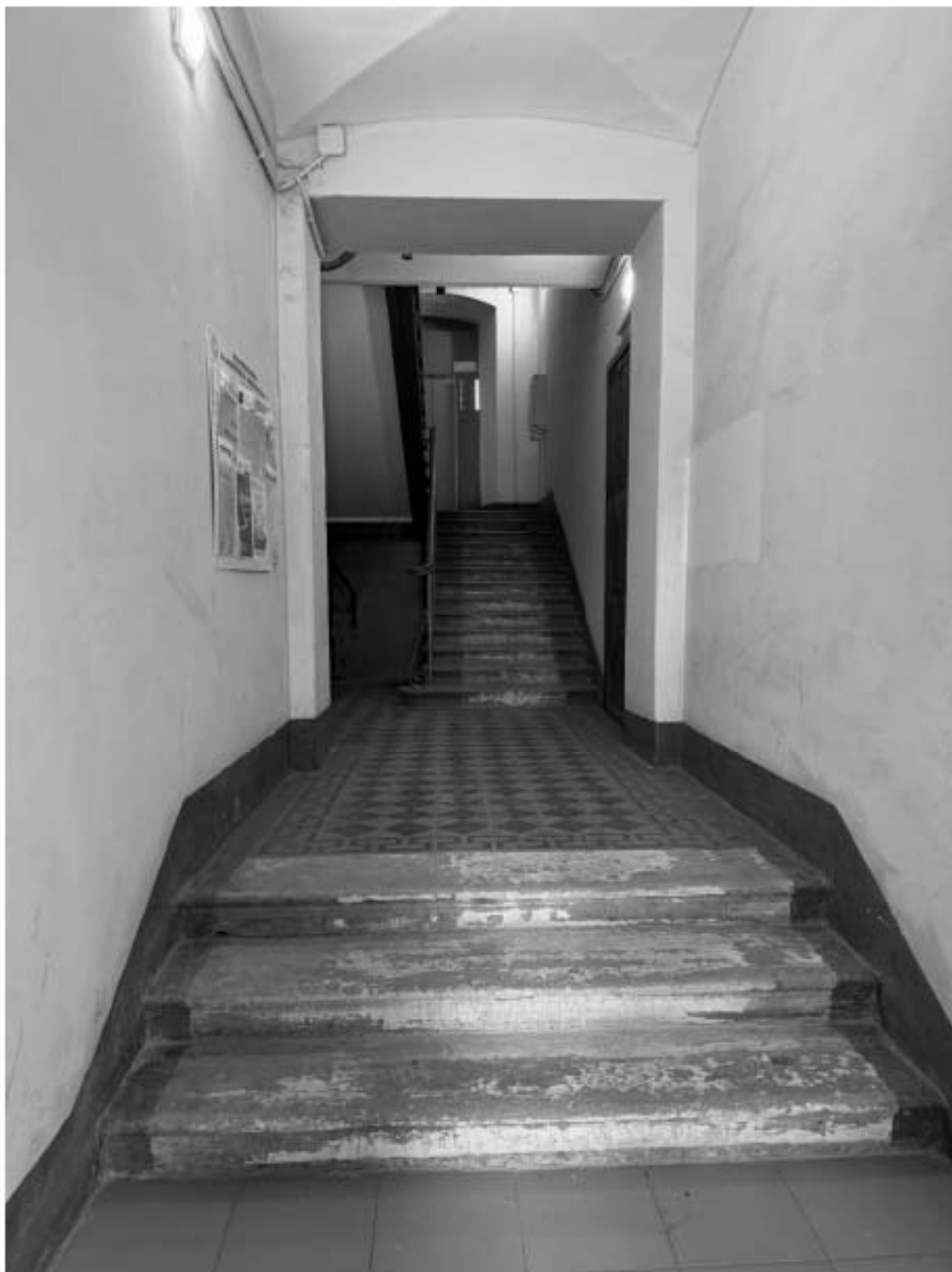
Фото 171. Вид на интерьер вестибюля лестницы 1-ЛК объекта культурного наследия.
