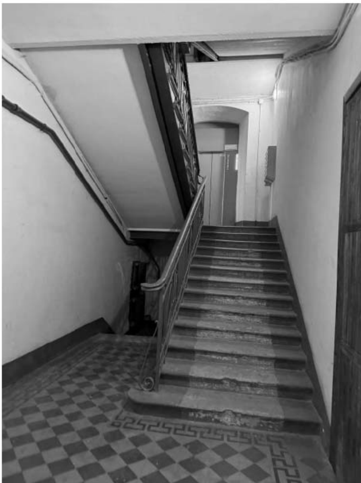
Фото 172. Вид на интерьер вестибюля лестницы 1-ЛК объекта культурного наследия.
