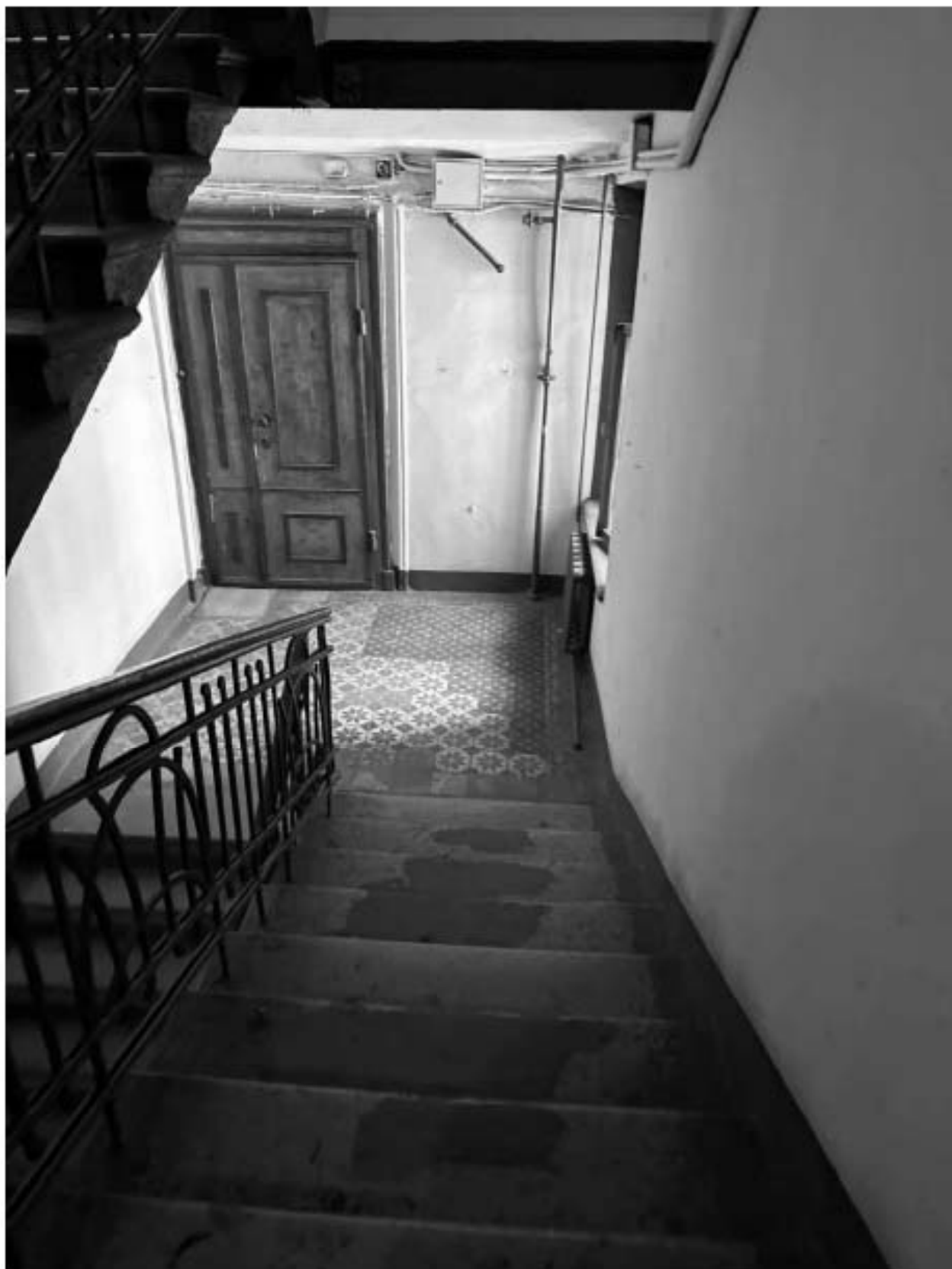
Фото 130. Вид на интерьер лестницы 4-ЛК объекта культурного наследия.
