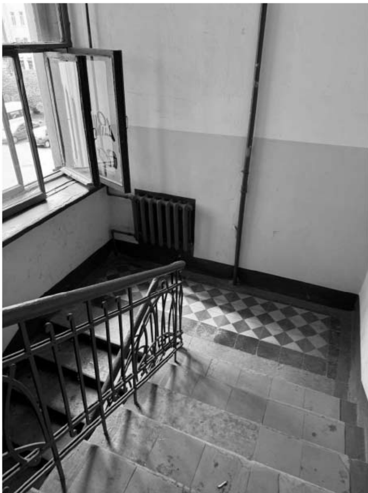
Фото 102. Вид на интерьер лестницы 5-ЛК объекта культурного наследия.
