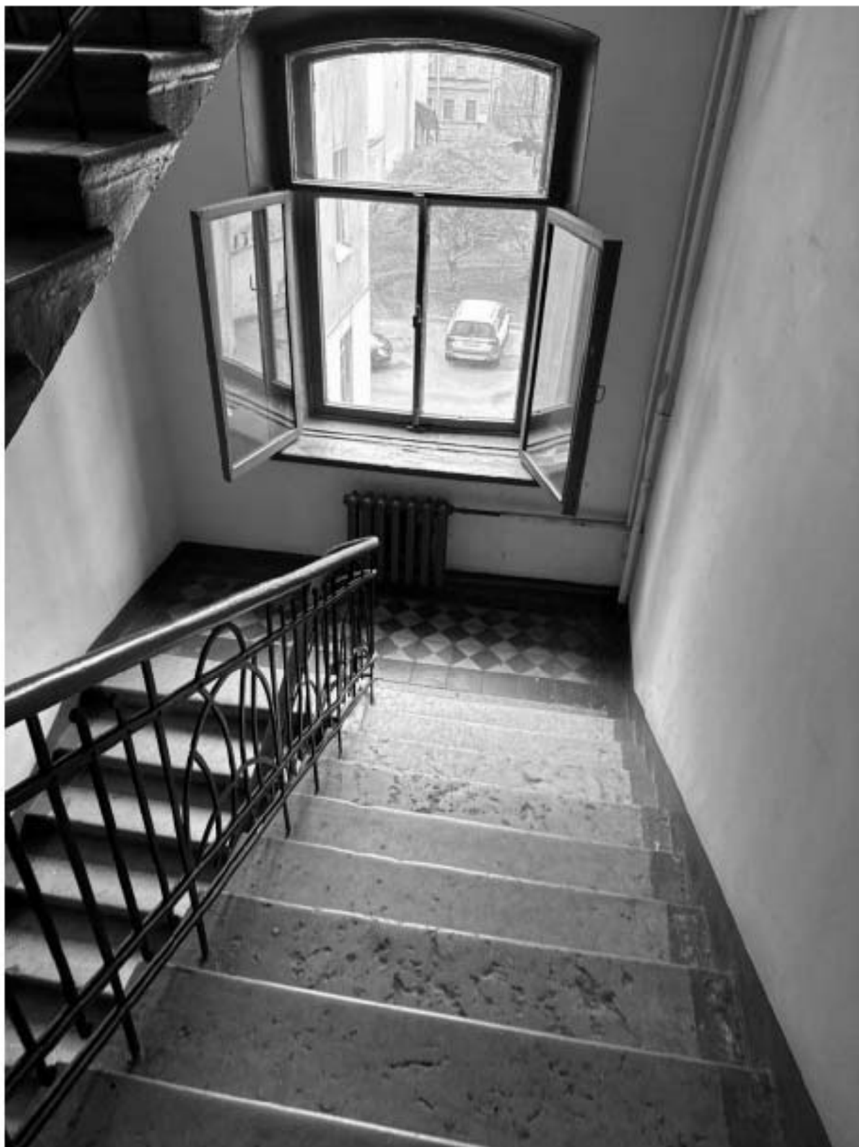
Фото 53. Вид на интерьер лестницы 7-ЛК объекта культурного наследия.
