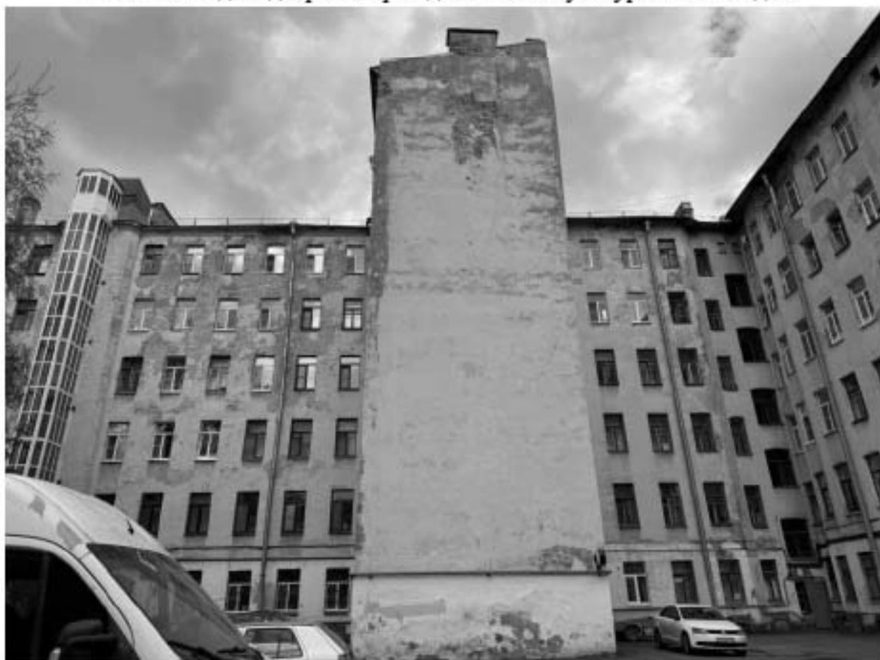
Фото 19. Вид на дворовые фасады объекта культурного наследия.
